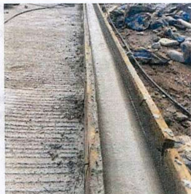
Fundición bordillos en concreto clase E.
