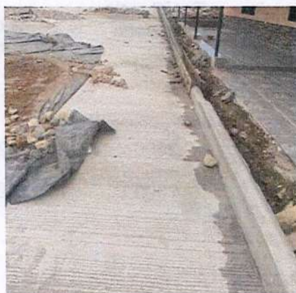
Curado de bordillos en concreto.
