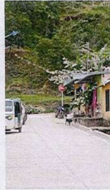
Pavimento rígido en concreto barrio La Esperanza.
