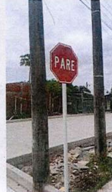
Señalización vertical instalada.
