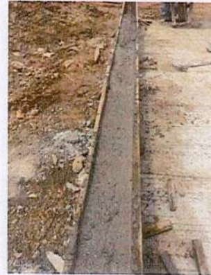
Fraguado de bordillos.
