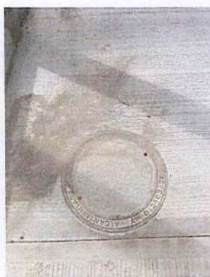
Nivelación de pozos barrio La Esperanza.
