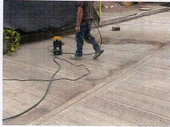
Curado de pavimento rígido.
