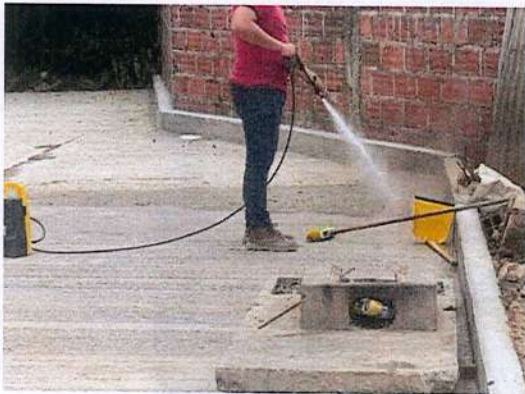
Limpieza de obra.
