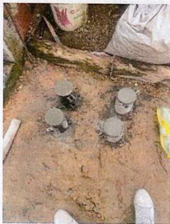
Toma de muestras de concreto para ensayo de compresión (bordillos)
