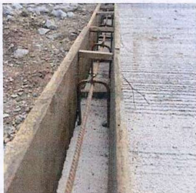
Acero de refuerzo bordillos.
