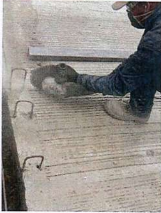
Corte para dilataciones del pavimento.
