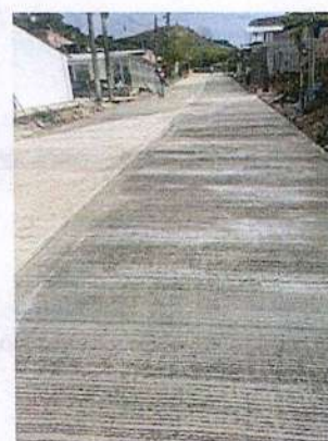
Curado de pavimento rígido en concreto.
