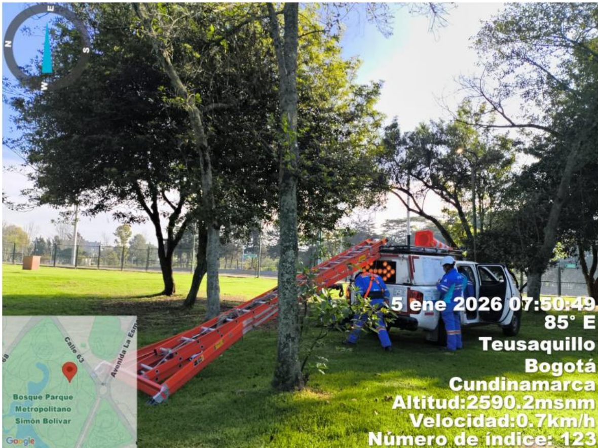
Personal de Enel condensa inicia labores cerca de la plazoleta
