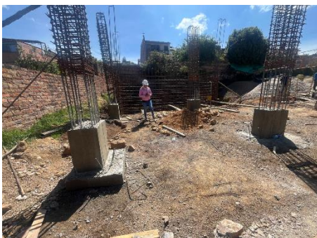
Foto 17. COLUMNAS EN CONCRETO 28 MPa (4000 PSI), ALTURA MAYOR A 3 mts FORMALETA METALICA
