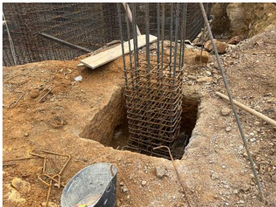
Foto 7. SUMINISTRO FIGURADA Y AMARRE DE ACERO 60000 PSI 420 MPa
