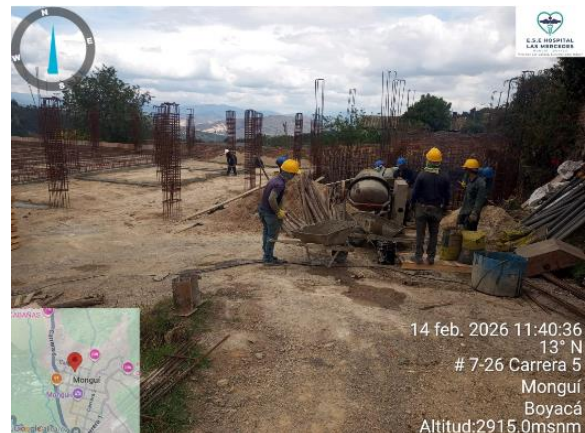
Foto 28. SOLADO CONCRETO ESPESOR E=0.0 5MTS 14MPa (2000PSI)
