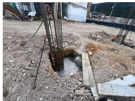
Foto 16. CONCRETO DE ZAPATAS 21MPa + FORMALETA
