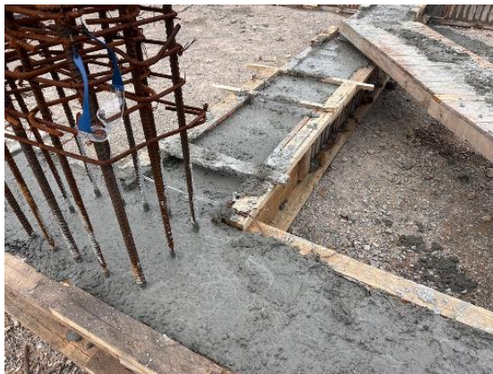
Foto 38. CONCRETO VIGA DE AMARRE 21,1 MPa, SECCION RECTANGULAR
