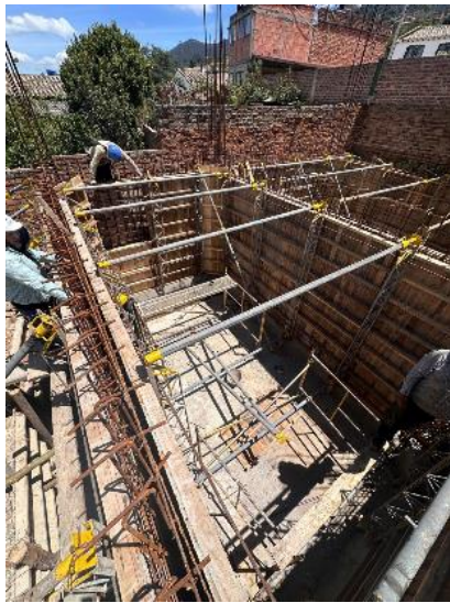
Foto 31. ENCOFRADO MUROS TANQUE SUBTERRANEO
