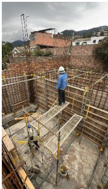
Foto 33. ENCOFRADO MUROS TANQUE SUBTERRANEO
