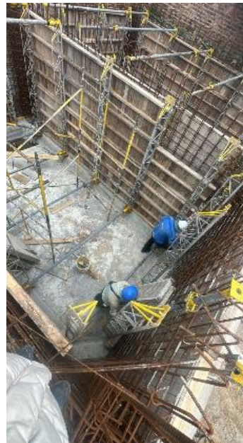
Foto 34. ENCOFRADO MUROS TANQUE SUBTERRANEO
