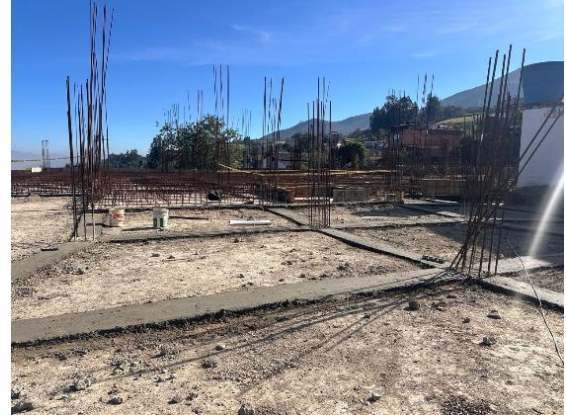
Foto 30. SOLADO CONCRETO ESPESOR E=0.0 5MTS 14MPa (2000PSI)
