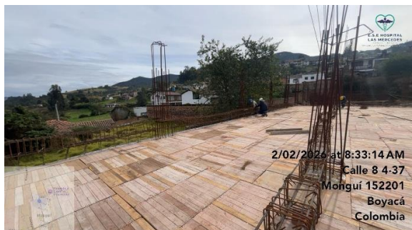
Foto 19. SUMINISTRO FIGURADA Y AMARRE DE ACERO 60000 PSI 420 MPa
