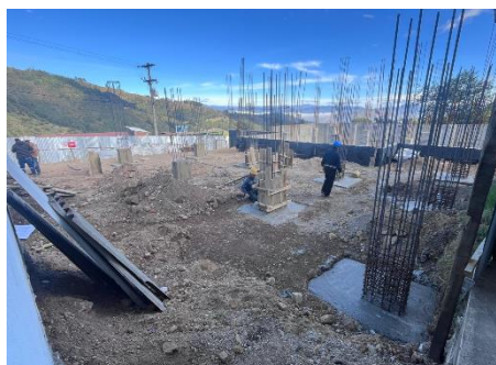
Foto 15. CONCRETO DE ZAPATAS 21MPa + FORMALETA
