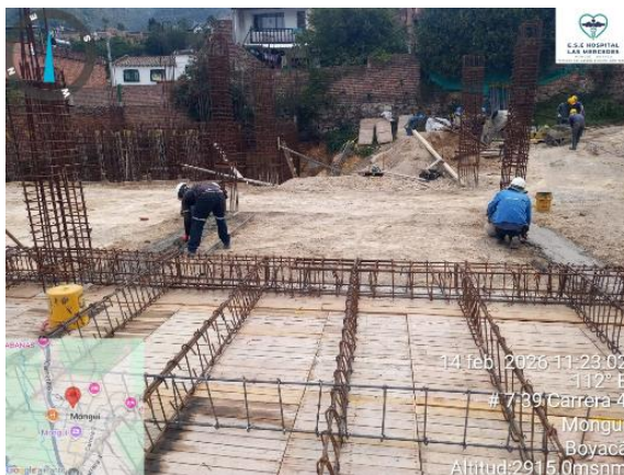
Foto 27. SOLADO CONCRETO ESPESOR E=0.0 5MTS 14MPa (2000PSI)
