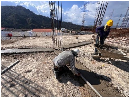
Foto 29. SOLADO CONCRETO ESPESOR E=0.0 5MTS 14MPa (2000PSI)
