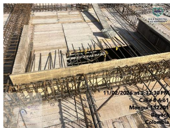
Foto 22. SUMINISTRO FIGURADA Y AMARRE DE ACERO 60000 PSI 420 MPa
