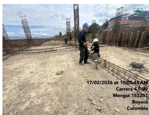
Foto 24. SUMINISTRO FIGURADA Y AMARRE DE ACERO 60000 PSI 420 MPa
