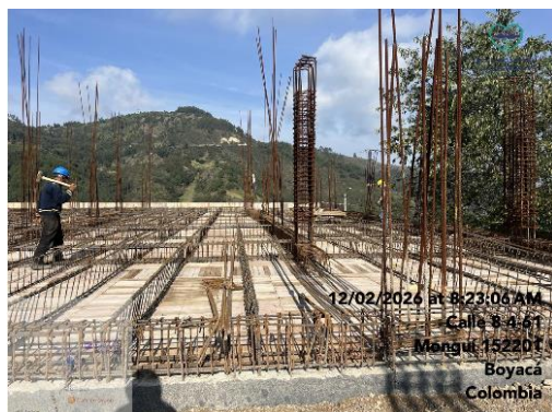
Foto 23. SUMINISTRO FIGURADA Y AMARRE DE ACERO 60000 PSI 420 MPa
