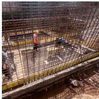
Foto 12. ENCOFRADO DE MUROS DE ARRANQUE DE TANQUE
