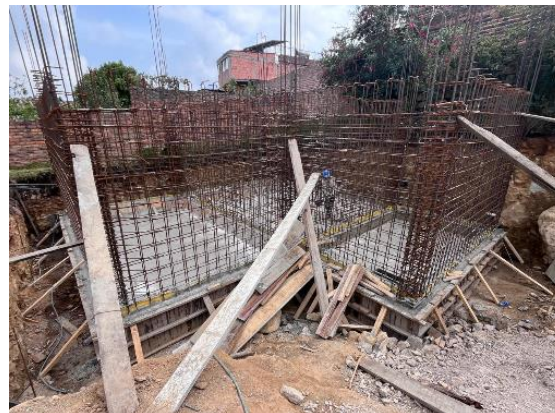
Foto 14. CONCRETO SIMPLE DE 28 MPa - (4000 PSI) IMPERMEABILIZADO PARA PLACAS PISOS
