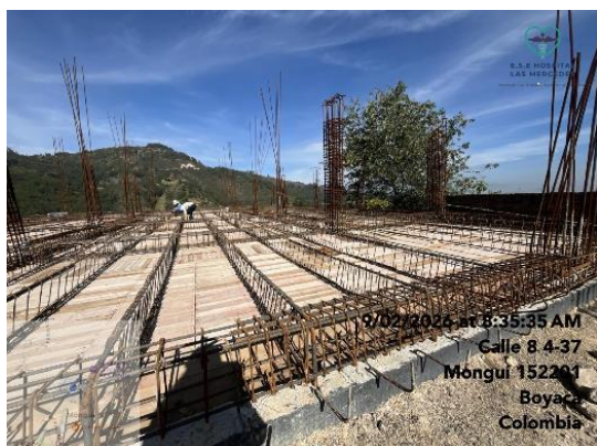
Foto 21. SUMINISTRO FIGURADA Y AMARRE DE ACERO 60000 PSI 420 MPa
