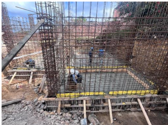
Foto 13. CONCRETO SIMPLE DE 28 MPa - (4000 PSI) IMPERMEABILIZADO PARA PLACAS PISOS
