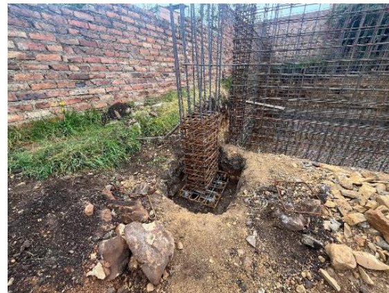
Foto 8. SUMINISTRO FIGURADA Y AMARRE DE ACERO 60000 PSI 420 MPa
