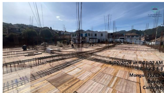
Foto 20. SUMINISTRO FIGURADA Y AMARRE DE ACERO 60000 PSI 420 MPa
