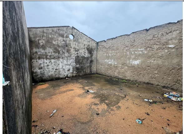
VISTA INTERNA - CONSTRUCCIÓN
