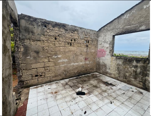
VISTA INTERNA - CONSTRUCCIÓN
