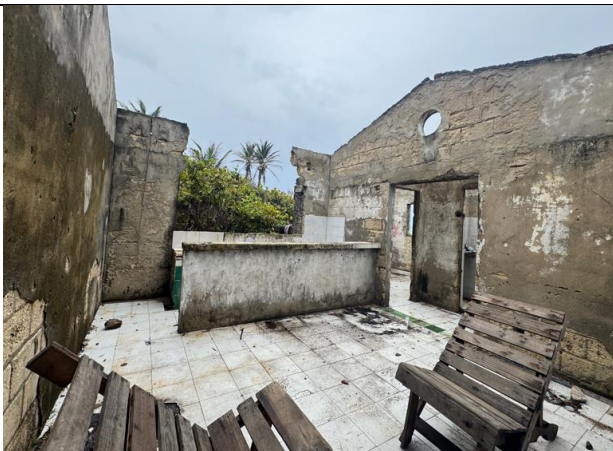
VISTA INTERNA - CONSTRUCCIÓN
