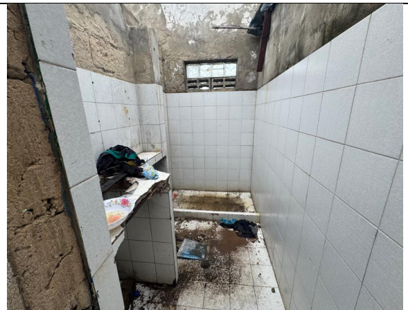
VISTA INTERNA - CONSTRUCCIÓN
