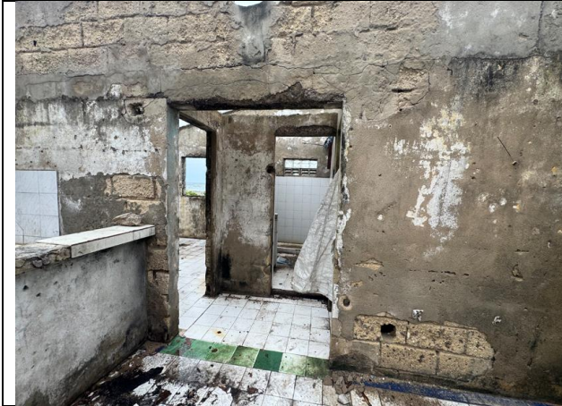
VISTA INTERNA - CONSTRUCCIÓN
