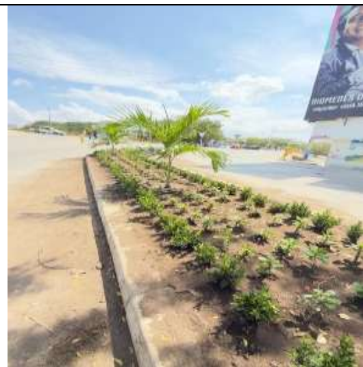
Foto 2: Siembra de material vegetal, en Bulevar frente Yo Amo a Riohacha.
