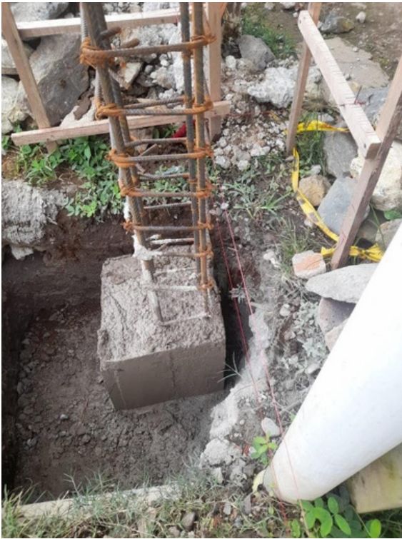
2.0 zapata en concreto
