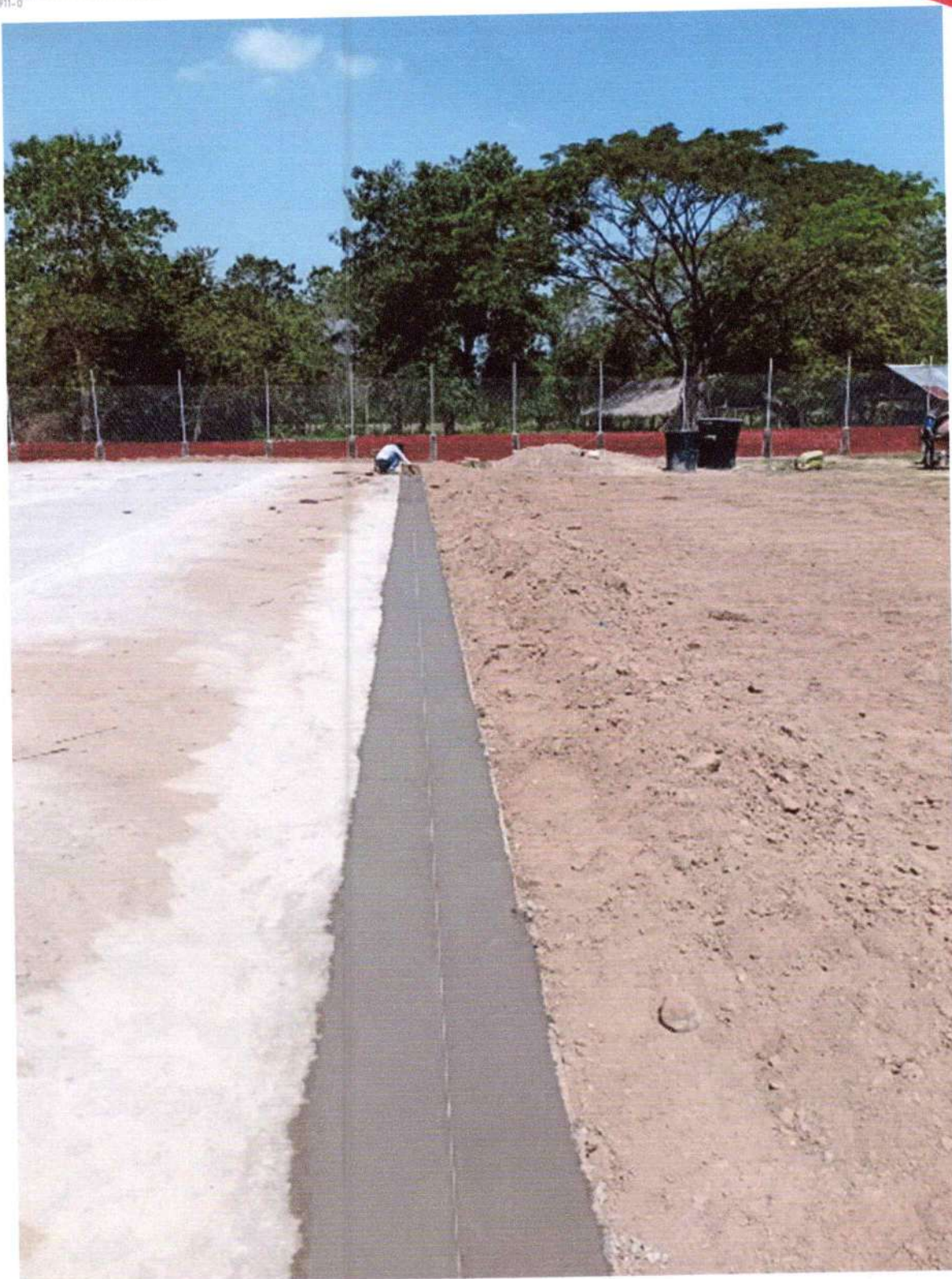
Forografía. 4Proceso de fundida de cunetas en concreto
