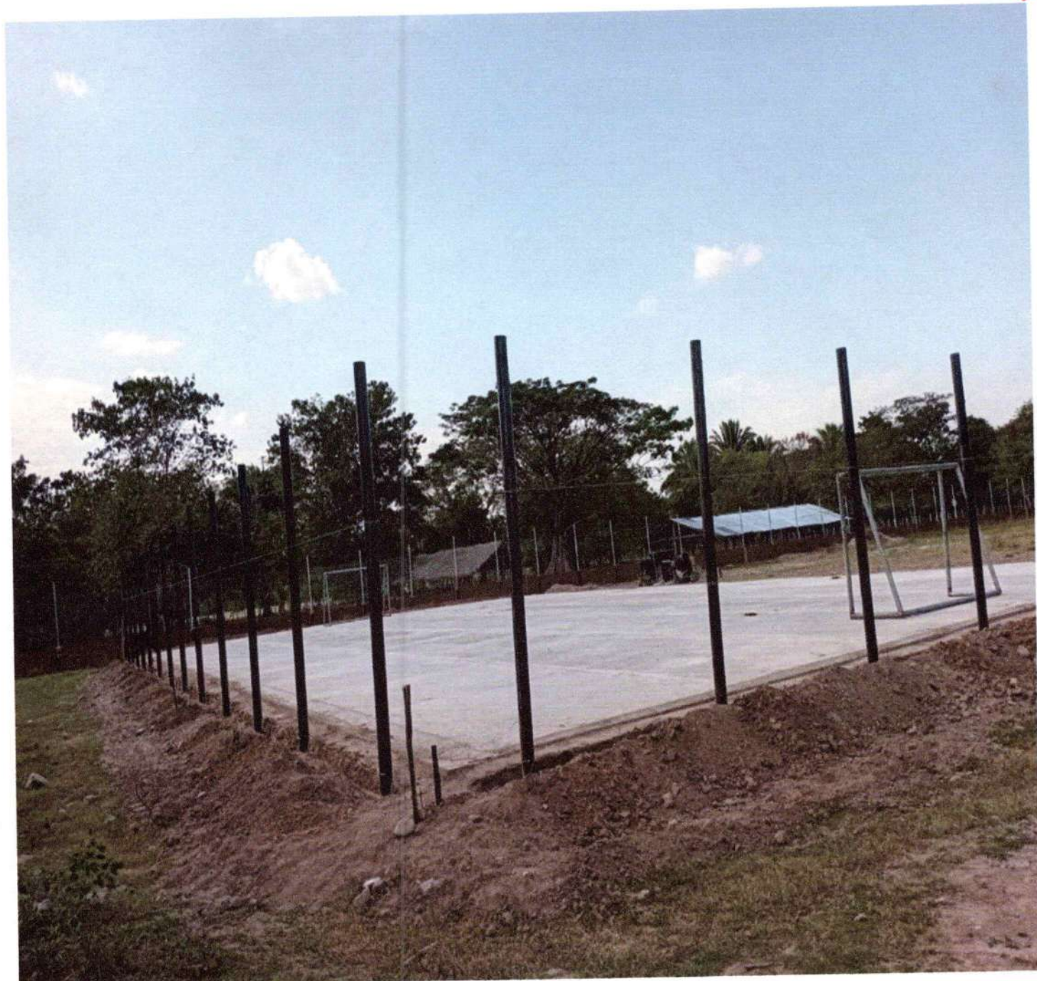
Fotografía. 5. Cancha, malla de impacto, portería
