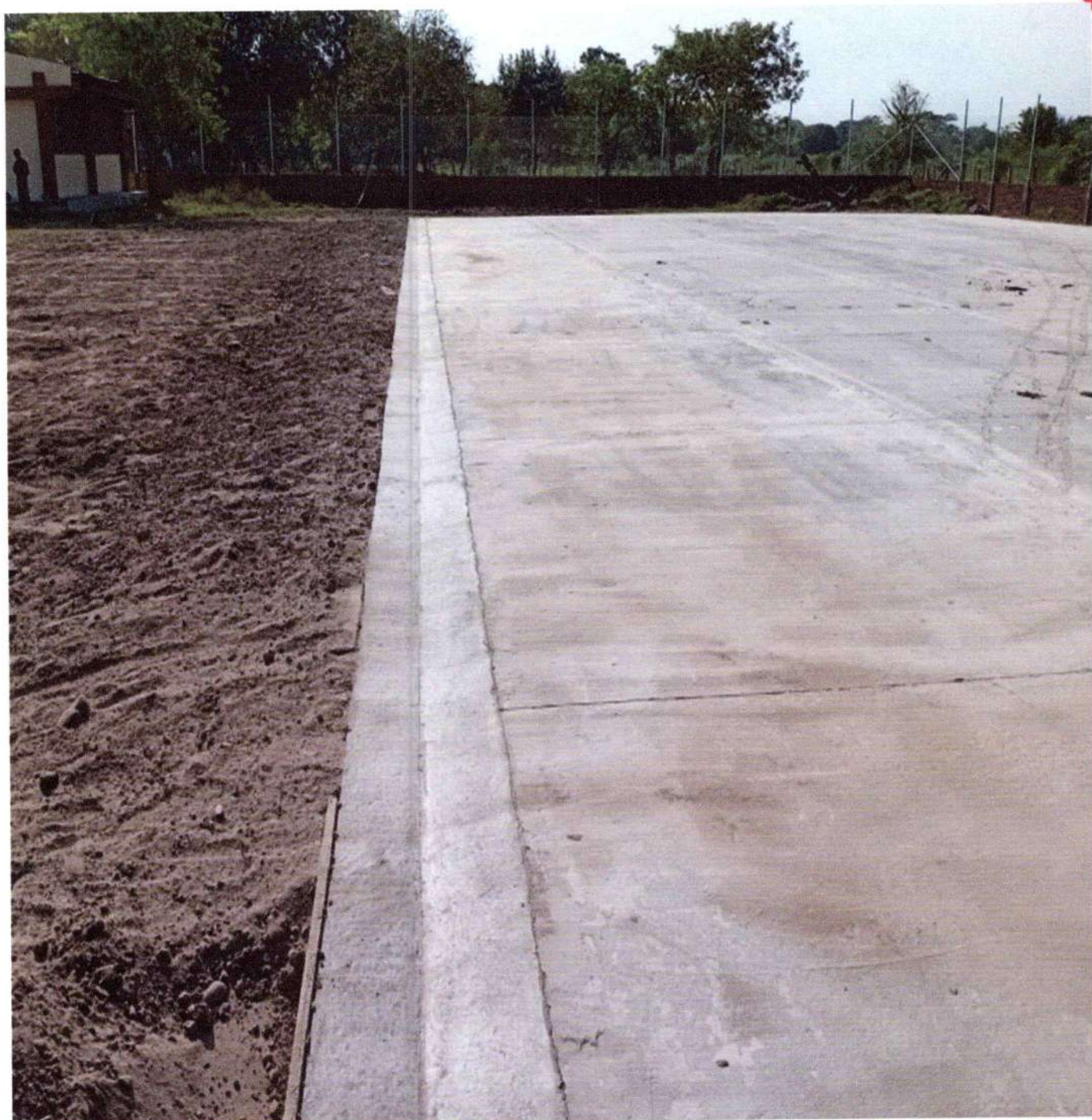
Forografía. 3. Cunetas en concreto y cancha en concreto
