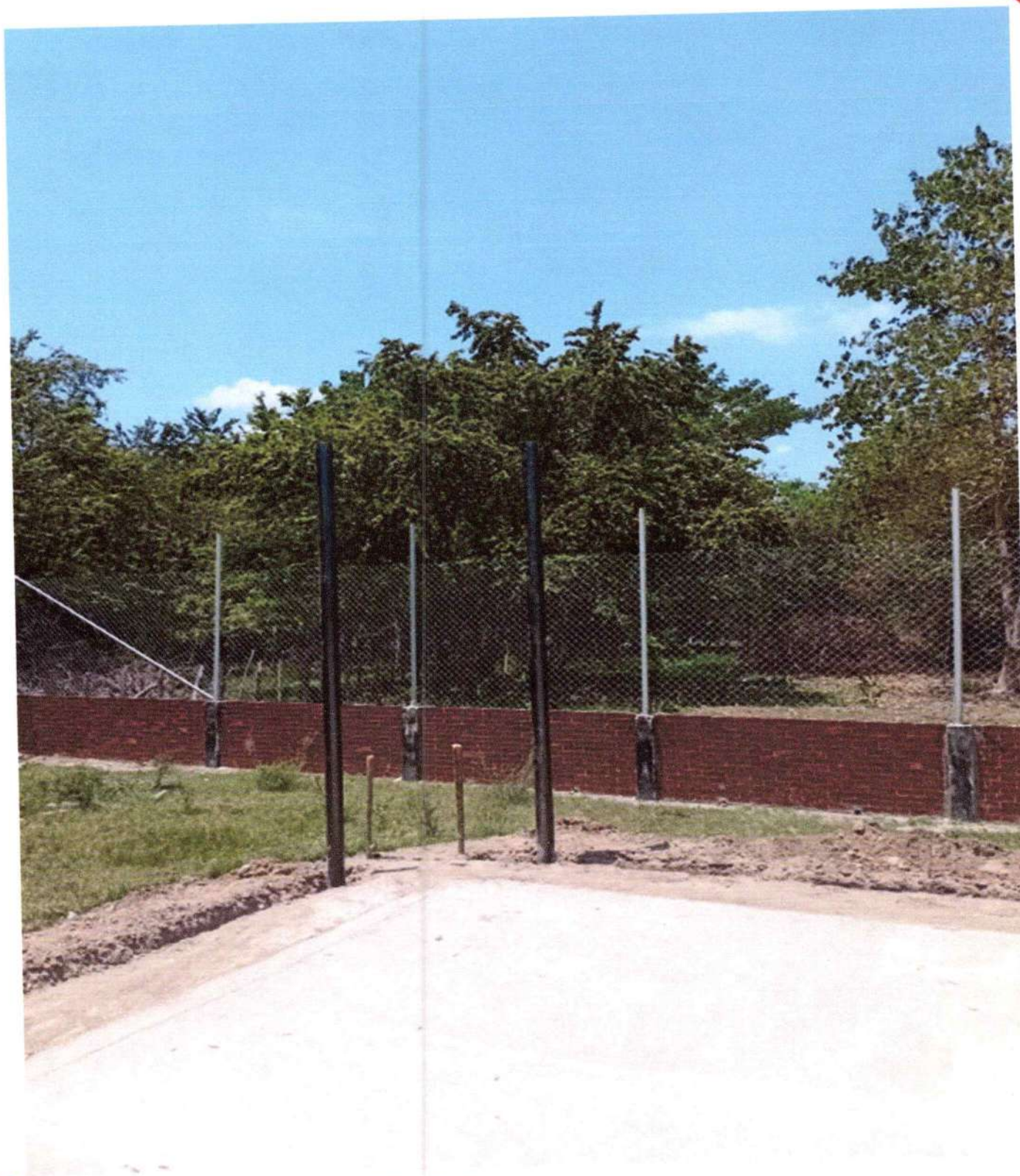
Fotografía. 1Cerramiento en malla. Muro en ladrillo a ala vista
