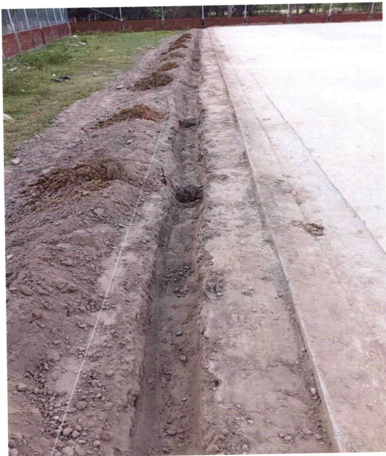
Forografía. 2Excavacion para cunetas laterales.
