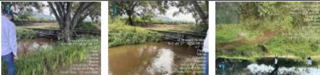
Registro fotográfico tramos canal, propuestos para revestir en distrito Asoprado.
