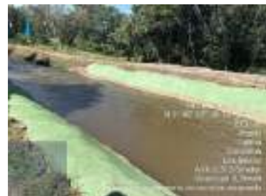
Revestimiento de geotextil, tramos actuales en distrito de Asoprado.
