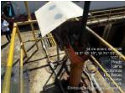
Estado engranajes accionamiento compuertas, aguas abajo central hidroeléctrica Prado.
