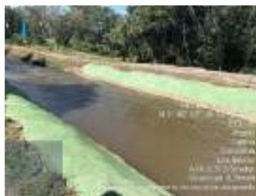
Revestimiento de geotextil, tramos actuales en distrito de Asoprado.
