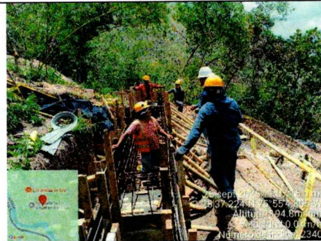
Ilustración 8. Charla de SST del Personal de Obra
