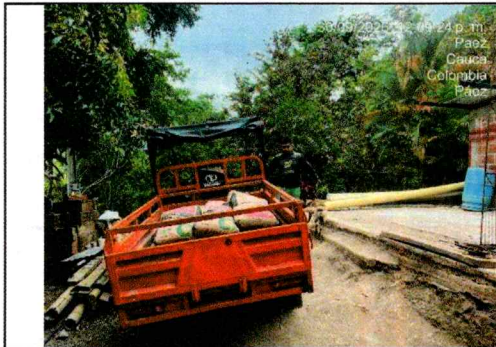
Ilustración 21. Suministro de Cemento
