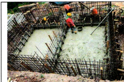
Ilustración 7. Vaciado de Concreto en Losa Inferior
