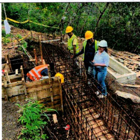
Ilustración 9. Charla de SST del Personal de Obra
