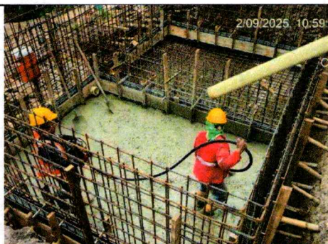
Ilustración 10. Vaciado de Concreto en Losa Inferior
