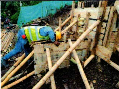
Ilustración 25. Atrake de formaleta cajas de salida estructurada lavado de arena
