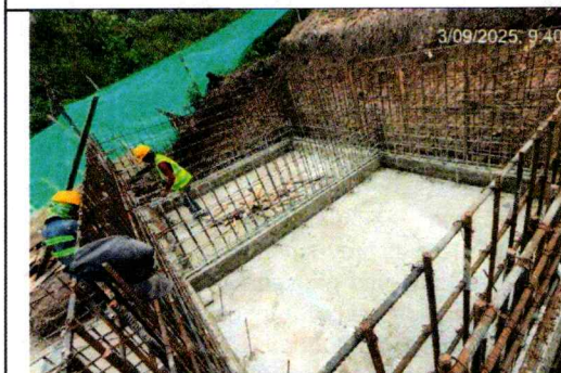
Ilustración 9. Losa Inferior de Filtro Lento en Arena terminada
