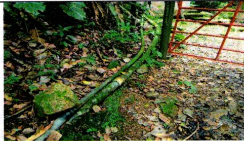
Ilustración 6. Localización en sitio de estructura llegada a PTAP
