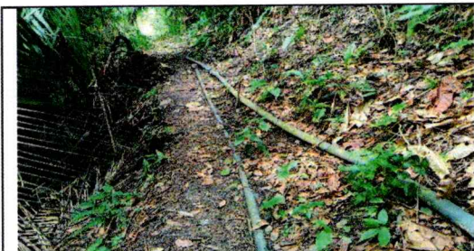
Ilustración 5. Localización en sitio de estructura llegada a PTAP
