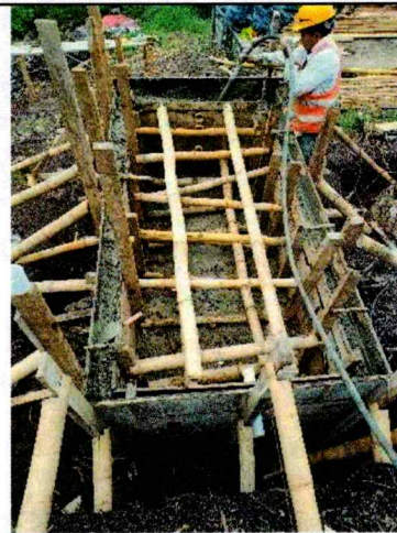
Ilustración 24. Fundición de concreto de estructura de cámara de lavado de arena
