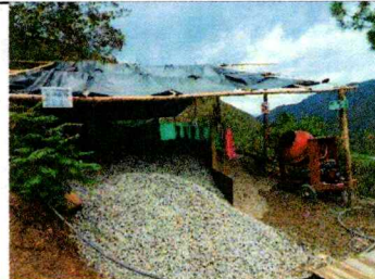
Ilustración 30. Acopio de material en sitio de obra
