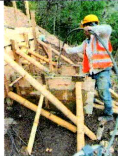
Ilustración 26. Proceso de vibrado de concreto
