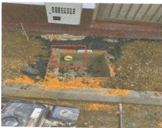
20. Tubería 6" para conexiones cajas de inspeccion sanitarias.
