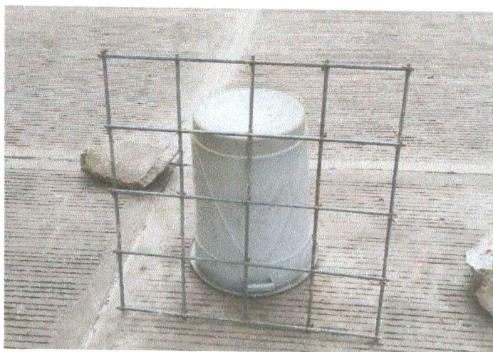
24. Refuerzo de caja de inspección.
