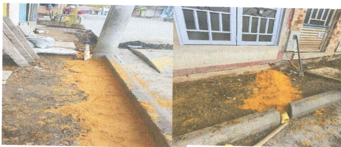
46. Arena amarilla para tuberías de desagüe y acueducto.
