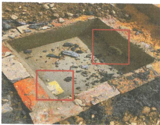
20. Tubería 6" para conexiones cajas de inspeccion sanitarias.
