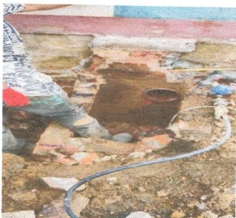
44. Demolicion cajas de inspeccion.
