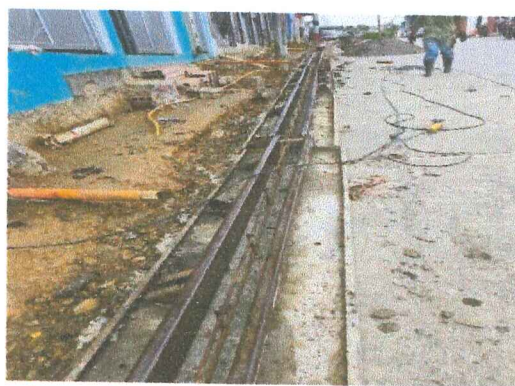
35. Acero de refuerzo para viga y rampa
