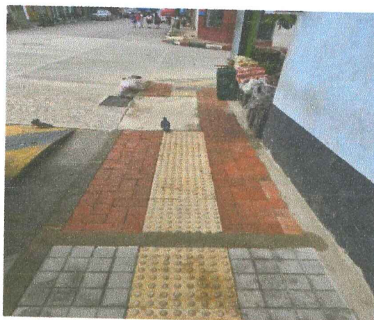
1. 49. Instalacion adoquin de arcilla.
