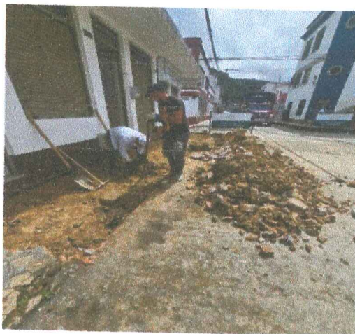
19. excavación manual para alcantarillado
