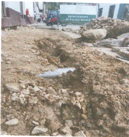
8. imagenes de retiro de tubería existente.
