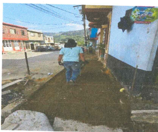
50. 47.Relleno con subbase.
