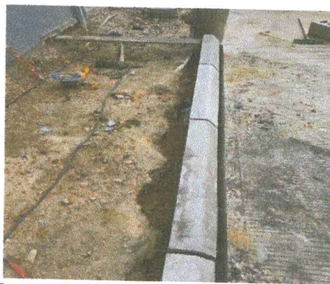
37. Instalación de sardineles calle 6.
