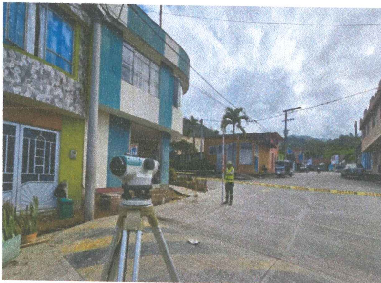
4. Imagen localización y replanteo andenes Calle 4.
