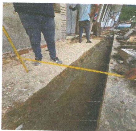
36. Excavaciones para instalacion de sardinel y estructura de anden.
