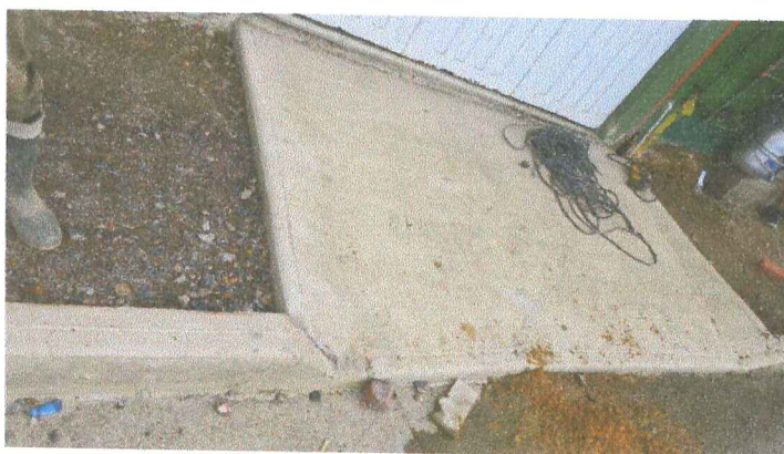
33. Rampa de anden Carrera 3.
