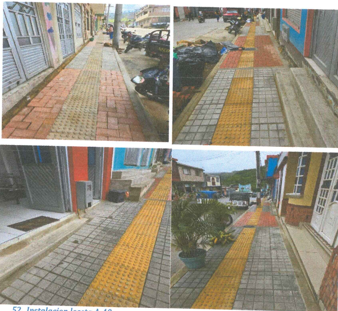
52. Instalacion loseta A-40.
