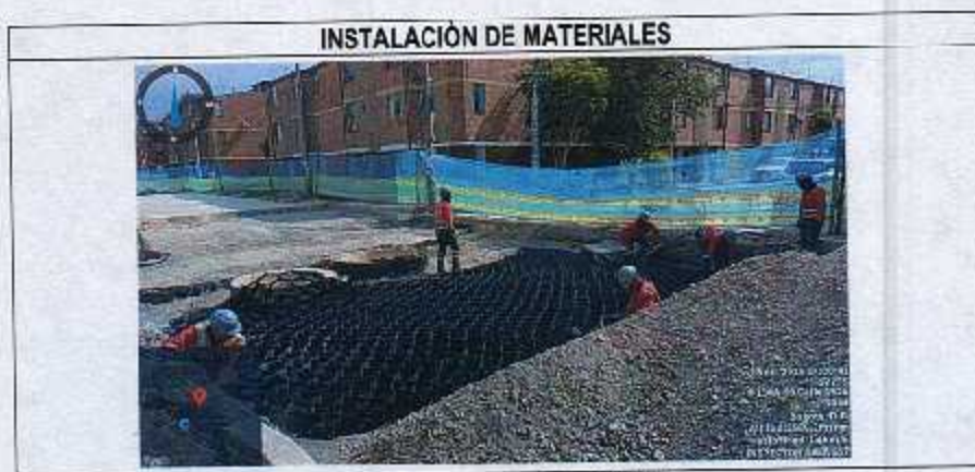
Ilustración No.3. Instalación de Materiales.
