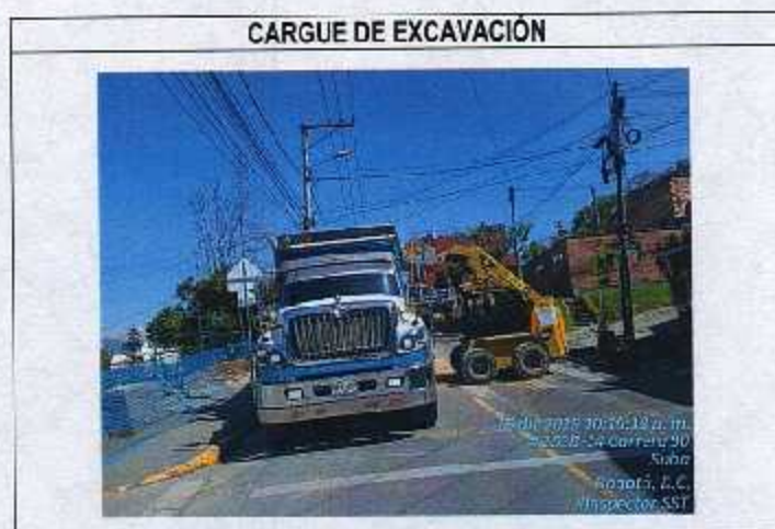
Ilustración No. 2. Cargue de excavación.
