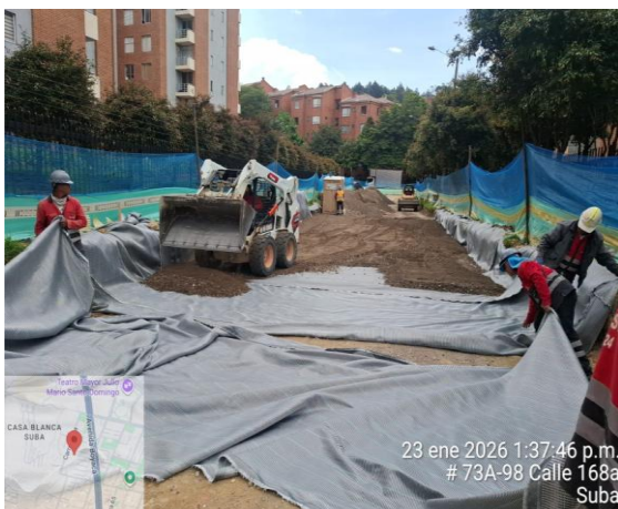
Fotografía 13 Instalación de geocelda, geotextil y sub-base
