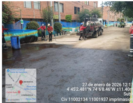
Fotografía 11 Instalación de imprimación
