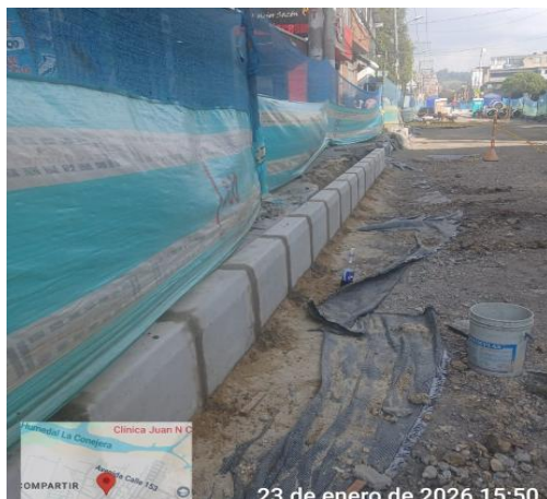
Fotografía 8 Instalación de sardinel
