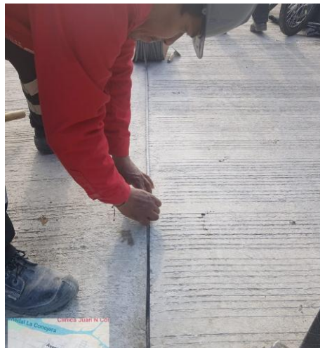
Fotografía 3 Instalación de Bulken
