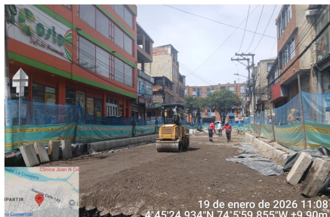
Fotografía 7 Instalación de Sub-base
