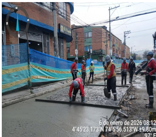
Fotografía 2 Instalación de MR-45
