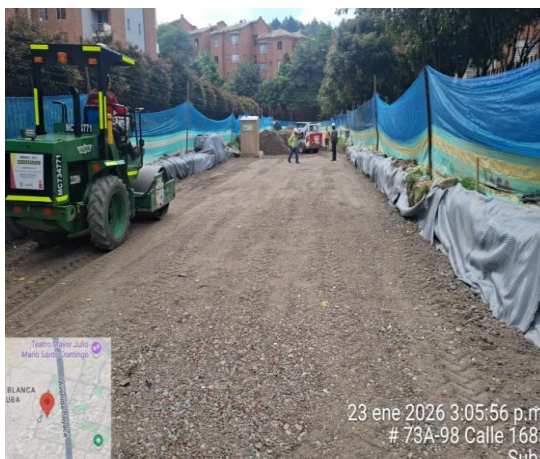
Fotografía 13 Instalación de geocelda, geotextil y sub-base
