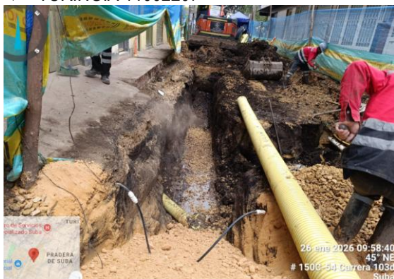
Fotografía 15 Cambio de tubería
