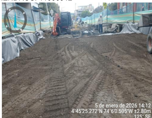
Fotografía 6 Instalación de Geotextil y sub-base
