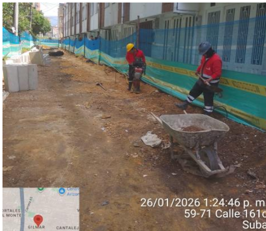
Fotografía 14 Traslado de tubería de agua potable
