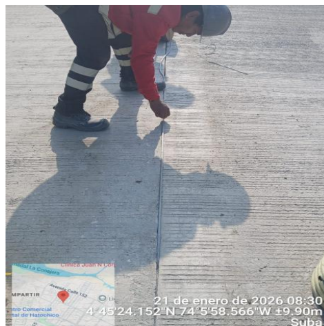
Fotografía 5 Instalación de Bulken
