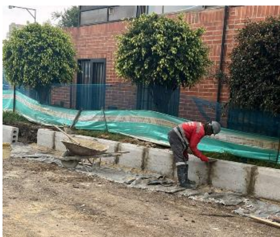
Fotografía 12 Instalación de sardinel
