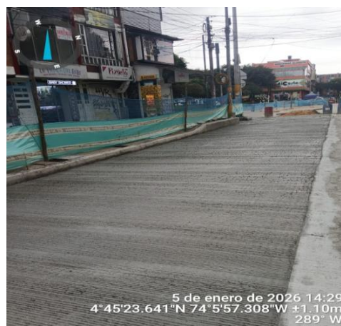
Fotografía 4 Instalación de MR-45
