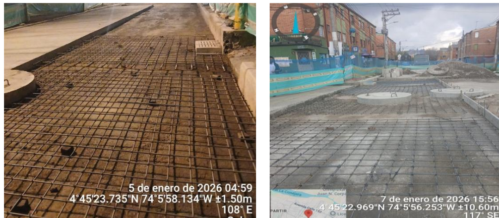
Fotografía 1 instalación de acero para curado de losas en concreto
