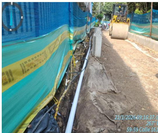
Fotografía 14 Traslado de tubería de agua potable
