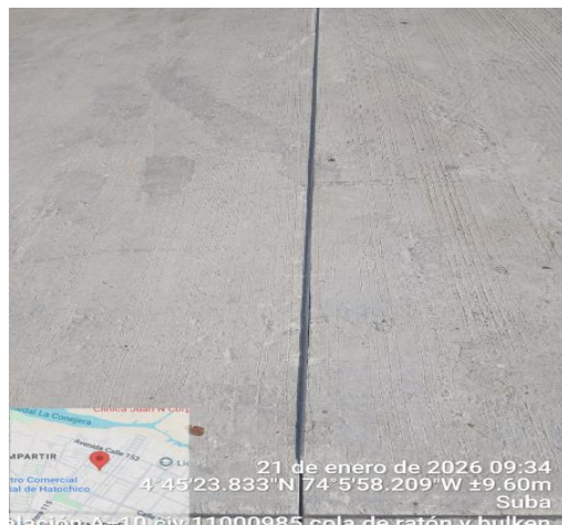
Fotografía 5 Instalación de Bulken
