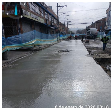
Fotografía 2 Instalación de MR-45
