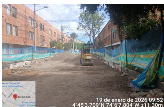
Fotografía 10 Instalación de base
