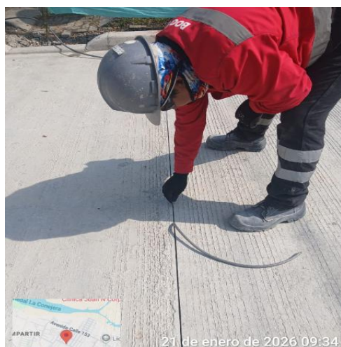
Fotografía 3 Instalación de Bulken
