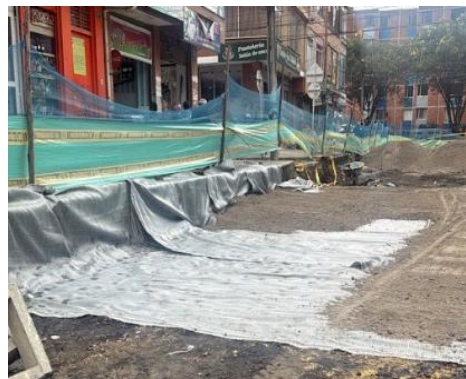
Fotografía 6 Instalación de Geotextil y sub-base
