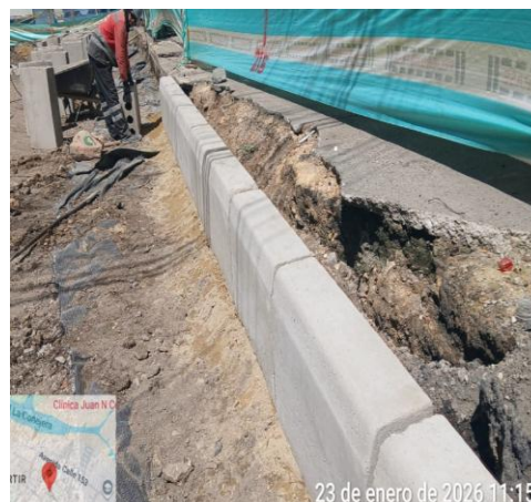
Fotografía 8 Instalación de sardinel
