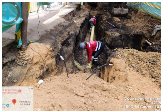
Fotografía 15 Cambio de tubería
