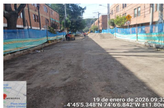
Fotografía 10 Instalación de base
