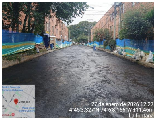
Fotografía 11 Instalación de imprimación
