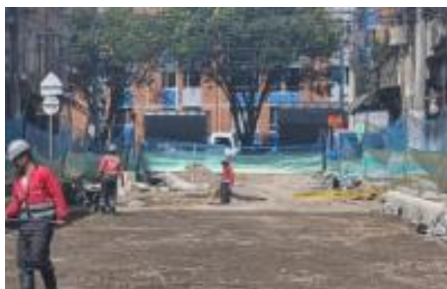
Fotografía 9 instalación de Sub - base
