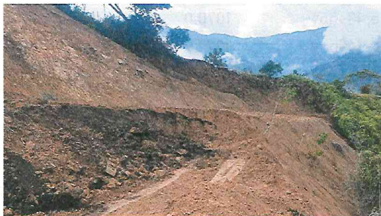
Terrazas conformadas en punto crítico.
