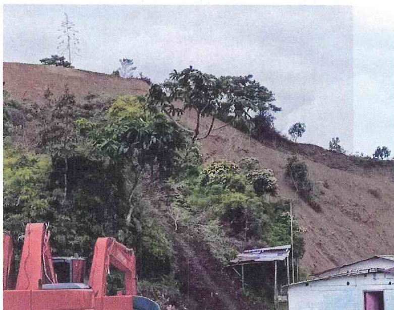
Terrazas del sector crítico.
