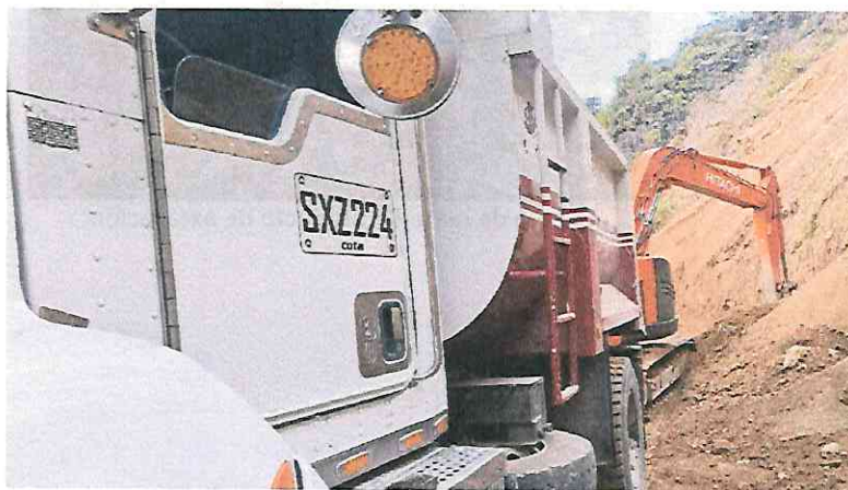
Cargue de material producto de excavación.
