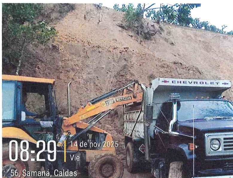
Cargue de material para traslado a botadero.
