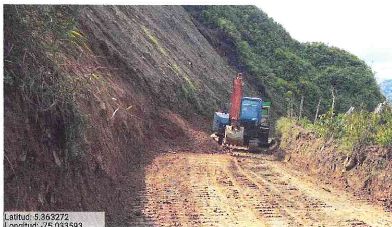
Limpieza de vía.
