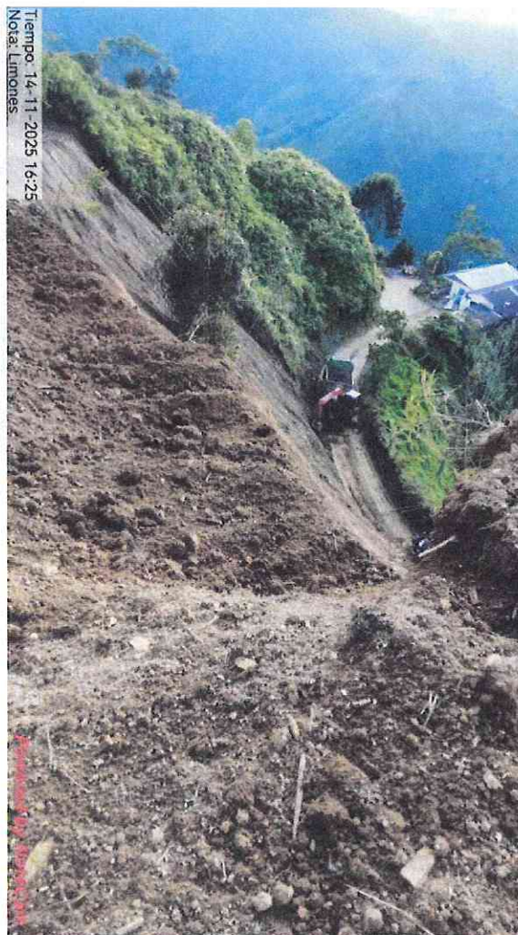
Cargue de material producto de excavación.
