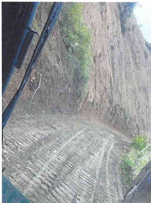
Limpieza de vía.
