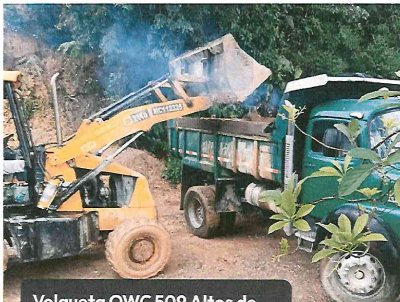
Cargue de material para traslado a botadero.
