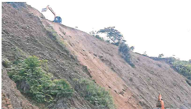
Cargue de material para disposición a botadero y conformación de terrazas.
