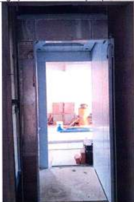
Fotografía 117 Instalación de cabina
