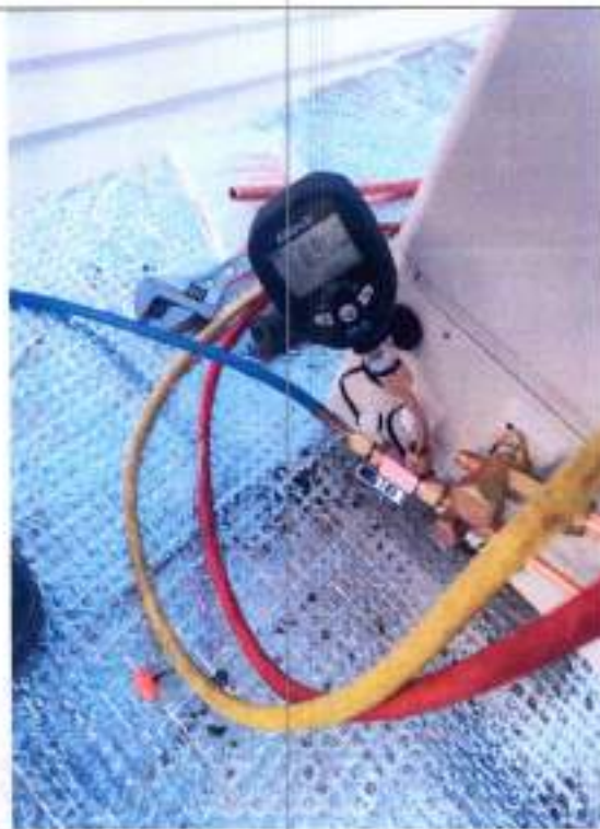
Fotografía 134 Prueba de gas
