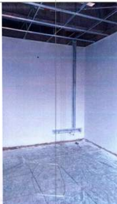
Fotografía 148 Montaje de Tubería Emt y canaleta metálica
