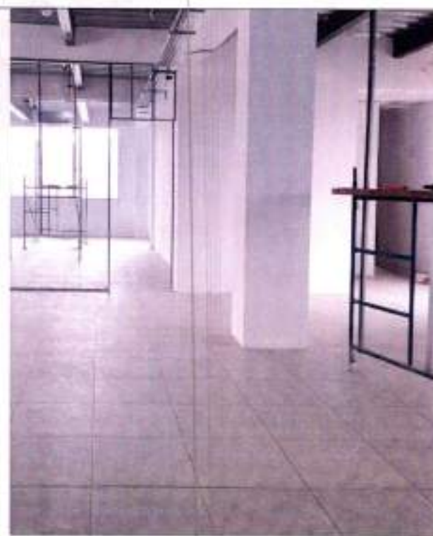
Fotografía 30 Enchape de piso cerámico 61x61
