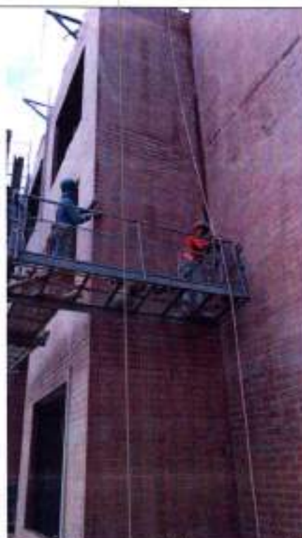
Fotografía 32 Muro en ladrillo estructural fachada principal
