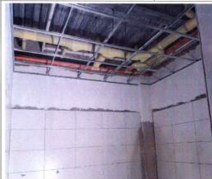
Fotografía 9 Instalación estructura para cielo raso
