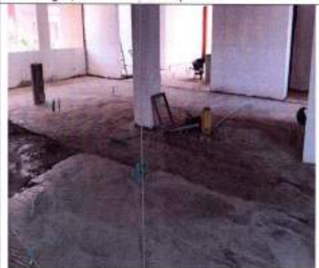
Fotografía 22 Alistado de piso en mortero 1:3
