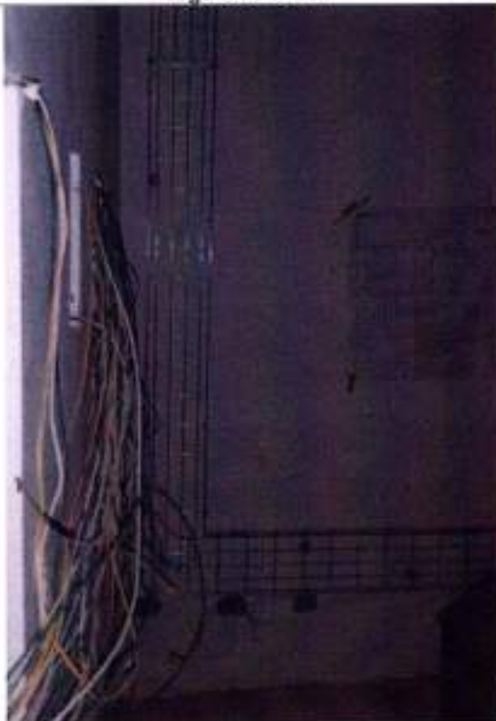
Fotografía 101 Cableado de acometidas parciales para tableros de distribución
