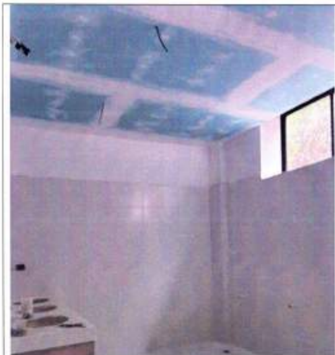
Fotografía 13 Cielo raso en panel RH en baños
