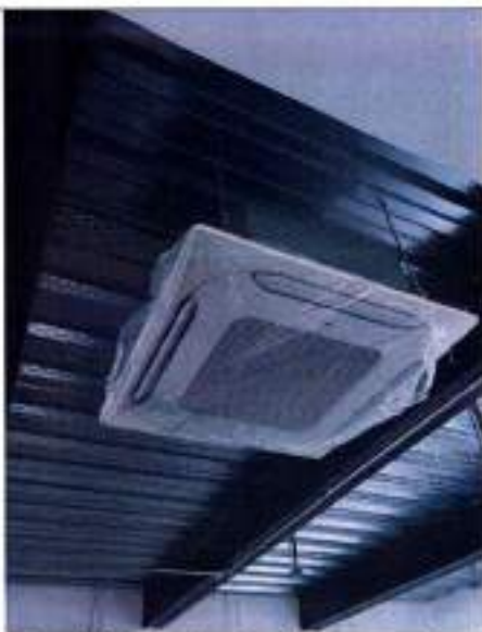
Fotografía 125 Instalación de equipo de aire tipo cassette
