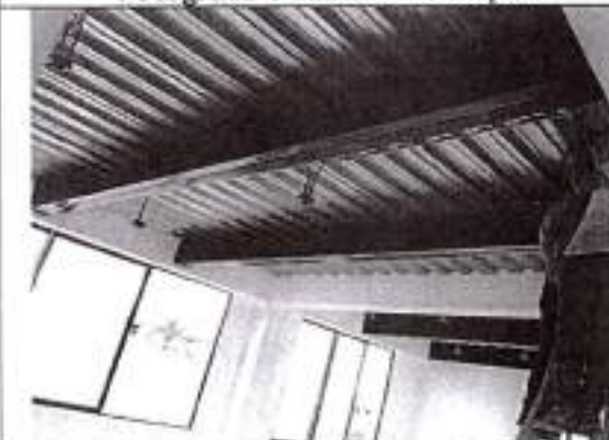
Fotografía 3 Instalación salidas para luminarias
