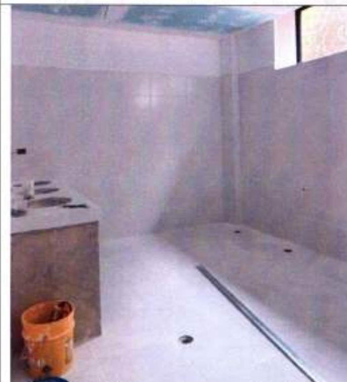
Fotografía 25 Enchape de piso y paredes de baños
