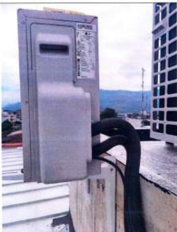
Fotografía 133 Montaje de manejadoras
