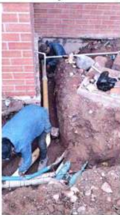
Fotografía 73 Instalación de tubería sanitaria de 4", Kit silla Yee Pvc 6x4 y desagües de aires acondicionados en 3/4"
