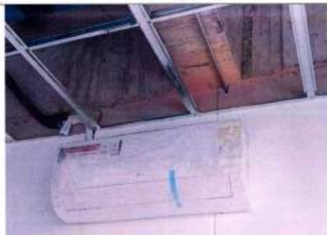
Fotografía 129 Instalación de equipo de aire tipo MiniSplit
