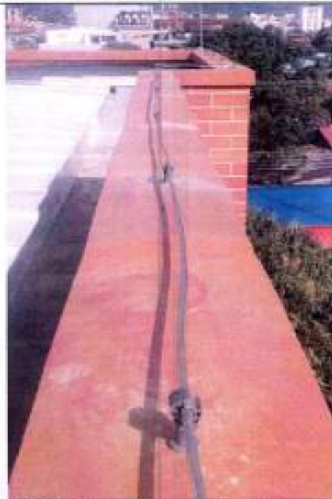
Fotografía 98 Anillo superior en alambazón de aluminio de 8mm y puntas captoras de 5/8x1m
