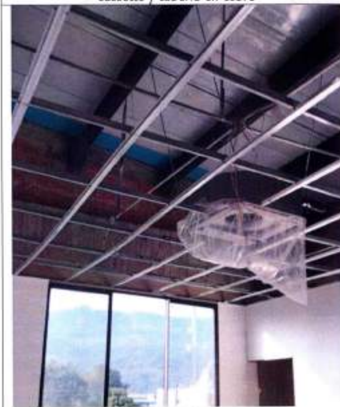
Fotografía 123 Instalación de equipo de aire tipo cassette y tubería en cobre
