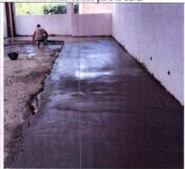
Fotografía 20 Alistado de piso en mortero 1:3
