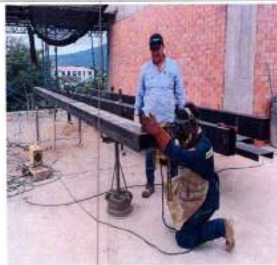
Fotografía 6 Equipo de soldadura
