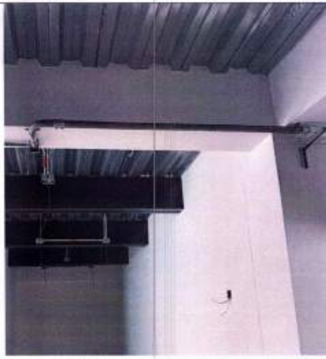
Fotografía 146 Montaje de Tubería Emt de 1 1/4"
