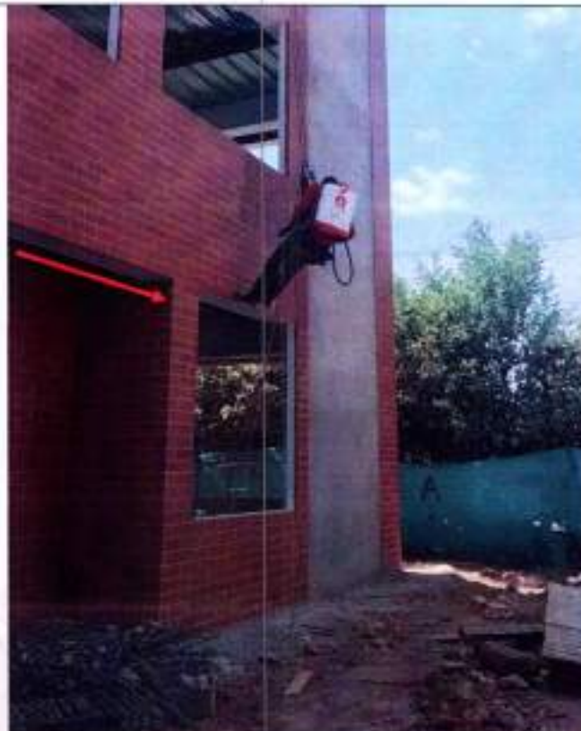
Fotografía 50 Limpieza de ladrillo estructural a la vista y estuco exterior en vigas
