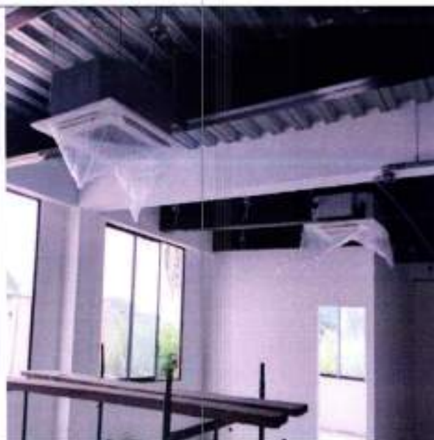
Fotografía 122 Instalación de equipo de aire tipo cassette y tubería en cobre
