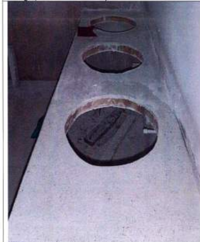
Fotografía 41 Enchape en piedra granito travertino No.2
