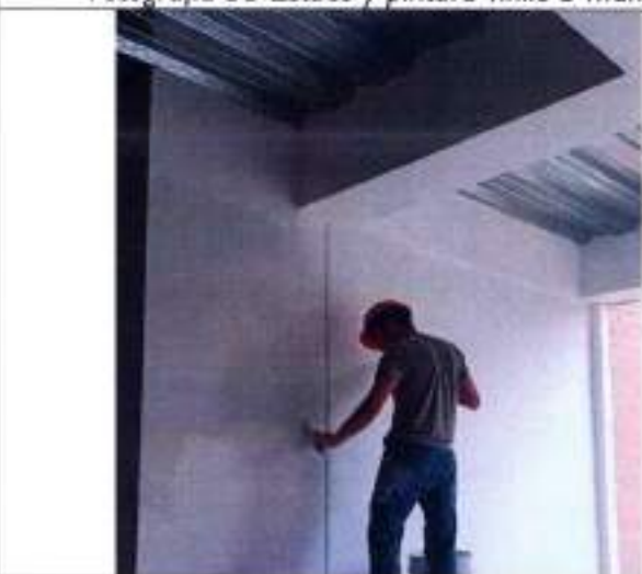
Fotografía 55 Estuco y pintura vinilo 3 manos
