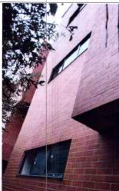
Fotografía 60 Instalación ventana corrediza en aluminio negro
