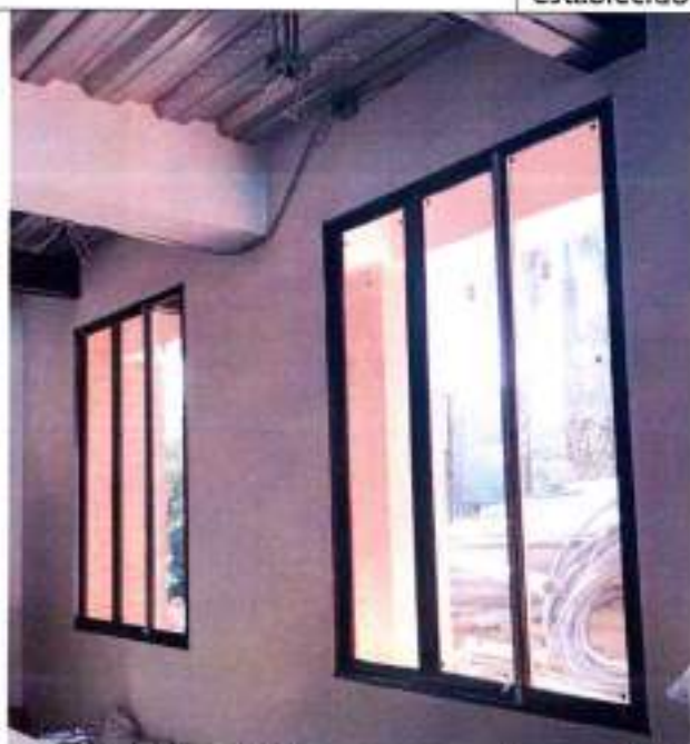
Fotografía 59 Instalación ventana corrediza en aluminio negro
