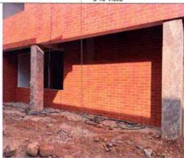
Fotografía 48 Limpieza de ladrillo estructural a la vista
