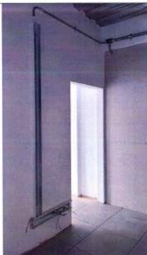
Fotografía 147 Montaje de Tubería Emt y canaleta metálica
