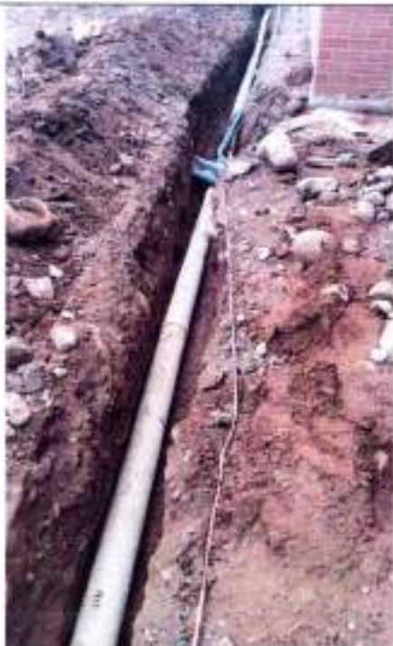
Fotografía 71 Instalación de tubería alcantarillado de 6"
