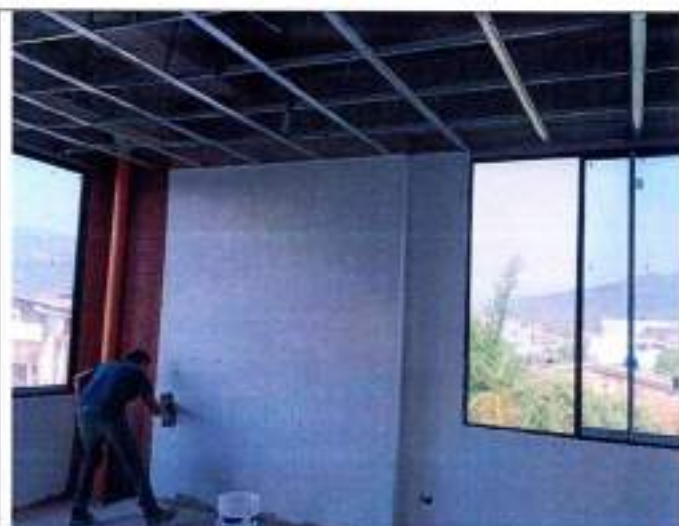
Fotografía 53 Estuco y pintura vinilo 3 manos
