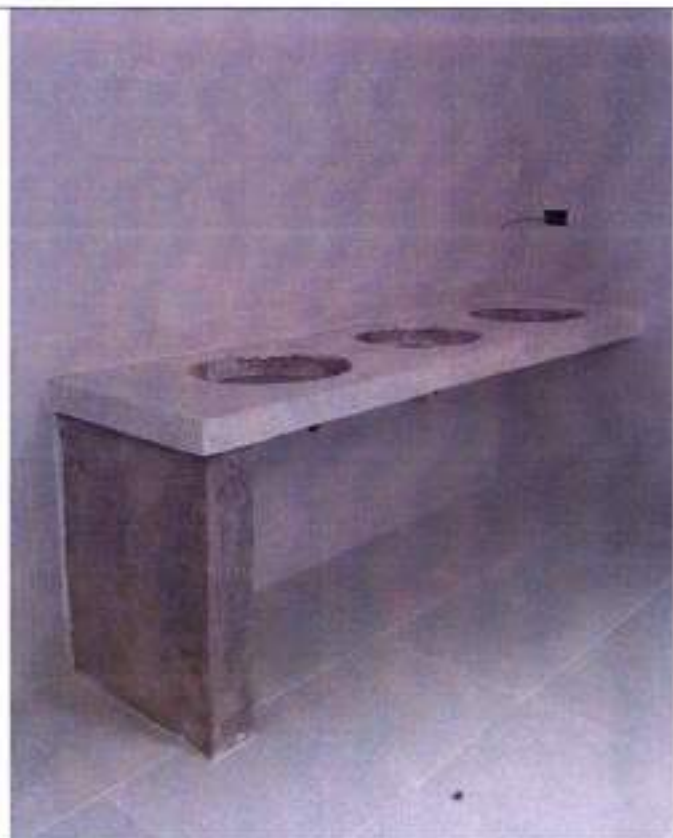
Fotografía 43 Pulida Granito travertino No.2
