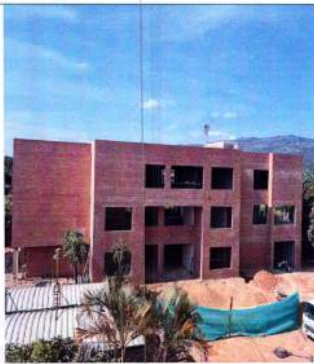
Fotografía 36 Muro en ladrillo estructural fachada principal
