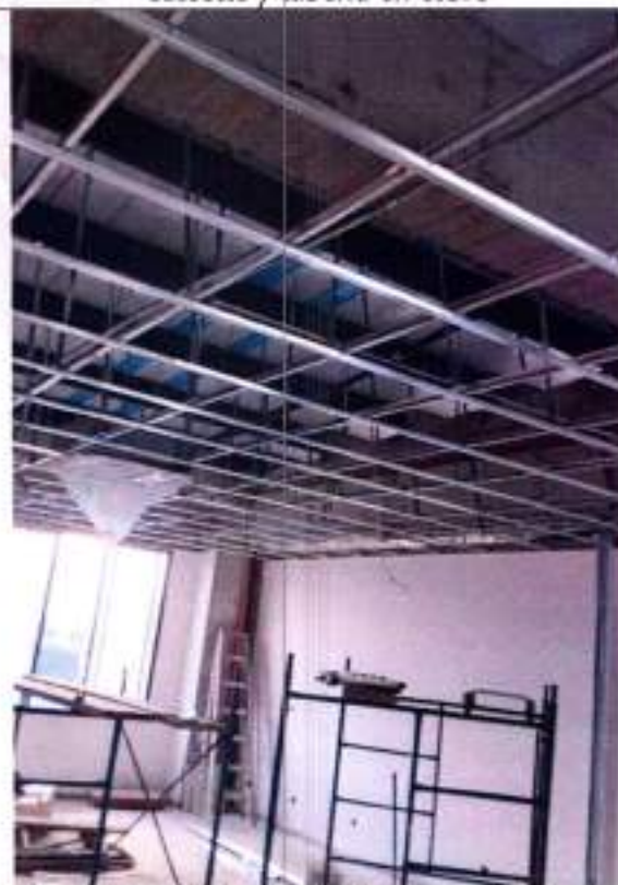
Fotografía 124 Instalación de equipo de aire tipo cassette y tubería en cobre
