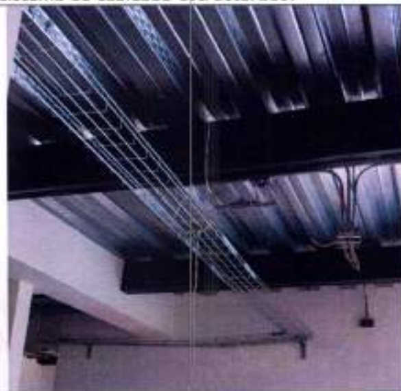
Fotografía 140 Montaje de bandeja portacables tipo malla
