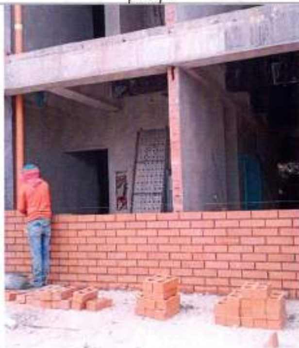
Fotografía 33 Muro en ladrillo estructural fachada principal
