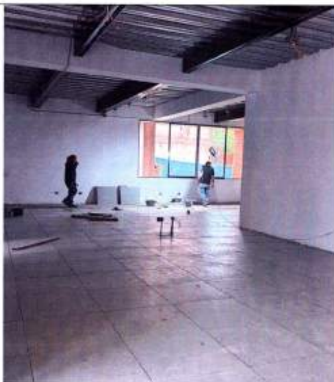
Fotografía 27 Enchape de piso cerámico 61x61
