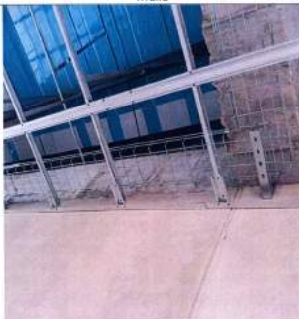
Fotografía 141 Montaje de bandeja portacables tipo malla
