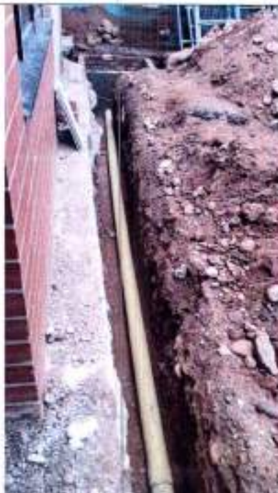
Fotografía 72 Instalación de tubería sanitaria de 4"
