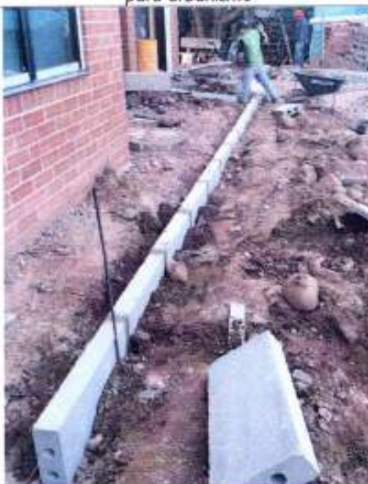
Fotografía 159 Conformación e instalación de bordillo para urbanismo
