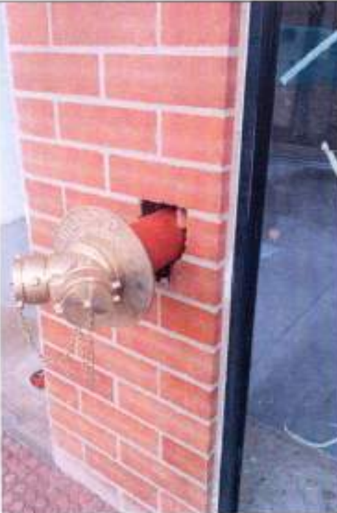
Fotografía 89 Instalación Válvula siamesa en bronce Ø 4" x 2 1/2" x 2 1/2"
