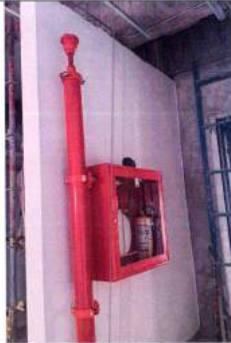
Fotografía 88 Instalación Válvula de ventosa I" H.D cámara sencilla doble acción roscada y gabinete tercer piso
