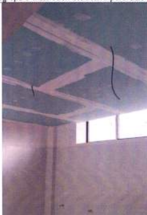
Fotografía 11 Cielo raso en panel RH en baños
