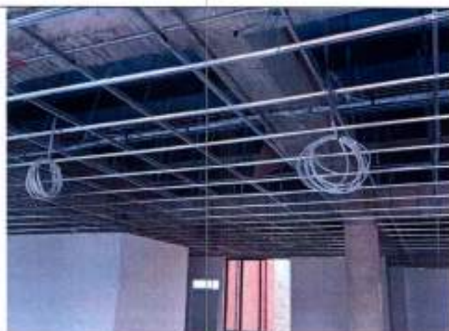
Fotografía 156 instalación Cable utp categoría 6a FIUTP LSZH o LSOH 100% cobre
