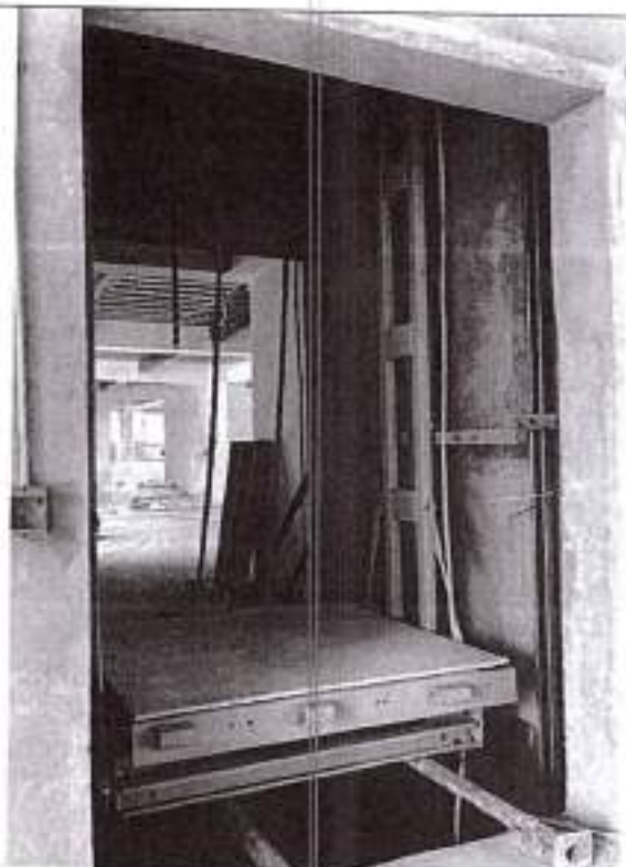
Fotografía 10 Instalación de ascensor
