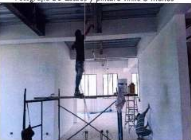
Fotografía 58 Estuco y pintura vinilo 3 manos
