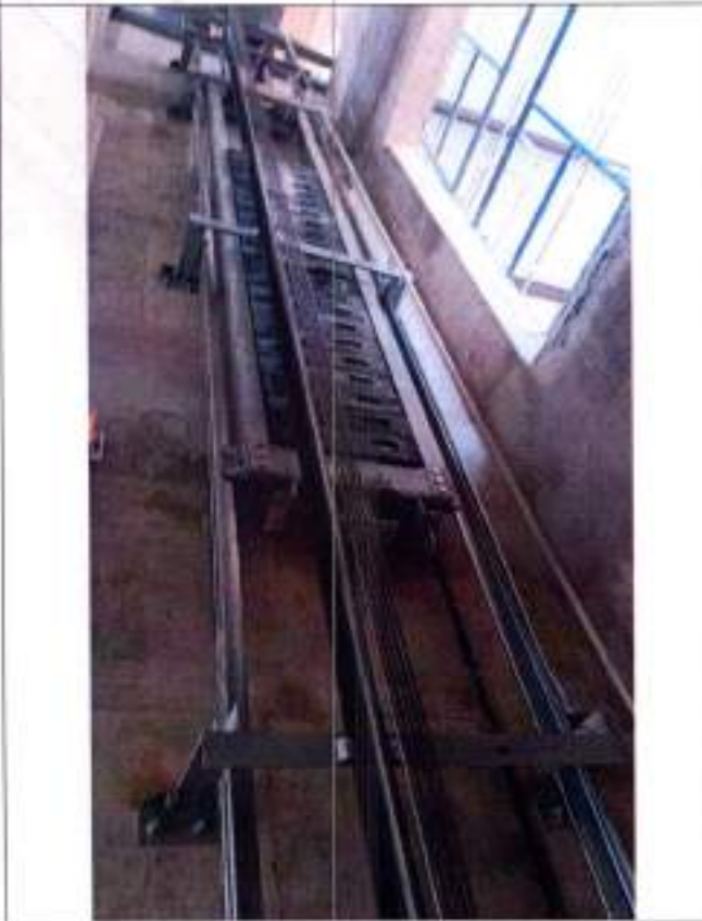
Fotografía 114 Instalación de contrapesos
