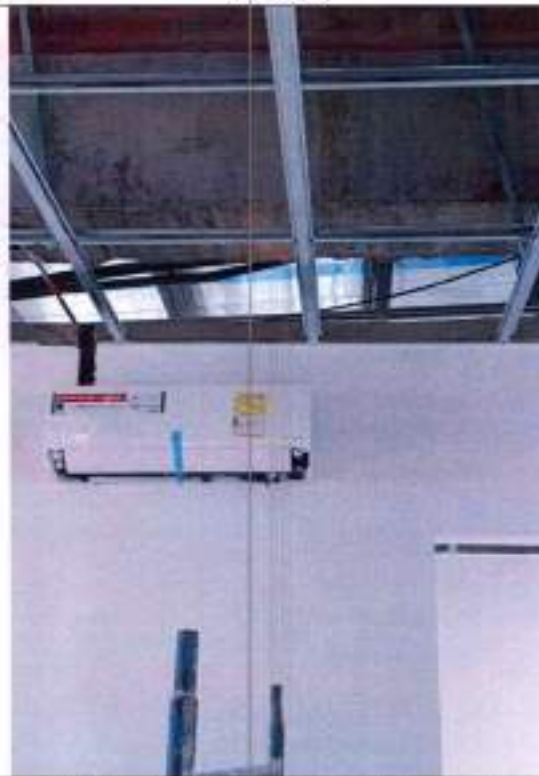
Fotografía 128 Instalación de equipo de aire tipo MiniSplit
