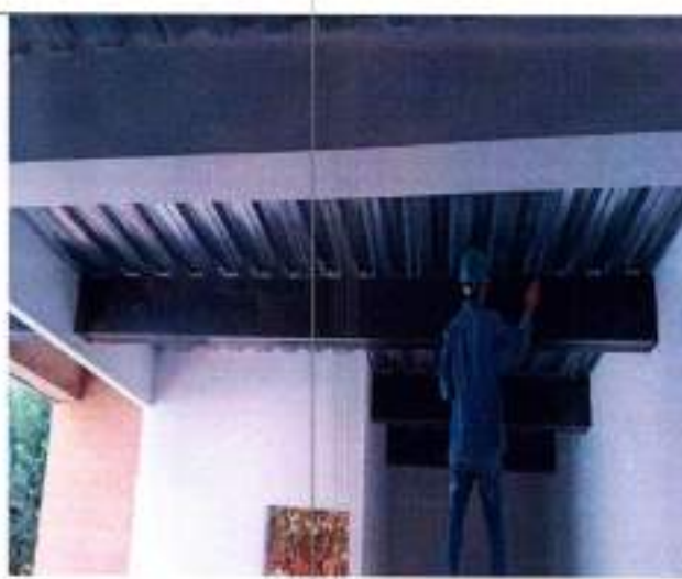
Fotografía 54 Estuco y pintura vinilo 3 manos
