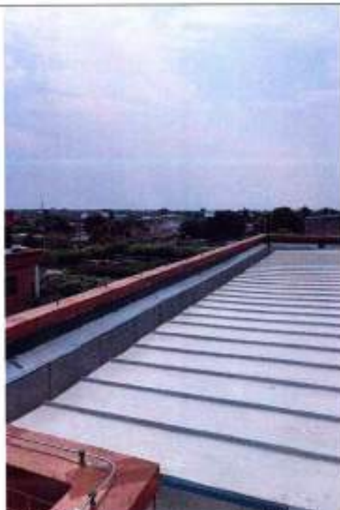
Fotografía 97 Anillo superior en alambazón de aluminio de 8mm y puntas captoras de 5/8x1m
