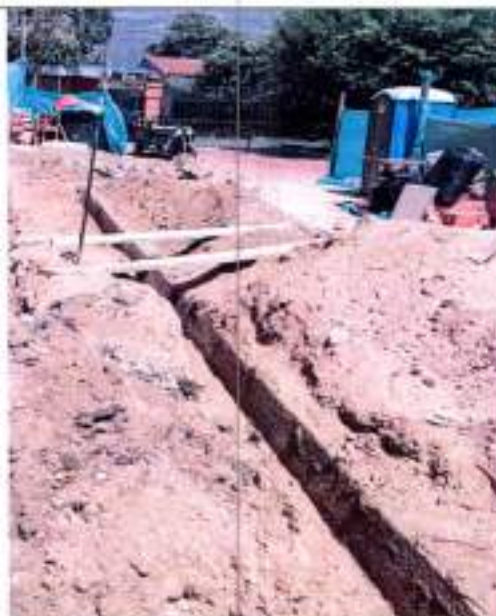
Fotografía 158 Excavación manual
