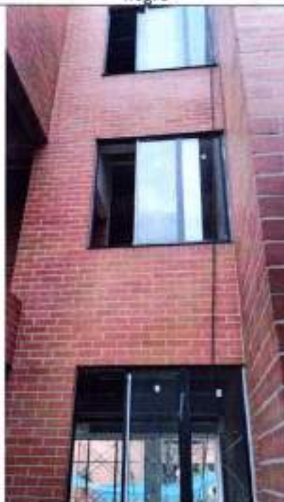
Fotografía 61 Instalación ventana corrediza en aluminio negro
