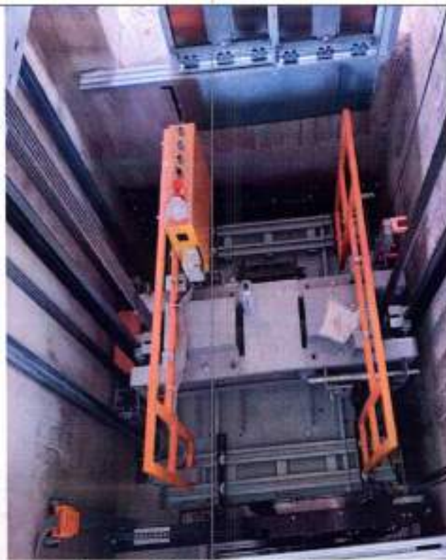
Fotografía 116 Instalación de cabina
