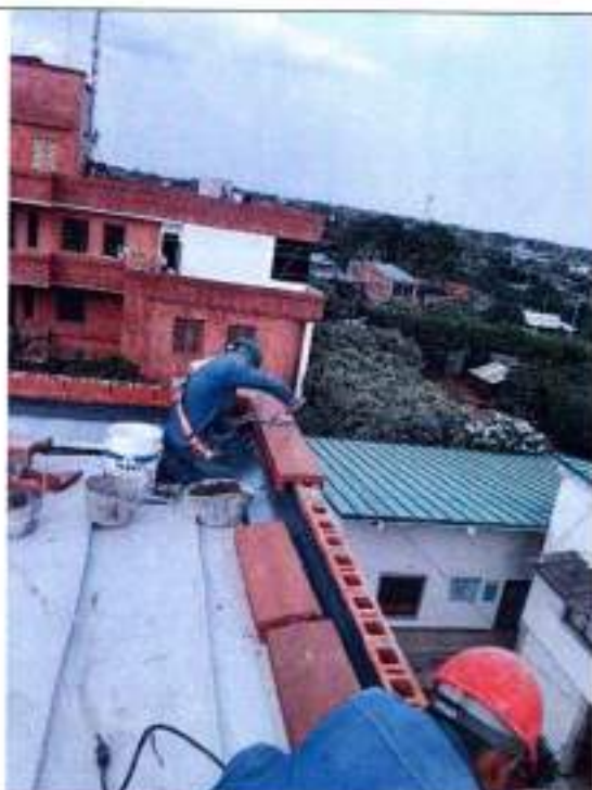
Fotografía 17 Instalación Alfajías en concreto
