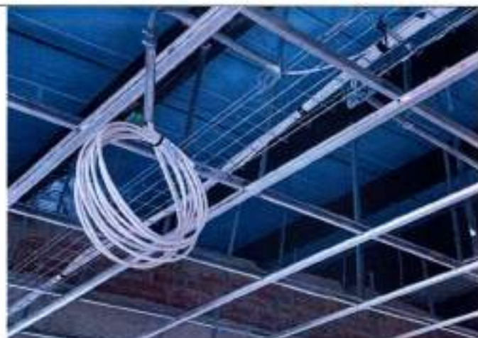
Fotografía 155 instalación Cable utp categoría 6a FIUTP LSZH o LSOH 100% cobre
