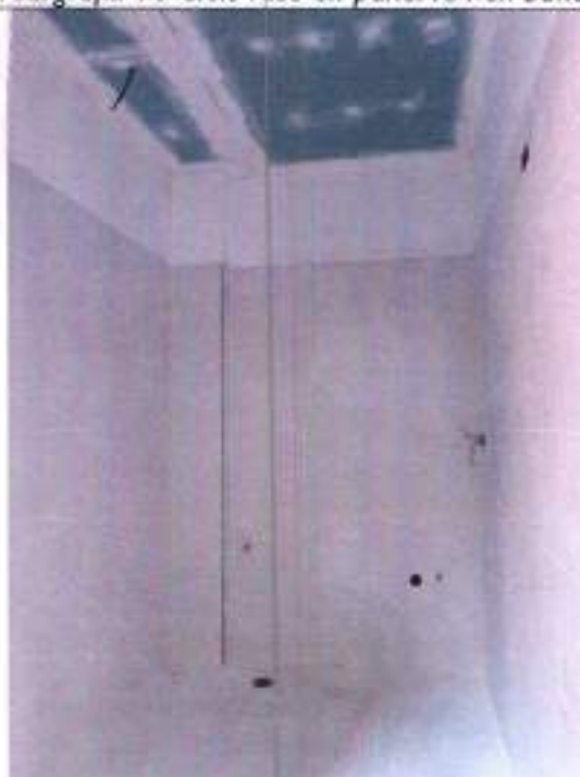
Fotografía 12 Cielo raso en panel RH en baños
