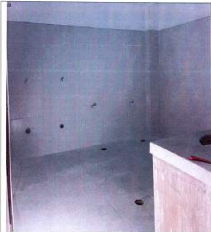
Fotografía 23 Enchape de piso y paredes de baños
