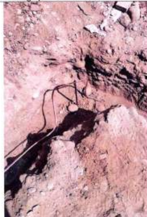
Fotografía 95 Varilla puesta a tierra en cobre al 99%
