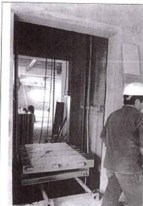
Fotografía 9 Instalación de ascensor
