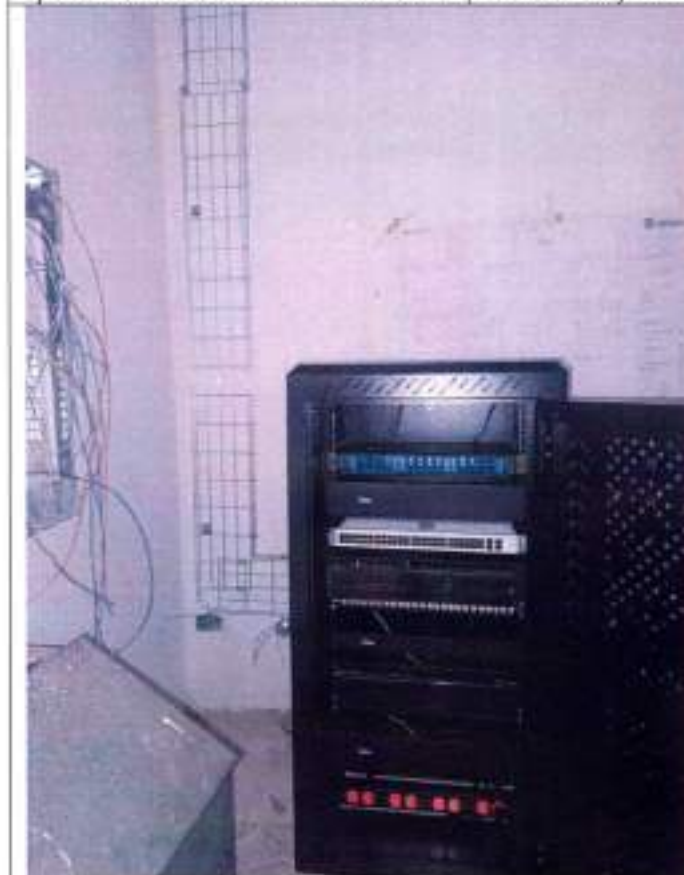
Fotografía 153 instalación de gabinete de datos tipo rack de 23 RU, 120 cm de altura
