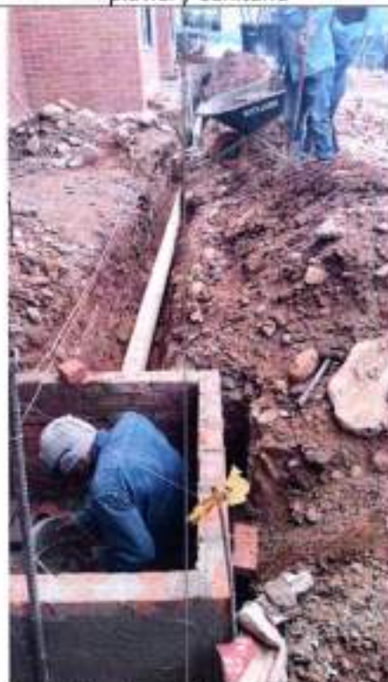
Fotografía 70 Instalación de tubería alcantarillado de 6"
