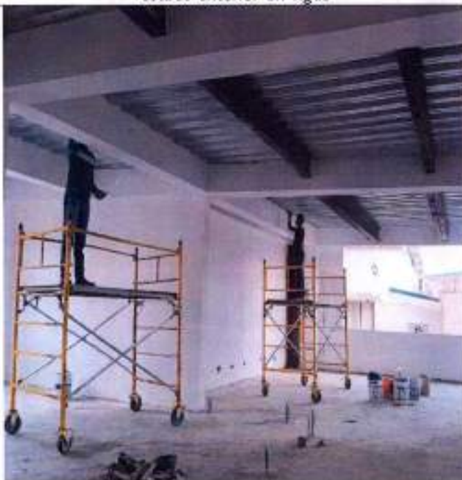
Fotografía 51 Estuco y pintura vinilo 3 manos
