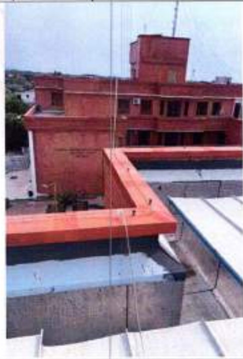
Fotografía 96 Anillo superior en alambirón de aluminio de 8mm y puntas captoras de 5/8x1m
