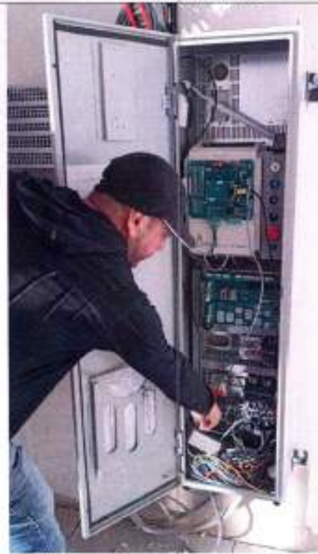
Fotografía 102 Montaje de tablero Ascensor (1, 2 y 3)
