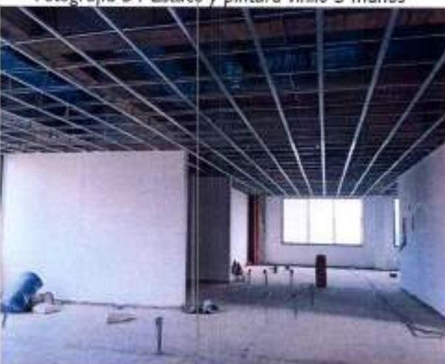
Fotografía 56 Estuco y pintura vinilo 3 manos
