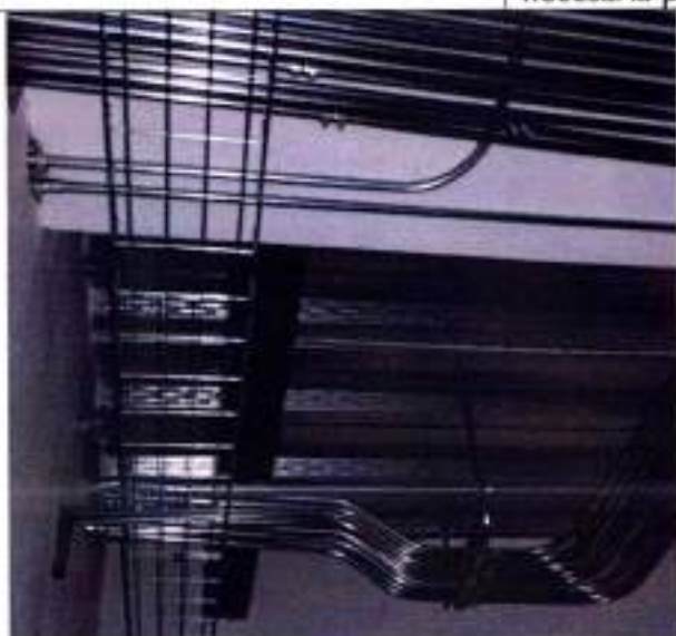
Fotografía 139 Montaje de bandeja portacables tipo malla
