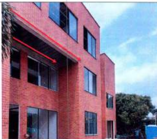
Fotografía 40 Pañete liso impermeabilizado en vigas
