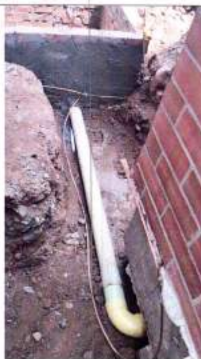
Fotografía 74 Instalación de tubería alcantarillado de 4"
