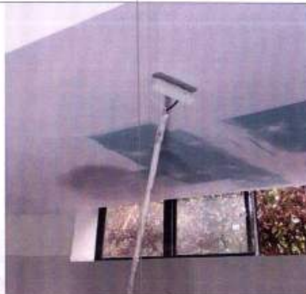
Fotografía 10 Cielo raso en panel RH en baños
