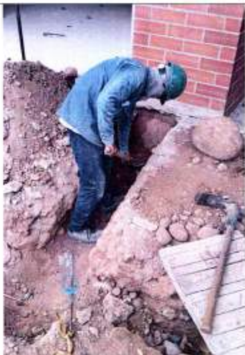
Fotografía 67 Excavación manual para tubería exterior pluvial y sanitaria
