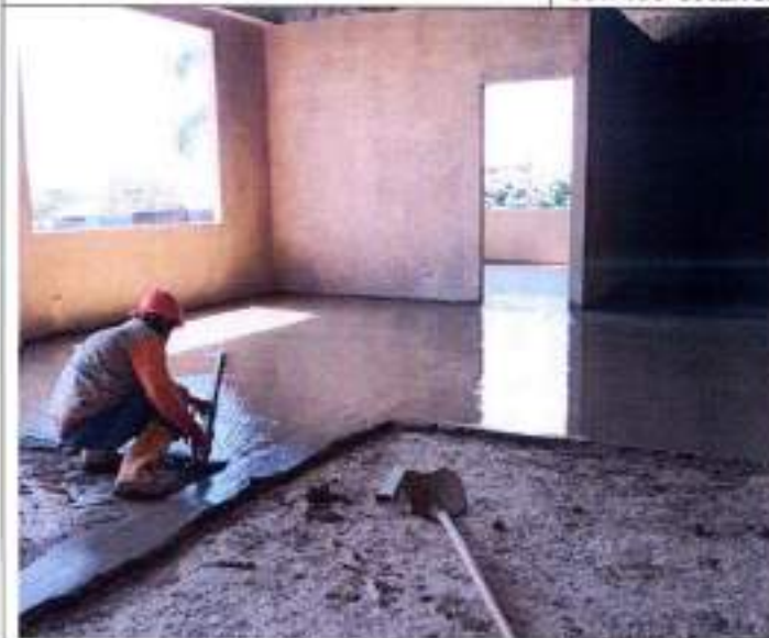
Fotografía 19 Alistado de piso en mortero 1:3
