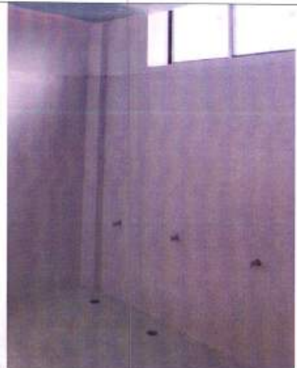
Fotografía 24 Enchape de piso y paredes de baños
