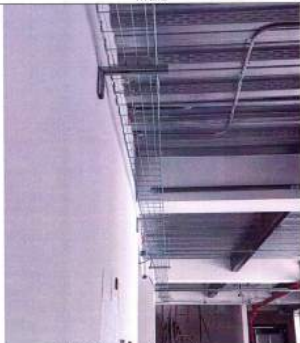
Fotografía 145 Montaje de bandeja portacables tipo malla
