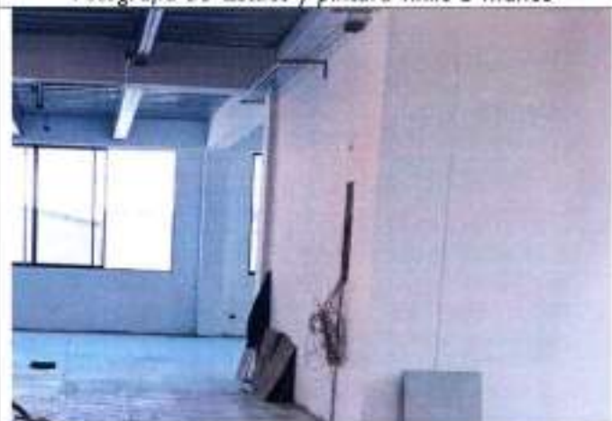
Fotografía 57 Estuco y pintura vinilo 3 manos
