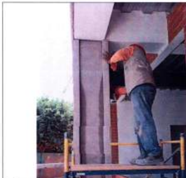
Fotografía 39 Pañete liso impermeabilizado en columna
