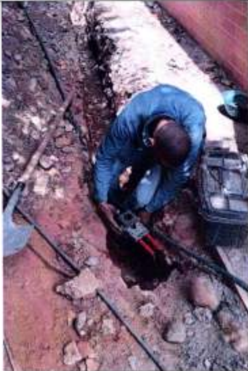
Fotografía 93 Soldadura exotérmica
