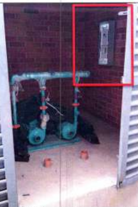
Fotografía 104 Montaje de tablero bombas agua potable
