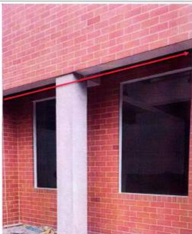
Fotografía 49 Limpieza de ladrillo estructural a la vista y estuco exterior en vigas
