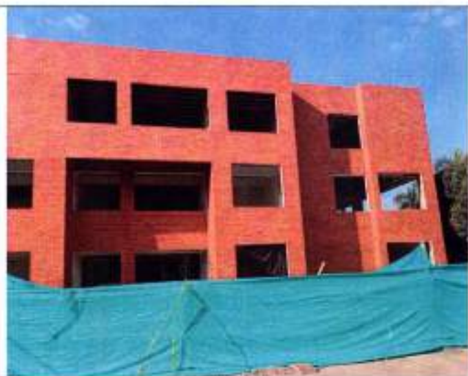
Fotografía 47 Limpieza de ladrillo estructural a la vista
