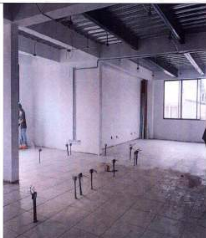
Fotografía 29 Enchape de piso cerámico 61x61
