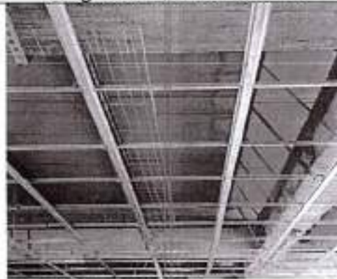
Fotografía 4 Instalación bandeja portacables para red de voz y datos
