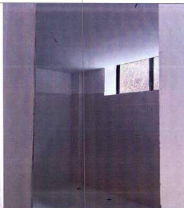
Fotografía 14 Cielo raso en panel RH en baños
