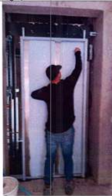
Fotografía 118 Instalación puertas de cabina
