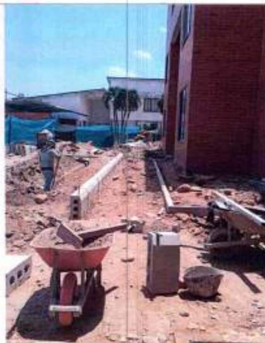
Fotografía 160 Conformación e instalación de bordillo para urbanismo
