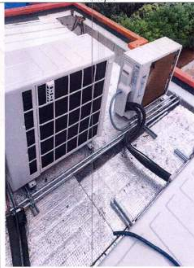
Fotografía 132 Montaje de manejadoras
