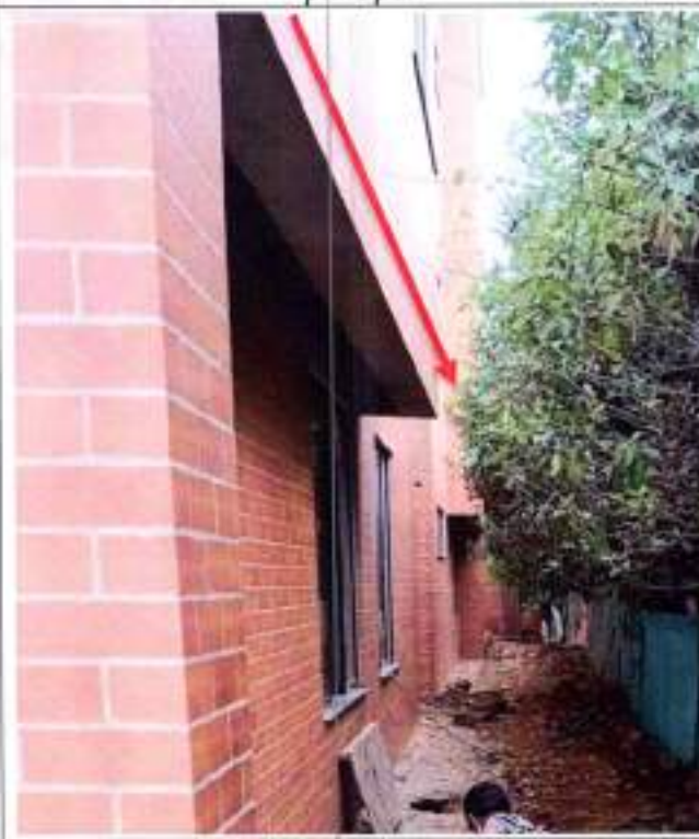
Fotografía 38 Pañete liso impermeabilizado en vigas
