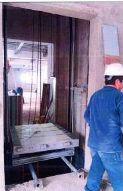
Fotografía 115 Instalación piso para cabina
