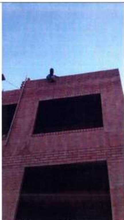
Fotografía 31 Muro en ladrillo estructural fachada principal
