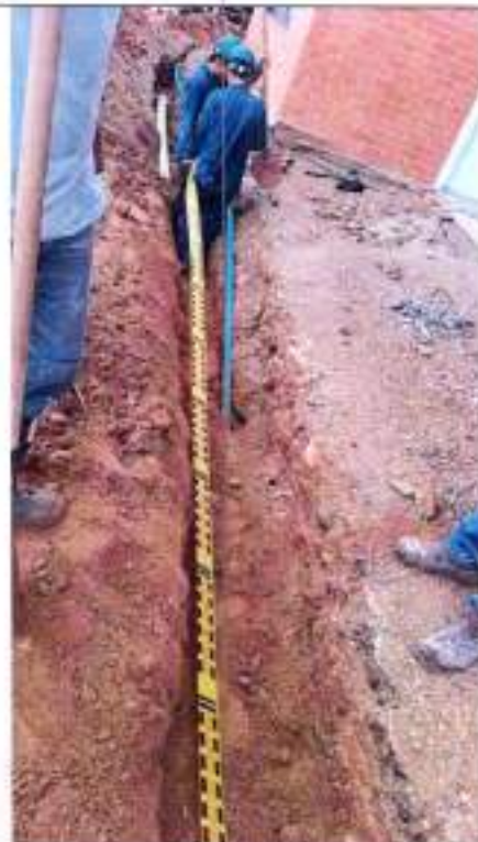
Fotografía 76 Relleno con material
