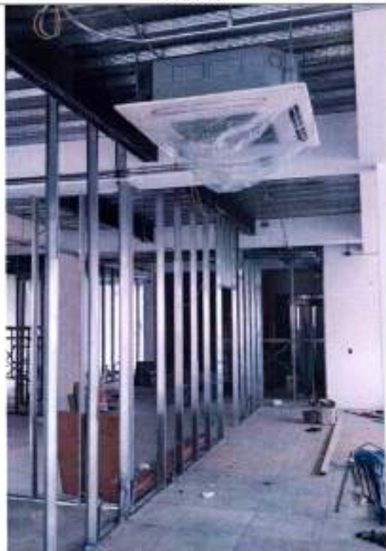
Fotografía 127 Instalación de equipo de aire tipo cassette
