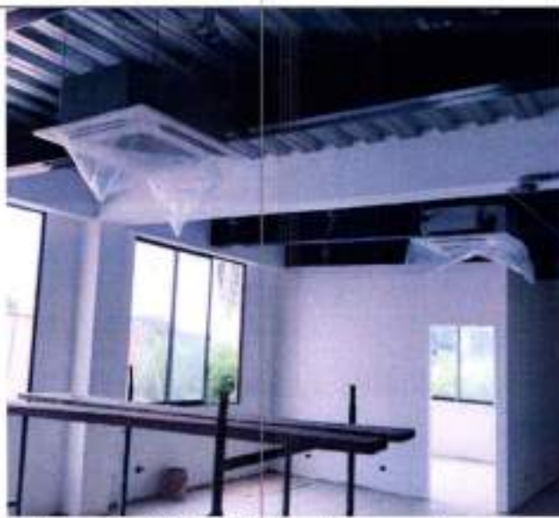
Fotografía 126 Instalación de equipo de aire tipo cassette
