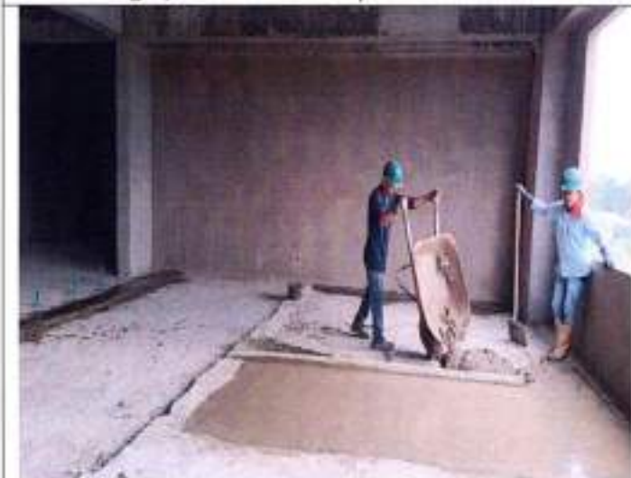
Fotografía 21 Alistado de piso en mortero 1:3
