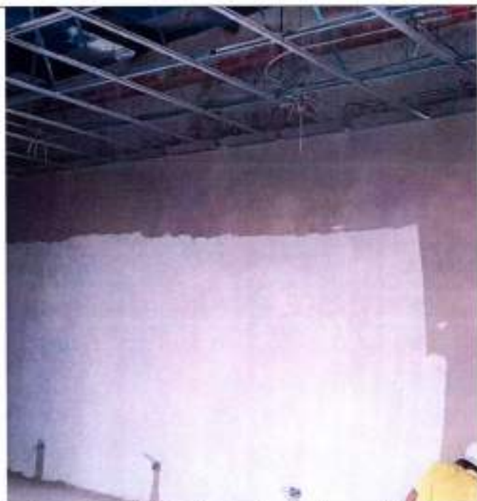
Fotografía 107 Salida para luminarias y salidas para tomacorrientes
