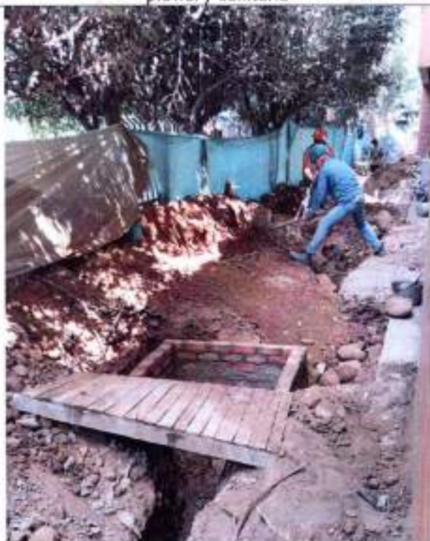
Fotografía 69 Excavación manual para tubería exterior pluvial y sanitaria
