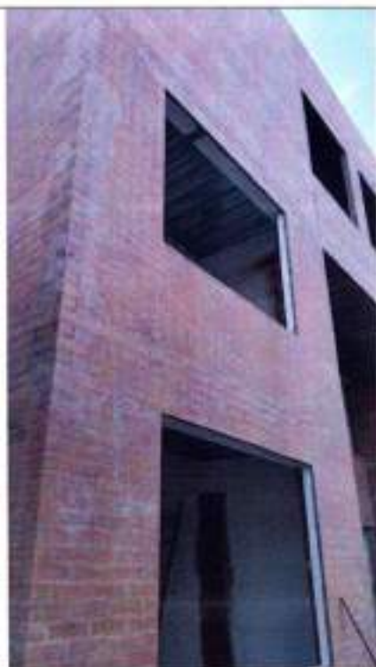
Fotografía 35 Muro en ladrillo estructural fachada principal
