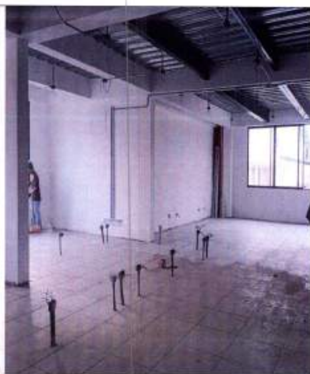
Fotografía 28 Enchape de piso cerámico 61x61
