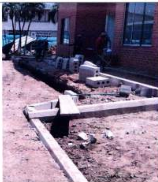
Fotografía 157 Conformación e instalación de bordillo para urbanismo
