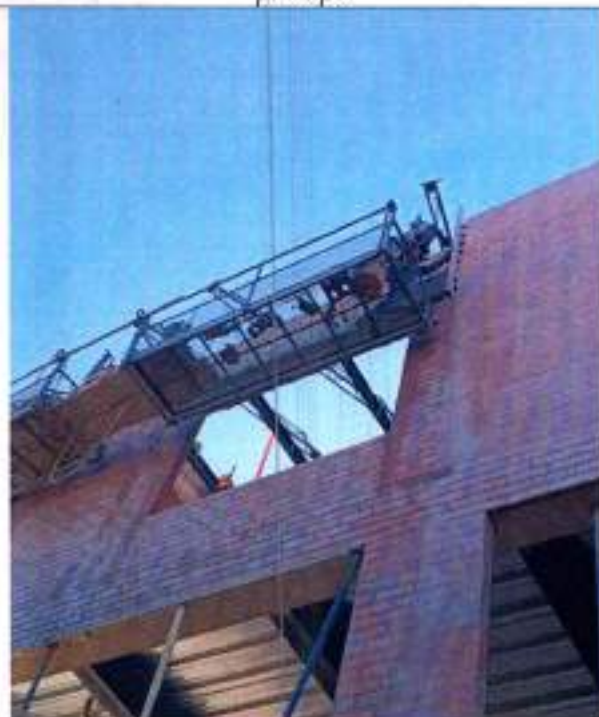
Fotografía 34 Muro en ladrillo estructural fachada principal
