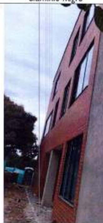
Fotografía 62 Instalación ventana corrediza en aluminio negro
