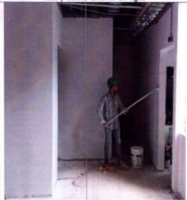
Fotografía 52 Estuco y pintura vinilo 3 manos
