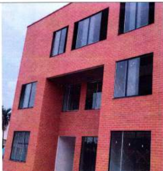
Fotografía 63 Instalación ventana corrediza en aluminio negro
