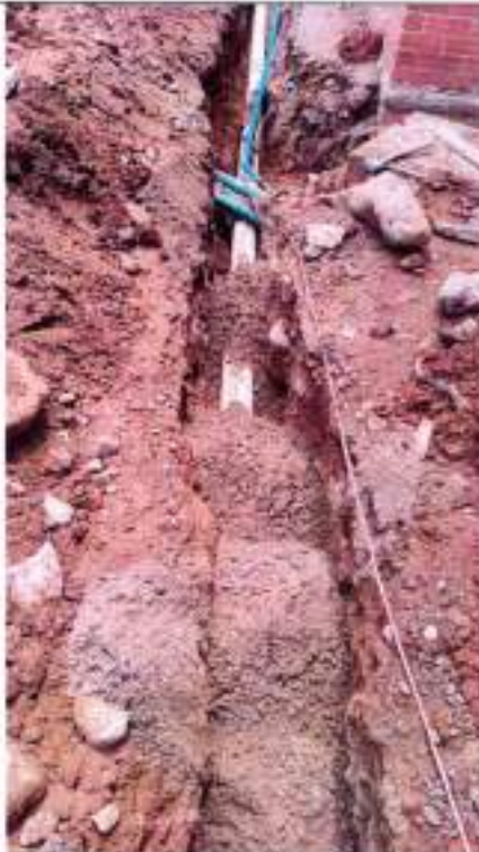
Fotografía 75 Relleno en arena lavada
