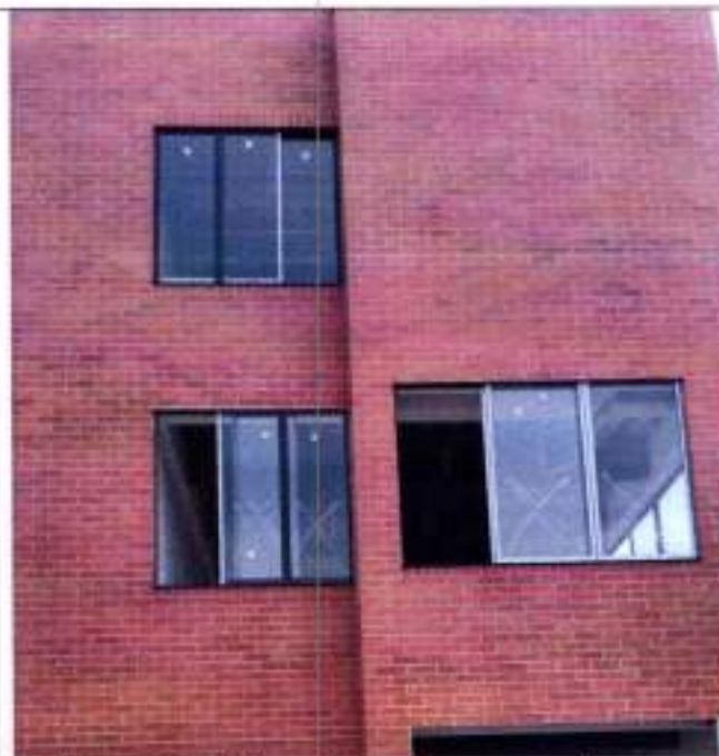
Fotografía 64 Instalación ventana corrediza en aluminio negro
