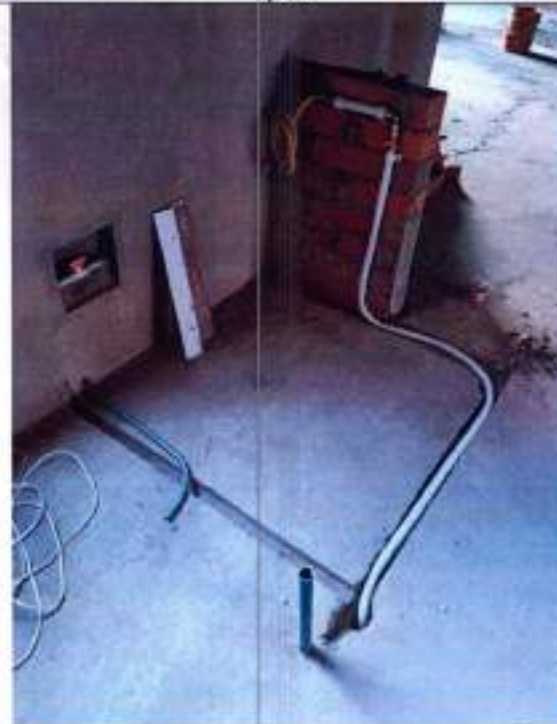
Fotografía 170 Instalación Tubería de cobre Tipo "L" D=3/4"
