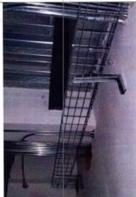
Fotografía 142 Montaje de bandeja portacables tipo malla
