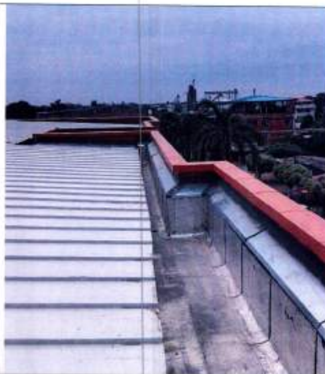
Fotografía 18 Instalación Alfajías en concreto
