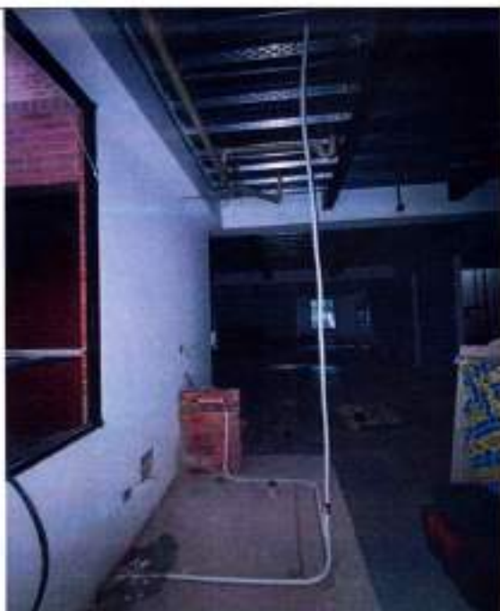
Fotografía 167 Instalación Tubería de cobre Tipo "L" D=3/4" y Tubería de cobre Tipo "L" D=1/2" primer piso
