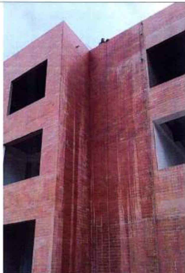
Fotografía 45 Limpieza de ladrillo estructural a la vista
