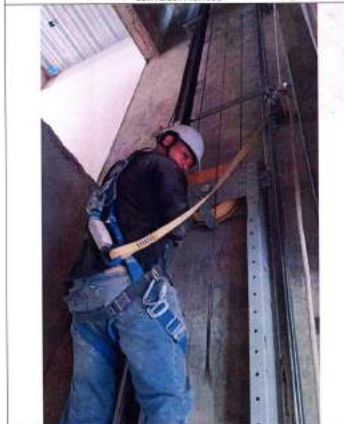
Fotografía 113 Instalación de rieles para ascensor
