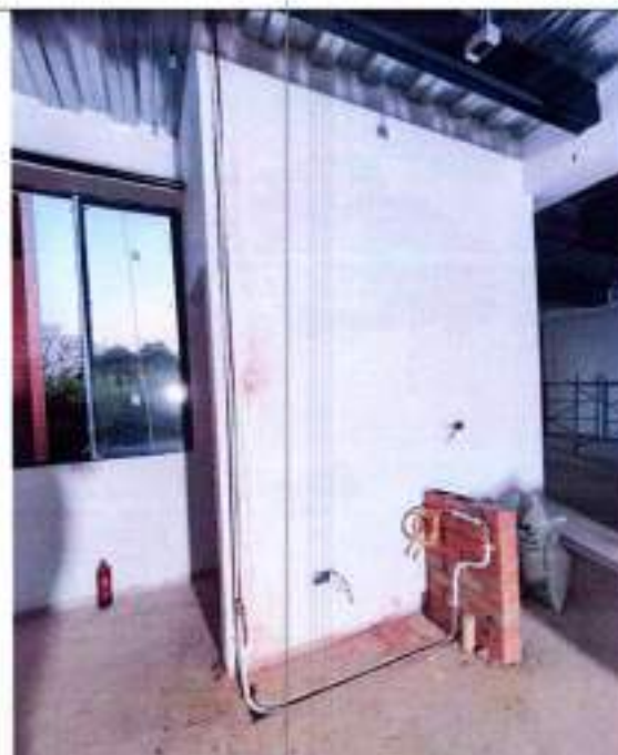
Fotografía 168 Instalación Tubería de cobre Tipo "L" D=3/4" y Tubería de cobre Tipo "L" D=1/2" segundo piso
