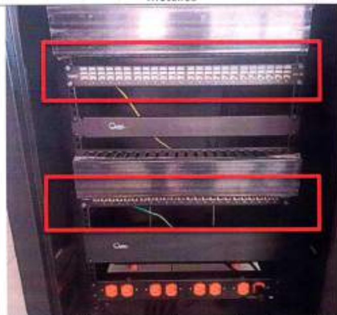
Fotografía 149 Montaje gabinete de datos tipo rack de 23RU, 120CM con patch panel de 24 puertos
