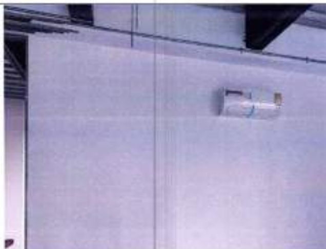
Fotografía 130 Instalación de equipo de aire tipo MiniSplit
