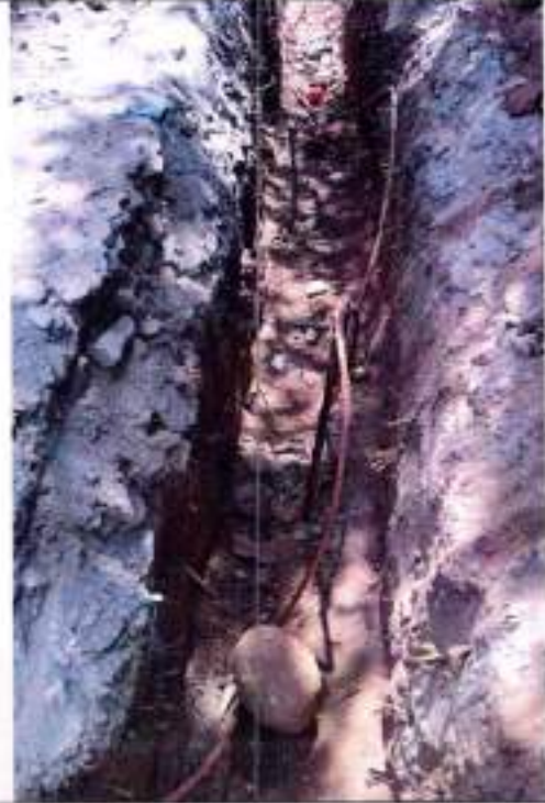
Fotografía 94 Varilla puesta a tierra en cobre al 99%
