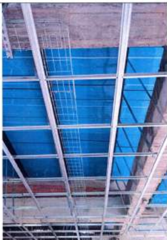
Fotografía 143 Montaje de bandeja portacables tipo malla
