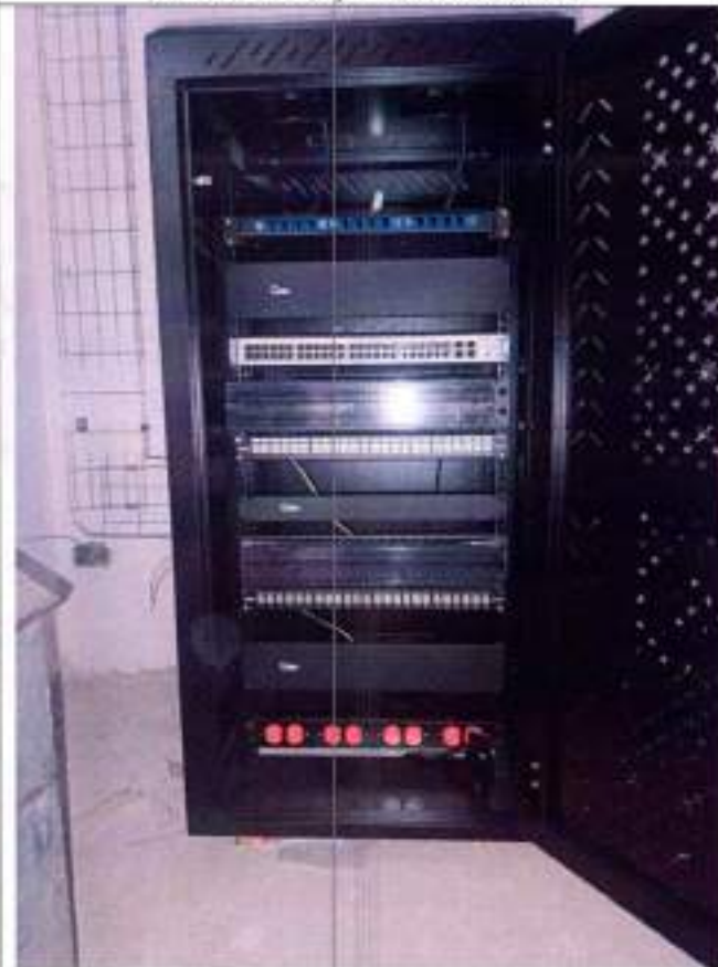
Fotografía 154 instalación de gabinete de datos tipo rack de 23 RU, 120 cm de altura
