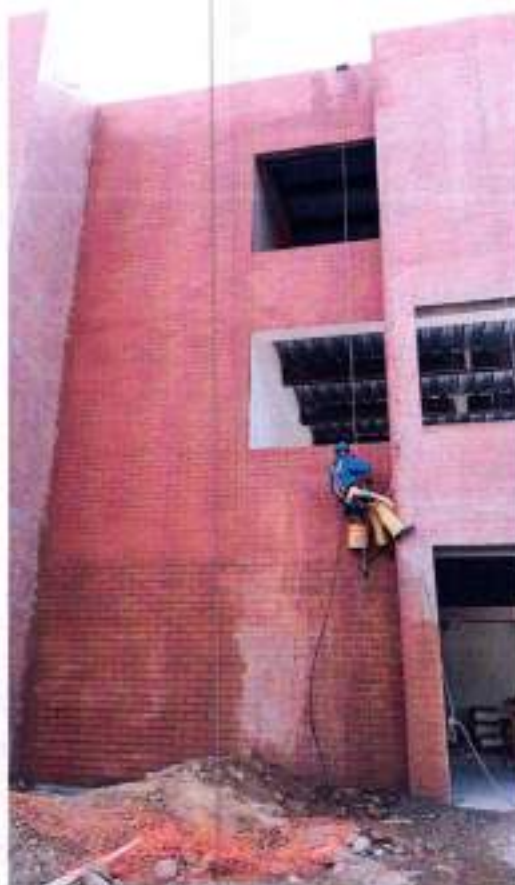
Fotografía 46 Limpieza de ladrillo estructural a la vista
