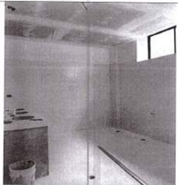
Fotografía 6 Instalación cielo raso Drywall
