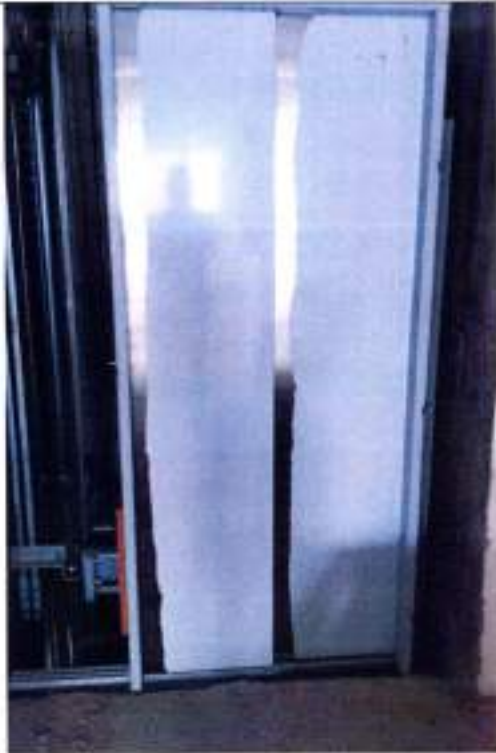
Fotografía 119 Instalación puertas de cabina
