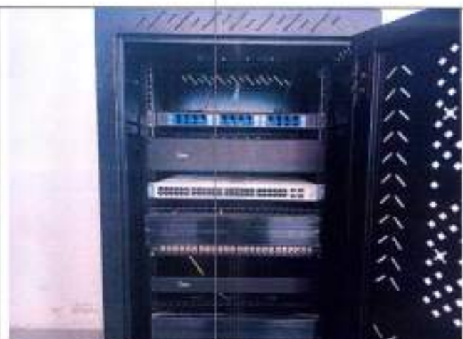
Fotografía 152 instalación de gabinete de datos tipo rack de 23 RU, 120 cm de altura
