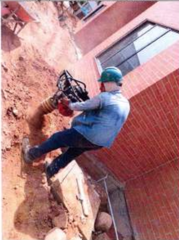
Fotografía 77 Compactación de Relleno con material
