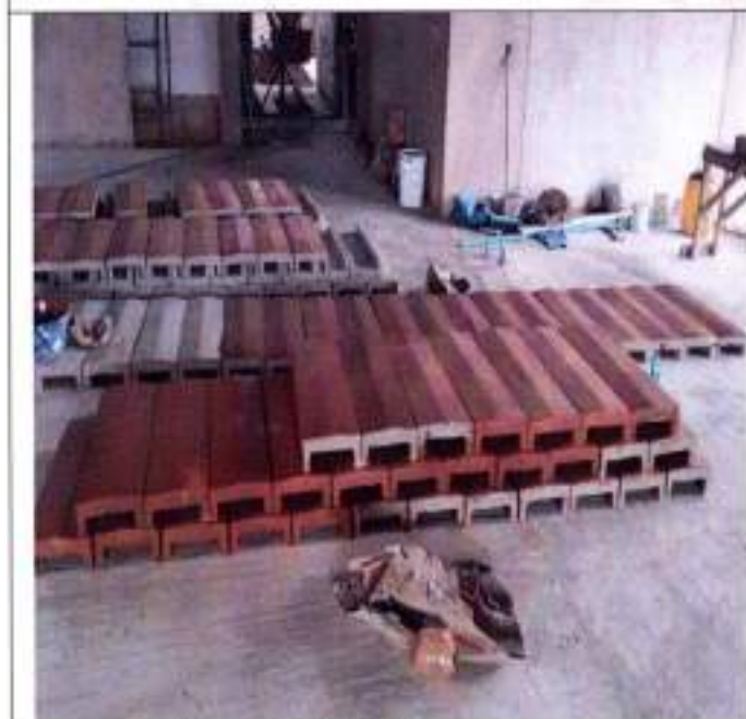
Fotografía 15 Alfajías en concreto
