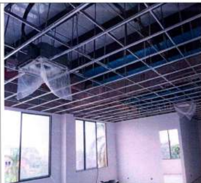
Fotografía 121 Instalación de equipo de aire tipo cassette y tubería en cobre
