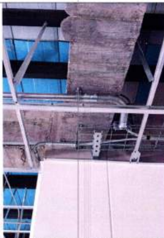
Fotografía 144 Montaje de Tubería Emt de 1 1/4"
