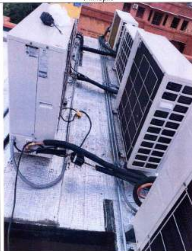
Fotografía 131 Montaje de manejadoras
