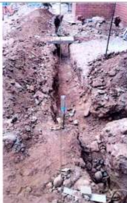
Fotografía 68 Excavación manual para tubería exterior pluvial y sanitaria
