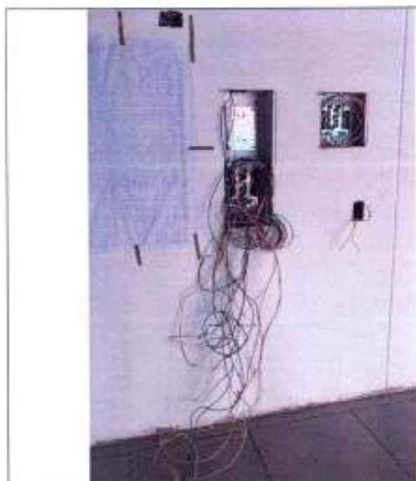
Fotografía 103 Cableado de acometidas parciales para tableros de distribución
