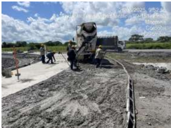
Construcción de subbase Tramo villa Fátima
