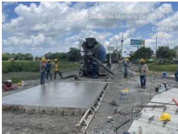
Pavimento en concreto Tramo villa Fátima
