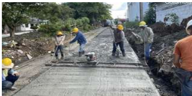
Mejoramiento – tramo San José
