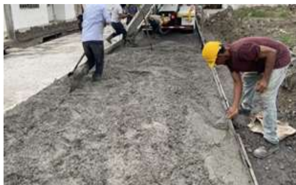
Mejoramiento - tramo Santa Barbara
