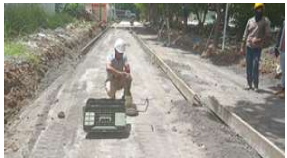
Mejoramiento – tramo San José
