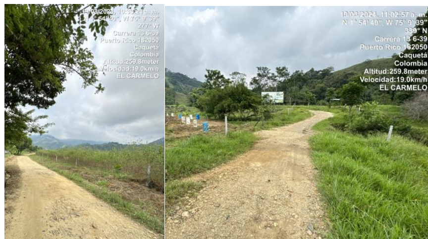
Ilustración 1. Estado actual de la vía.
