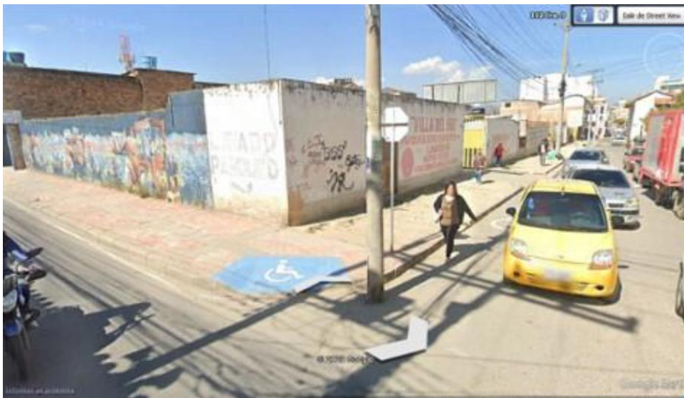
Figura 1. Estado actual, CALLE 11 ANDEN SUR
