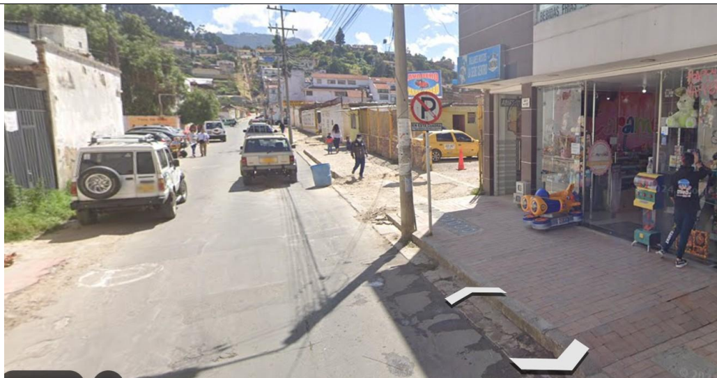
Figura 2 y 3. Estado actual, CALLE 11 ANDÉN SUR.
