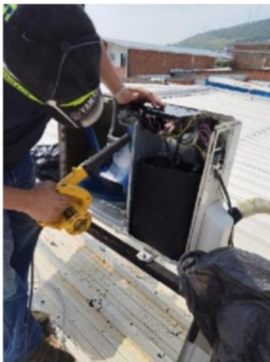
Imagen 17. Mantenimiento A.A. personería
