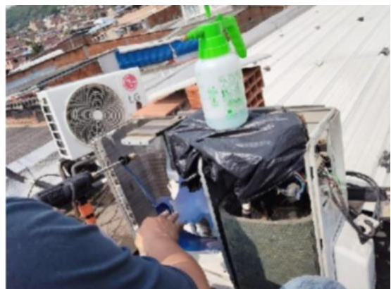
Imagen 22. Mantenimiento A.A. personería
