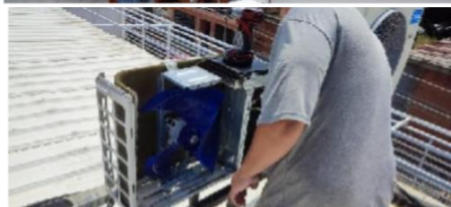
Imagen 3. Mantenimiento A.A planeación sala de Reuniones
