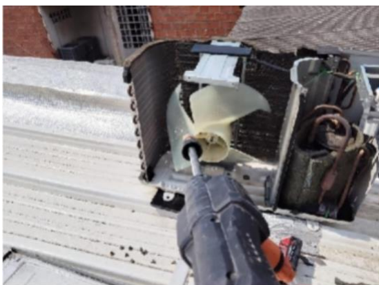
Imagen 25. Mantenimiento A.A. personería
