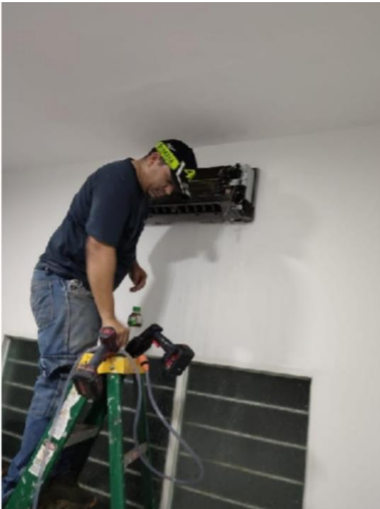
Imagen 30. Mantenimiento A.A. personería
