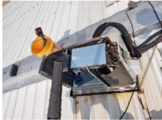
Imagen 19. Mantenimiento A.A. personería
