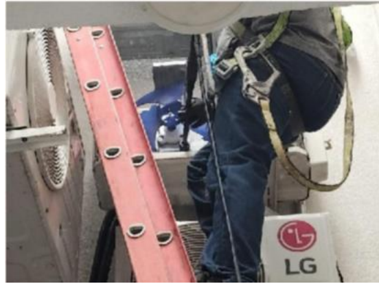
Imagen 32. Mantenimiento A.A. personería
