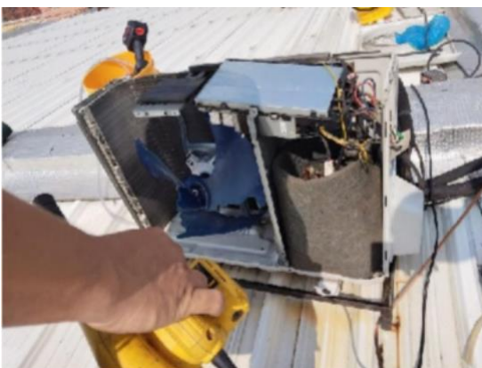
Imagen 18. Mantenimiento A.A. personería
