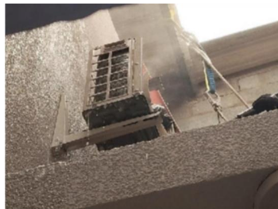
Imagen 34. Mantenimiento A.A. personería
