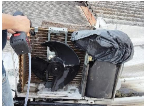
Imagen 21. Mantenimiento A.A. personería
