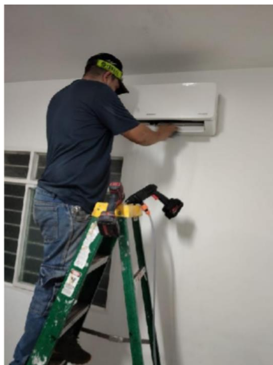
Imagen 27. Mantenimiento A.A. personería
