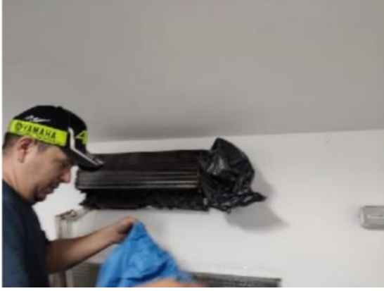
Imagen 29. Mantenimiento A.A. personería
