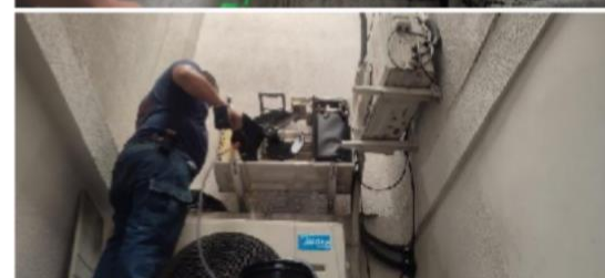
Imagen 15. Mantenimiento A.A. personería condensadora oficina 108 archivo
