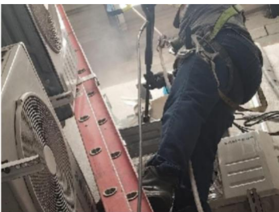
Imagen 31. Mantenimiento A.A. personería
