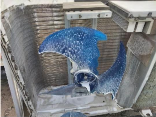
Imagen 16. Mantenimiento A.A. personería condensadora oficina 105
