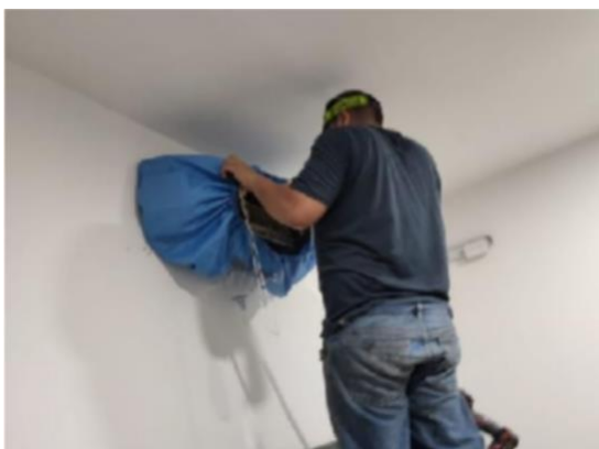
Imagen 24. Mantenimiento A.A. personería
