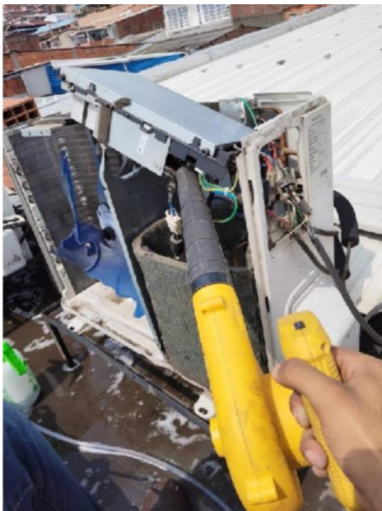
Imagen 23. Mantenimiento A.A. personería
