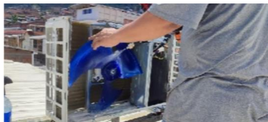
Imagen 2. Mantenimiento A.A planeación condensadora
