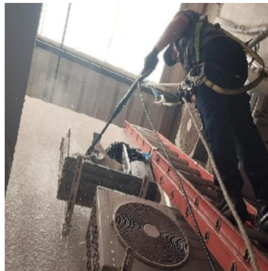
Imagen 33. Mantenimiento A.A. personería
