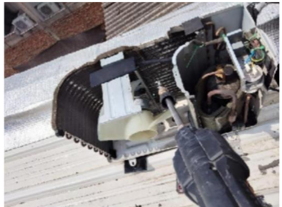
Imagen 20. Mantenimiento A.A. personería
