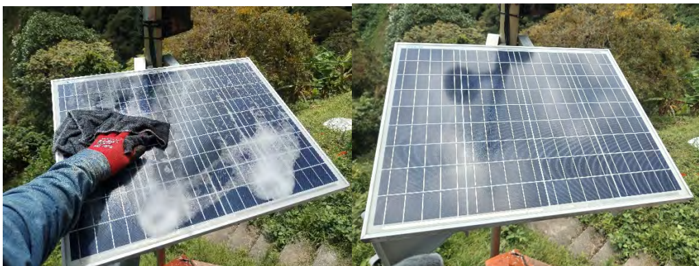
Ilustración 117: Limpieza de paneles solares.
