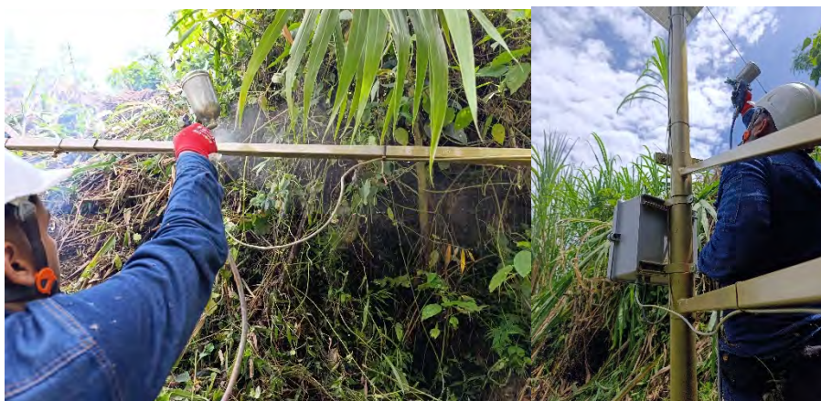
Ilustración 3: Aplique de pintura anticorrosiva.
