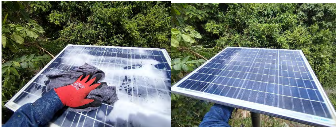
Ilustración 2: Limpieza de paneles solares.
