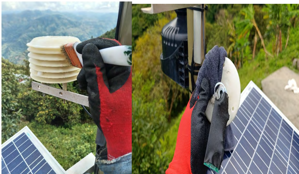
Ilustración 139: Limpieza sensor de temperatura y humedad.
