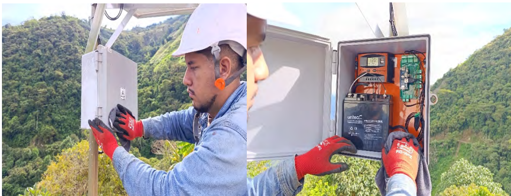
Ilustración 10: Limpieza de gabinete de estación.
