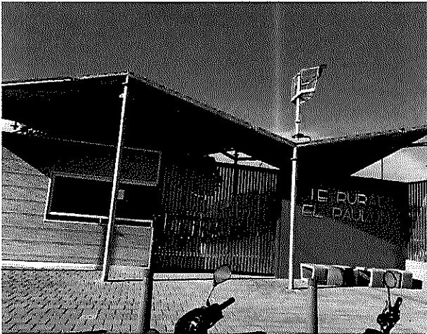
Condiciones locativas: Fachada Institución
