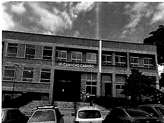
Condiciones locativas: Fachada institución
