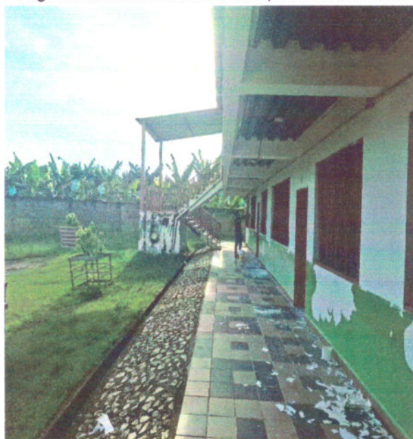
Fotografía 52. Remoción de cada de pintura existente deteriorada en paredes externas de bloque de salones.
