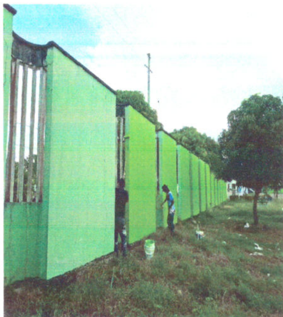
Fotografía 65. Paredes internas de salón mantenidas con pintura tipo I.
