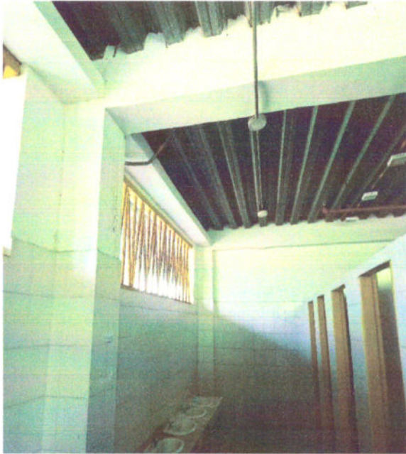
Fotografía 20. Protectores metálicos de ventanas mantenidas y pintadas.
