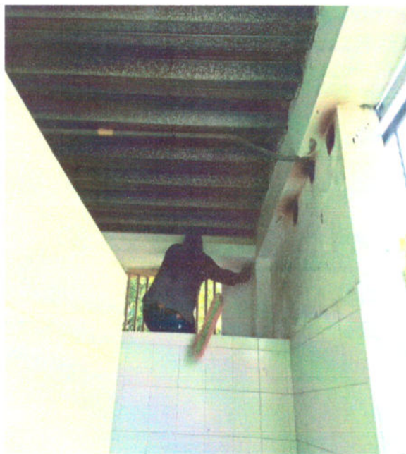
Fotografía 40. Aplicación de primera mano de pintura acrílica hidrorrepelente en paredes externas.
