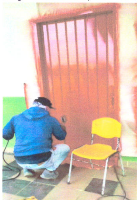
Fotografía 23. Labores de pintura base aceite para mantenimiento de puerta metálica.
