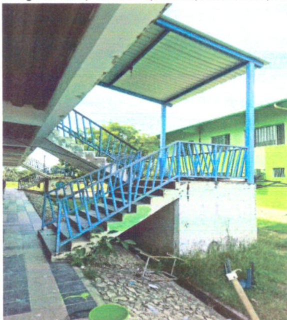
Fotografía 68. Aplicación de pintura tipo acrílica en paredes de escalinata.
