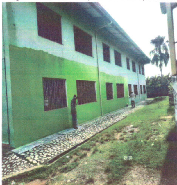
Fotografía 57. Aplicación de pintura acrílica de paredes externas.
