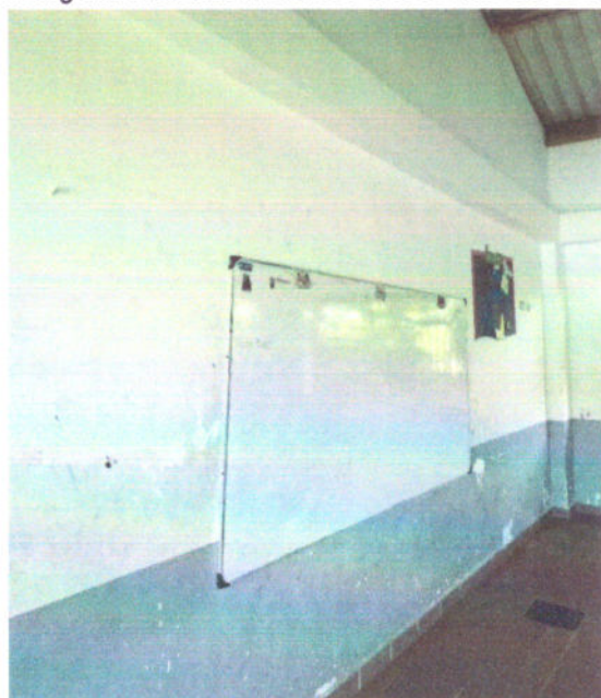
Fotografía 4. Remoción de capas de pintura desgasta y deteriorada.
