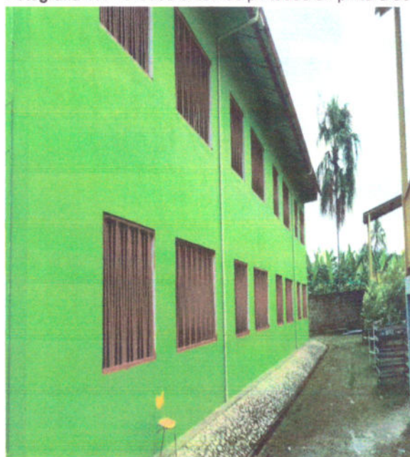
Fotografía 17. Paredes externas pintadas en pintura acrílica con hidrorrepelente.
