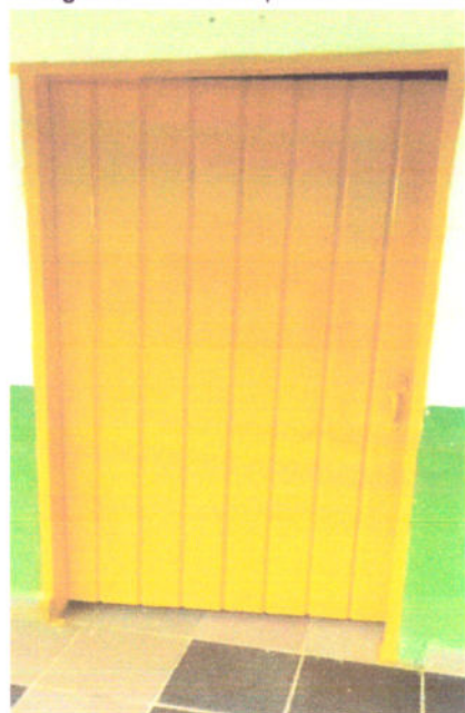
Fotografía 7. Pintura tipo esmalte a base de aceite puerta metálica.
