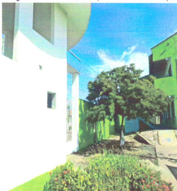
Fotografía 47. Fachada de Bloques mantenidas con aplicación de pintura acrílica con hidrorrepelente.
