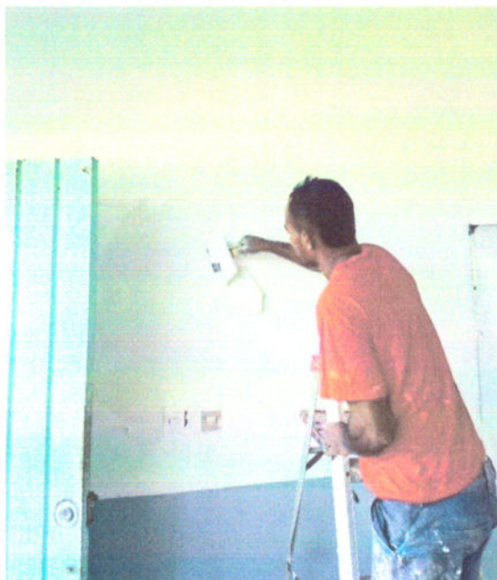
Fotografía 5. Aplicación de pintura acrílica en paredes externas a la intemperie.
