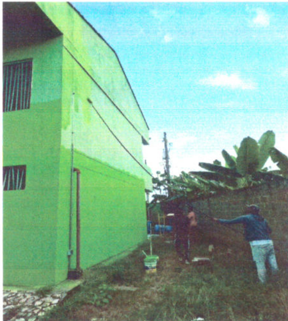
Fotografía 50. Fachada de bloque pintadas en pintura acrílica con hidorepelente.
