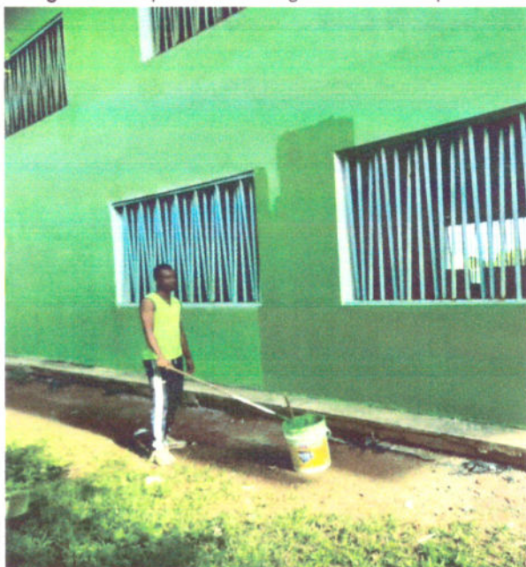
Fotografía 51. Aplicación de segunda mano de pintura acrílica en paredes externas de bloque.
