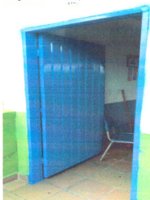
Fotografía 10. Pintura tipo esmalte a base de aceite puerta metálica.
