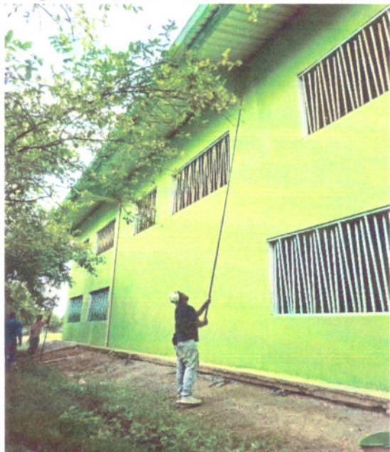
Fotografía 5. Aplicación de pintura acrílica en paredes externas a la intemperie.
