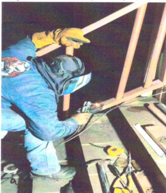
Fotografía 37. Soldadura de piezas de pasamanos y baranda en escaleras
