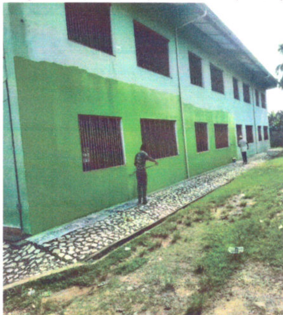
Fotografía 67. Aplicación de primera mano de pintura tipo Koraza con hidorepelente en paredes externas de bloque.
