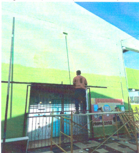
Fotografía 40. Aplicación de primera mano de pintura acrílica hidrorrepelente en paredes externas.
