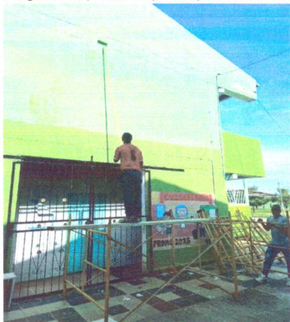
Fotografía 56. Aplicación de pintura tipo acrílica en fachada lateral de bloque de salones.
