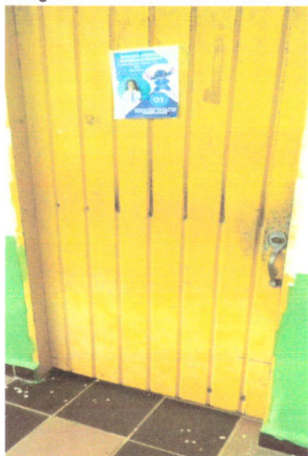
Fotografía 16. Estado inicial de Puertas metálica de acceso.
