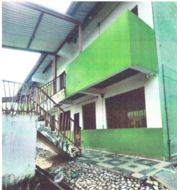
Fotografía 50. Fachada de bloque pintadas en pintura acrílica con hidorepelente.
