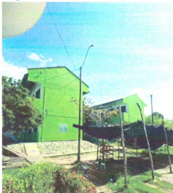
Fotografía 48. Fachada Lateral de Bloques mantenidas con aplicación de pintura acrílica con hidrorrepelente.
