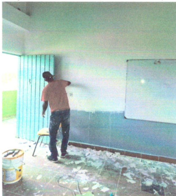
Fotografía 22. Remoción de capa deterioradas de pintura existente en salones.
