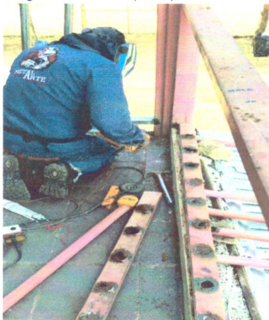
Fotografía 38. Soldadura para reparación de estructura metálica..
