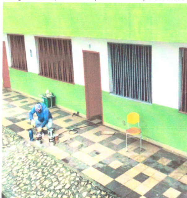
Fotografía 32. Aplicación de pintura acrílica para fachada de bloque de Salones.
