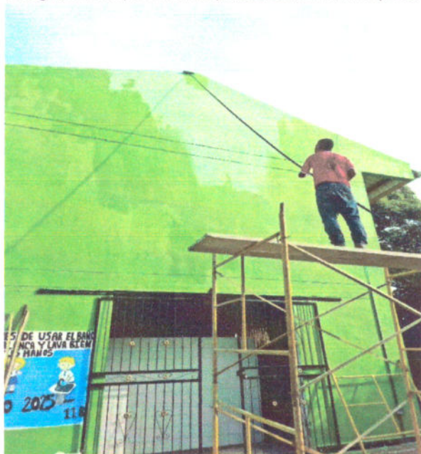
Fotografía 42. Aplicación de pintura acrílica hidrorrepelente en paredes externas.con trabajo de altura.
