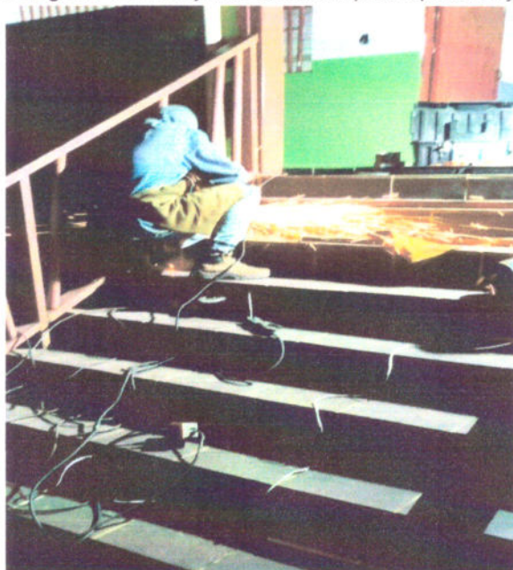
Fotografía 15. Trabajos de soldadura para reparación y mantenimiento de pasamano metálico
