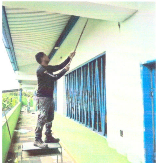
Fotografía 60. Pintura acrílica con hidorepelente para paredes externas de salones,
