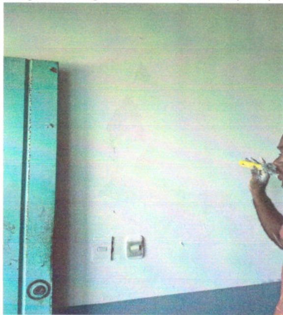
Fotografía 12. Registro inicial de estado de capa de pintura existente.
