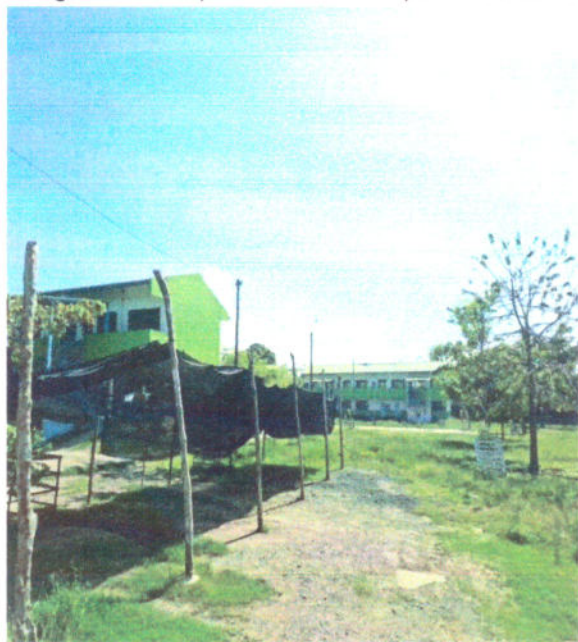
Fotografía 41. Bloque de Salones con paredes externas pintadas.
