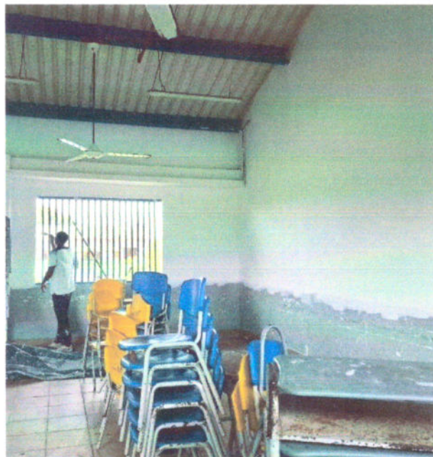
Fotografía 60. Pintura acrílica con hidorepelente para paredes externas de salones,
