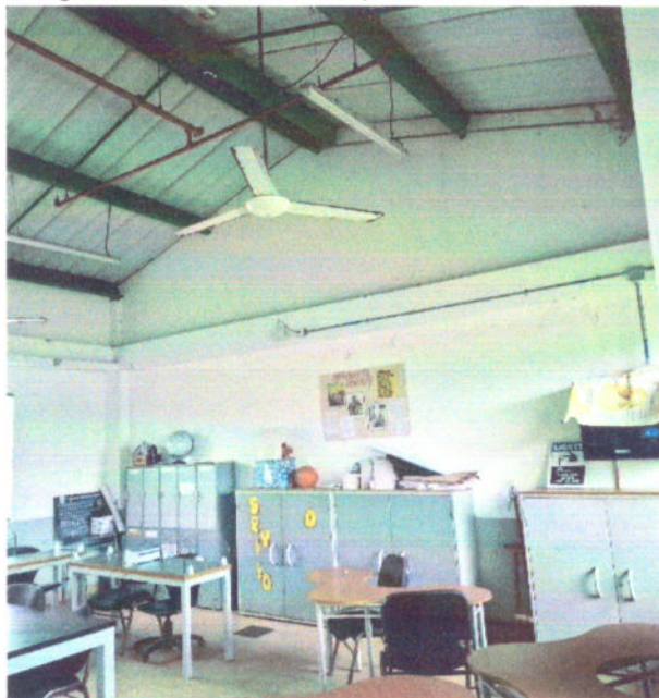
Fotografía 21. Estado inicial de paredes internas de Salones
