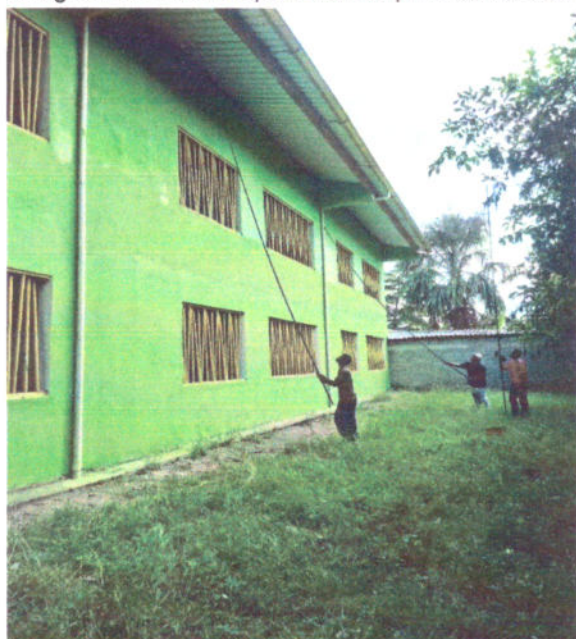
Fotografía 72. Fachada posterior con primera mano de pintura acrílica,
