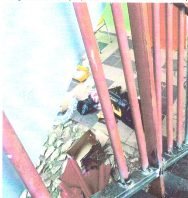
Fotografía 31. Corte y reposición de elemento vertical de pasamanos
