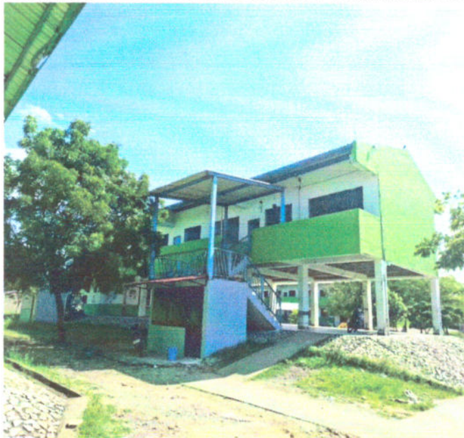
Fotografía 62. Fachada de bloque de salones con pintura acrílica
