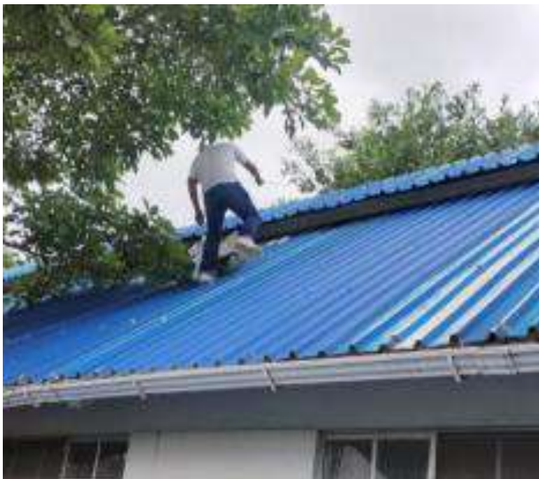
Mantenimiento de instalaciones – Biblioteca Pública Distrital Las Gardenias
