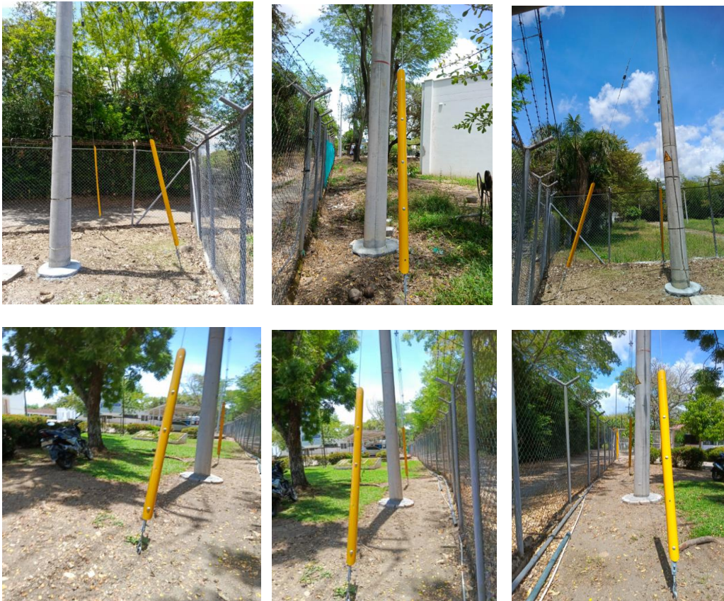
Mejoras red de media tensión
