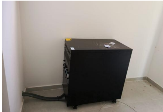
Proceso instalación de UPS Edificio Administrativo
