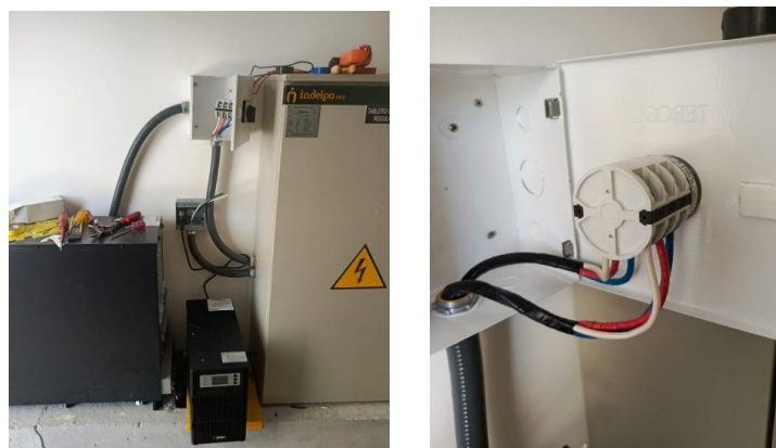
Proceso instalación UPS Pabellón de agudos
