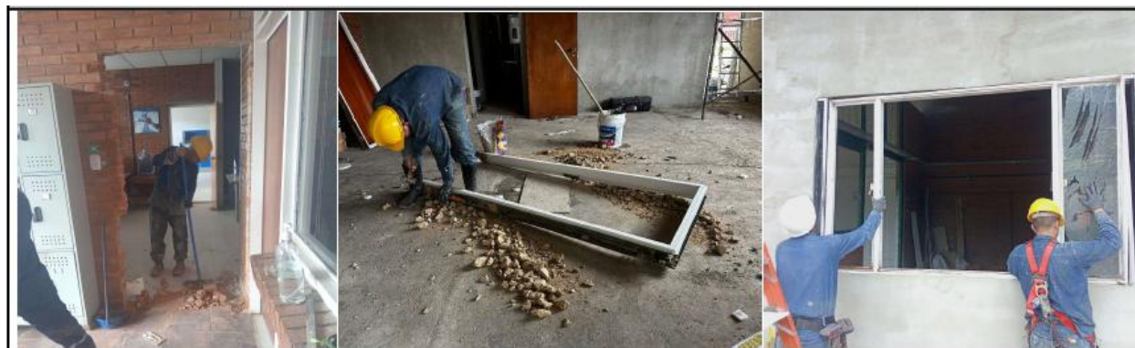
NP14-014 Lavado y vinilo a dos manos sobre muros en ladrillo a la vista
