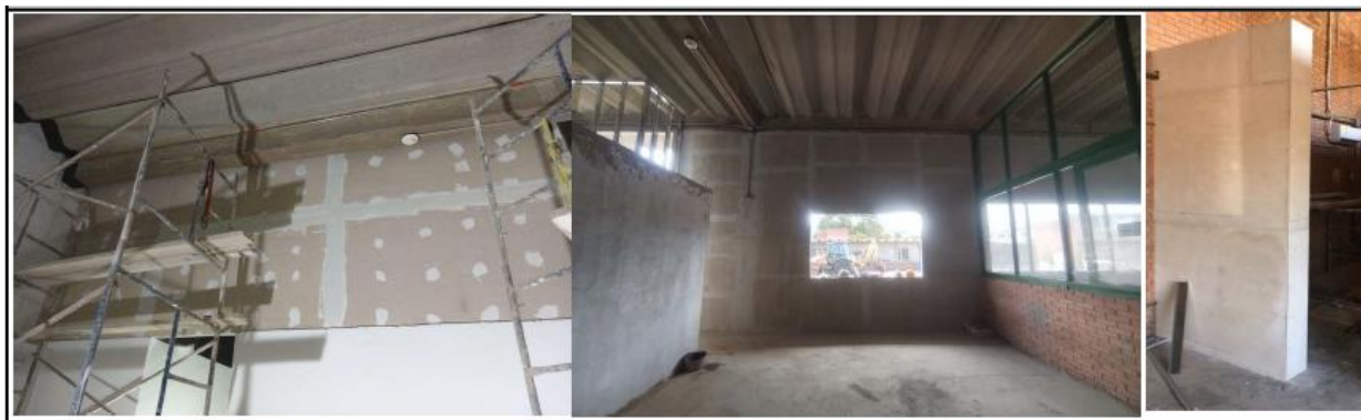
NP14-017 Instalación recubrimiento de fachada en superboard 8mm
