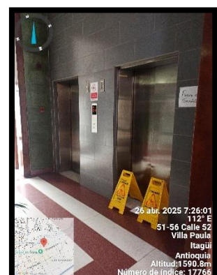
4. Ascensor fuera de servicio
