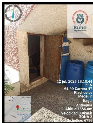
1.1. Zona de basuras parte interna 2
