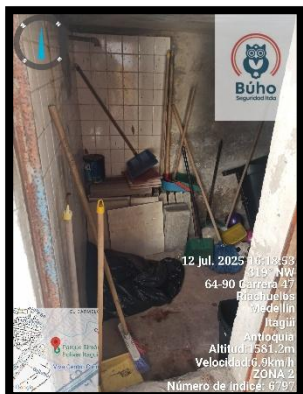
1.1. Zona de basuras, parte interna 1
