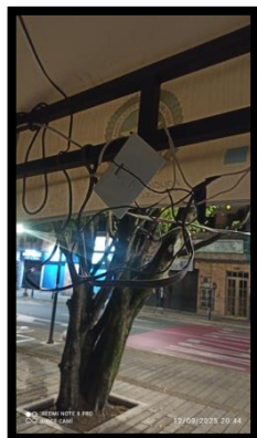
1.1. Carpa externa CAMI cables
