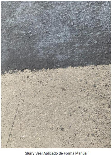
Slurry Seal Aplicado de Forma Manual
