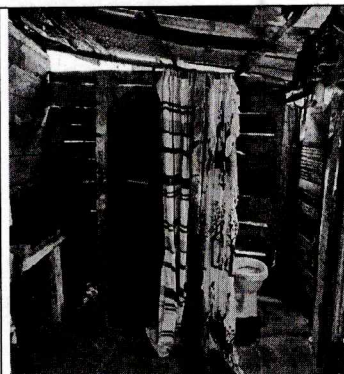
FOTO 4: Visita a viviendas beneficiadas – Diagnostico técnico.
