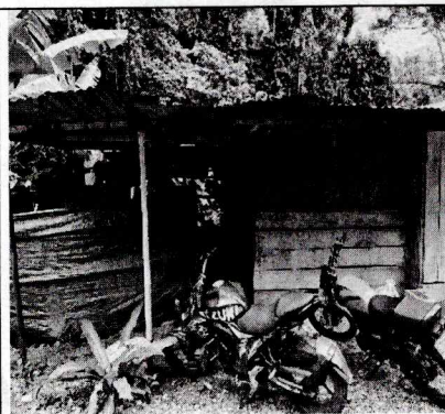
FOTO 6: Visita a viviendas beneficiadas – Diagnostico técnico.
