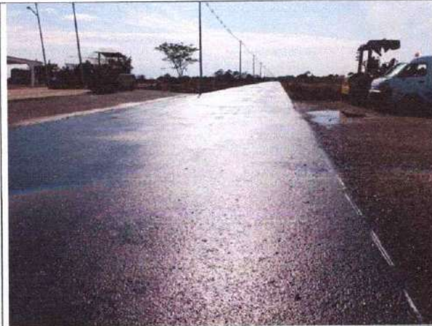
fotografía 1. Durante esta actividad se efectuó el control de la instalación de las capas de las mezclas asfálticas MDC-2 o 19 y la MCD-3 o 10
