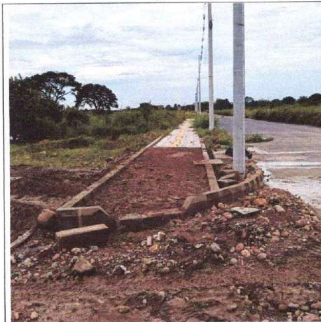
Fotografía 3. Se ejecutaron verificaciones de nivel y pendiente con equipo topográfico de la instalación de los sardineles para las rampas.
