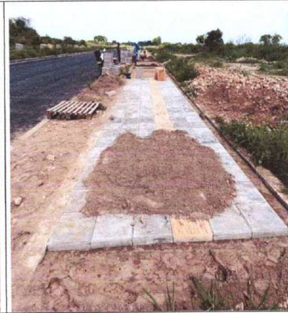
fotografía 4. Se realizó verificación topográfica de precisión para confirmar el cumplimiento de las cotas de nivel y pendientes transversales. En el proceso de instalación de las losetas.
