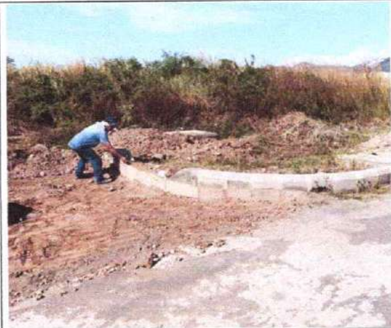
fotografía 2. Se ejecutaron verificaciones de nivel y pendiente con equipo topográfico de la instalación de los sardineles para las rampas.
