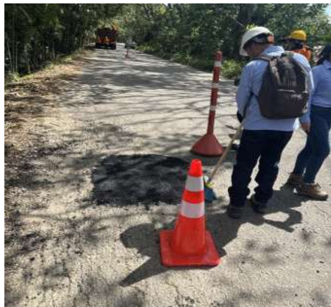
Ítem 1.2 MEZCLA DENSA EN CALIENTE PARA PARCHEO - MDC-19 (MANUAL)
