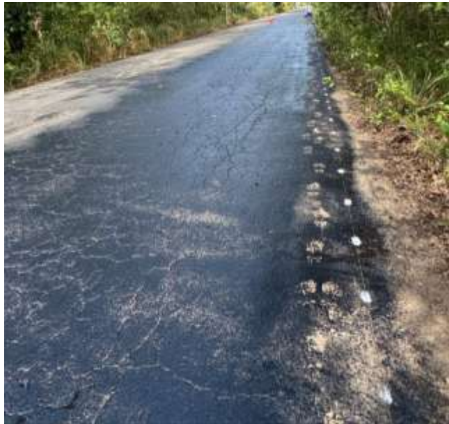
ITEM 1.1 RIEGO CON EMULSION ASFALTICA
