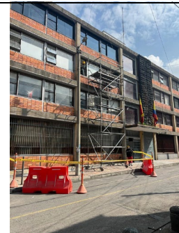
3.Imagen: Cambio de ventanería.
