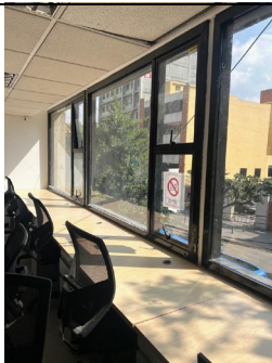
2.Imagen: Cambio de ventanería
