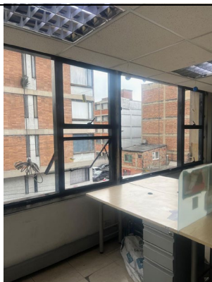
7.Imagen: Cambio de ventanería
