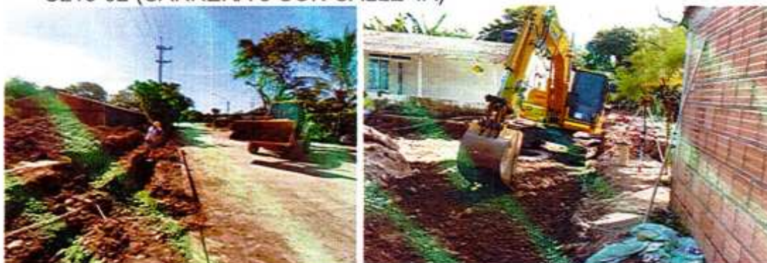
IMAGEN 12. CARGUE Y RETIRO MECÁNICO DE MATERIAL, CON ACARREO A 6 KMS.
