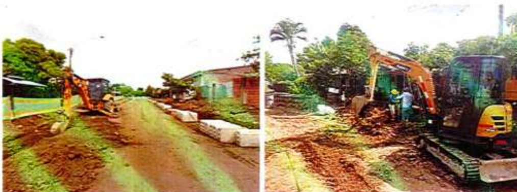
IMAGEN 43. RELLENO EN MATERIAL SELECCIONADO DE LA EXCAVACIÓN COMPACTADO.
