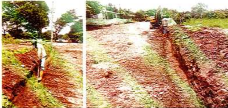
IMAGEN 115. EXCAVACIÓN A MANO EN MATERIAL COMÚN.
