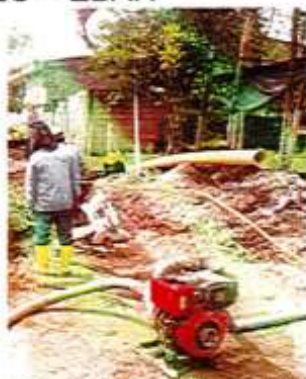
IMAGEN 70. MANEJO, CONTROL Y EXTRACCIÓN DE AGUA.
