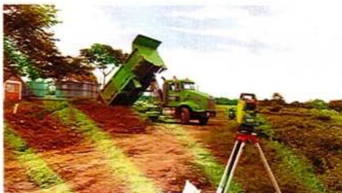
IMAGEN 24. CARGUE Y RETIRO MECÁNICO DE MATERIAL, CON ACARREO A 6 KMS.
