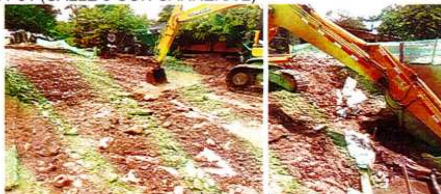
IMAGEN 32. MANEJO, CONTROL Y EXTRACCIÓN DE AGUA.
