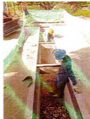
Fotografías 6.15. Señalización implementada en la obra.
