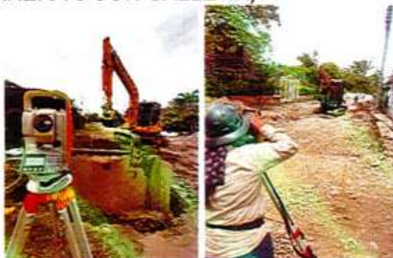
IMAGEN 6. REPLANTEO Y LOCALIZACIÓN DE TUBERÍAS DE ALCANTARILLADO.
