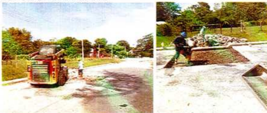
IMAGEN 20. DEMOLICIÓN DE PAVIMENTO EN CONCRETO RÍGIDO (INC.RETIRO) E.P=0.15 M.
