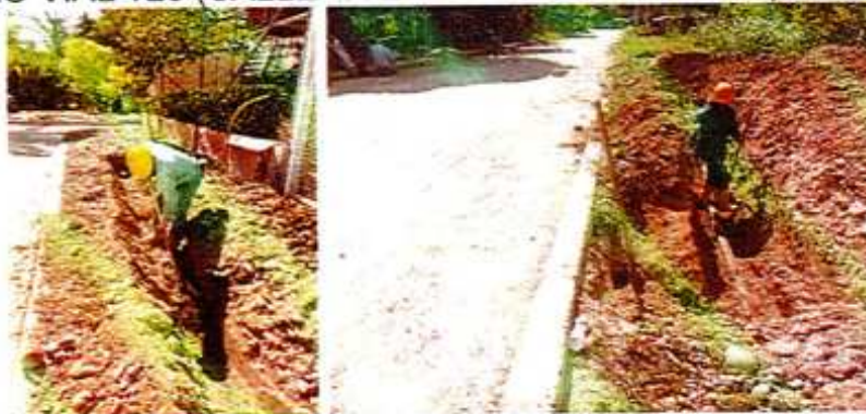
IMAGEN 95. EXCAVACIÓN MANUAL EN MATERIAL COMÚN DE 1 - 2 M. (ZANJAS ANGOSTAS).
