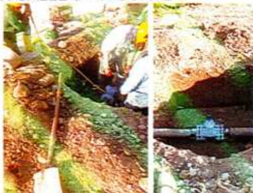
IMAGEN 108. PORTAFLANCHE DE POLIETILENO PE 100 - RDE 11 PN 16 110 MM Ø=4".
