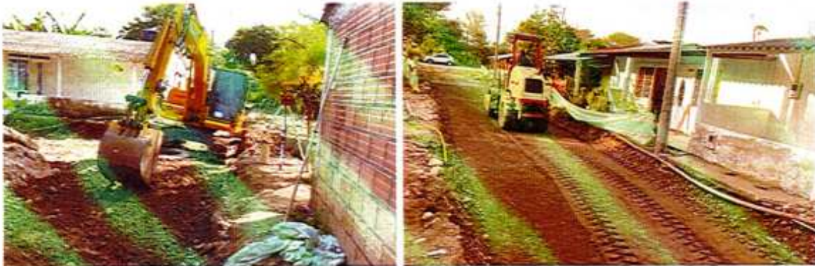
IMAGEN 114. MEJORAMIENTO DE LA SUBRASANTE CON MATERIAL CRUDO DE RÍO CLASIFICADO TMAX 3".
