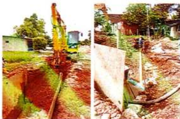
IMAGEN 45. ENTIBADO TIPO 3: APUNTALAMIENTO METÁLICO TIPO TABLESTACADO.
