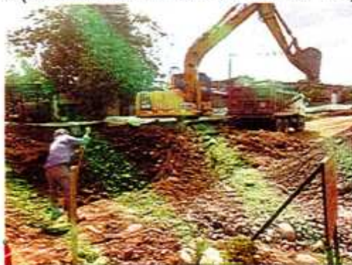
IMAGEN 125. CARGUE MANUAL Y RETIRO DE MATERIAL HASTA 6 KM.
