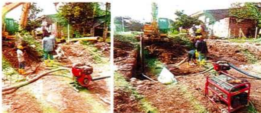
IMAGEN 25. MANEJO, CONTROL Y EXTRACCIÓN DE AGUA.
