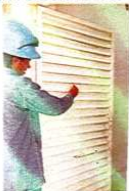
IMAGEN 86. ESMALTE SOBRE VENTANAS EN LAMINA (INCLUYE ANTICORROSIVO).
