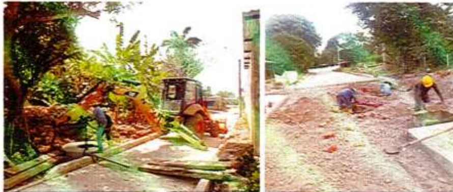
IMAGEN 51. RELLENO EN MATERIAL SELECCIONADO DE LA EXCAVACIÓN COMPACTADO.
