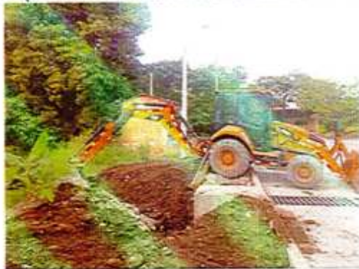
IMAGEN 93. RELLENO EN MATERIAL SELECCIONADO DE LA EXCAVACIÓN COMPACTADO.
