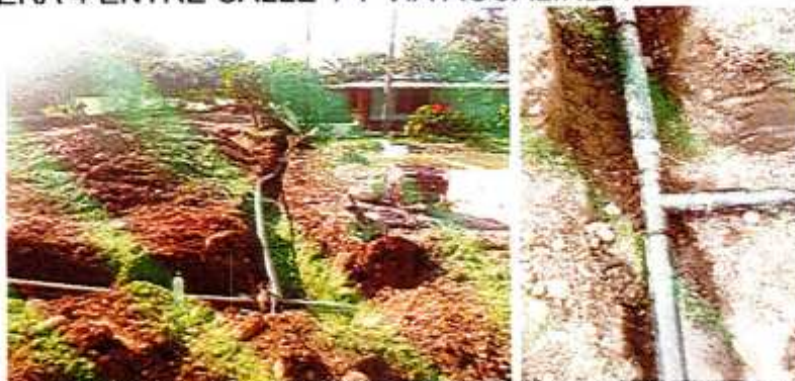
IMAGEN 99. TEE DE POLIETILENO PE 100 - RDE 17 PN 10 90 MM Ø=3".
