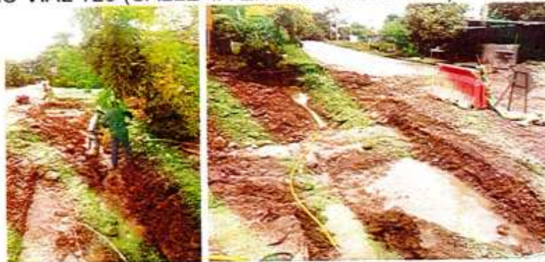
IMAGEN 132. REPARACIÓN TUBERÍA DE GAS POLIETILENO PE-80 DE 1/2".
