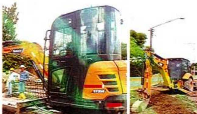
IMAGEN 64. EXCAVACIÓN MECÁNICA EN MATERIAL COMÚN 0 - 6 M (ÁREA RESTRINGIDA).
