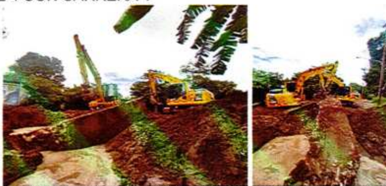
IMAGEN 18. DEMOLICIÓN DE ALCANTARILLA TIPO Y=36".
