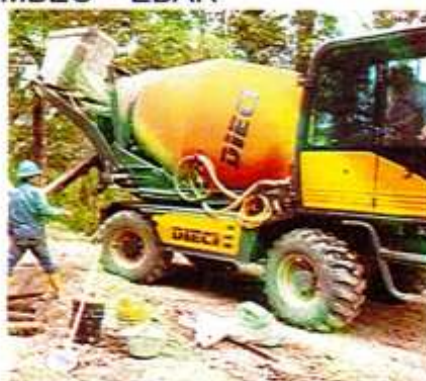
IMAGEN 66. CONCRETO PARA SOLADO RESISTENCIA 175 KG/CM 2 - 2500 PSI.
