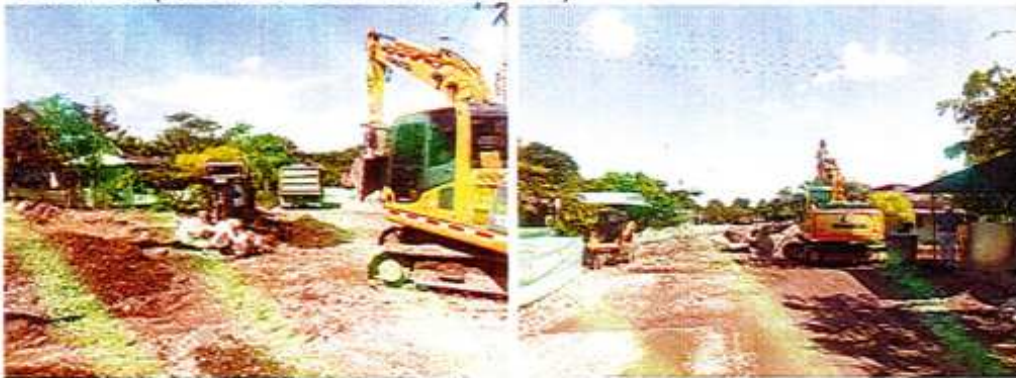
IMAGEN 31. CARGUE Y RETIRO MECÁNICO DE MATERIAL, CON ACARREO A 6 KMS.
