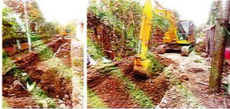
IMAGEN 38. EXCAVACIÓN MECÁNICA EN MATERIAL COMÚN 0 - 6 M (ÁREA RESTRINGIDA).
