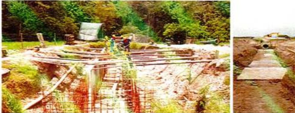
IMAGEN 34. CONCRETO 4000 PSI, IMPERMEABILIZADO PARA ESTRUCTURAS HIDRÁULICAS.
