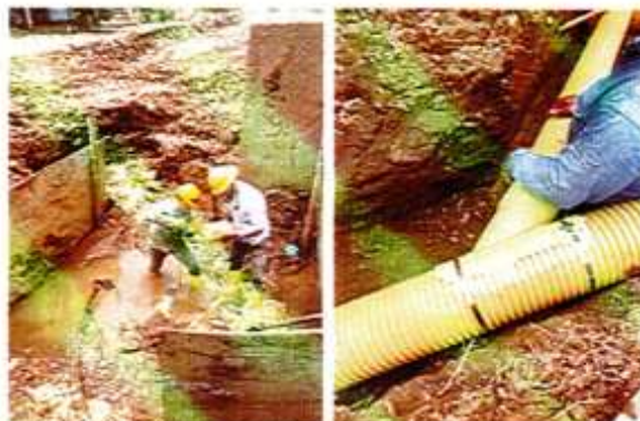
IMAGEN 60. KIT SILLA YEE PVC 8 X 6 (200 X 160 MM), SUMINISTRO E INSTAL.
