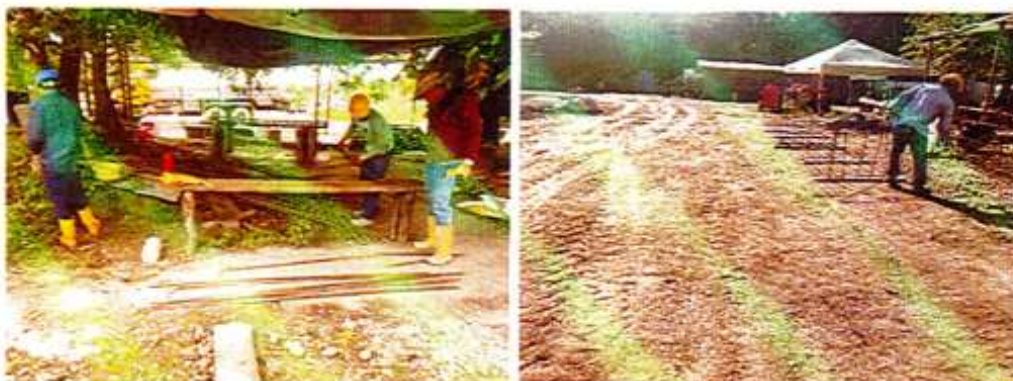
IMAGEN 33. ACERO DE REFUERZO GRADO 60.
