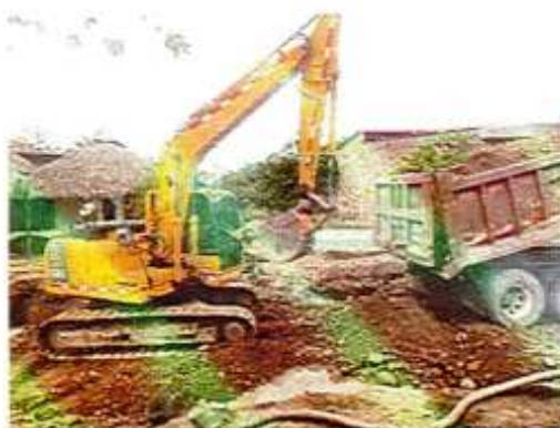
IMAGEN 52. CARGUE Y RETIRO MECÁNICO DE MATERIAL, CON ACARREO A 6 KMS.
