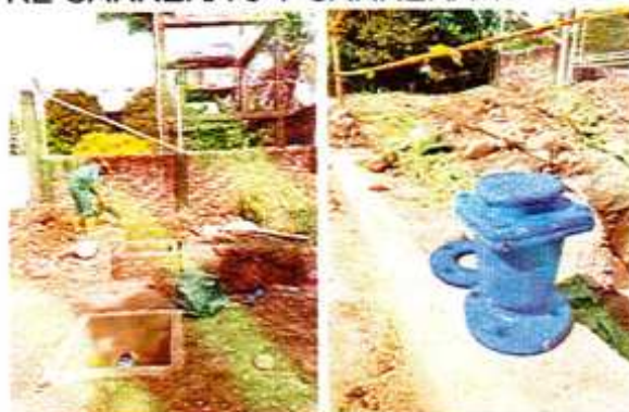
IMAGEN 106. VÁLVULA VENTOSA 2". CÁMARA DOBLE, ACCIÓN MÚLTIPLE.
