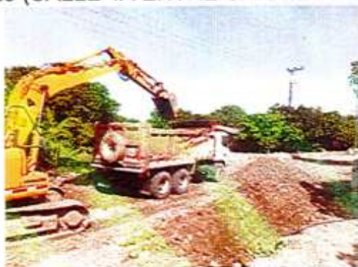
IMAGEN 98. CARGUE Y RETIRO MECÁNICO DE MATERIAL, CON ACARREO A 6 KMS.
