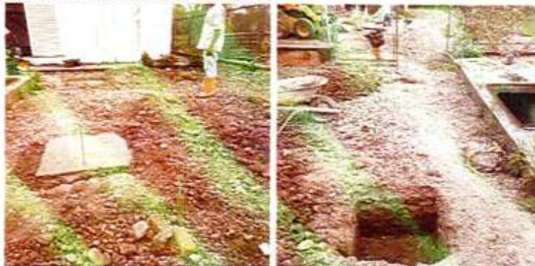
IMAGEN 71. ZAPATA EN CONCRETO PARA CIMENTACIÓN DE RESISTENCIA 3000 PSI.
