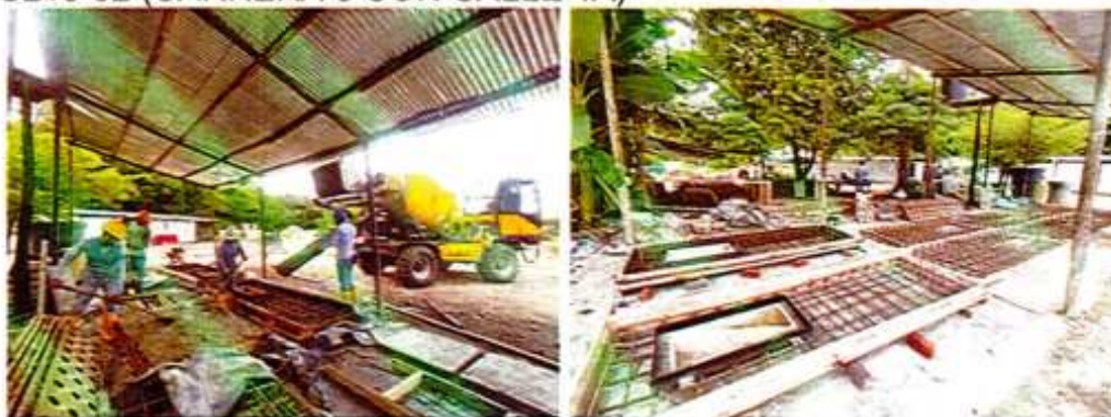
IMAGEN 29. SUMIDERO LATERAL EN CONCRETO REFORZADO 3500 PSI SL-250.
