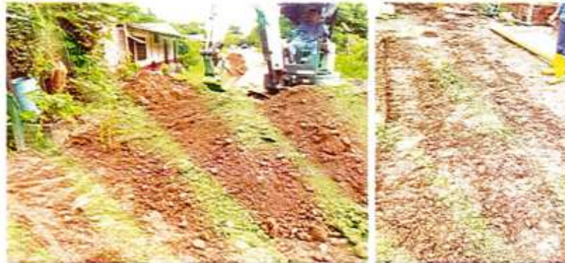
IMAGEN 61. RELLENO EN MATERIAL SELECCIONADO DE LA EXCAVACIÓN COMPACTADO.
