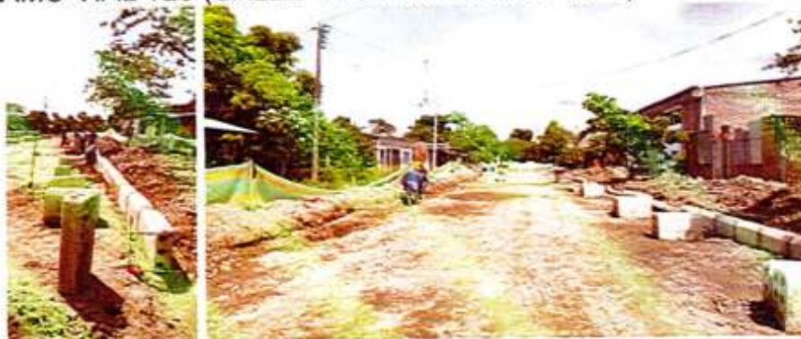
IMAGEN 117. SARDINEL PREFABRICADO (0.80 X 0.20 X 0.40) INCLUYE MORTERO DE PEGUE Y NIVELACIÓN DE 0.03 M.
