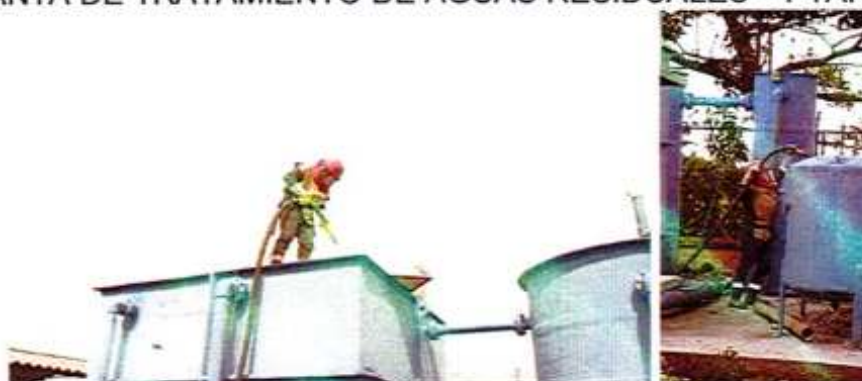
IMAGEN 88. LIMPIEZA CON EQUIPO SANDBLASTING EN ESTRUCTURA METÁLICA MÓDULOS DE TRATAMIENTO DE AGUA RESIDUAL.
