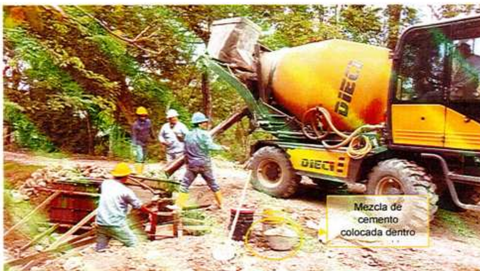
Fotografía 6.19. Mezcla de cemento colocada dentro de un valde para hacer terminados y evitar contacto directo con el recurso suelo, así mismo se evidencia el uso de un mixer.
