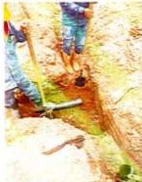
IMAGEN 102. TAPÓN DE POLIETILENO PE 100 - RDE 17 PN 10 90 MM Ø=3". SUMINISTRO E INSTAL.
