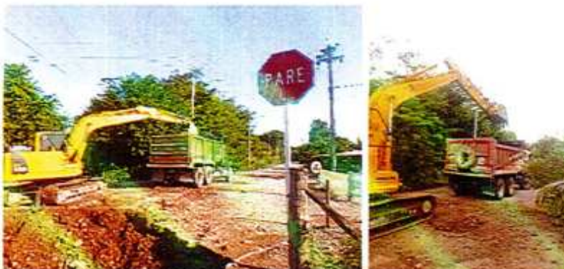
IMAGEN 44. CARGUE Y RETIRO MECÁNICO DE MATERIAL, CON ACARREO A 6 KMS.
