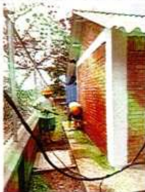
IMAGEN 78. LIMPIEZA Y LAVADO DE MAMPOSTERÍA A LA VISTA CON ÁCIDO NÍTRICO E HIDROSOLVE.
