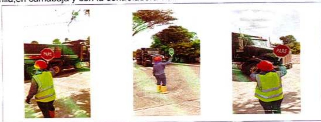
IMAGEN 145. CONTROL DE TRANSITO VEHICULAR.
