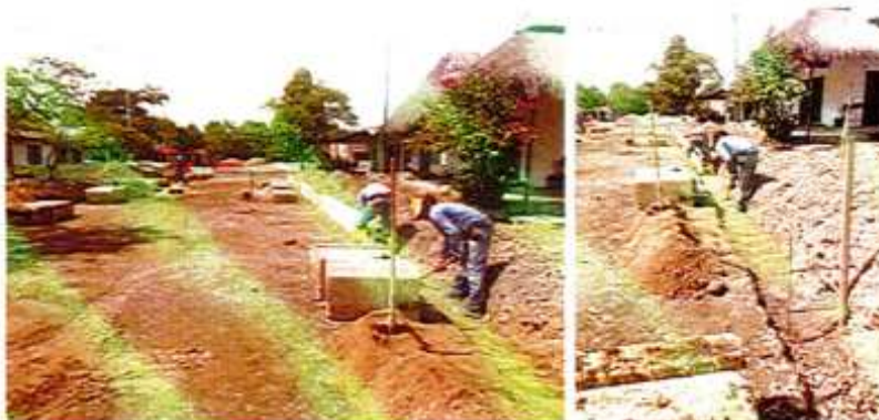
IMAGEN 124. RELLENO EN ARENA LAVADA APISONADA PARA SOLADO CON TRANSPORTE.
