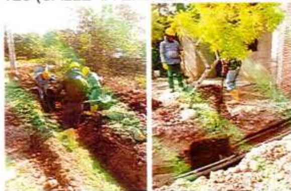
IMAGEN 96. RELLENO EN ARENA LAVADA APISONADA PARA ATRAQUE DE LA TUBERÍA CON TRANSPORTE.
