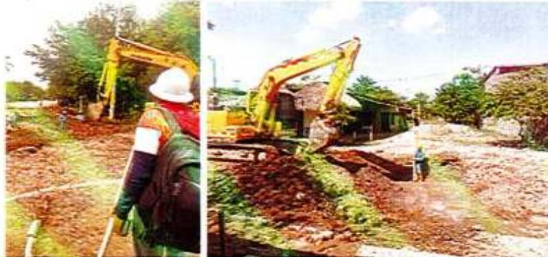
IMAGEN 37. REPLANTEO Y LOCALIZACIÓN DE TUBERÍAS DE ALCANTARILLADO.
