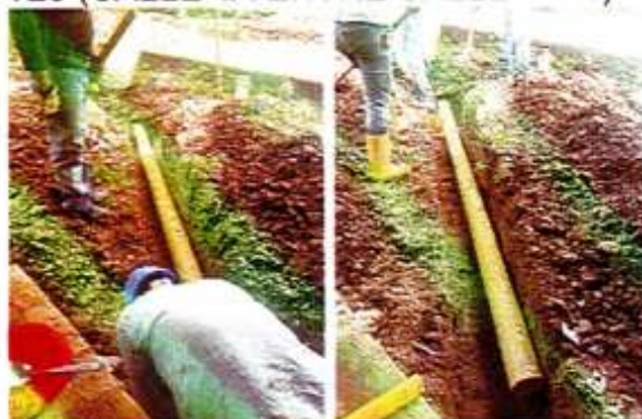
IMAGEN 131. REPARACIÓN DE ACOMETIDA DOMICILIARIA ALCANTARILLADO Ø= 6".
