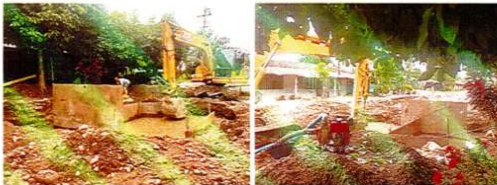
IMAGEN 54. MANEJO, CONTROL Y EXTRACCIÓN DE AGUA.
