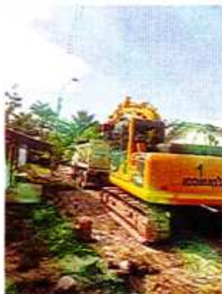
IMAGEN 68. CARGUE Y RETIRO MECÁNICO DE MATERIAL, CON ACARREO A 6 KMS.
