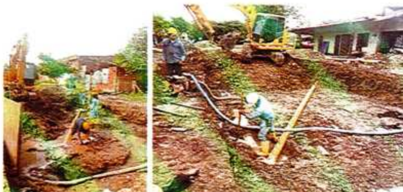
IMAGEN 46. MANEJO, CONTROL Y EXTRACCIÓN DE AGUA.
