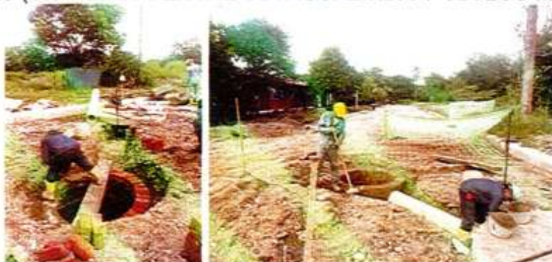
IMAGEN 57. NIVELACIÓN DE POZOS DE INSPECCIÓN (NO INCLUYE: TAPA NI ARO).
