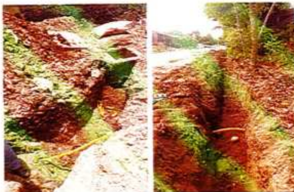
IMAGEN 136. REPARACIÓN TUBERÍA DE GAS POLIETILENO PE-80 RDE 11 DE 2".
