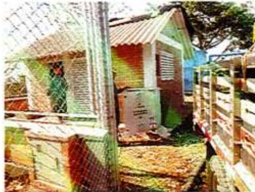
IMAGEN 80. TEJA EN FIBROCEMENTO NO.10. SUMINISTRO E INSTAL.
