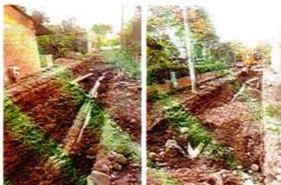
IMAGEN 41. TUBERÍA PVC ALCANTARILLADO 8". SUMINISTRO E INSTAL.
