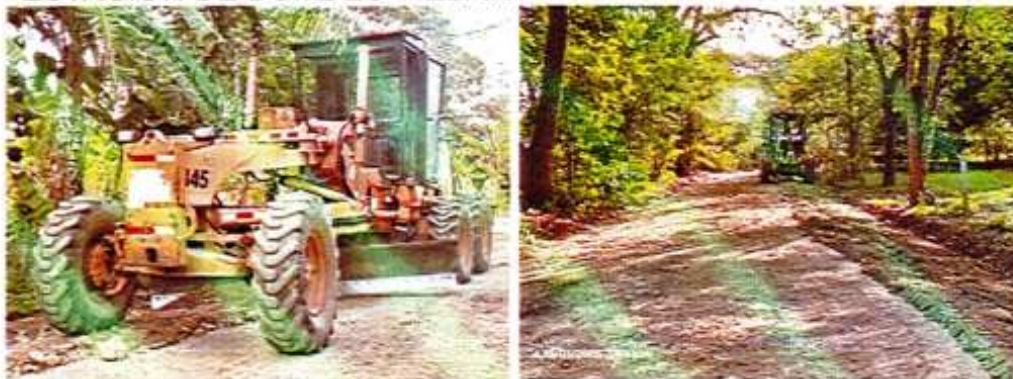
IMAGEN 67. SUB BASE GRANULAR TRITURADA.
