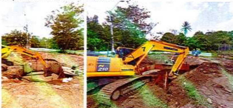
IMAGEN 21. EXCAVACIÓN MECÁNICA EN MATERIAL COMÚN 0 - 6 M (ÁREA RESTRINGIDA).
