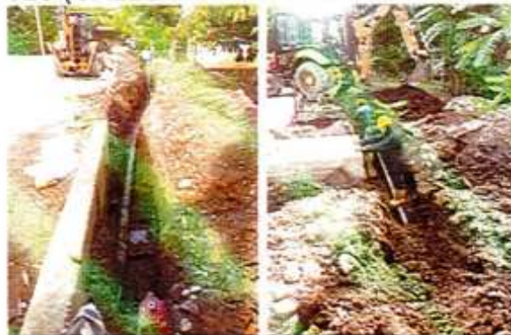
IMAGEN 92. TUBERÍA DE POLIETILENO PE 100 PN-10 DE Ø=90 MM =3".
