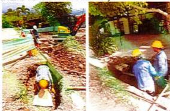
IMAGEN 10. TUBERÍA PVC ALCANTARILLADO 12". SUMINISTRO E INSTAL.
