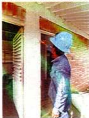
IMAGEN 85. ESMALTE SOBRE MARCOS METÁLICOS DE PUERTAS.
