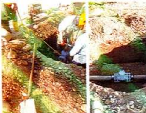
IMAGEN 112. BRIDA LOCA HD Ø=4" PARA POLIETILENO (INCLUYE: EMPAQUETADURA Y ESPÁRRAGOS). SUMINISTRO E INSTALACIÓN.
