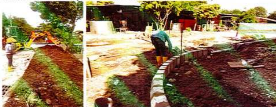
IMAGEN 126. RELLENO EN MATERIAL SELECCIONADO DE LA EXCAVACIÓN COMPACTADO.
