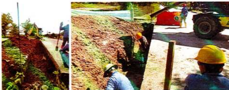
IMAGEN 28. EXCAVACIÓN A MANO EN MATERIAL COMÚN.
