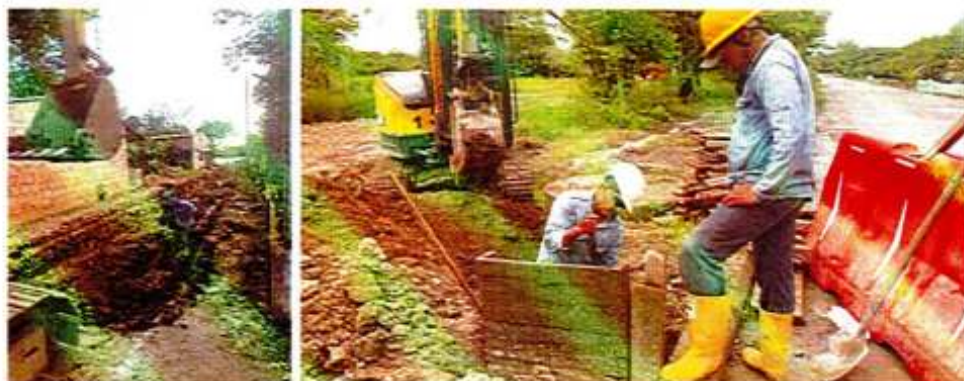
IMAGEN 39. EXCAVACIÓN A MANO EN MATERIAL COMÚN.
