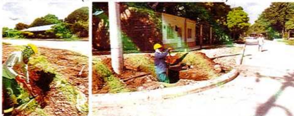
IMAGEN 127. EXCAVACIÓN A MANO EN MATERIAL COMÚN.
