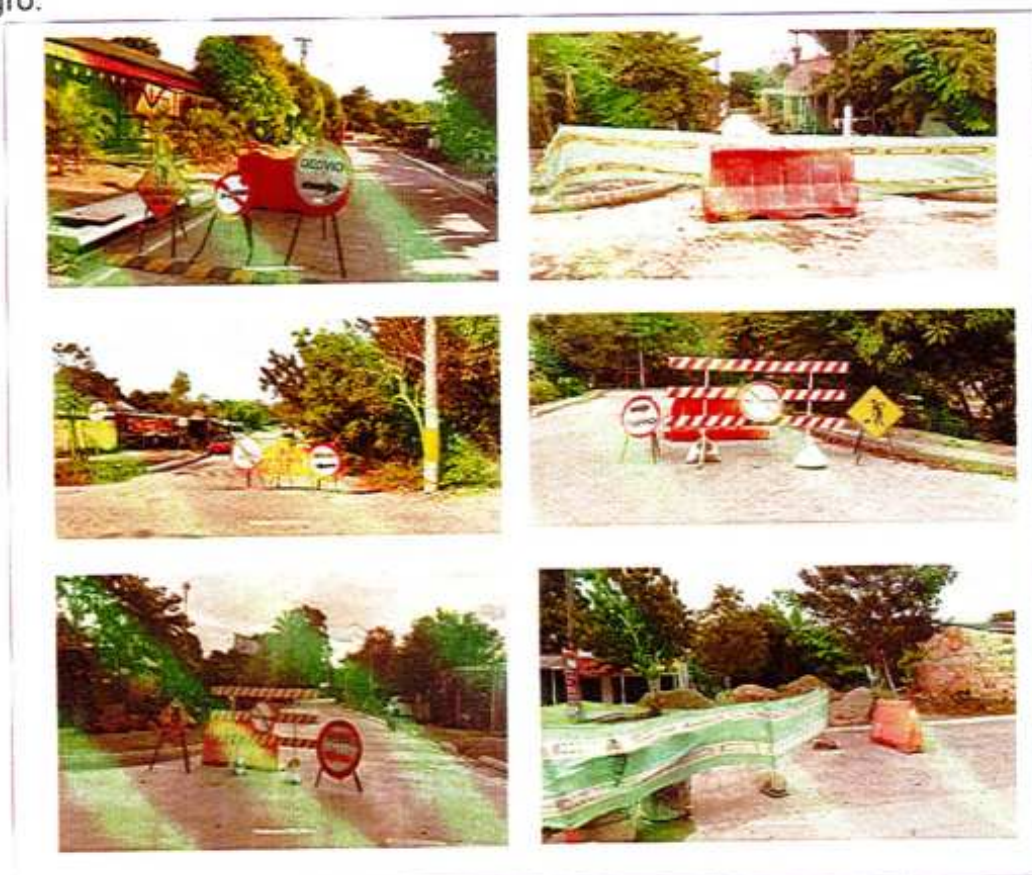
IMAGEN 146. REGISTRO DE SEÑALIZACIÓN VÍAS INTERVENIDAS.
