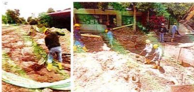
IMAGEN 59. RELLENO EN ARENA LAVADA APISONADA PARA ATRAQUE DE LA TUBERÍA CON TRANSPORTE.
