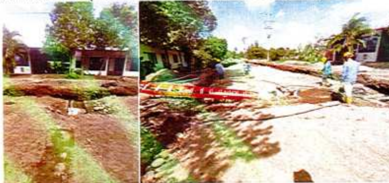
IMAGEN 134. CANALIZACIÓN DUCTO CONDUIT PVC 1", ZONA BLANDA. INCLUYE CINTA DE PREVENCIÓN Y ARENA LAVADA DE RÍO.
