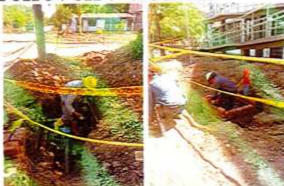
IMAGEN 105. CAJA DE INSPECCIÓN 80 X 80 CON TAPA VÁLVULA. SUMINISTRO E INSTALACIÓN.
