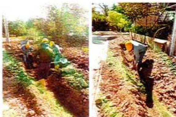
IMAGEN 8. EXCAVACIÓN A MANO EN MATERIAL COMÚN.
