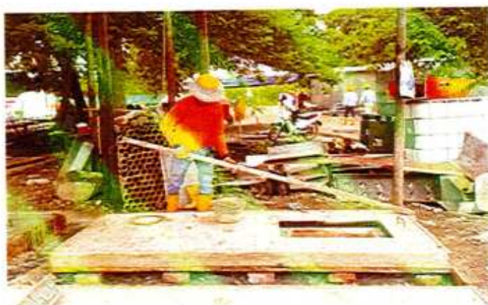
Fotografía 6.10. Área donde se elaboran tapas para sumideros del proyecto.
