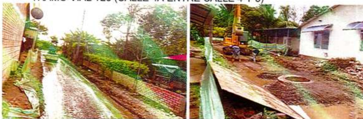
IMAGEN 118. SUB BASE GRANULAR TRITURADA.
