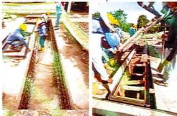
IMAGEN 30. SUMIDERO TRANSVERSAL EN CONCRETO REFORZADO 3000 PSI CON REJILLA DE AU= 0.70, HU =0.80, E= 0.20 M.
