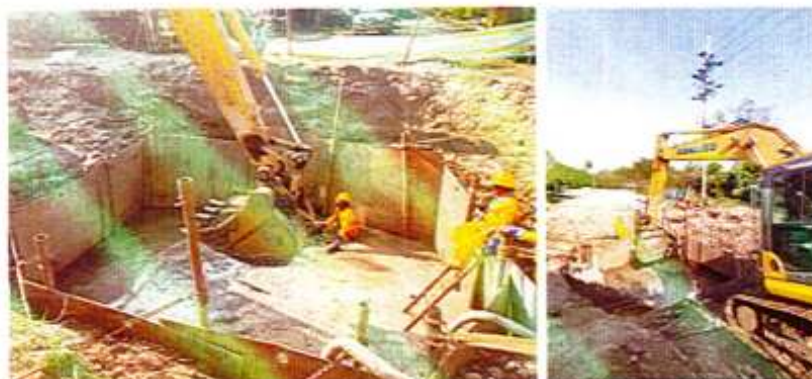
IMAGEN 48. EXCAVACIÓN MECÁNICA EN MATERIAL COMÚN 0 - 6 M (ÁREA RESTRINGIDA).
