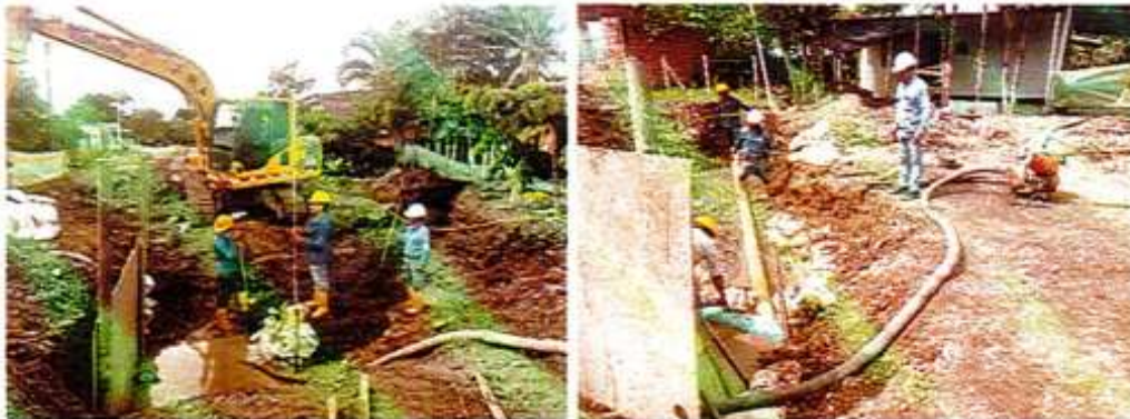
IMAGEN 42. TUBERÍA PVC ALCANTARILLADO 12". SUMINISTRO E INSTAL.
