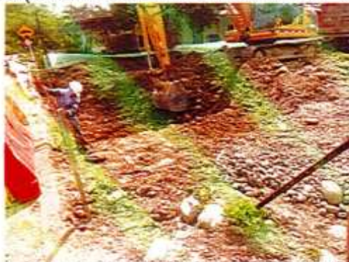
IMAGEN 130. CARGUE MANUAL Y RETIRO DE MATERIAL HASTA 6 KM.
