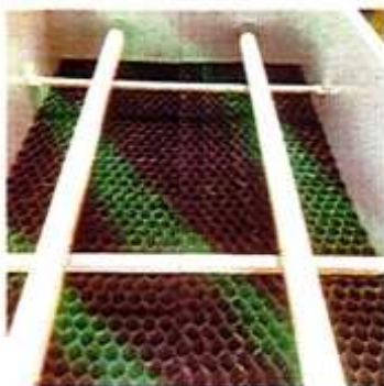
IMAGEN 74. MÓDULO DE SEDIMENTACIÓN ACELERADA TIPO COLMENA, CAPACIDAD 60 M 3 . SUMINISTRO E INSTAL.
