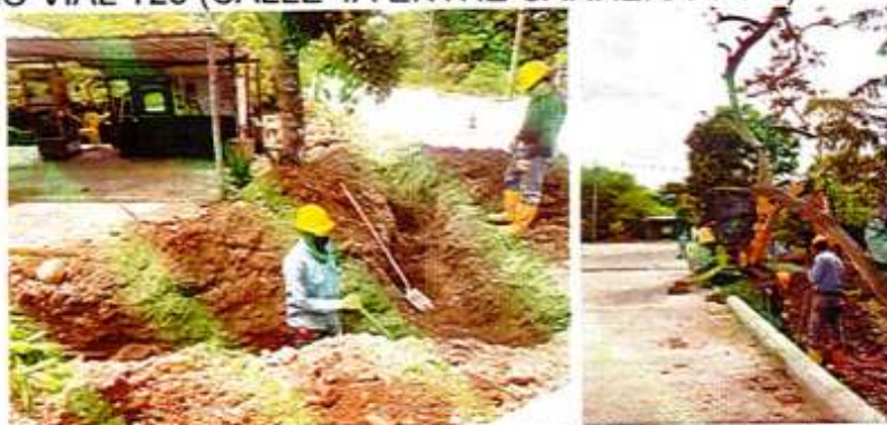
IMAGEN 91. EXCAVACIÓN MANUAL EN MATERIAL COMÚN DE 1 - 2 M. (ZANJAS ANGOSTAS).
