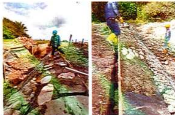
IMAGEN 36. PIEDRA PEGADA CONCRETO DE 2500 PSI, E=0.15 M.
