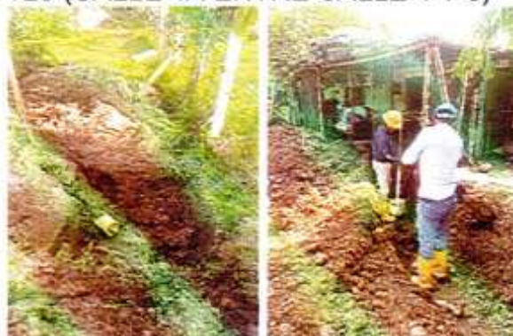
IMAGEN 128. ENCAMADO TUBERÍA CON ARENA APISONADA (ARENA SUCIA DE RÍO).
