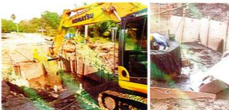
IMAGEN 14. ENTIBADO TIPO 3: APUNTALAMIENTO METÁLICO TIPO TABLESTACADO.
