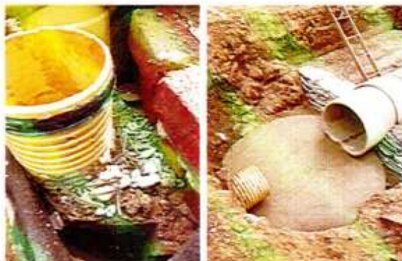
IMAGEN 11. TUBERÍA PVC ALCANTARILLADO 18". SUMINISTRO E INSTAL.
