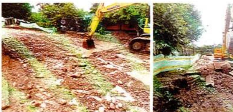
IMAGEN 15. DEMOLICIÓN MECÁNICA DE PAVIMENTO EN CONCRETO ASFALTICO (INC.RETIRO).
