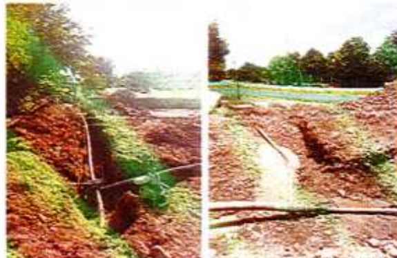
IMAGEN 100. TEE DE POLIETILENO PE 100 - RDE 17 PN 10 110 MM Ø=4".
