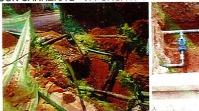
IMAGEN 101. CODO 90° PE 100 - RDE 17 PN 10 90 MM Ø=3".
