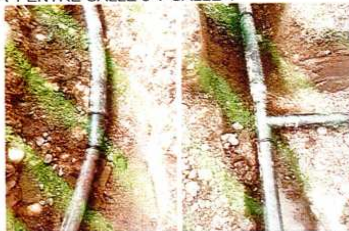
IMAGEN 109. REDUCCIÓN DE POLIETILENO 90 MM X 63 MM PE 100 RDE 17 PN 10.
