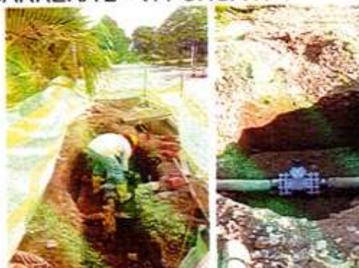
IMAGEN 103. VÁLVULA COMPUERTA ELÁSTICA VÁSTAGO NO ASCENDENTE Ø=3" E.B. SUMINISTRO E INSTAL.
