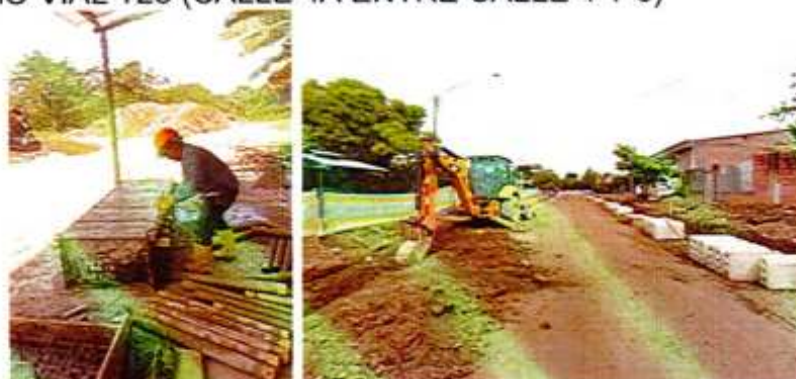
IMAGEN 116. SARDINEL PREFABRICADO A-10 (0.80 X 0.20 X 0.50) INCLUYE MORTERO DE PEGUE Y NIVELACIÓN DE 0.03 M.
