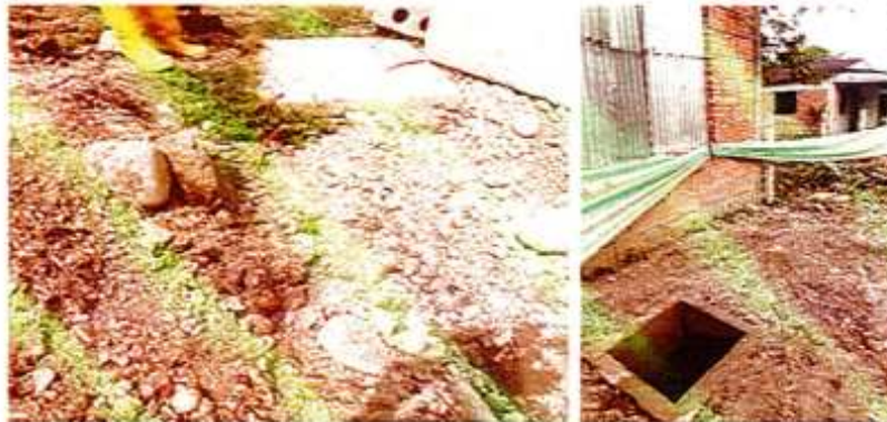
IMAGEN 129. RELLENO EN MATERIAL SELECCIONADO DE LA EXCAVACIÓN COMPACTADO.
