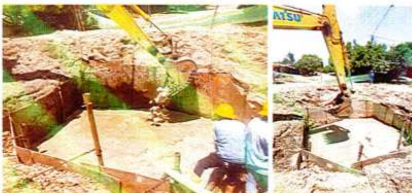
IMAGEN 13. ENTIBADO TIPO 3: APUNTALAMIENTO METÁLICO TIPO TABLESTACADO.
