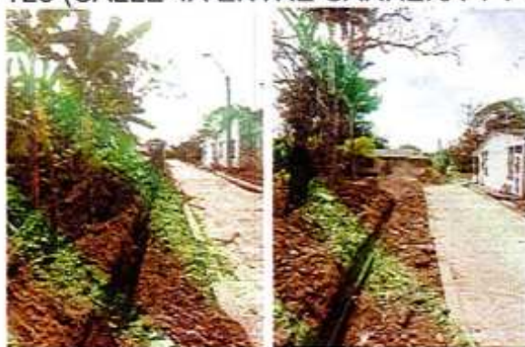
IMAGEN 97. RELLENO EN MATERIAL SELECCIONADO DE LA EXCAVACIÓN COMPACTADO.
