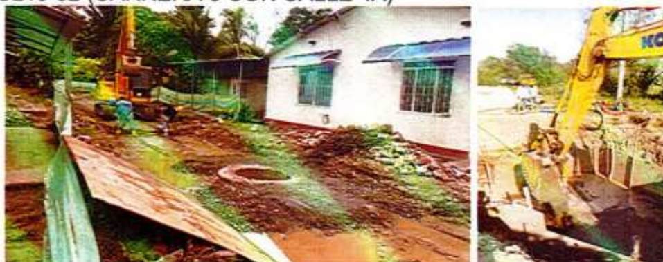
IMAGEN 9. RELLENO ZONA DE ATRAQUE DE TUBERÍA CON MATERIAL BASE GRANULAR TRITURADA (TAMAÑO MÁXIMO 1 1/2").
