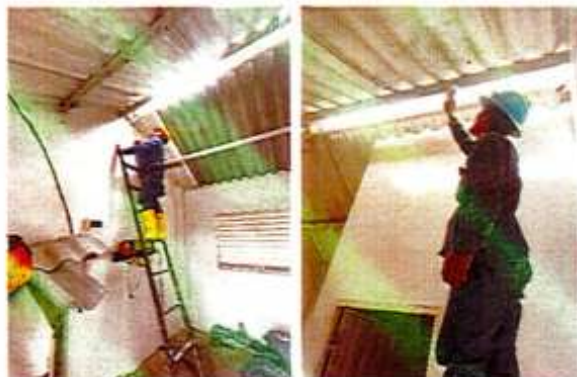
IMAGEN 81. CABALLETE FIJO TEJA DE FIBROCEMENTO.
