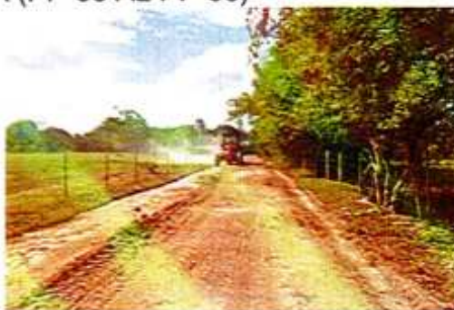
IMAGEN 75. MEJORAMIENTO DE LA SUBRASANTE CON MATERIAL CRUDO DE RÍO CLASIFICADO TMAX 3".
