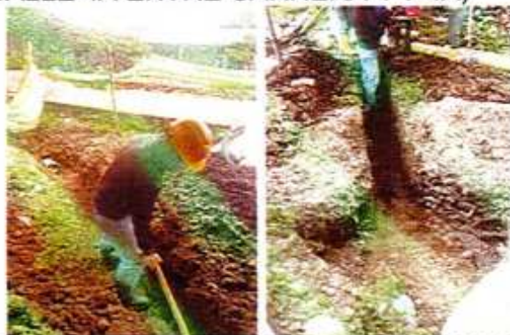
IMAGEN 58. EXCAVACIÓN A MANO EN MATERIAL COMÚN.
