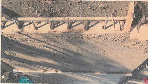
Foto 4. Acero de refuerzo 60.000 PSI para barras de amarre.
