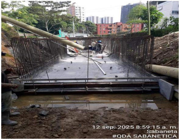
Armado de muros.
