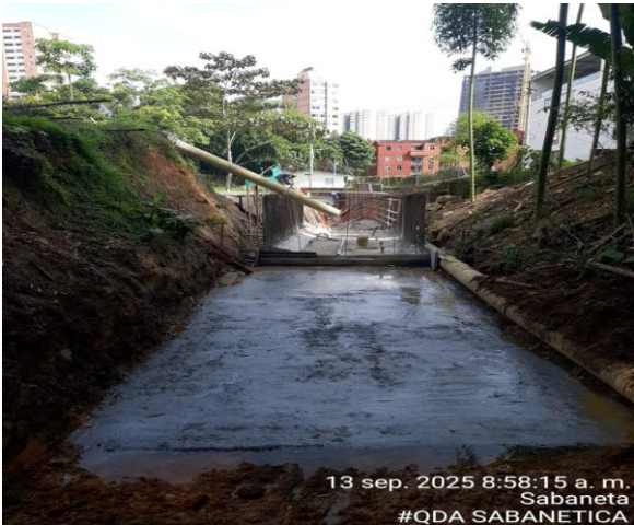
Vaciado de solado.
