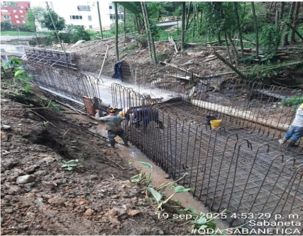
Se continua con el vaciado de muros y losa.
