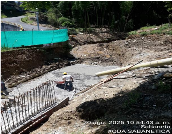
Vaciado de losa.
