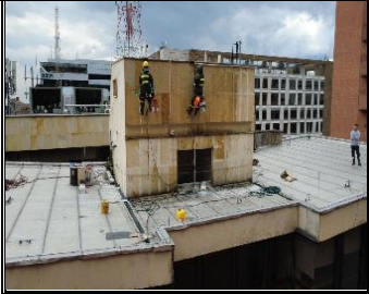
Foto 4: Lavado de fachada en el cuarto de máquinas
