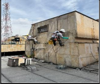
Foto 2: Emboquillado de fachada en el cuarto de máquinas
