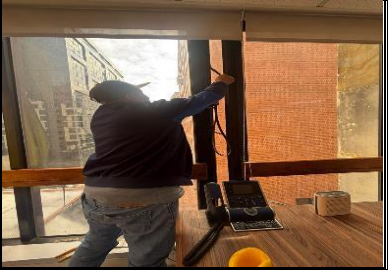
Foto 1: Desinstalación de marco de ventana en piso 4
