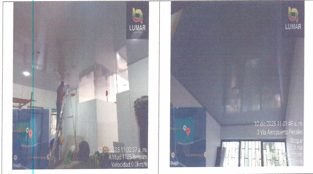
Ilustración 14. Instalación de cielo raso en PVC Fuente: Autor (2025)
