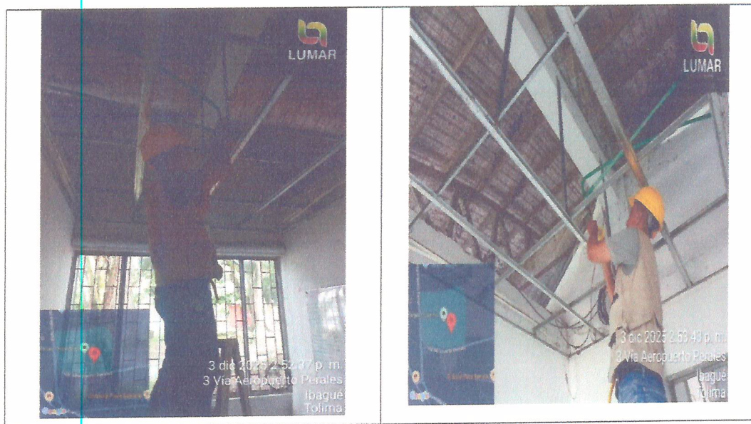
Ilustración 13. Desmonte de luminaria existente Fuente: Autor (2025)
