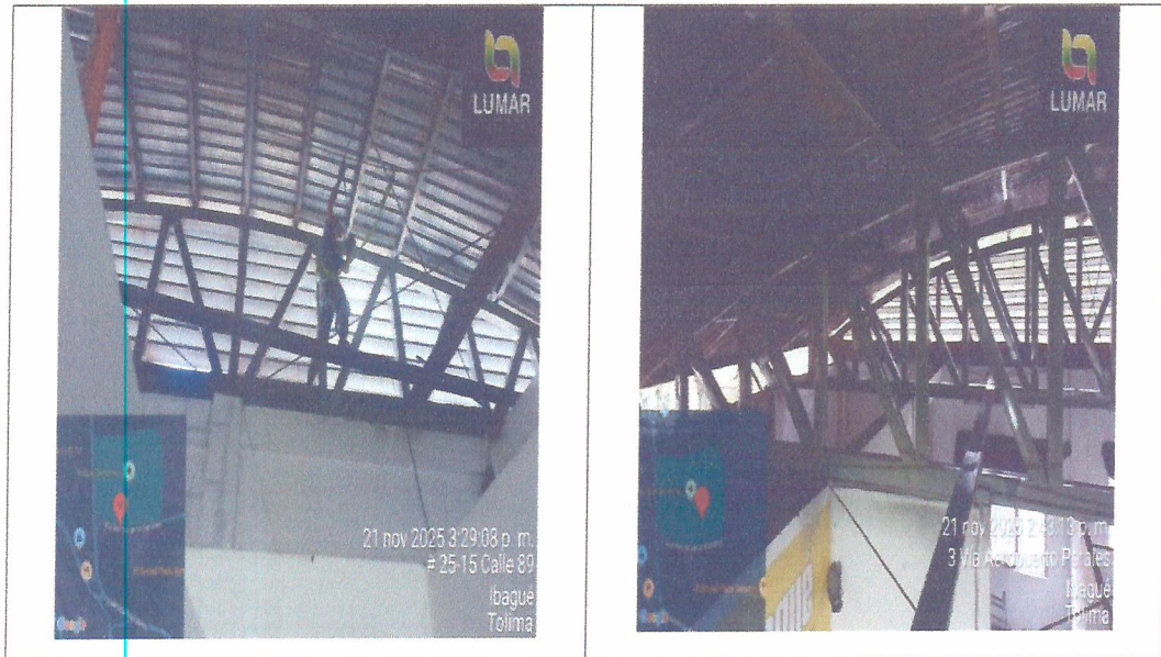
Ilustración 8. Mantenimiento estructuras metálicas. Fuente: Autor (2025)
