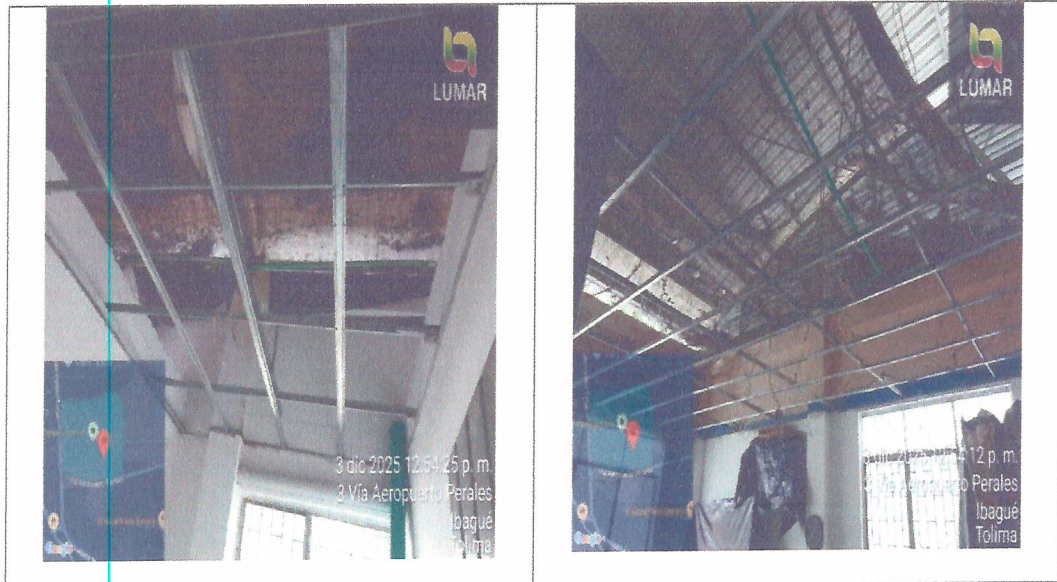
Ilustración 12. Desmonte cielo raso en drywall Fuente: Autor (2025)
