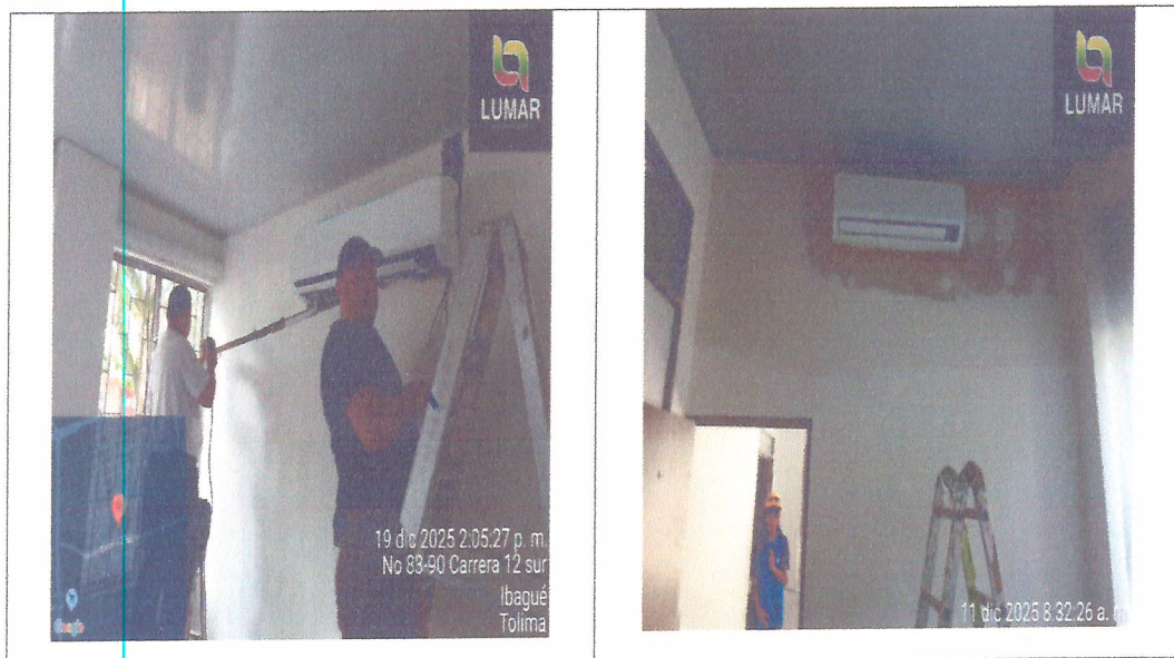
Ilustración 16. Instalación de equipos de aire acondicionado Fuente: Autor (2025)
