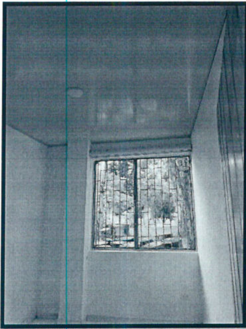
Ilustración 7. evidencia fotográfica de los acabados
