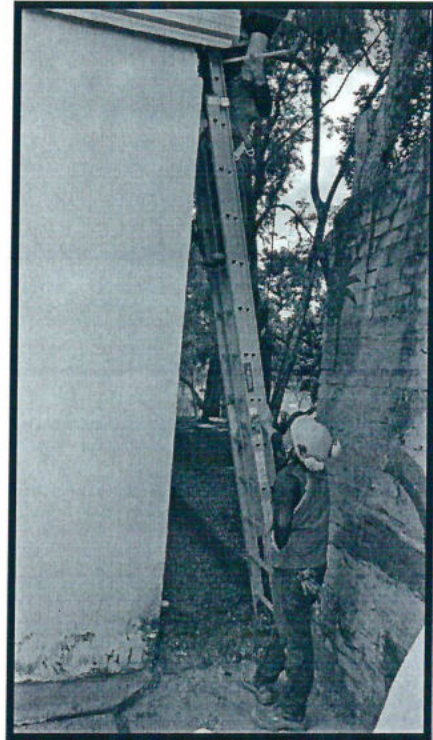
Ilustración 20. evidencia fotográfica de acompañamiento por área administrativa de Lumar y seguridad y salud en el trabajo
