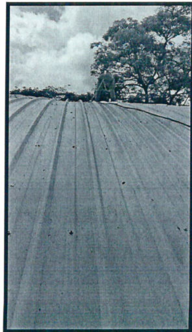
Ilustración 14. evidencia fotográfica cambio del tejado
