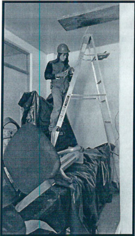
Ilustración 15. evidencia fotográfica parte eléctrica
