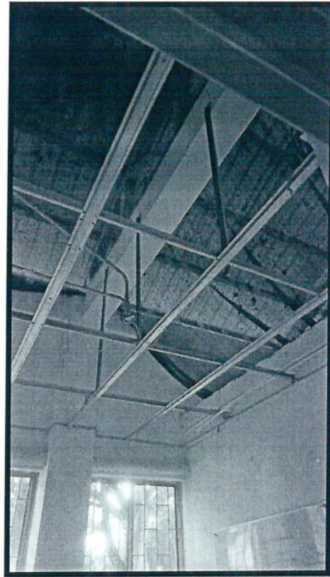
Ilustración 16. evidencia de la instalación de parte eléctrica
