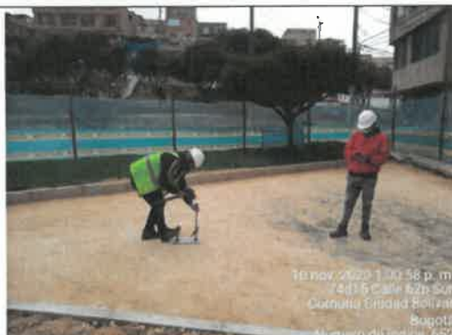
FOTO No. 126. Se revisó y verificó el cumplimiento del distanciamiento de seguridad industrial en la toma de densidades con el densímetro nuclear realizada, parque URBANIZACIÓN LA ESTANCIA 19-038
