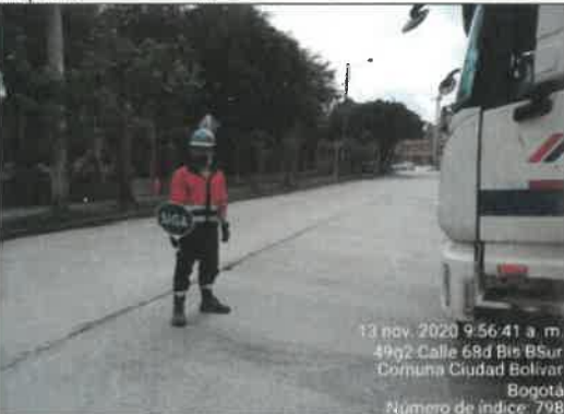
FOTO No. 148. Se revisó y verifico la implementación del control de tráfico. parque URBANIZACIÓN CANDELARIA LA NUEVA II SECTOR 1º ETAPA (19-479)
