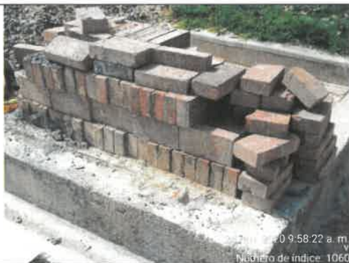
FOTO No. 86 Se revisó y verificó el acopio temporal de material prefabricado, en el punto de acopio temporal, parque URBANIZACIÓN LA ESTANCIA (19-038)
