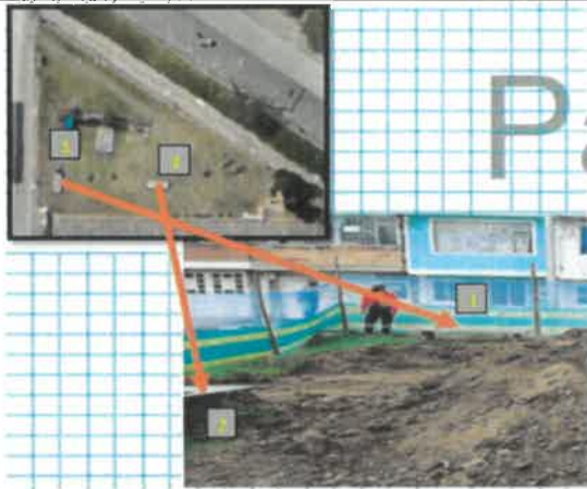
FOTO No 53. La interventoría ARQUITECTURA URBANA LTDA revisa y verifica que el contratista CONSORCIO OPORTO realice el desmonte de dos bancas en mal estado. Estas disposiciones finales deberán ser soportadas mediante los vales de disposición final.
