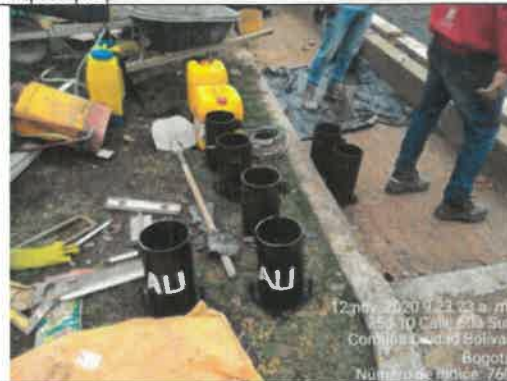
FOTO No. 141. Se revisó y verifico la utilización de las camisas para la toma de muestra de concreto, parque URBANIZACIÓN LA ESTANCIA. 19-039
