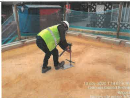
FOTO No. 128. Se revisó y verificó el cumplimiento del distanciamiento de seguridad industrial en la toma de densidades con el densímetro nuclear realizada, parque URBANIZACIÓN LA ESTANCIA 19-039
