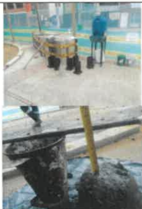
FOTO No 29. La interventoría ARQUITECTURA URBANA LTDA revisa y verifica que el contratista CONSORCIO OPORTO realice la toma de cilindros de concreto 3000 psi y asentamiento (slum) \rho : 6.5". La actividad de NP-8 Refuerzo acero MALLA LOZA MACIZA, corresponde a 50,27 ML
