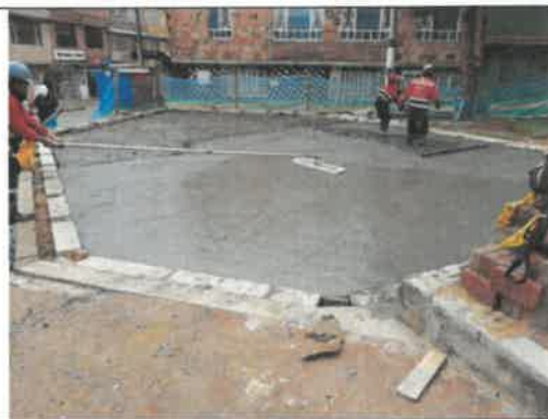
FOTO No. 109. Se revisa y verifica la actividad de fundida de concreto del parque URBANIZACIÓN LA ESTANCIA (19-039)
