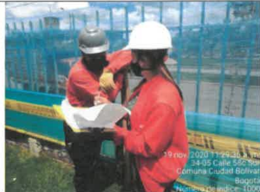
FOTO No. 159. Se revisó y verificó el cumplimiento del protocolo de bioseguridad en el reporte de las condiciones de salud del personal, PARQUE DE BOLSILLO DESARROLLO ARBORIZADORA BAJA19-022
