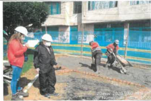
FOTO No. 165. Se revisó y verifico la utilización de, los elementos de protección personal (EPP) parque URBANIZACIÓN LA ESTANCIA. 19-038
