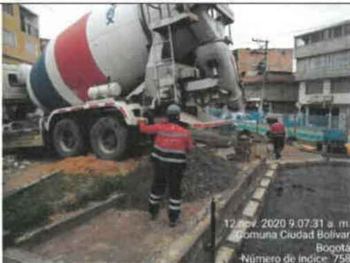
FOTO No. 140. Se revisó y verifico la utilización de la MIXER para el vaciado del concreto en el parque URBANIZACIÓN LA ESTANCIA. 19-039
