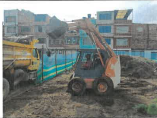
FOTO No. 103. Se revisó y verificó el ingreso del mini cargador, para el retiro de residuos de construcción y demolición.
