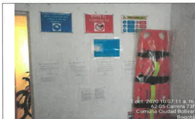
FOTO No. 108. Se revisa y verifica la instalación de los equipos de emergencia en el campamento (camilla, férula cervical, botiquín y extintor)
