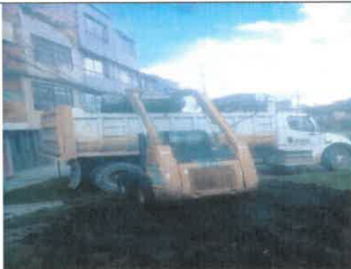
FOTO No. 102. Se revisó y verificó el ingreso de la volqueta para retiro de residuos de construcción y demolición.
