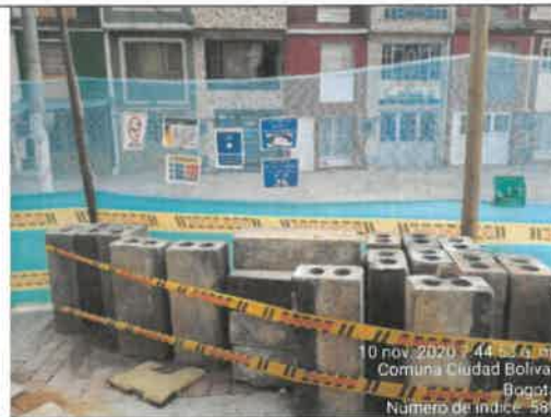
FOTO No. 87. Se revisó y verificó el acopio temporal de material prefabricado parque VECINAL URBANIZACIÓN LA ESTANCIA (19-150)
