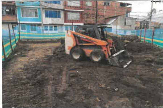
FOTO No. 107 Se realiza verificación de las medidas de Seguridad Tomadas por el contratista CONSORCIO OPORTO en el descapote mecánico del PARQUE DE BOLSILLO DESARROLLO ARBORIZADORA BAJA 19-022
