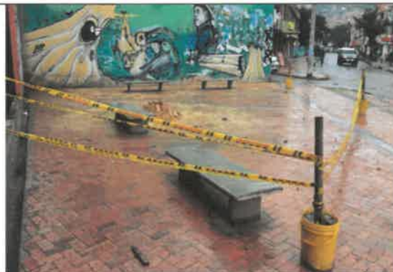
FOTO No. 155. Se revisó y verificó el cumplimiento de cerramiento y la instalación de las bancas M-30 parque URBANIZACIÓN LA ESTANCIA 19-483
