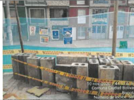
FOTO No. 123. Se revisó y verificó el cumplimiento la señalización del material almacenado, parque URBANIZACIÓN LA ESTANCIA 19-150
