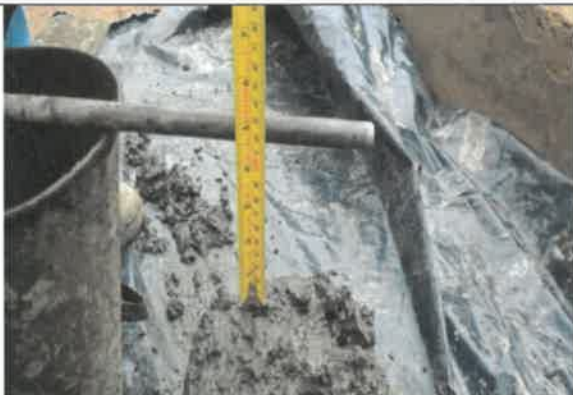
FOTO No 23. La interventoría ARQUITECTURA URBANA LTDA revisa y verifica que el contratista CONSORCIO OPORTO realice la toma de cilindros de concreto 3000 psi y asentamiento (slump) \rho : 5.0".
