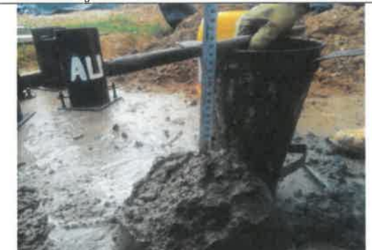
FOTO No 6. La interventoría ARQUITECTURA URBANA LTDA revisa y verifica que el contratista CONSORCIO OPORTO realizó la toma de cilindros de concreto 3000 psi y asentamiento (slump) p: 5.5".
