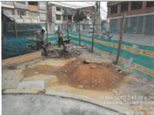
FOTO No. 120. Se revisó y verificó el cumplimiento del retiro de escombros, parque URBANIZACIÓN LA ESTANCIA 19-150
