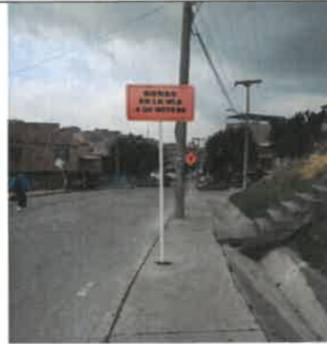
FOTO No. 68. Instalación señalización plan de manejo de tráfico, PARQUE DE BOLSILLO DESARROLLO ARBORIZADORA BAJA 19-022
