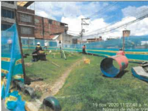
FOTO No. 158. Se revisó y verificó nivelación y ubicación del cerramiento, PARQUE DE BOLSILLO DESARROLLO ARBORIZADORA BAJA19-022
