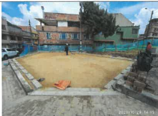
FOTO No 19. La interventoría ARQUITECTURA URBANA LTDA revisa y verifica que la superficie B-600 cumpla con las condiciones óptimas (Limpieza, humedad y/o contaminación).
