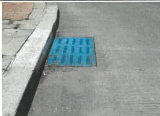
FOTO No. 85. Se revisó y verifico la protección de los sumideros, parque URBANIZACIÓN CANDELARIA LA NUEVA II SECTOR 1ª ETAPA (19-479)
