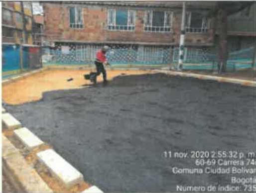
FOTO No 21. La interventoría ARQUITECTURA URBANA LTDA revisa y verifica que el contratista CONSORCIO OPORTO realice la respectiva imprimación con emulsión asfáltica sobre base granular.
