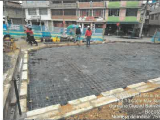
FOTO No 22. La interventoría ARQUITECTURA URBANA LTDA revisa y verifica que la malla electrosoldada cumpla con el recubrimiento horizontal exigido de 5 cm. Y se dejan los dilatadores para aislar la malla electrosoldada del piso. El Refuerzo acero MALLA LOZA MACIZA corresponde a 109.49 ML
