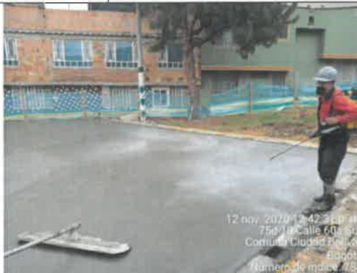
FOTO No 24. La interventoría ARQUITECTURA URBANA LTDA revisa y verifica que el contratista CONSORCIO OPORTO realice el respectivo curado a la losa de concreto, mediante la aplicación de antisol.
