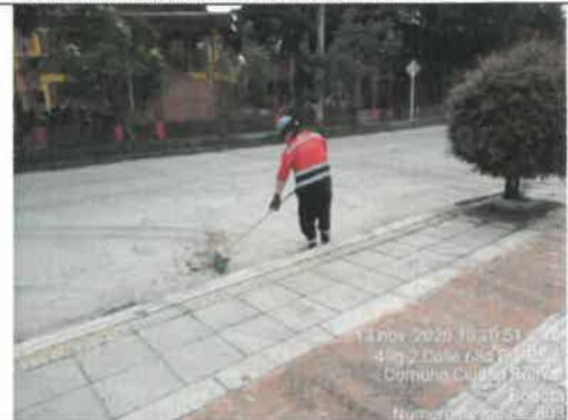
FOTO No. 149. Se revisó y verifico el aseo perimetral de las vías. parque URBANIZACIÓN CANDELARIA LA NUEVA II SECTOR 1º ETAPA (19-479)
