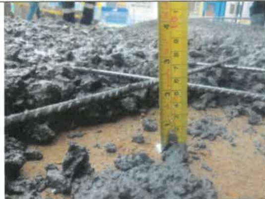
FOTO No 30. La interventoría ARQUITECTURA URBANA LTDA revisa y verifica que la malla electrosoldada cumpla con la separación con respecto a la base, exigido de 5 cm., mediante dilatadores que la aislen del piso en el momento de la fundida. El total de concreto de 3000 psi, la placa corresponde a 50,27 ML.
