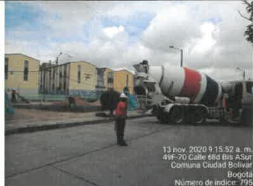
FOTO No. 147. Se revisó y verifico la implementación del control de tráfico. parque URBANIZACIÓN CANDELARIA LA NUEVA II SECTOR 1º ETAPA (19-479)
