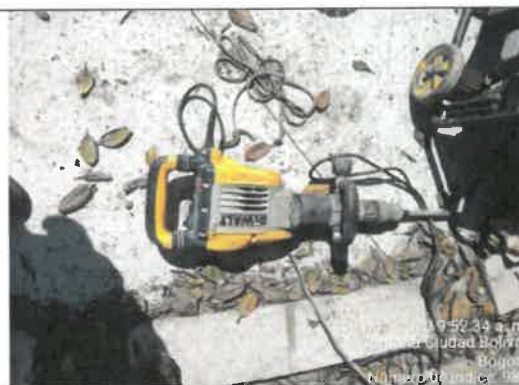
FOTO No 99. Se revisó y verificó el uso del roto martillo en los parques URBANIZACIÓN LA ESTANCIA (19-039), (19-150) y PARQUE URBANIZACIÓN CANDELARIA LA NUEVA II SECTOR 1ª ETAPA (19-479)
