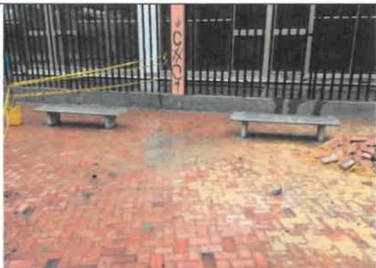
FOTO No. 154. Se revisó y verificó el cumplimiento de los procedimientos técnicos en la instalación de las bancas M- 30, parque URBANIZACIÓN LA ESTANCIA 19-483
