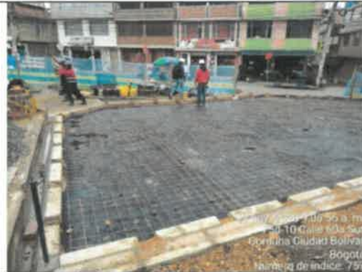
FOTO No. 139. Se revisó y verifico la instalación de la malla electrosoldada, para fundida de placa parque URBANIZACIÓN LA ESTANCIA. 19-039
