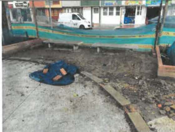
FOTO No 36. La interventoría ARQUITECTURA URBANA LTDA revisa y verifica que el contratista CONSORCIO OPORTO realice la instalación de bancas prefabricadas M - 3I. Con las certificaciones de calidad y de pruebas de laboratorio verificadas por la interventoría se procede a la instalación de las bancas M-3I
