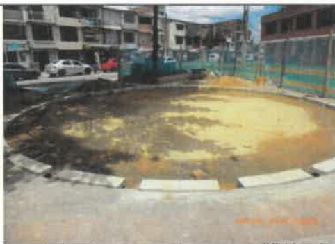
FOTO No 27. La interventoría ARQUITECTURA URBANA LTDA revisa y verifica que la superficie B-600 cumpla con las condiciones óptimas (Limpieza, humedad y/o contaminación).
