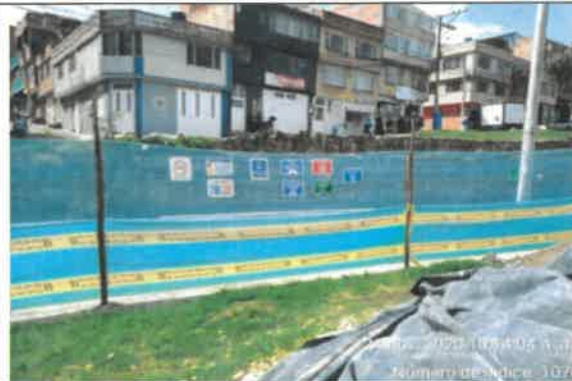
FOTO No. 72. Instalación señalización plan de manejo de tráfico, parque URBANIZACIÓN LA ESTANCIA 19-039
