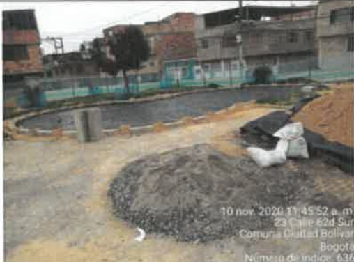
FOTO No. 124. Se revisó y verificó el cumplimiento de la protección de material pétreo, parque URBANIZACIÓN LA ESTANCIA 19-039
