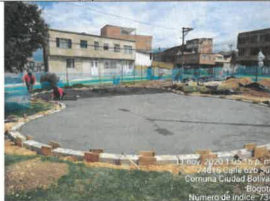
FOTO No 8. La interventoría ARQUITECTURA URBANA LTDA revisa y verifica que el contratista CONSORCIO OPORTO realice el respectivo curado a la losa de concreto, mediante la aplicación de antisol blanco, siguiendo los lineamientos del INSTITUTO DISTRITAL DE RECREACIÓN Y DEPORTE I.D.R.D. Y se procede a la ejecución de la actividad de corte de la placa con 143.05 ML.
