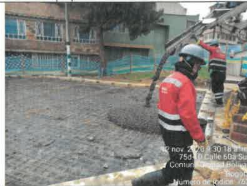
FOTO No. 143. Se revisó y verifico la utilización de los elementos de protección personal (EPP) URBANIZACIÓN LA ESTANCIA. 19-039
