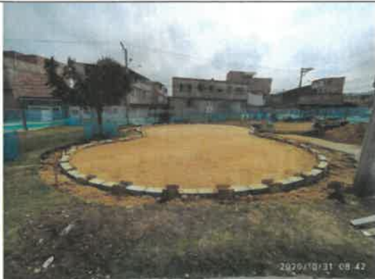
FOTO No 3. La interventoría ARQUITECTURA URBANA LTDA revisa y verifica que la superficie 8-600 cumpla con las condiciones óptimas (limpieza, humedad y/o contaminación).
