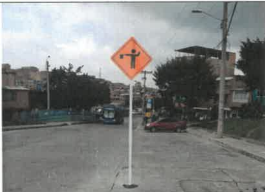
FOTO No. 67. Instalación señalización plan de manejo de tráfico PARQUE DE BOLSILLO DESARROLLO ARBORIZADORA BAJA 19-022
