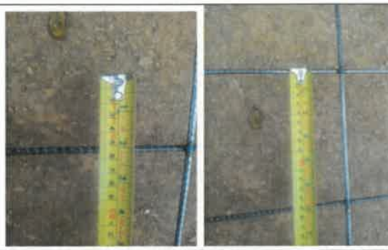
FOTO No 28. La interventoría ARQUITECTURA URBANA LTDA revisa y verifica que la malla electrosoldada cumpla con las especificaciones técnica. Ø: 5 mm y espaciamiento entre alambres 150x150 mm
