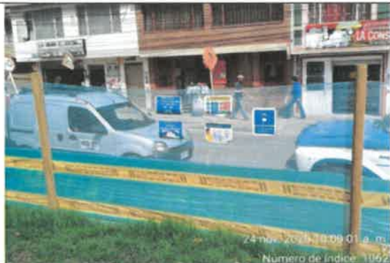
FOTO No. 71. Instalación señalización plan de manejo de tráfico parque URBANIZACIÓN LA ESTANCIA 19-150
