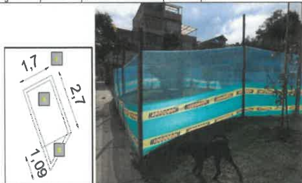
FOTO No 49. La interventoría ARQUITECTURA URBANA LTDA revisa y verifica que el contratista CONSORCIO OPORTO realice la actividad de localización y replanteo del área de juego infantil y acceso. El total corresponde a 58,73 M2 del área de juegos y 5,52 M2 del acceso. TOTAL A FACTURAR: 64,25 M2
