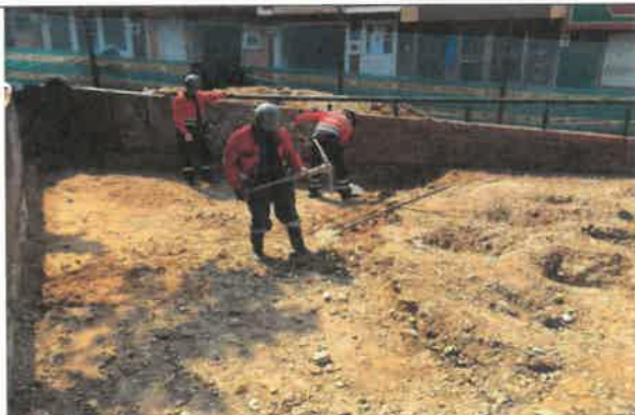
FOTO No. 106 Verificación las medidas de seguridad implementadas por el contratista CONSORCIO OPORTO en retiro manual del césped y la tierra negra en el riesgo biomecánico. PARQUE DE BOLSILLO DESARROLLO ARBORIZADORA BAJA 19-022
