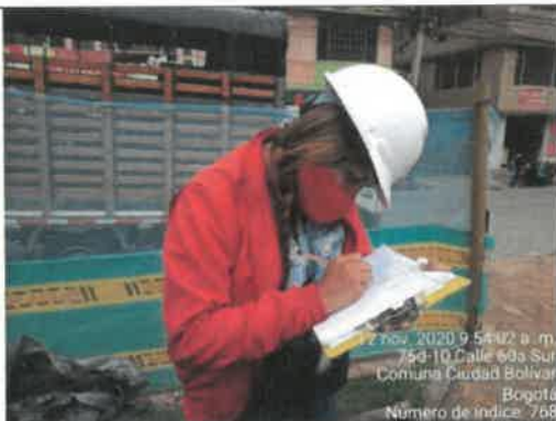
FOTO No. 144. Se revisó y verifíco las condiciones de salud del personal que realiza la fundida de placa., parque URBANIZACIÓN CANDELARIA LA NUEVA II SECTOR 1ª ETAPA (19-479)
