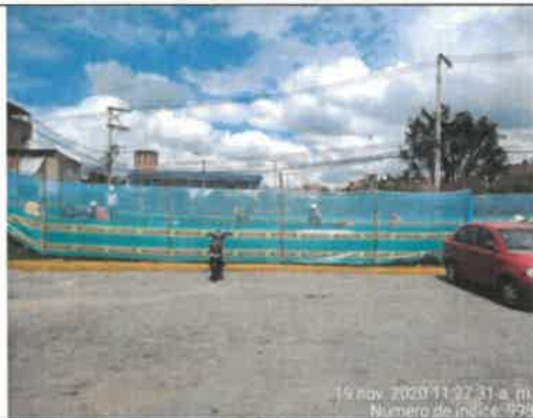
FOTO No. 73. Se revisó y verificó la instalación de señalización, PARQUE DE BOLSILLO DESARROLLO ARBORIZADORA BAJA 19-022
