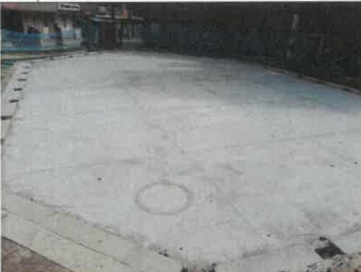
FOTO No 26. La interventoría ARQUITECTURA URBANA LTDA revisa y verifica que el contratista CONSORCIO OPORTO realice el respectivo curado a la losa de concreto. El Corte horizontal en concreto con pulidora profundidad 0.025 corresponde a 87.07 ML
