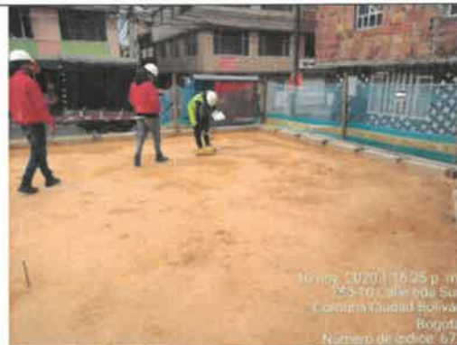
FOTO No. 129. Se revisó y verificó el cumplimiento del distanciamiento de seguridad industrial en la toma de densidades con el densímetro nuclear realizada, parque URBANIZACIÓN LA ESTANCIA 19-039
