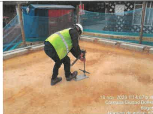
FOTO No 20. La interventoría ARQUITECTURA URBANA LTDA revisa y verifica que el contratista CONSORCIO OPORTO realice las pruebas de densidades en la base B-600 para que cumpla con la compactación óptima. Resultados 1) 106.5%, 2) 105.2%, 3) 105.6% y 4) 104.1%.
