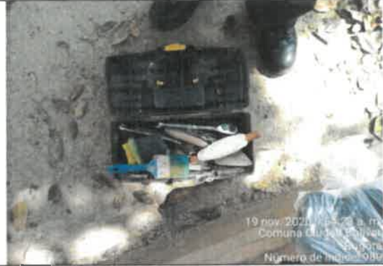
FOTO No. 101 Se revisó y verificó el uso de herramienta de mano, en los parques URBANIZACIÓN LA ESTANCIA (19-039), (19-150) y PARQUE URBANIZACIÓN CANDELARIA LA NUEVA II SECTOR 1ª ETAPA (19-479)
