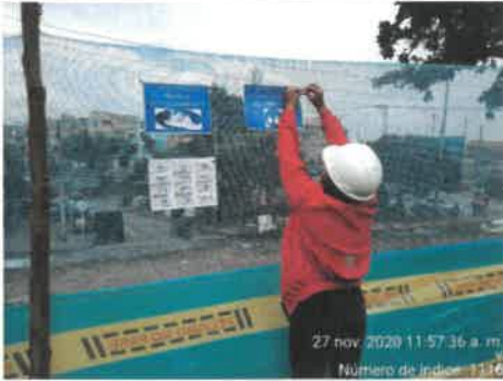
FOTO No. 168. Se revisó y verifico nivelación y ubicación del cerramiento, PARQUE DE BOLSILLO DESARROLLO SIERRA MORENA 19-079
