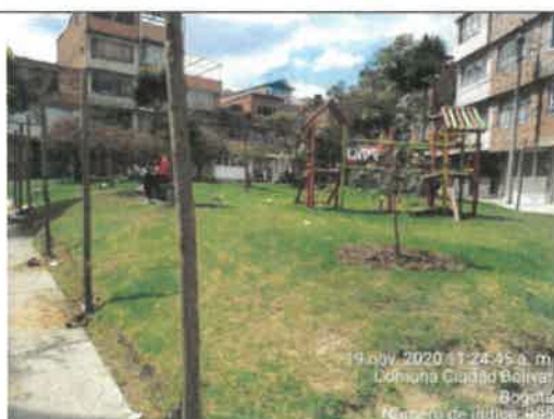
FOTO No. 156. Se revisó y verificó el cumplimiento de la instalación del cerramiento, PARQUE DE BOLSILLO URBANIZACIÓN ARBORIZADORA BAJA 19-255
