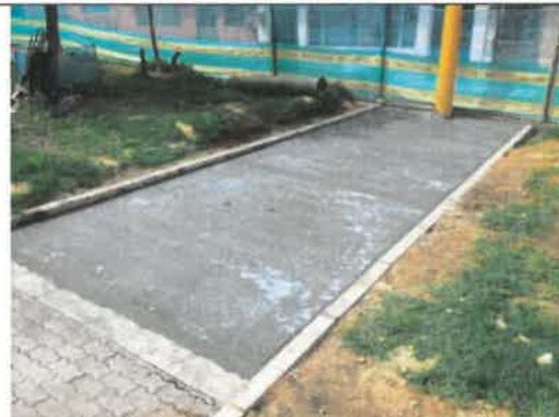
FOTO No 14. La interventoría ARQUITECTURA URBANA LTDA revisa y verifica que el contratista CONSORCIO OPORTO realice el respectivo curado a la losa de concreto.
