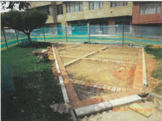
FOTO No 9. La interventoría ARQUITECTURA URBANA LTDA revisa y verifica que la superficie B-600 cumpla con las condiciones óptimas (Limpieza, humedad y/o contaminación). Se ejecuta la actividad de la cenefa en adoquín respondiendo a la recomendación de la interventoría del diseño de la placa. Total: 48,96 ML
