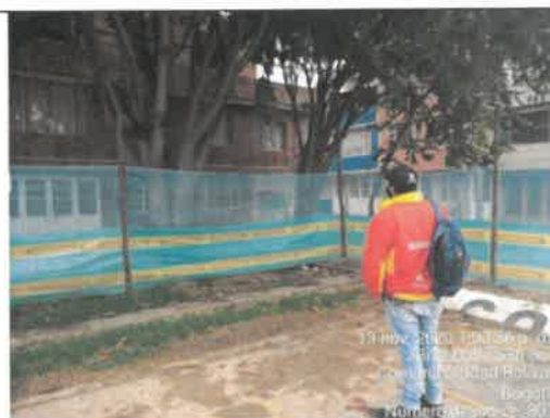
FOTO No. 93. Se revisó y verificó la inspección y clasificación de los individuos arbóreos para la poda, parque URBANIZACIÓN LA ESTANCIA (19-149) por parte del ingeniero ANDRÉS SEPÚLVEDA del FONDO DE DESARROLLO LOCAL DE CIUDAD BOLÍVAR
