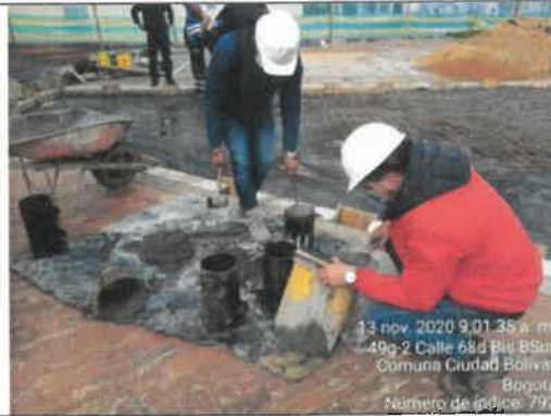
FOTO No. 145. Se revisó y verifíco la toma de muestra de concreto., parque URBANIZACIÓN CANDELARIA LA NUEVA II SECTOR 1ª ETAPA (19-479)
