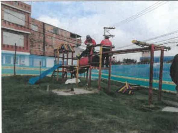
FOTO No 51. La interventoría ARQUITECTURA URBANA LTDA revisa y verifica que el contratista CONSORCIO OPORTO realice el desmonte de juego infantil en madera y haga su respectiva disposición final con el operador aprobado.
