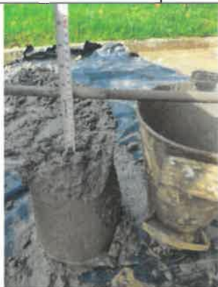
FOTO No 11. La interventoría ARQUITECTURA URBANA LTDA revisa y verifica que el contratista CONSORCIO OPORTO realice la toma de cilindros de concreto 3000 psi y asentamiento (slump) p: 4.5" .
