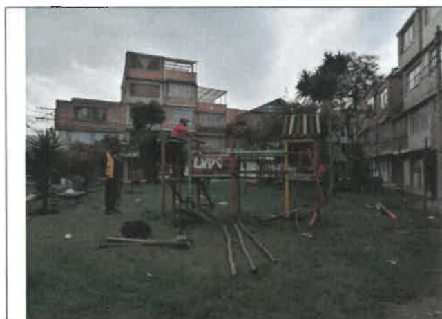
FOTO No 47. La interventoría ARQUITECTURA URBANA LTDA revisa y verifica que el contratista CONSORCIO OPORTO realice el desmonte de juego infantil en madera y haga su respectiva disposición final con el operador aprobado.
