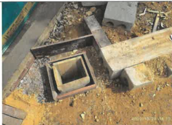
FOTO No 18. La interventoría ARQUITECTURA URBANA LTDA evidencia que durante este periodo el contratista CONSORCIO OPORTO no ejecuto actividades en la primera semana de noviembre.
