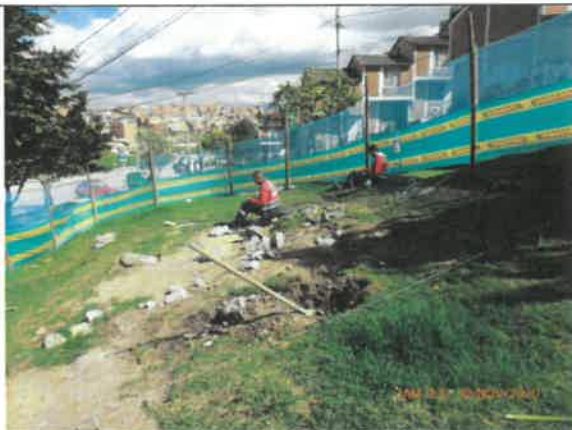
FOTO No 61. La interventoría ARQUITECTURA URBANA LTDA revisa y verifica que el contratista CONSORCIO OPORTO realice la actividad de descapote del material. Estas disposiciones finales deberán ser soportadas mediante los vales de disposición final. El total de descapote es de 32,35 M3
