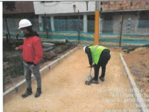
FOTO No. 125. Se revisó y verificó el cumplimiento del distanciamiento de seguridad industrial en la toma de densidades con el densímetro nuclear realizada, parque URBANIZACIÓN LA ESTANCIA 19-038
