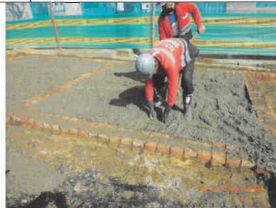
FOTO No 12. La interventoría ARQUITECTURA URBANA LTDA revisa y verifica que la malla electrosoldada cumpla con el recubrimiento horizontal exigido de 5 cm.
