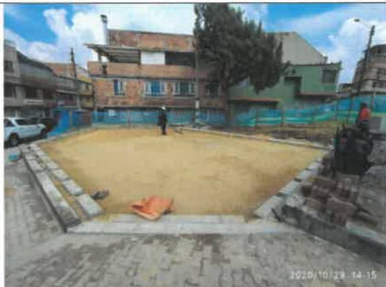
FOTO No 15. La interventoría ARQUITECTURA URBANA LTDA evidencia que durante este periodo el contratista CONSORCIO OPORTO no ejecuto actividades en la primera semana de noviembre.
