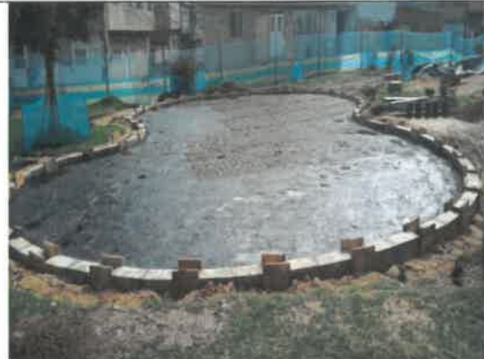
FOTO No 4. La interventoría ARQUITECTURA URBANA LTDA revisa y verifica que el contratista CONSORCIO OPORTO realice la respectiva imprimación con emulsión asfáltica sobre base granular.
