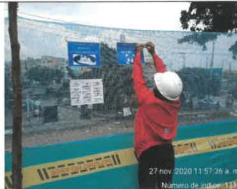
Foto No. 74. Instalación señalización plan de manejo de tráfico PARQUE DESARROLLO SIERRA MORENA ETAPA 2 19-079
