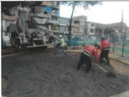
FOTO No 31. La interventoría ARQUITECTURA URBANA LTDA revisa y verifica el concreto (CEMEX) premezclado cumpla con el asentamiento y especificaciones de los materiales.
