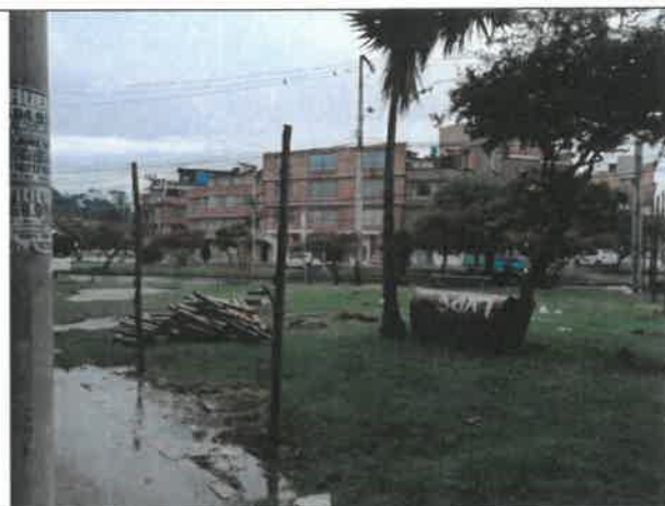
FOTO No 48. La interventoría ARQUITECTURA URBANA LTDA revisa y verifica que el contratista CONSORCIO OPORTO realice el desmonte de juego infantil en madera y haga su respectiva disposición final con el operador aprobado.
