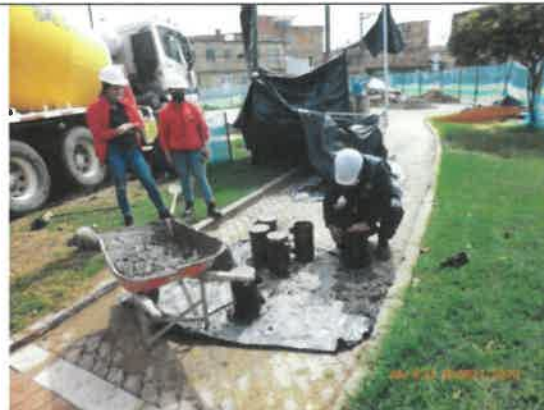
FOTO No 10. La interventoría ARQUITECTURA URBANA LTDA revisa y toma sus propias muestras de toma de cilindros de la placa de contrapiso del área de la plazoleta y del sendero peatonal. También, realiza la prueba del Slump, para verificar su plasticidad.
