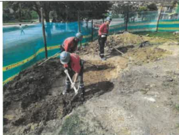
FOTO No 62. La interventoría ARQUITECTURA URBANA LTDA revisa y verifica que el contratista CONSORCIO OPORTO realice la actividad de excavación manual. La actividad de excavación manual debe ser soportada mediante los vales de disposición final. La altura de excavación es de 0,325 M. TOTAL EXCAVACIÓN MANUAL: 15,53 M3
