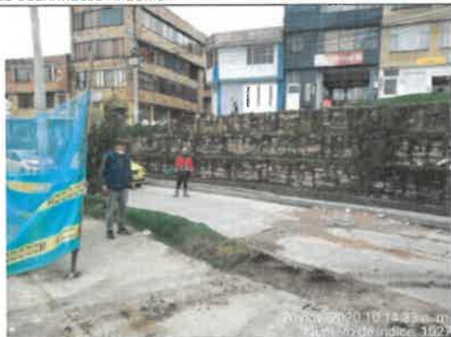
Foto No. 69. Se revisó y verificó la instalación de señalización, PARQUE VECINAL URBANIZACIÓN LA ESTANCIA 19-038
