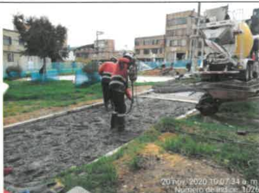
FOTO No. 166. Se revisó y verificó el cumplimiento del distanciamiento de bioseguridad, parque URBANIZACIÓN LA ESTANCIA 19-039
