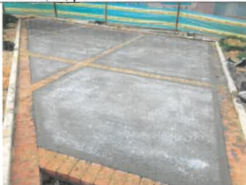
FOTO No 13. La interventoría ARQUITECTURA URBANA LTDA revisa y verifica que el contratista CONSORCIO OPORTO realice el respectivo curado a la losa de concreto.
