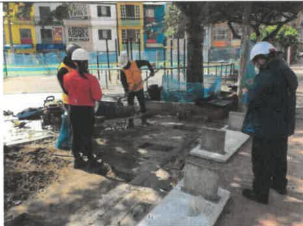
FOTO No 35. La interventoría ARQUITECTURA URBANA LTDA revisa y verifica que el contratista CONSORCIO OPORTO realice la actividad de la instalación de bancas prefabricadas M-3I. Después de revisar las certificaciones de calidad. Total de bancas: 9, 0 UN.
