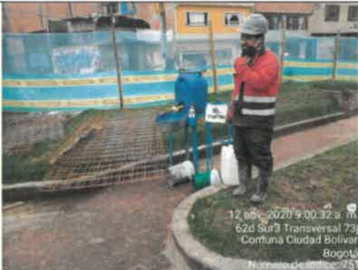
FOTO No. 138. Se revisa y verifica la instalación del lavamanos, parque URBANIZACIÓN LA ESTANCIA. 19-039
