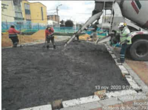
FOTO No. 146. Se revisó y verifico el vaciado del concreto para la fundida de la placa., parque URBANIZACIÓN CANDELARIA LA NUEVA II SECTOR 1º ETAPA (19-479)
