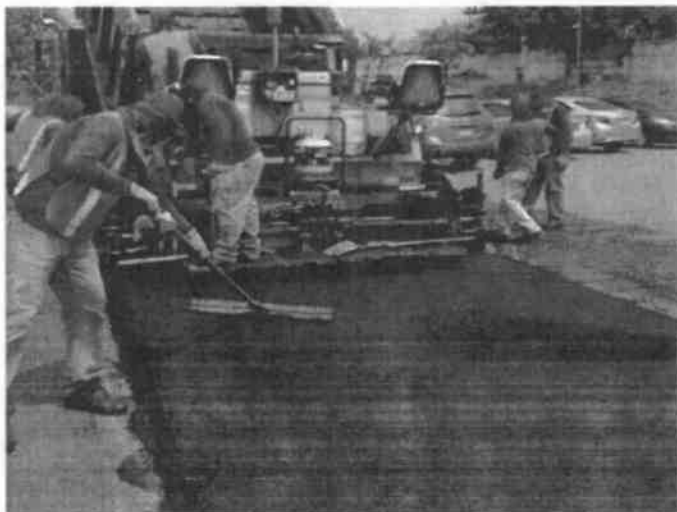
Rodadura asfáltica con espesor de 7 cm
