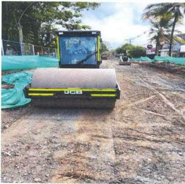
Compactación de la subrasante tramo ABSC 0 + 500 en adelante
