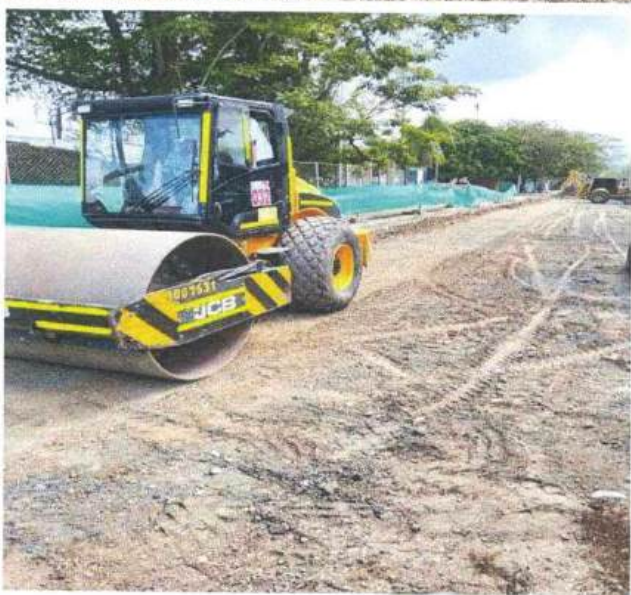
Compactación de la subrasante tramo ABSC 0 + 500 en adelante
