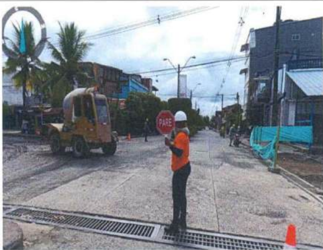
Implementación del PMT, control de tráfico.
