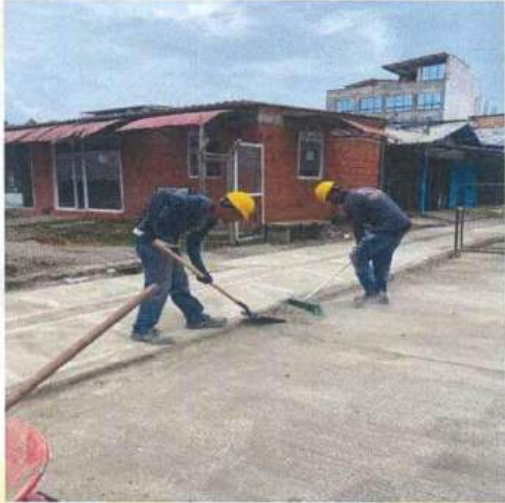
Jornadas de aseo frente de obra.
