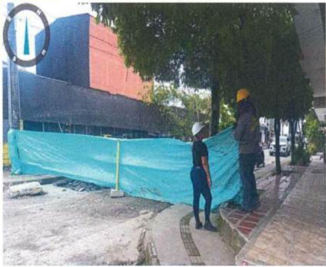
Instalación de señalización preventiva del frente de obra.
