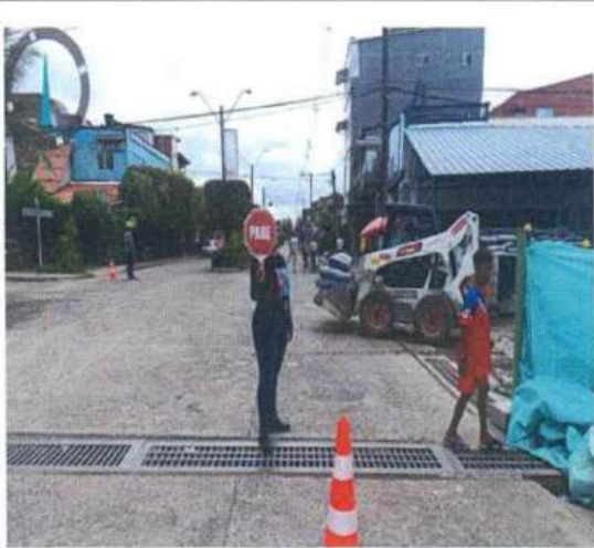
Implementación del PMT, control de tráfico.
