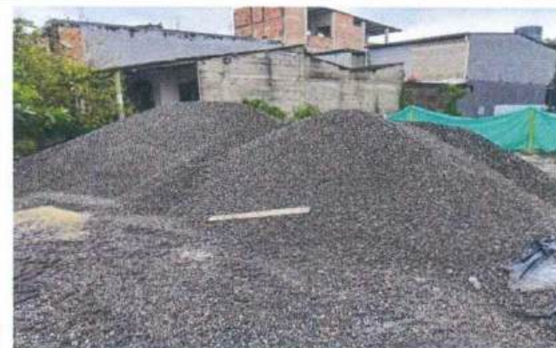
Material pétreo. ubicado dentro del frente de obra y en sitio seco, área de vaciado de concreto
