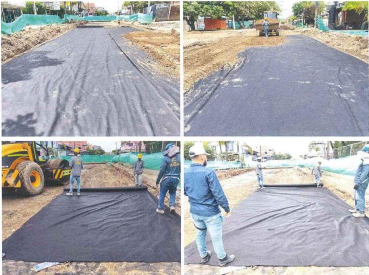
Instalación de geotextil NT-2500 tramo ABSC 0 + 500 en adelante
