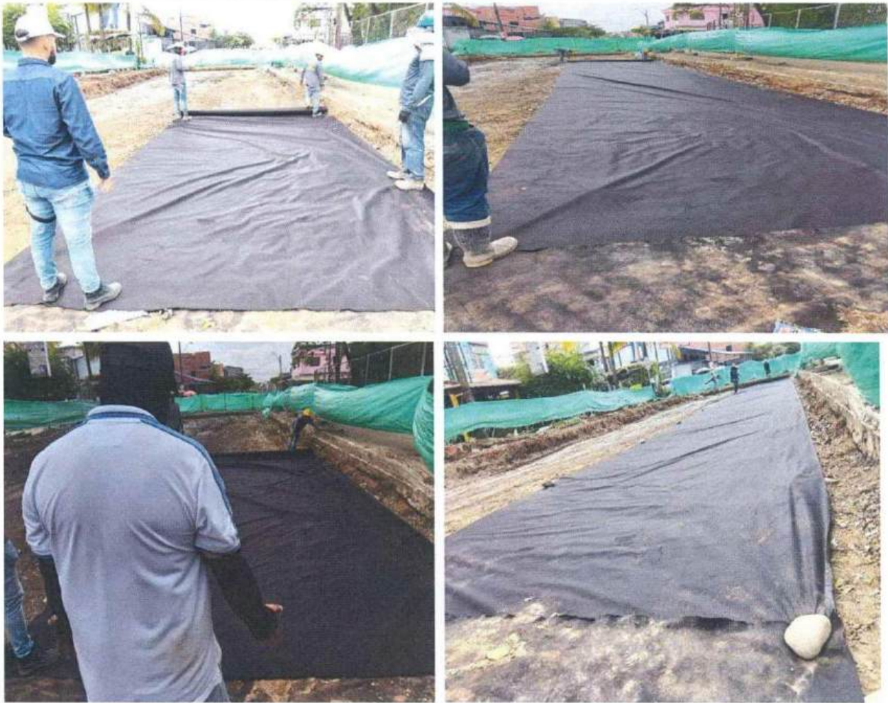
Instalación de geotextil NT-2500 tramo ABSC 0 + 500 en adelante
