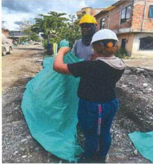
Instalación de señalización preventiva del frente de obra.
