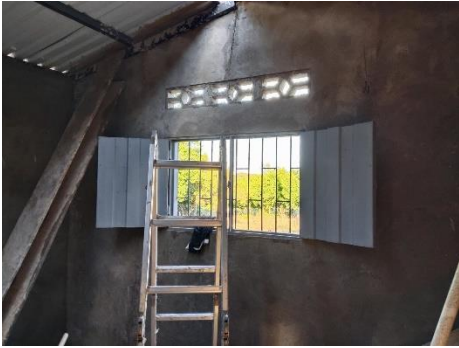
Foto No. 19 ejecución de actividades.
