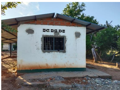
Foto No. 17 ejecución de actividades.
