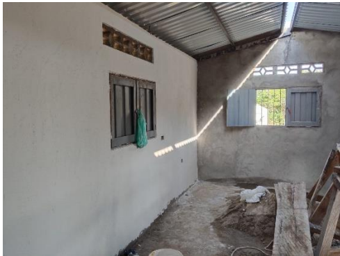
Foto No. 31 ejecución de actividades.
