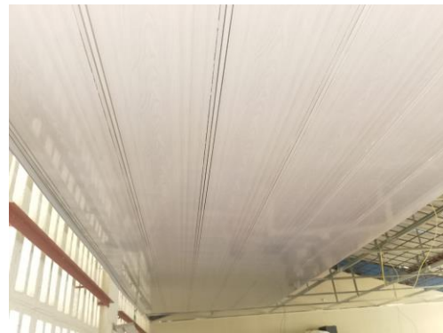
Foto No. 90 ejecución de actividades.
