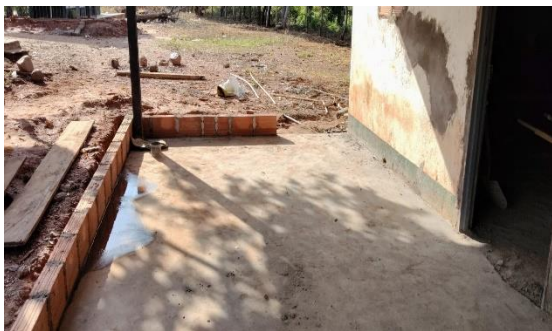
Foto No. 29 ejecución de actividades.
