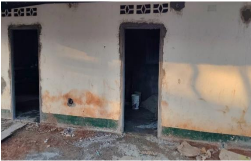
Foto No. 21 ejecución de actividades.
