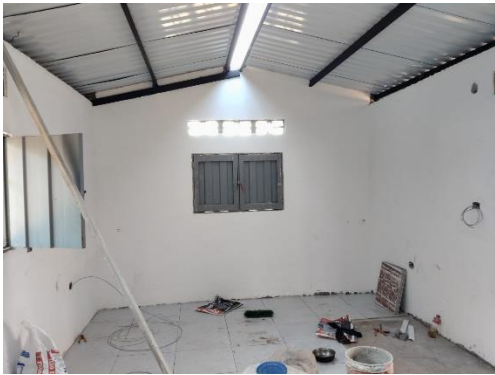
Foto No. 37 ejecución de actividades.
