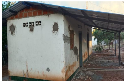
Foto No. 24 ejecución de actividades.
