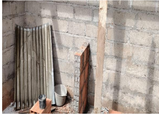
Foto No. 8 ejecución de actividades.
