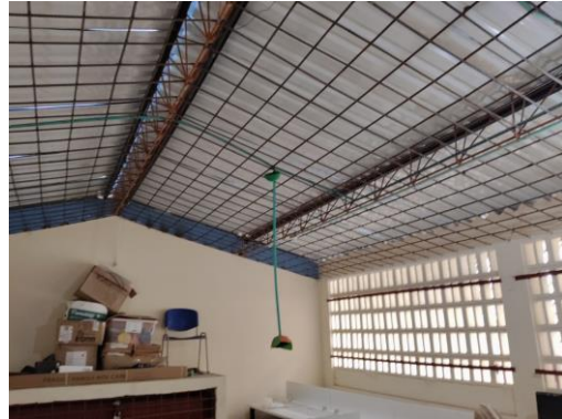
Foto No. 86 ejecución de actividades.
