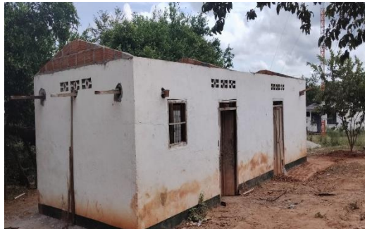
Foto No. 14 ejecución de actividades.
