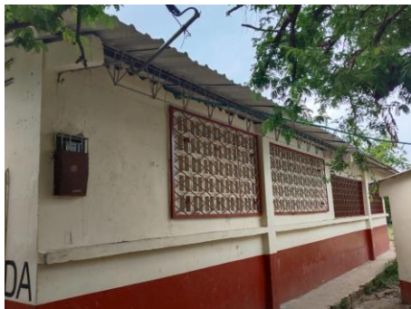
Foto No. 83 ejecución de actividades.
