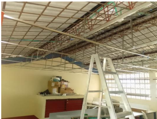
Foto No. 87 ejecución de actividades.
