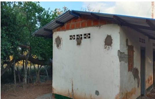
Foto No. 23 ejecución de actividades.
