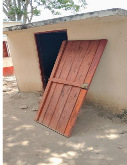
Foto No. 98 ejecución de actividades.
