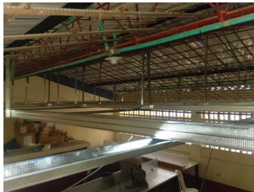
Foto No. 88 ejecución de actividades.
