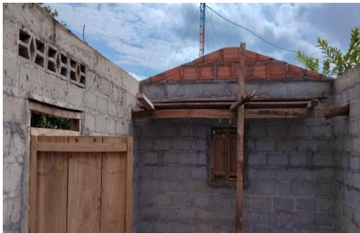
Foto No. 9 ejecución de actividades.
