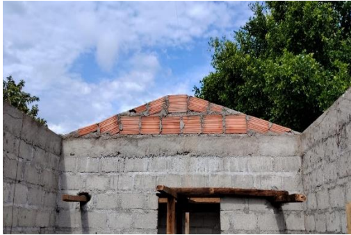
Foto No. 7 ejecución de actividades.
