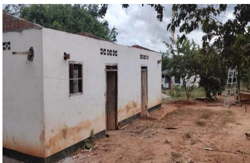
Foto No. 15 ejecución de actividades.
