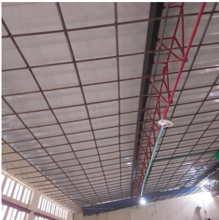
Foto No. 77 ejecución de actividades.
