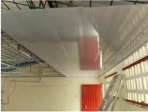
Foto No. 91 ejecución de actividades.
