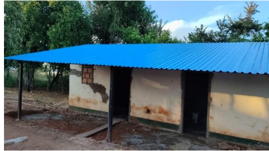
Foto No. 26 ejecución de actividades.
