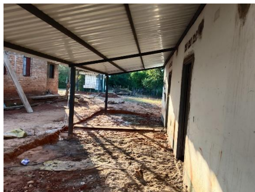
Foto No. 18 ejecución de actividades.
