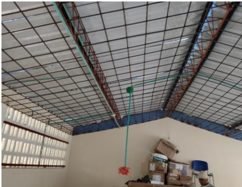
Foto No. 85 ejecución de actividades.
