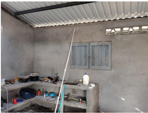
Foto No. 33 ejecución de actividades.
