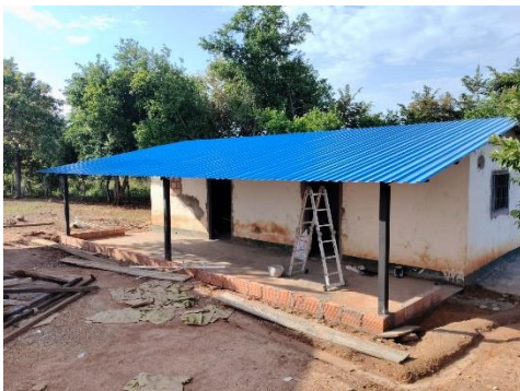
Foto No. 35 ejecución de actividades.
