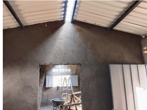
Foto No. 20 ejecución de actividades.
