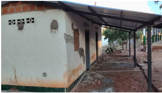
Foto No. 25 ejecución de actividades.
