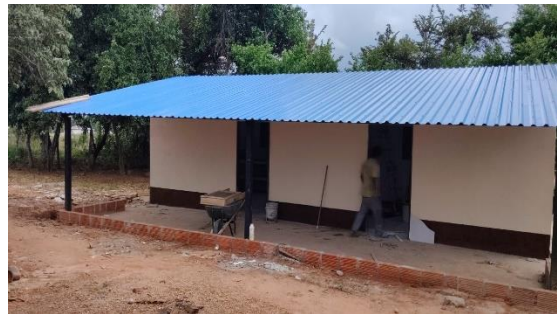
Foto No. 44 condiciones finales.
