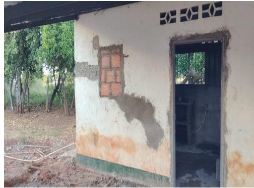
Foto No. 22 ejecución de actividades.
