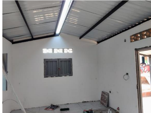
Foto No. 38 ejecución de actividades.
