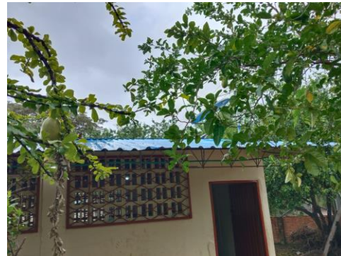
Foto No. 82 ejecución de actividades.
