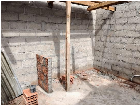
Foto No. 11 ejecución de actividades.
