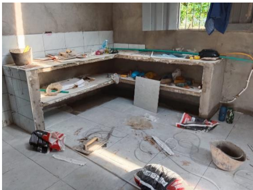
Foto No. 41 ejecución de actividades.
