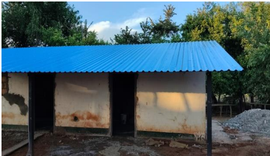
Foto No. 27 ejecución de actividades.
