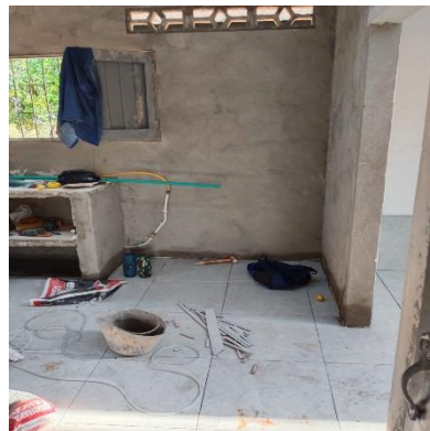
Foto No. 42 ejecución de actividades.
