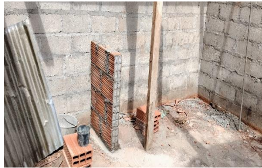
Foto No. 10 ejecución de actividades.
