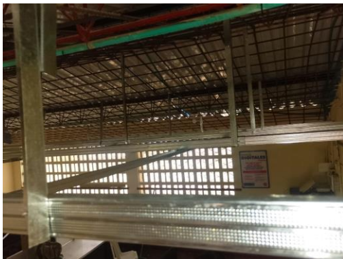
Foto No. 89 ejecución de actividades.
