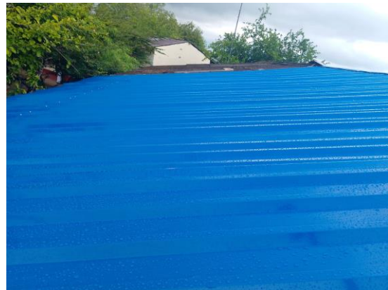
Foto No. 78 ejecución de actividades.
