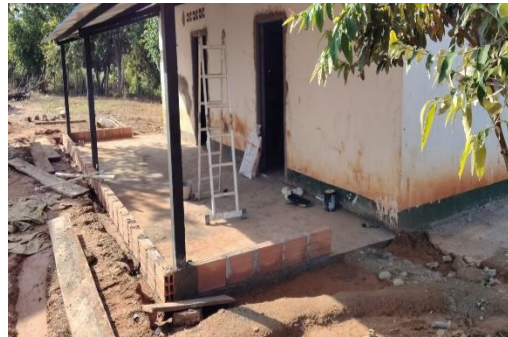
Foto No. 28 ejecución de actividades.
