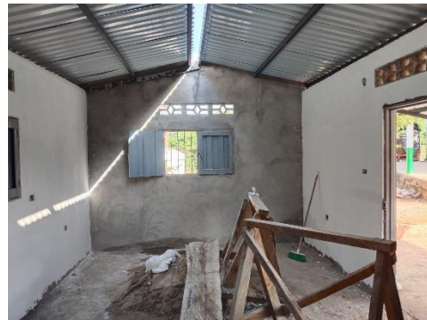
Foto No. 32 ejecución de actividades.
