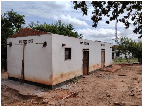
Foto No. 13 ejecución de actividades.
