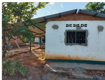
Foto No. 16 ejecución de actividades.
