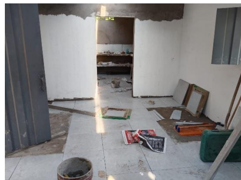
Foto No. 36 ejecución de actividades.
