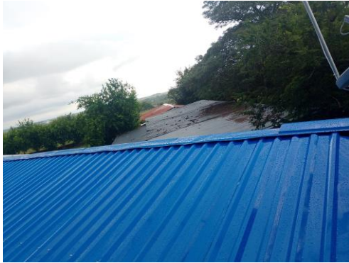
Foto No. 79 ejecución de actividades.
