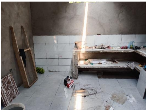
Foto No. 39 ejecución de actividades.
