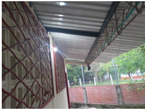
Foto No. 81 ejecución de actividades.
