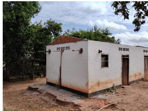
Foto No. 12 ejecución de actividades.
