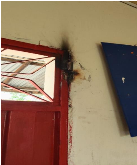
Foto No. 97 ejecución de actividades.
