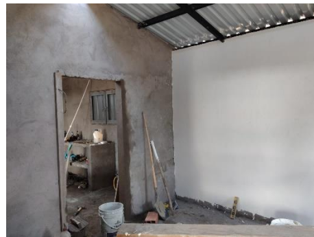
Foto No. 30 ejecución de actividades.
