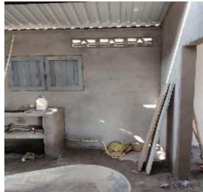
Foto No. 34 ejecución de actividades.
