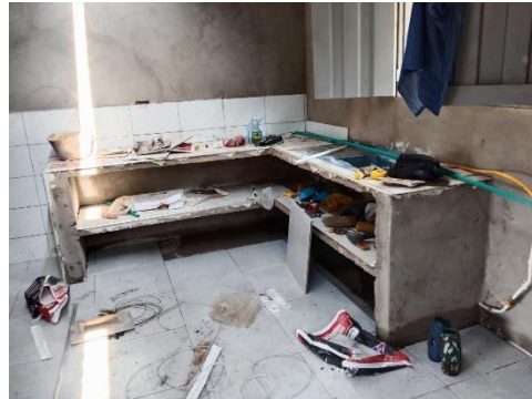
Foto No. 40 ejecución de actividades.
