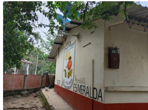
Foto No. 84 ejecución de actividades.
