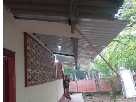
Foto No. 80 ejecución de actividades.
