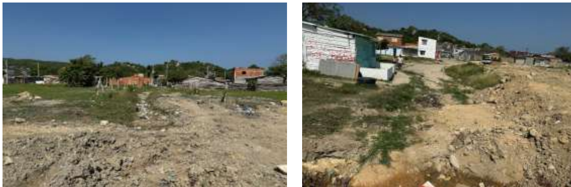
Ilustración 3 Escorrentías de áreas adyacentes a la vía
