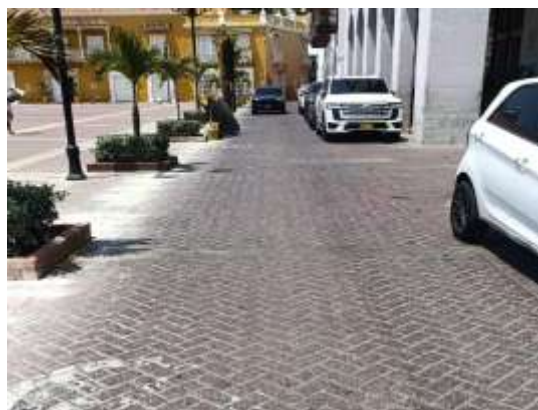
Ilustración 4 Condiciones Urbanísticas del entorno aledaños a la vía
