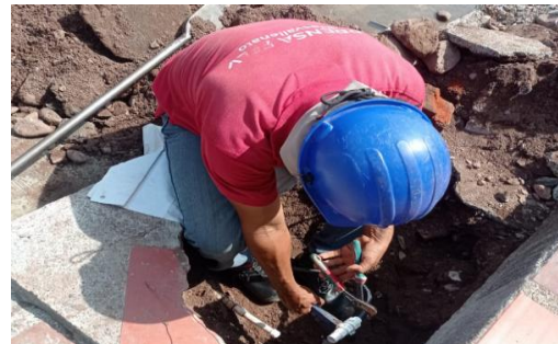
Imagen: Reparación red domiciliaria.
