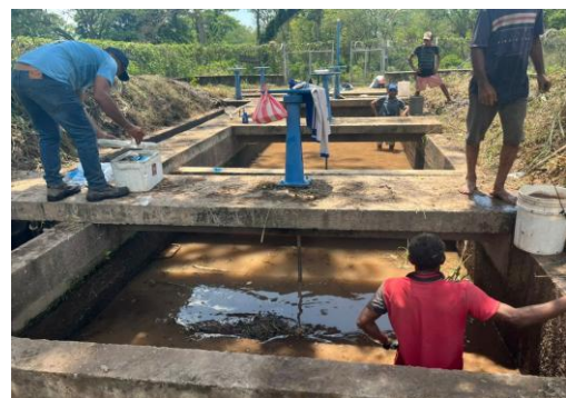
Imagen: Limpieza desarenador Casacará.
