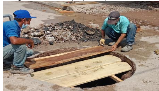
Imagen: Reconstrucción corona de inspección.
