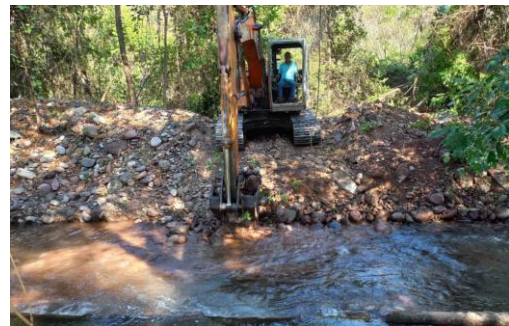
Imagen: Canalización antigua bocatoma.
