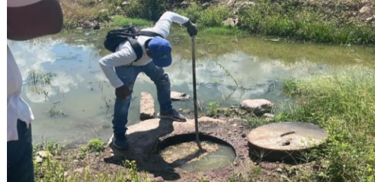
Imagen: Sondeo tubería y limpieza de pozos alcantarillado.
