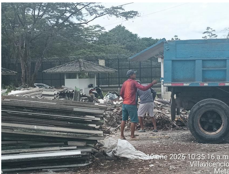
Figura 9. Recolección de RCD por parte del contratista. Fuente: (Autores propios, 2026)
