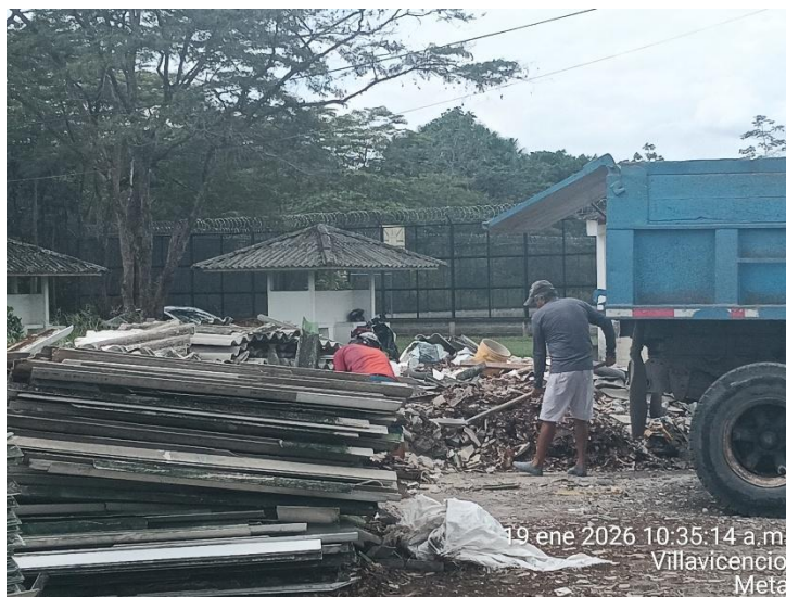
Figura 10. Recolección de RCD por parte del contratista. Fuente: (Autores propios, 2026)
