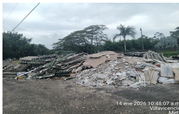
Figura 2. Acopio de RCD de taparito. Fuente: Autores propios, 2026.
