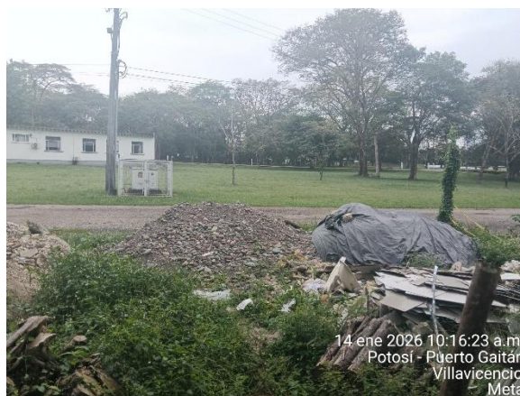
Figura 1. Acopio de RCD de casa 53. Fuente: Autores propios, 2026.
