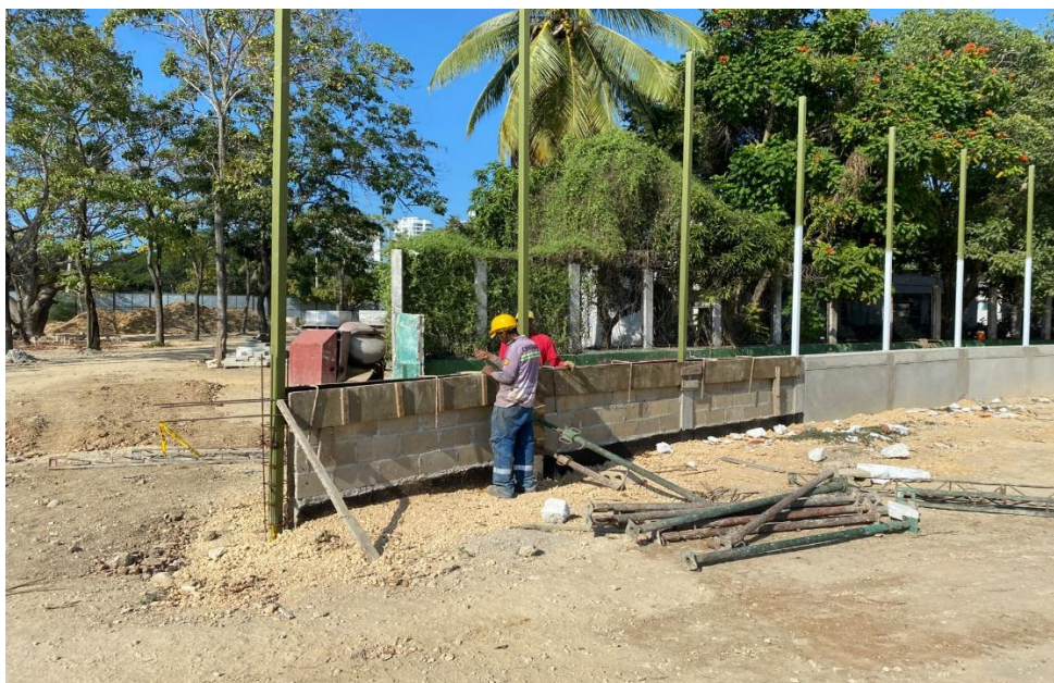
Ilustración 19. Fundida concreto 4000 psi viga de confinamiento cerramiento perimetral
