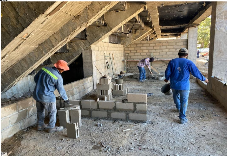
Ilustración 25. Levante en block No 4 baños graderías de softbol
