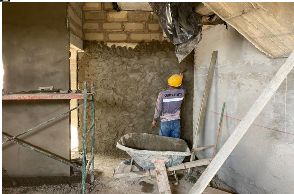
Ilustración 27. Pañete baños graderías de softbol
