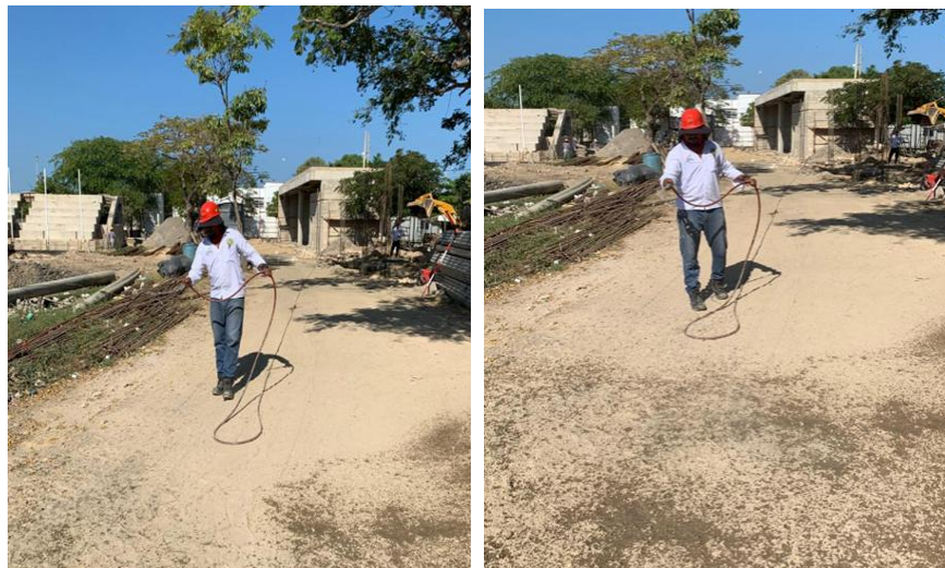
Ilustración 87. Riego de agua contra el polvo
