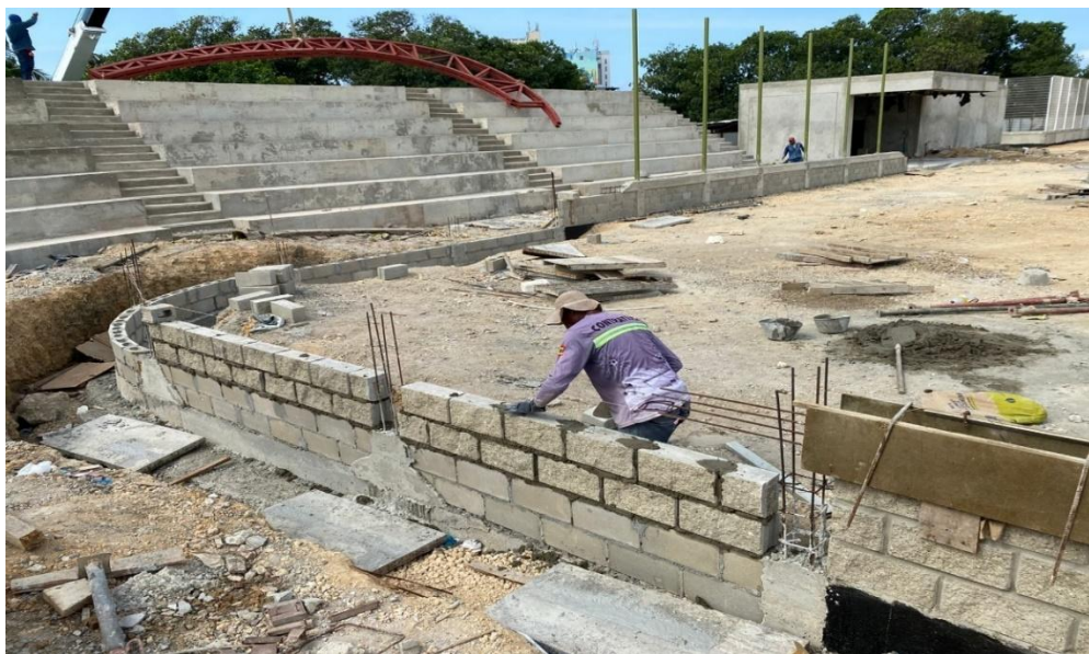
Ilustración 21. Levante en Block No 6 cerramiento cancha de softbol
