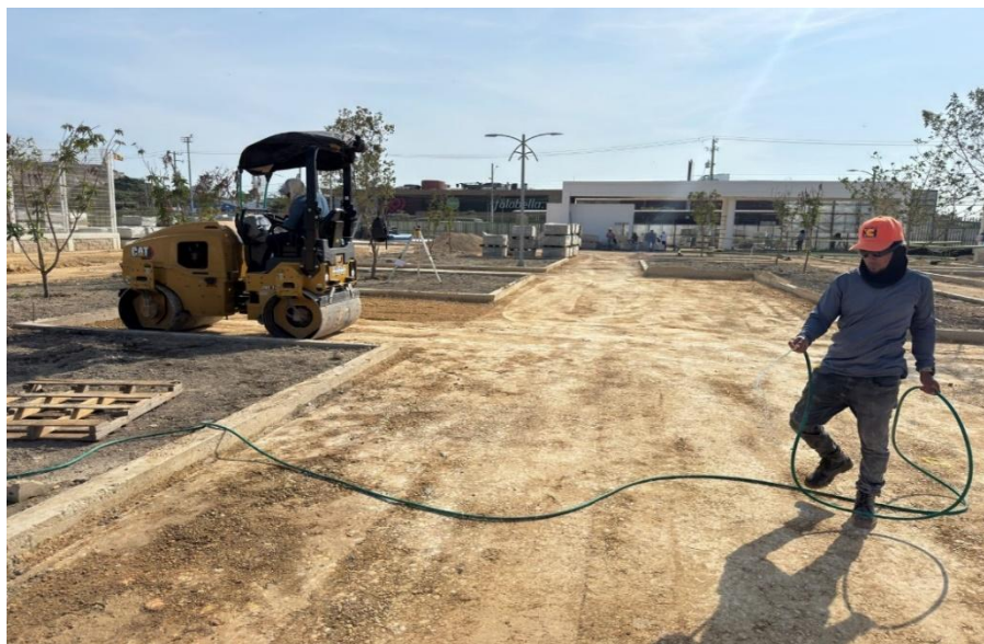
Ilustración 37. Relleno material seleccionado área recuperada
