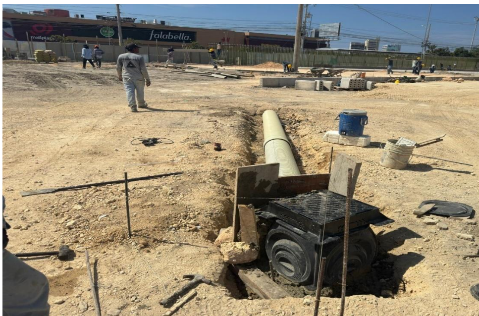
Ilustración 56. Instalación sistema de drenaje aguas lluvias(canaleta)
