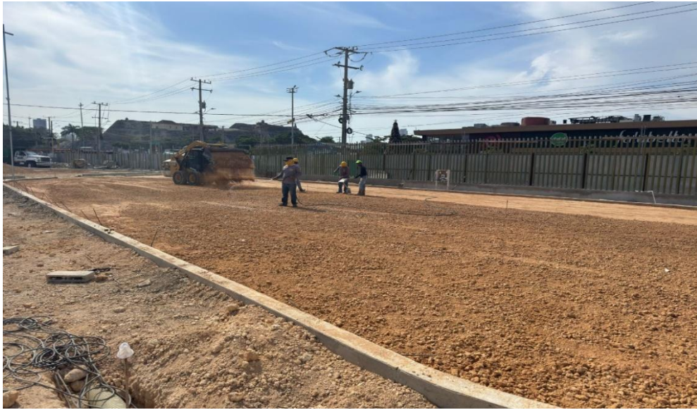
Ilustración 39. Relleno y compactación material seleccionado para acondicionamiento zona de niños
