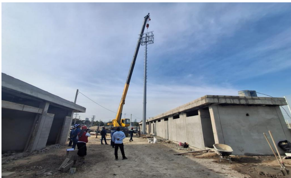
Ilustración 65. Instalaciones mástiles y canastillas canchas futbol 11 y 9
