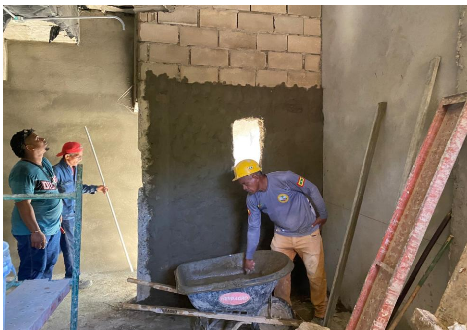
Ilustración 26. Pañete baños graderías de softbol
