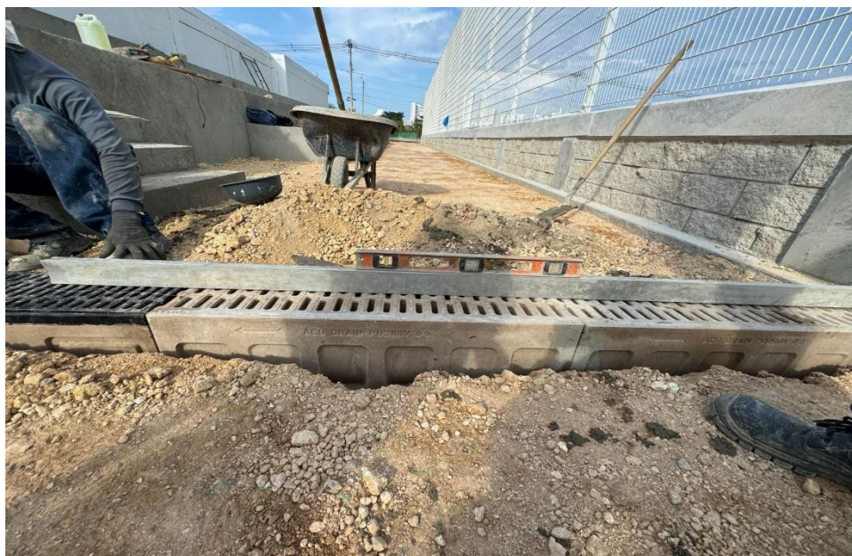
Ilustración 57. Instalación sistema de drenaje aguas lluvias(canaleta)
