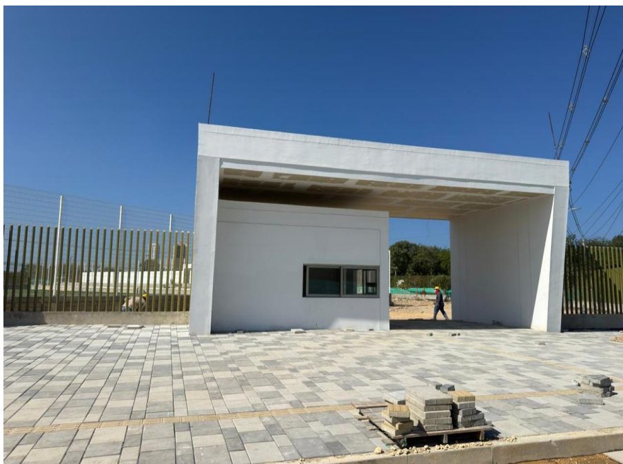
Ilustración 63. Instalación de estuco exterior y cielo raso acceso parqueadero
