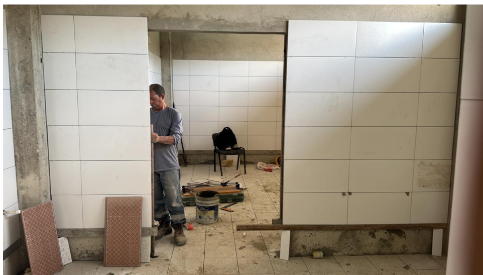
Ilustración 58. Instalación de pisos y enchape baños y camerinos cancha futbol 11
