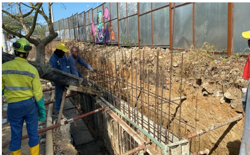
Ilustración 20. Fundida concreto 4000 psi muro de contención
