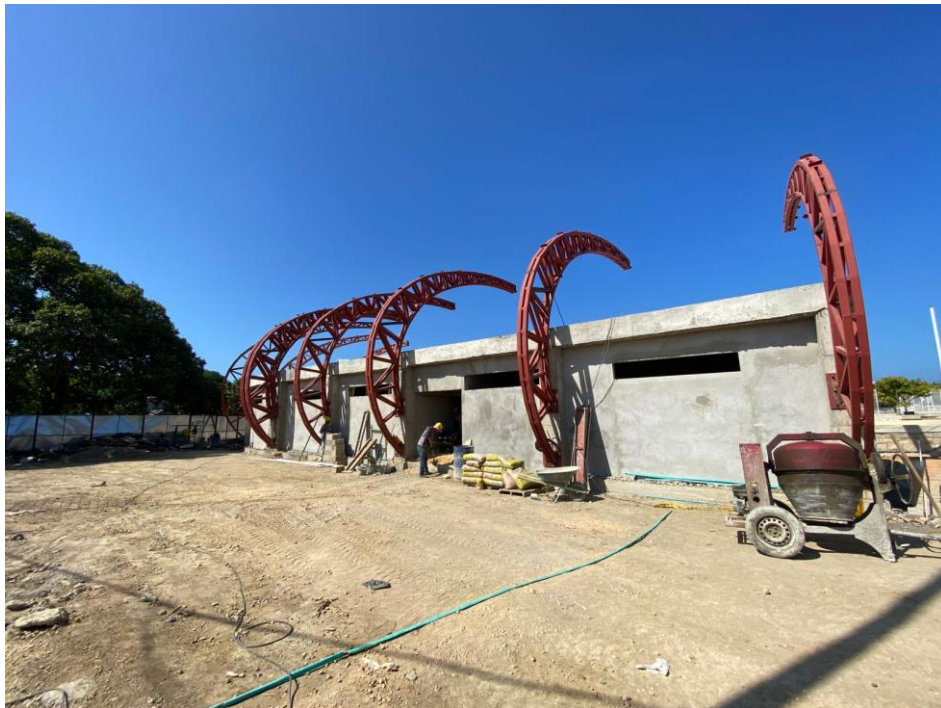
Ilustración 30. Instalación cerchas metálicas para cubierta gradierías de fútbol
