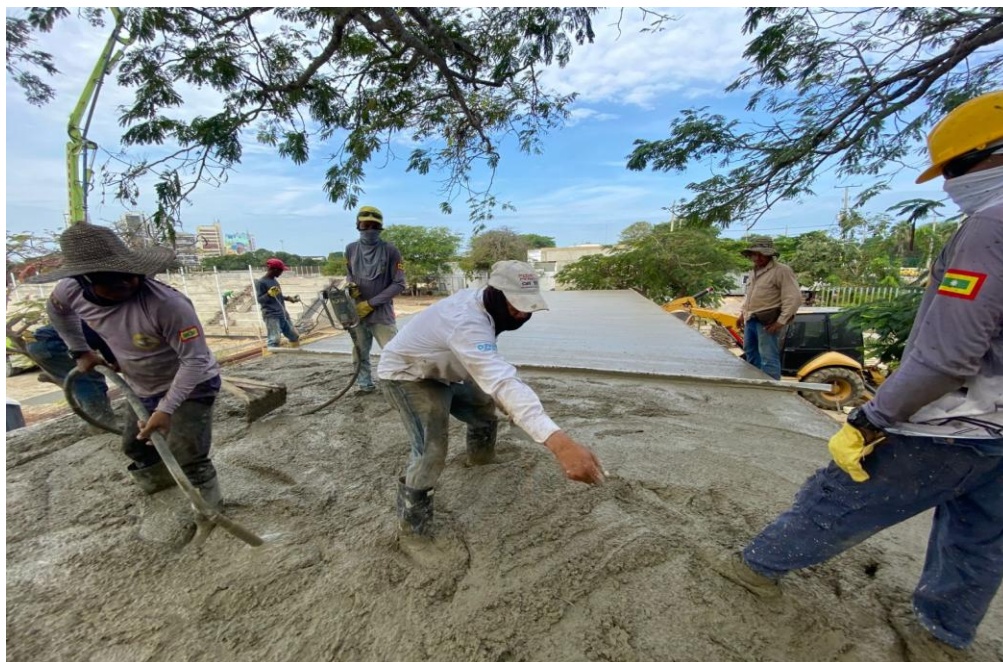
Ilustración 17. Fundida concreto 4000 psi placa cuartos técnicos
