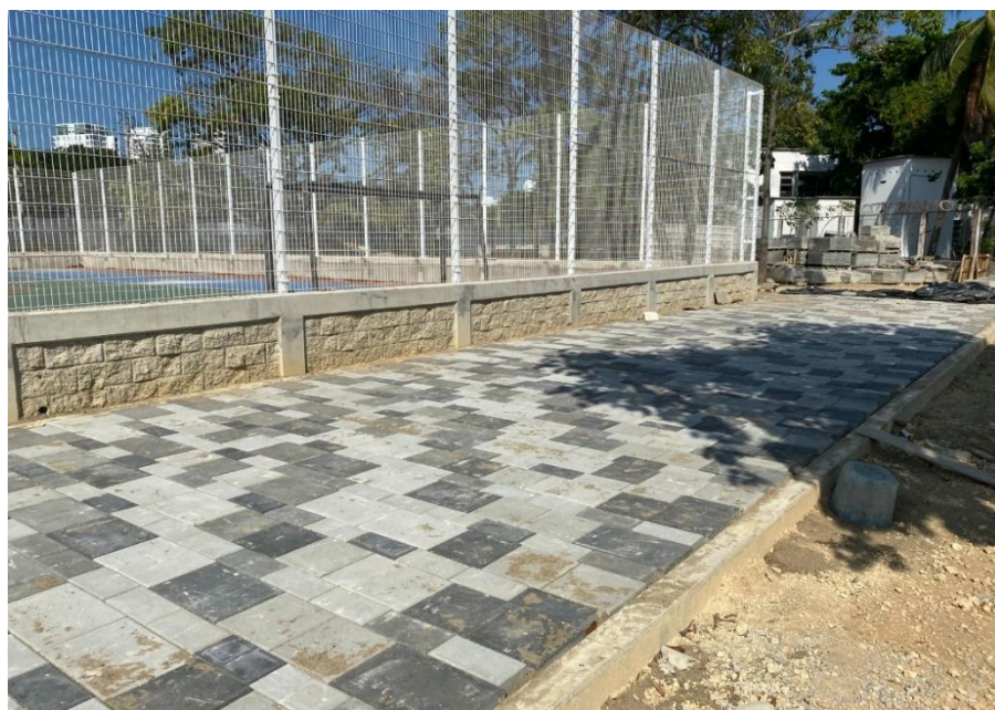
Ilustración 32. Instalación losetas circulación cancha múltiple
