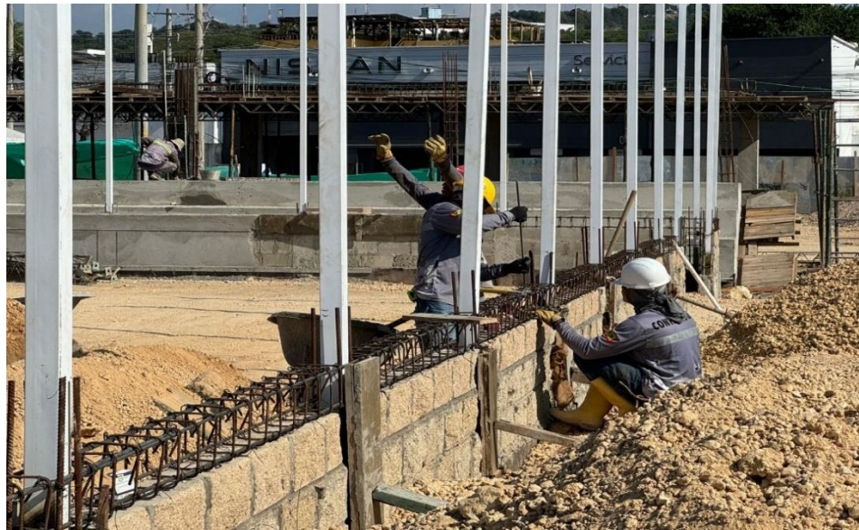
Ilustración 41. Figurado acero de refuerzo 60.000 psi viga confinamiento cerramiento cancha futbol 9
