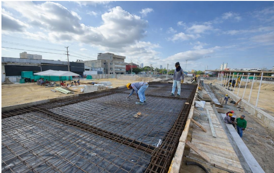
Ilustración 40. Figurado acero de refuerzo 60.000 placa faltante baños y camerinos futbol 9
