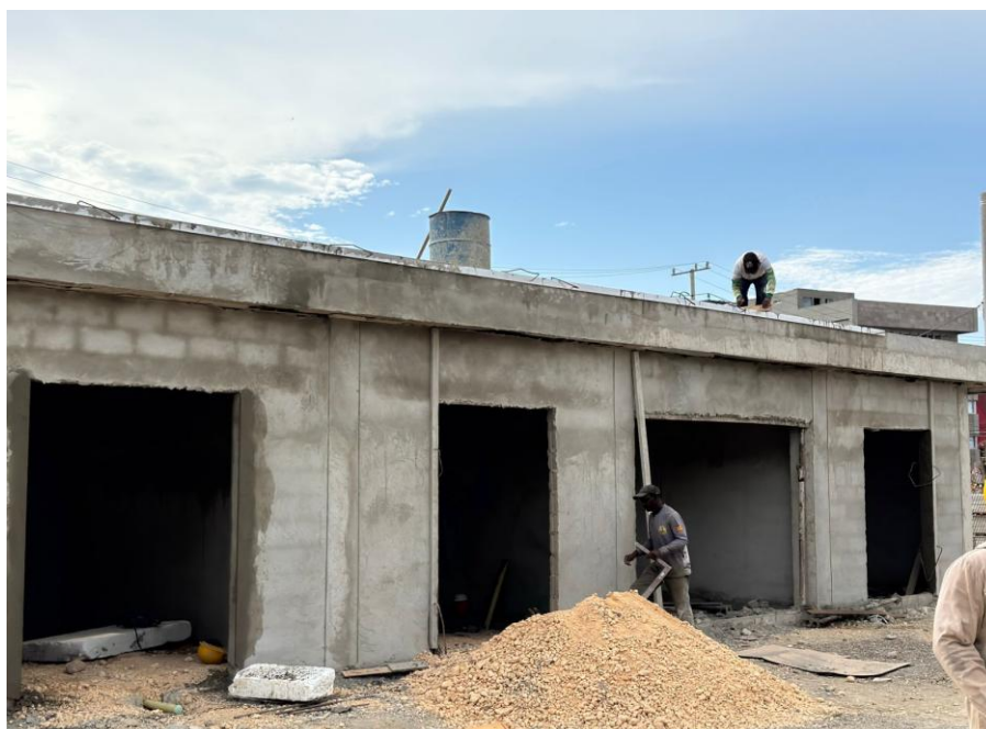
Ilustración 50. Levante en block No 4 baños y camerinos cancha futbol 9
