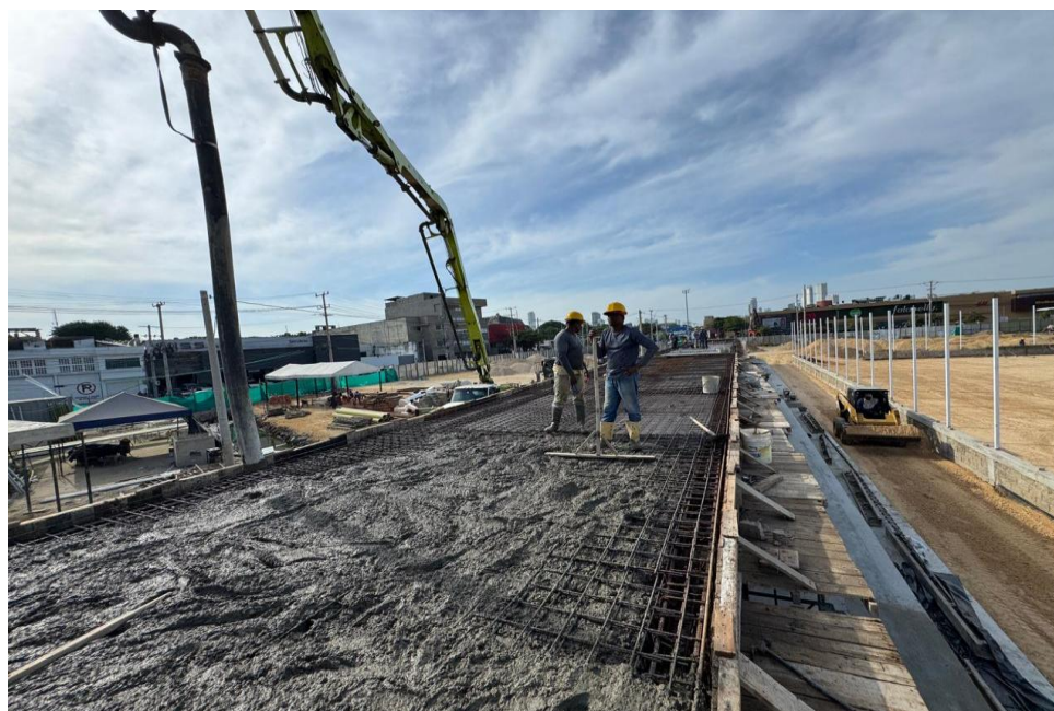
Ilustración 44. Fundida concreto 4000 psi placa baños y camerinos cancha futbol 9
