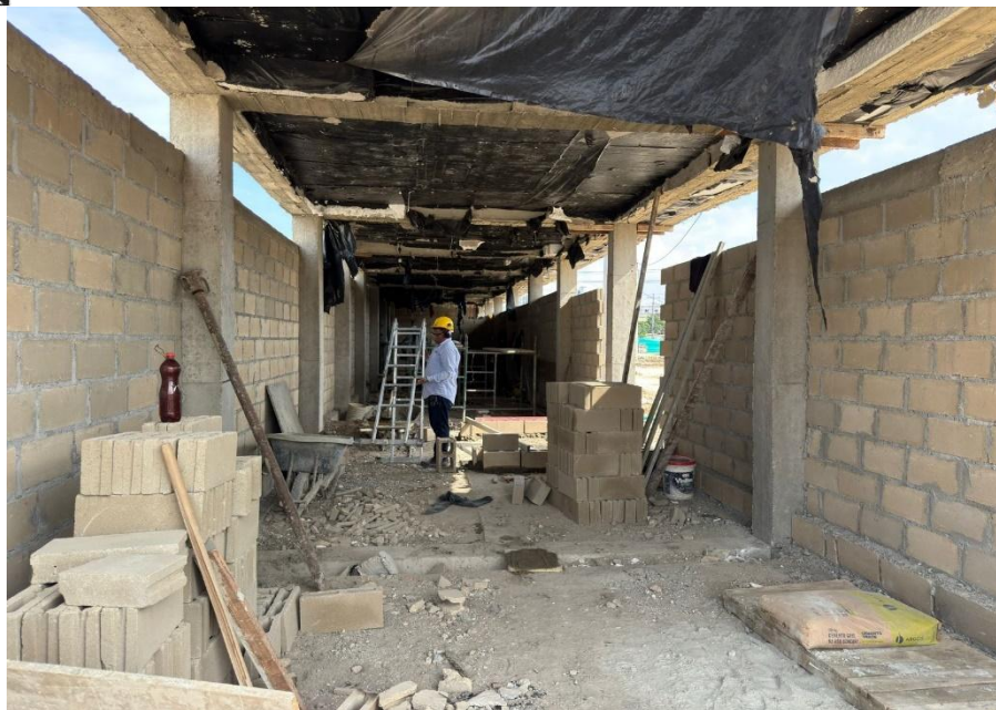
Ilustración 49. Levante en block No 4 baños y camerinos cancha futbol 9
