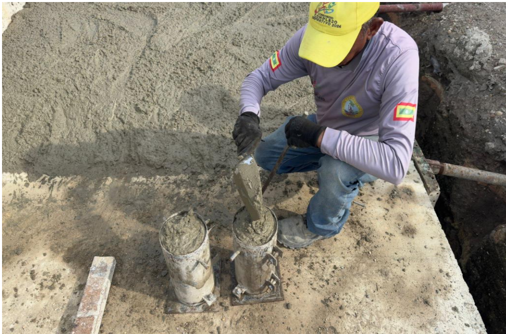
Ilustración 74. Toma de muestras concreto 4000 psi para muro de contención ligas mayores
