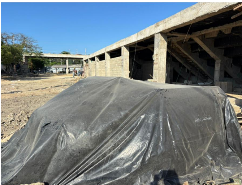
Ilustración 77. Protección de materiales.
