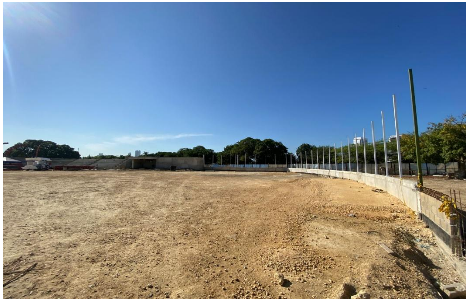
Ilustración 10. Relleno y compactación material seleccionado cancha de softbol.
