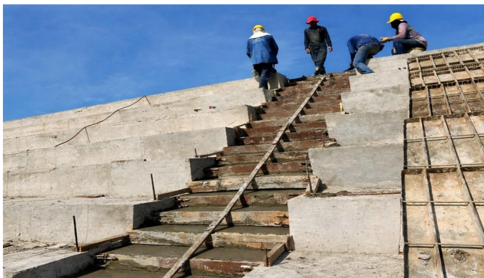
Ilustración 18. Fundida concreto 4000 escaleras graderías cancha de futbol
