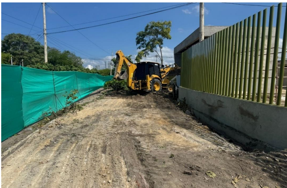
Ilustración 36. Excavación para conformación de terreno para instalación losetas
