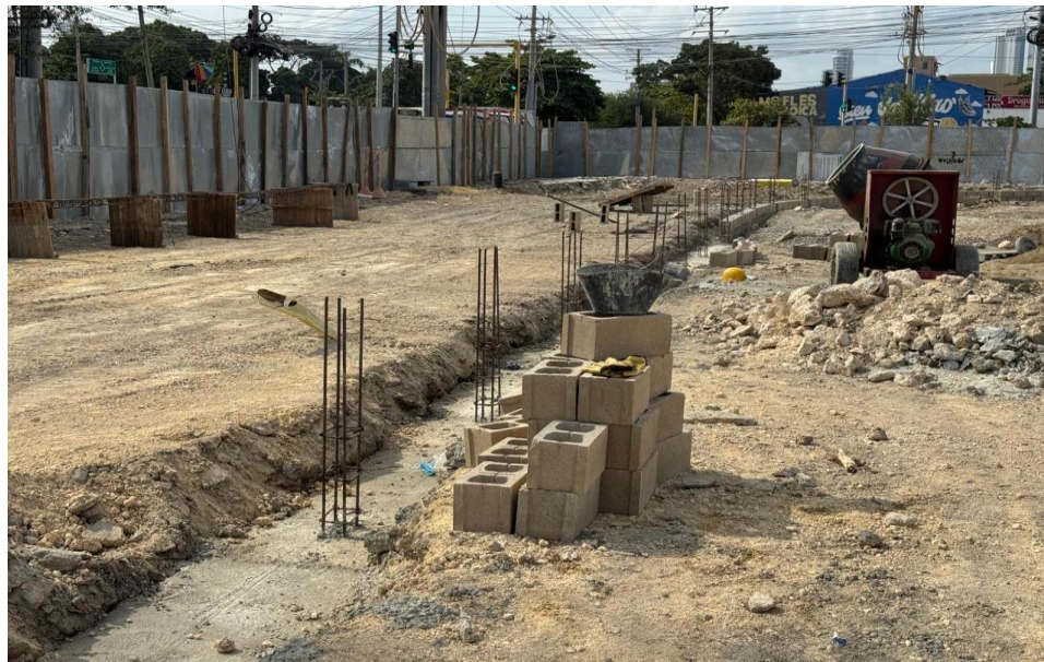
Ilustración 42. Figurado acero de refuerzo de 60.000 psi columnas cerramiento perimetral área recuperada
