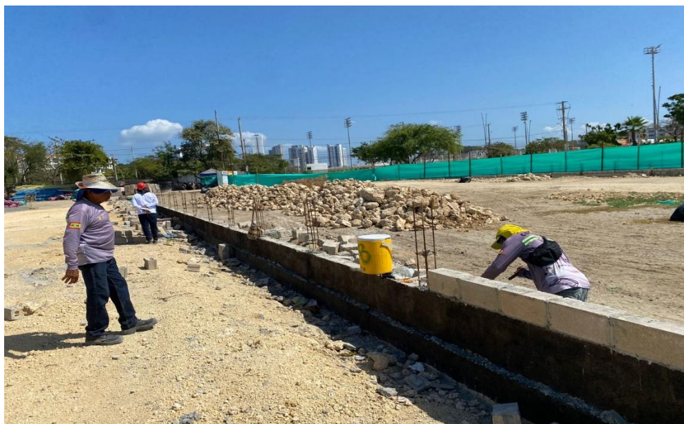
Ilustración 22. Levante en Block No 6 cerramiento cancha de futbol
