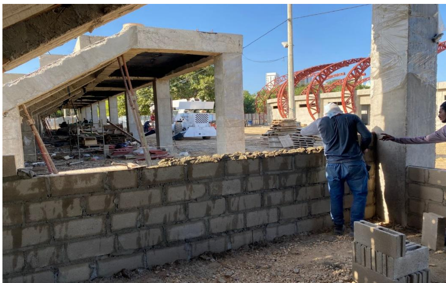
Ilustración 24. Levante en block No 4 baños graderías de futbol
