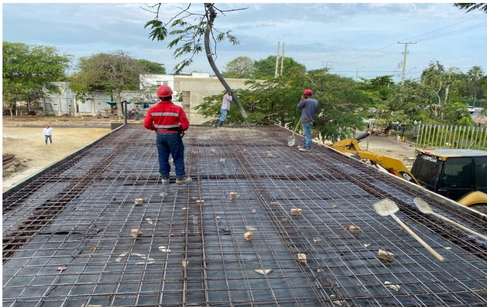
Ilustración 15. Figurado acero 60000 psi placa cuartos técnicos
