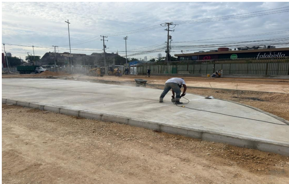
Ilustración 46. Fundida concreto 4000 psi placa juegos de niños
