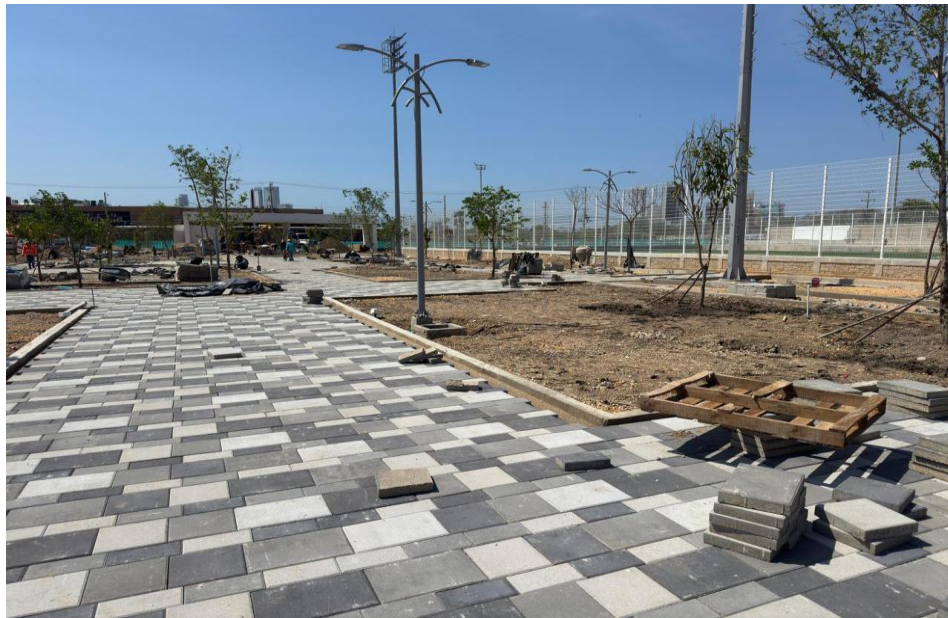
Ilustración 69. Instalación losetas zona central
