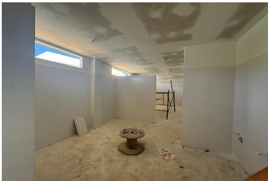
Ilustración 59. Instalación de pisos y enchape baños y camerinos cancha futbol 11
