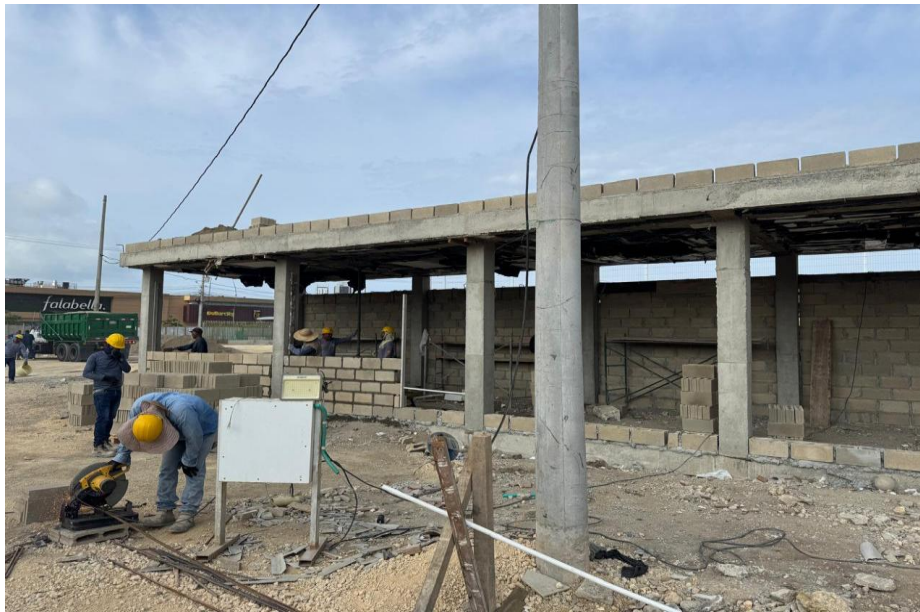
Ilustración 47. Levante en block No 4 baños y camerinos cancha futbol 9
