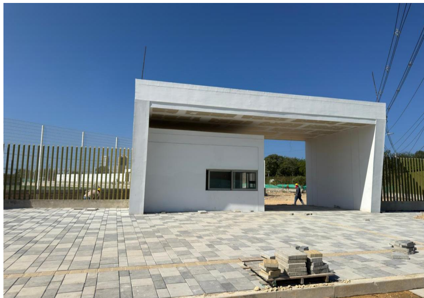
Ilustración 71. Instalación losetas zona parqueaderos
