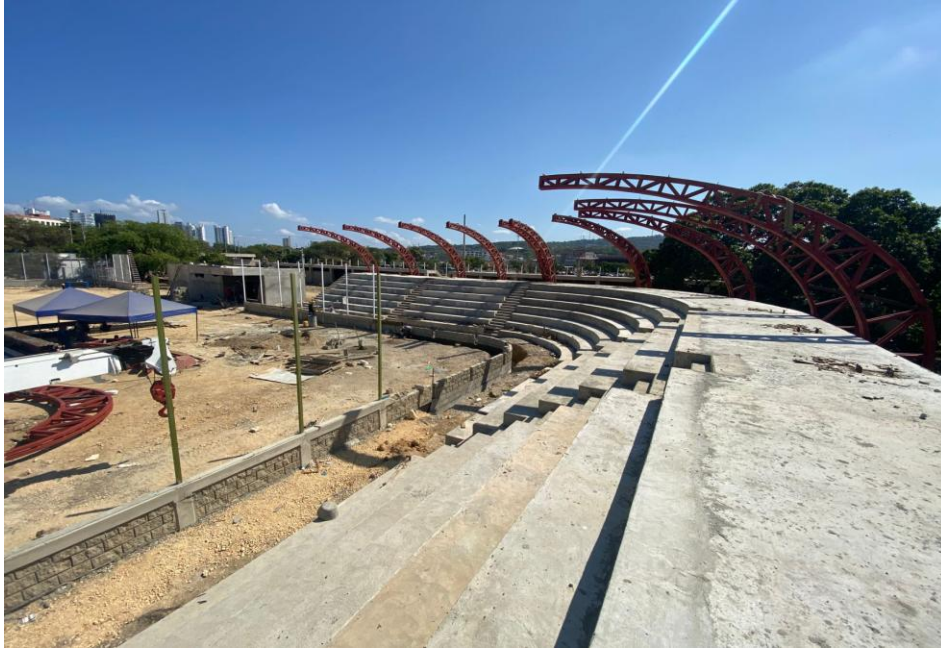
Ilustración 29. Instalación cerchas metálicas para cubierta gradierías de fútbol
