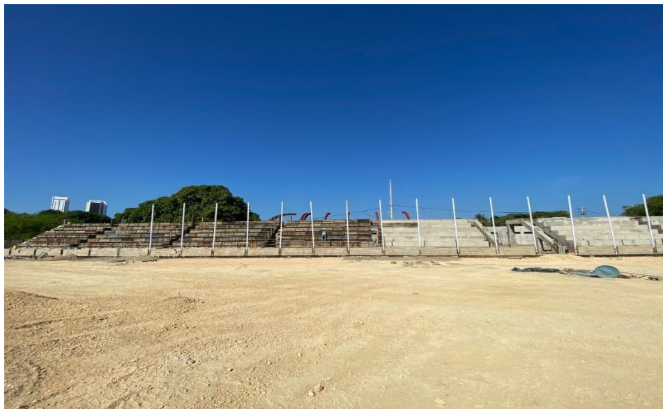
Ilustración 11. Relleno y compactación material seleccionado cancha de futbol
