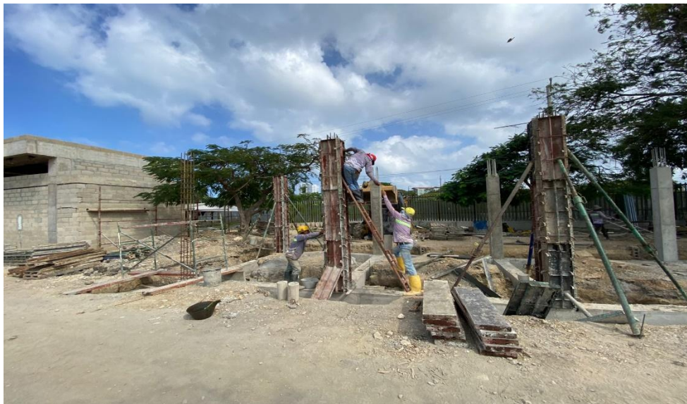
Ilustración 14. Figurado acero 60000 psi columnas cuartos técnicos
