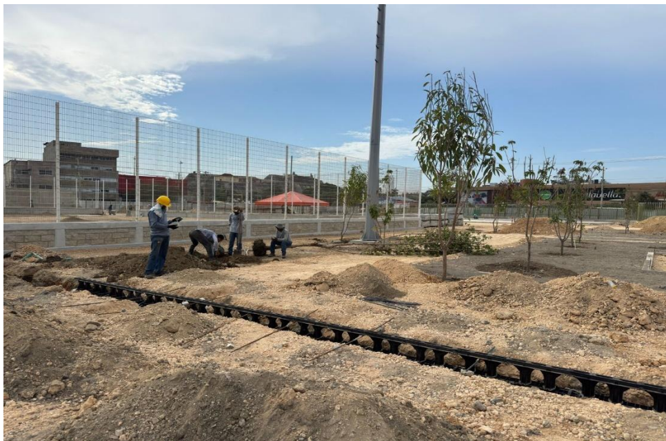
Ilustración 55. Instalación sistema de drenaje aguas lluvias(canaleta)
