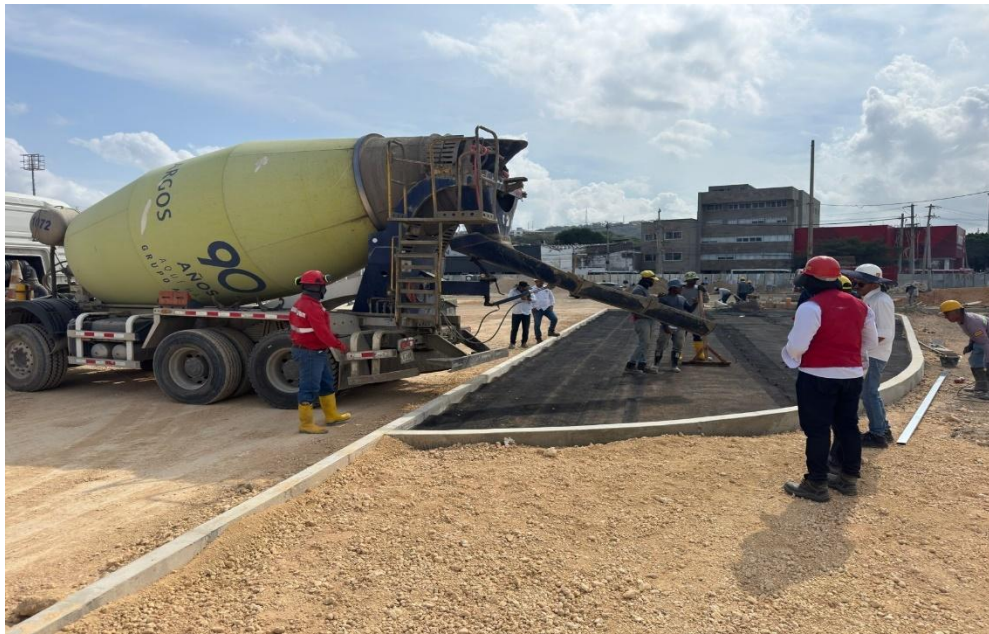
Ilustración 45. Fundida concreto 4000 psi placa juegos de niños
