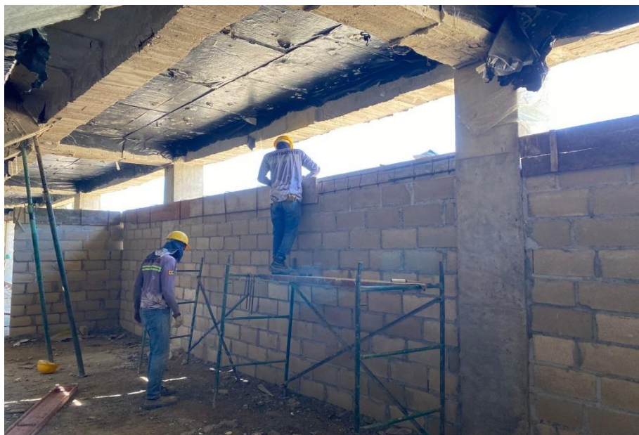
Ilustración 48. Levante en block No 4 baños y camerinos cancha futbol 9
