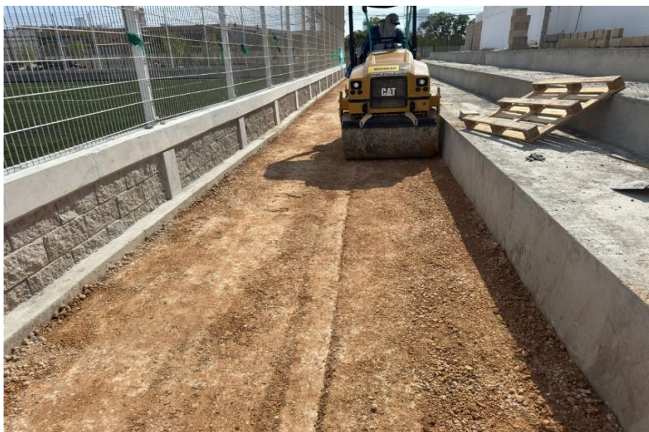
Ilustración 38. Relleno y compactación material seleccionado para conformación de terreno para loseta
