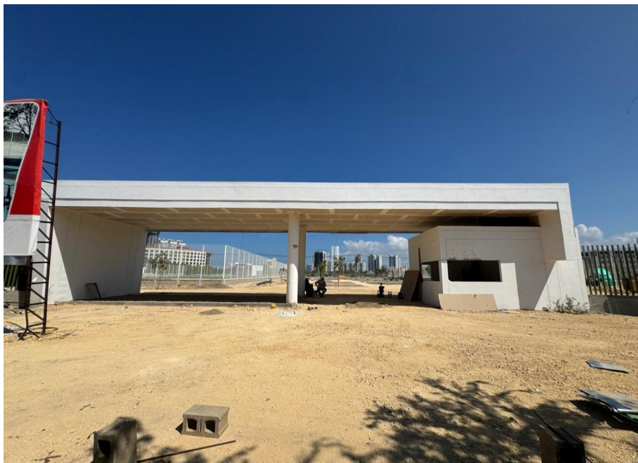
Ilustración 61. Instalación de estuco exterior y cielo raso acceso principal
