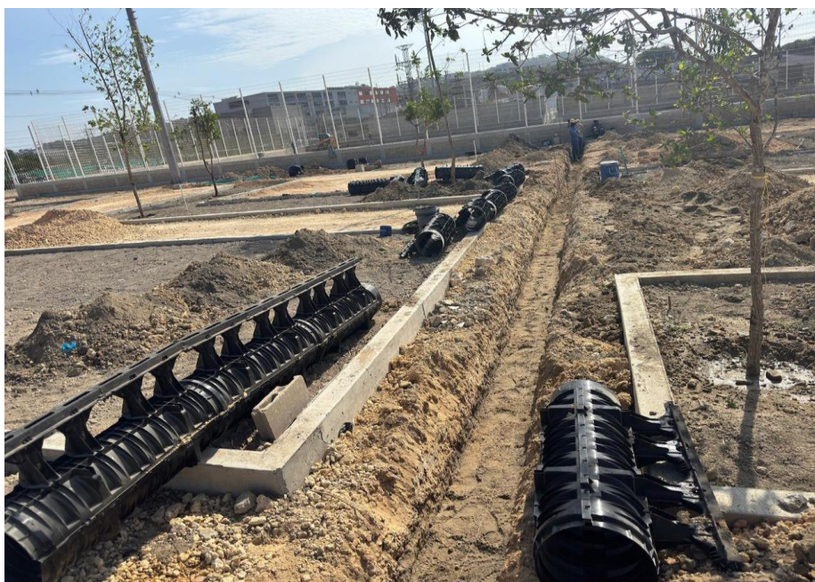
Ilustración 54. Instalación sistema de drenaje aguas lluvias(canaleta)
