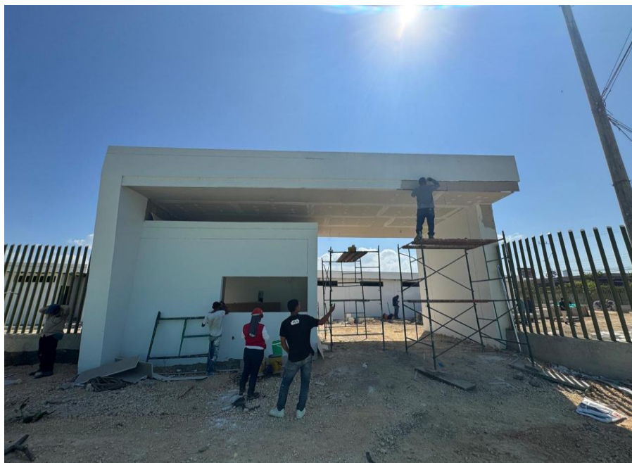
Ilustración 62. Instalación de estuco exterior y cielo raso acceso manglar
