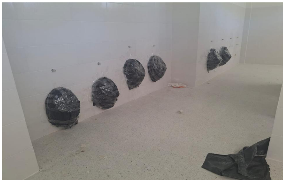
Ilustración 52. Instalación de orinales baños cancha futbol 11
