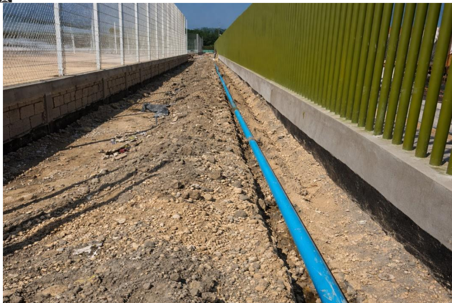
Ilustración 53. Instalación tubería C-900 sistema contraincendios
