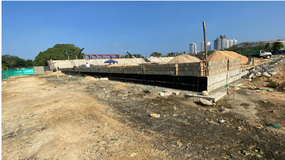
Ilustración 11. Relleno y compactación material seleccionado cancha de futbol
