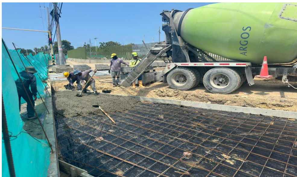
Ilustración 43. Fundida concreto 4000 psi placa acceso bahía
