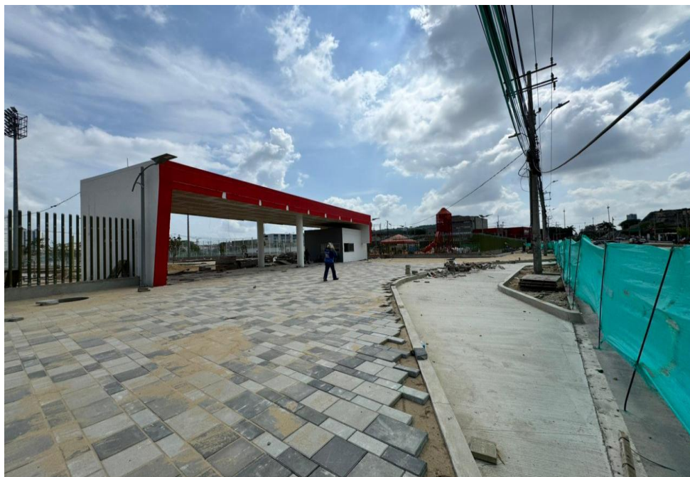
Ilustración 60. Instalación losetas plazoleta acceso principal
