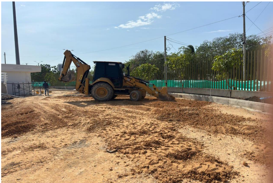
Ilustración 35. Relleno y compactación material seleccionado zona baños cancha futbol 11
