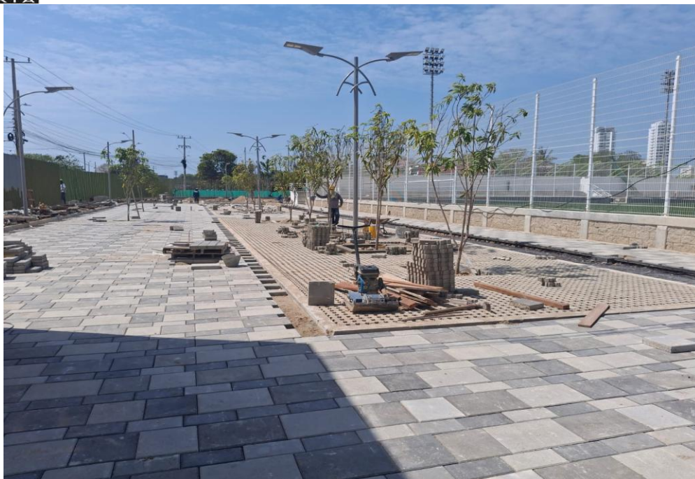
Ilustración 59. Instalación losetas y gramoquin
