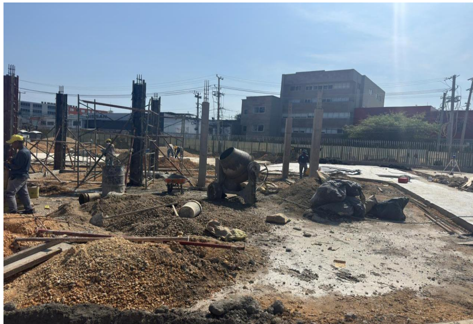
Ilustración 41. Fundida concreto 4000 psi vigas cafeterías
