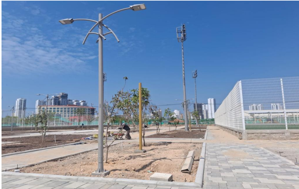
Ilustración 57. Instalación de lámparas convencionales zona central
