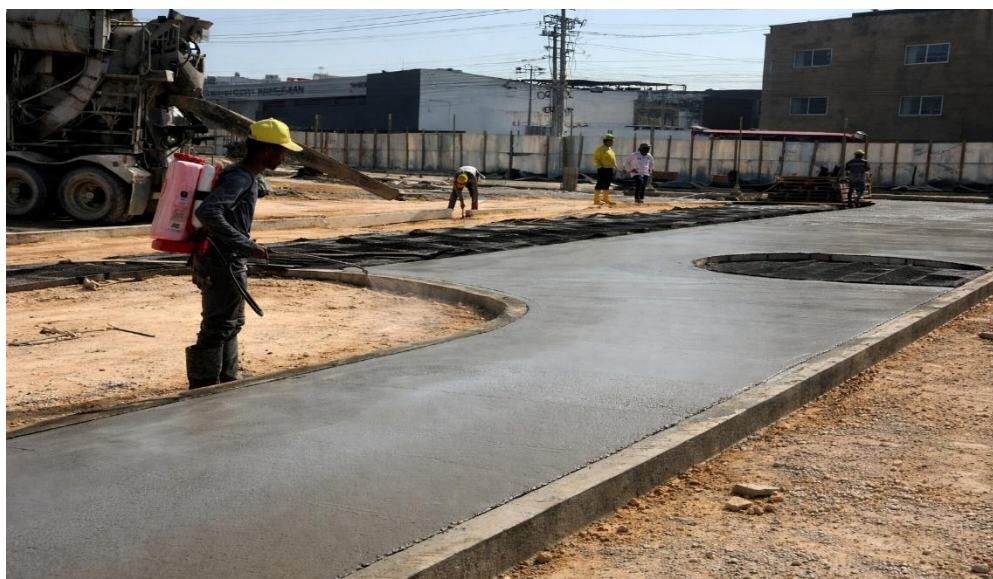
Ilustración 44. Fundida concreto 4000 psi placa juegos de niños
