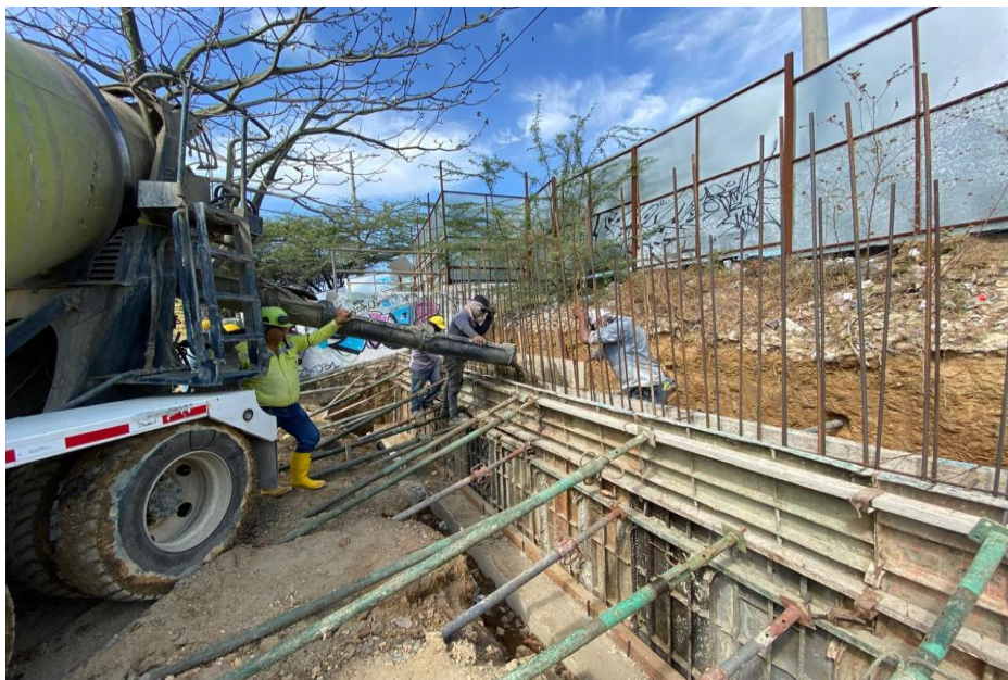
Ilustración 19. Fundida concreto 4000 psi muro de contención
