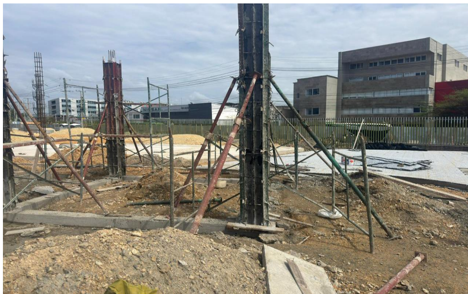
Ilustración 39. Figurado acero de refuerzo 60.000 columnas cafeterías
