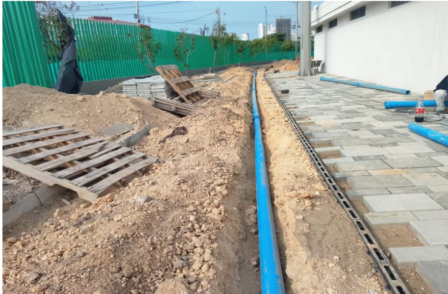
Ilustración 47. Instalación tubería C-900 sistema contra incendios
