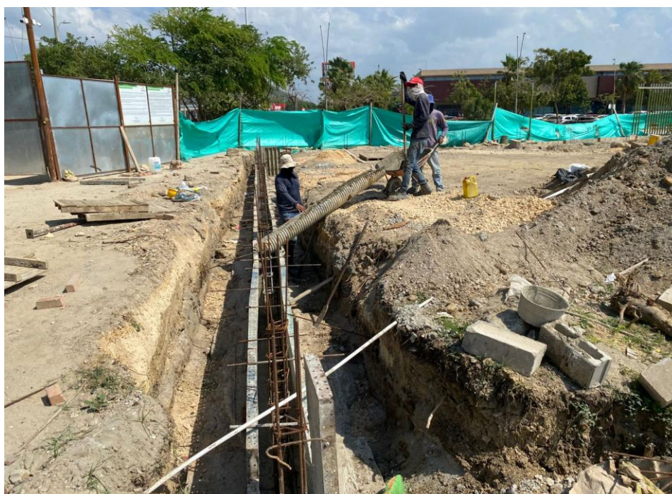
Ilustración 18. Fundida concreto 4000 psi viga de cimentación cerramiento cancha futbol
