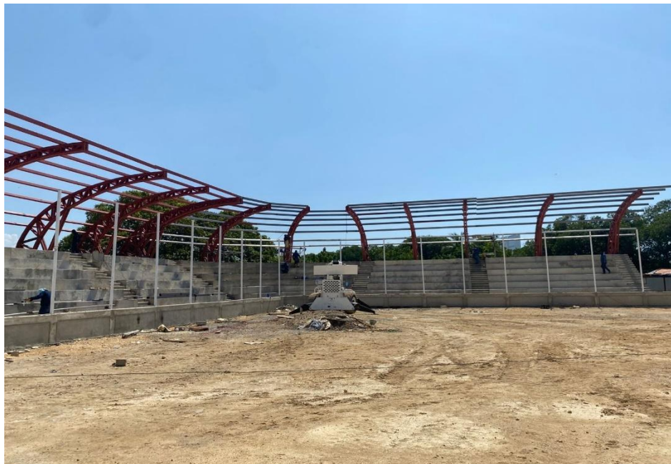
Ilustración 30. Instalación cerchas y correas metálicas para cubierta graderías de softbol
