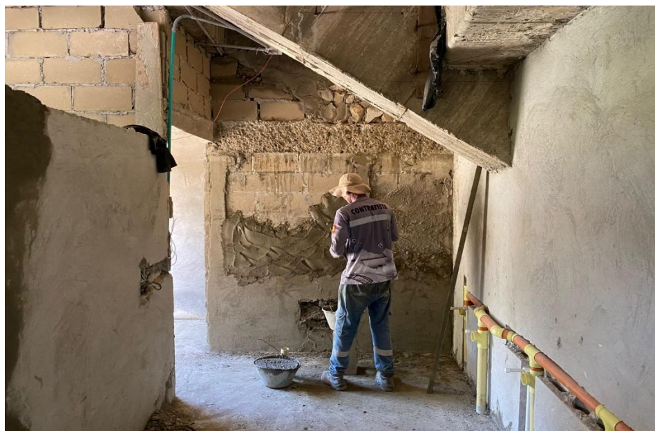
Ilustración 27. Pañete baños graderías de softbol
