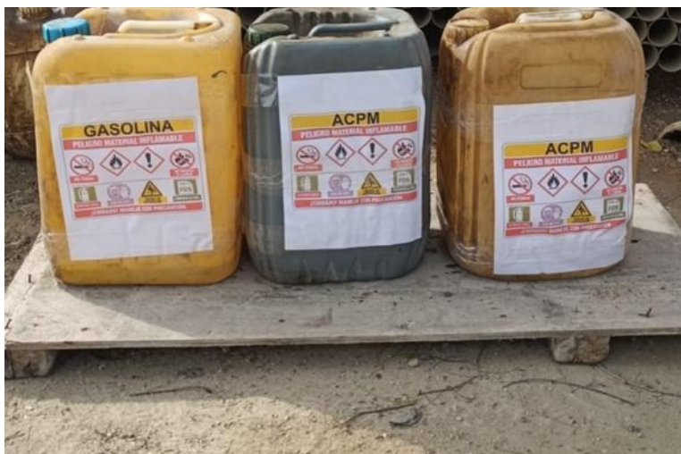
Ilustración 68. Almacenamiento de sustancias peligrosas.
