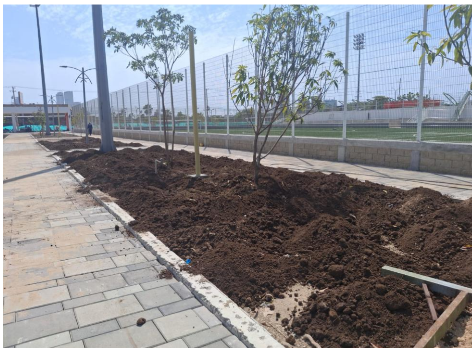
Ilustración 62. Instalación tierra negra jardineras
