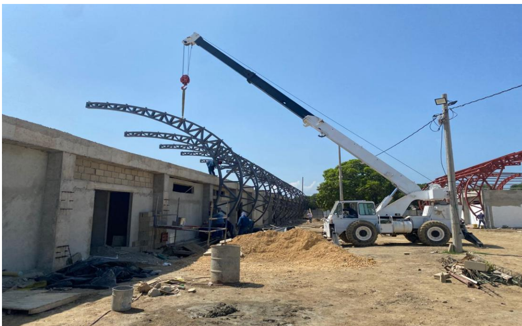
Ilustración 31. Instalación cerchas metálicas para cubierta graderías de futbol
