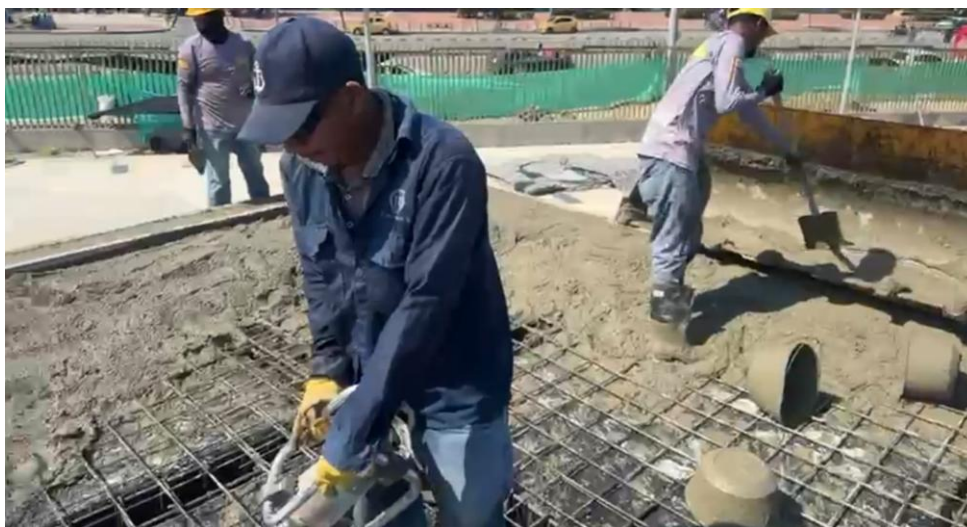
Ilustración 42. Fundida concreto 4000 psi placa cafeterías
