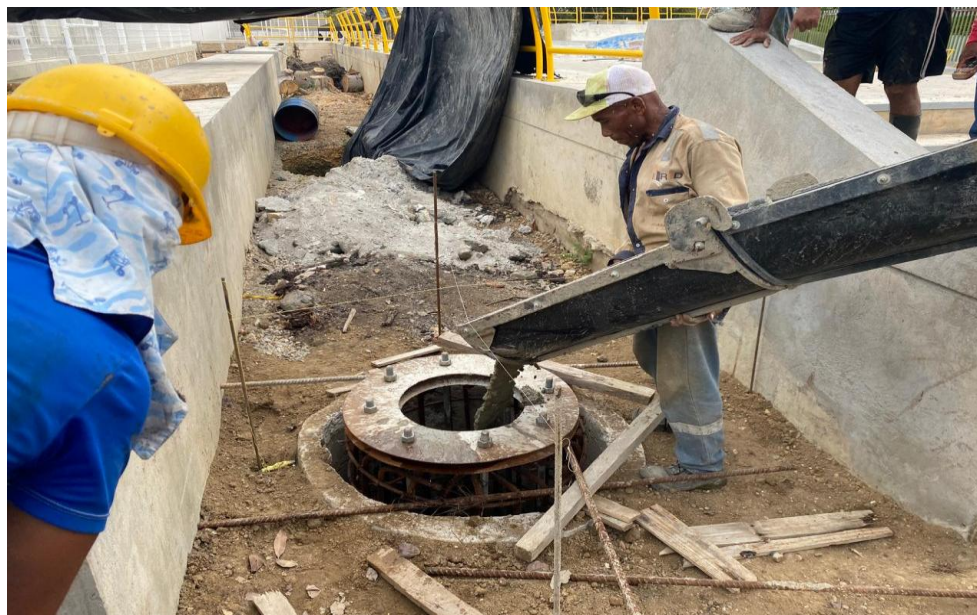
Ilustración 16. Fundida concreto 4000 psi para mástiles
