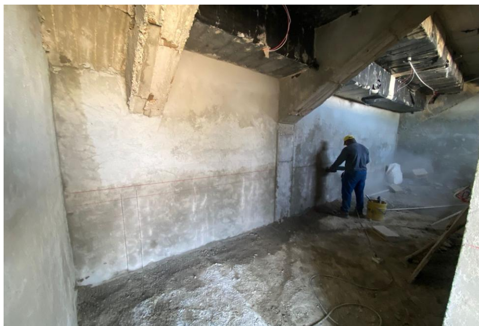
Ilustración 28. Pañete baños graderías de futbol
