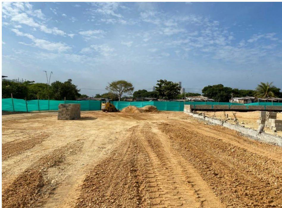
Ilustración 12. Relleno y compactación material seleccionado cancha futbol
