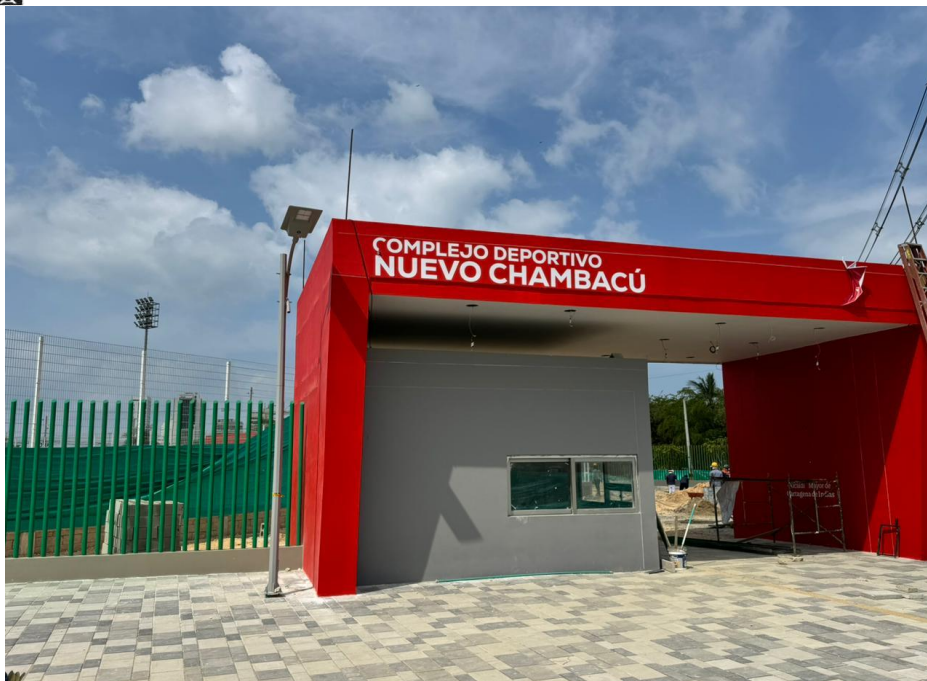
Ilustración 55. Instalación de estuco exterior y cielo raso acceso parqueadero
