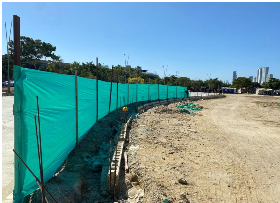
Ilustración 21. Levante en Block No 8 cerramiento perimetral paralelo al parqueadero
