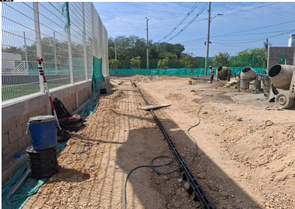
Ilustración 51. Instalación sistema de drenaje aguas lluvias (canaleta)
