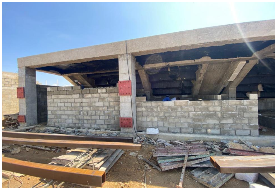
Ilustración 25. Levante en block No 4 baños graderías de futbol
