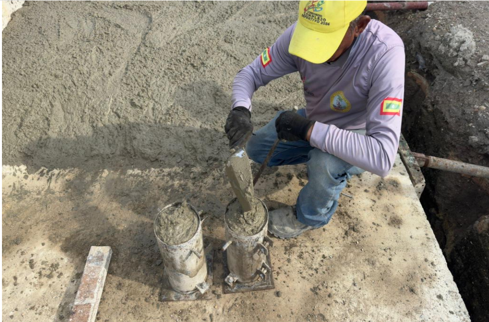
Ilustración 64. Toma de muestras concreto 4000 psi para muro de contención ligas mayores
