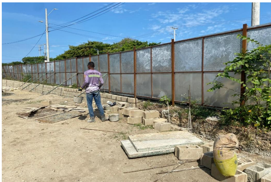
Ilustración 20. Levante en Block No 8 cerramiento perimetral
