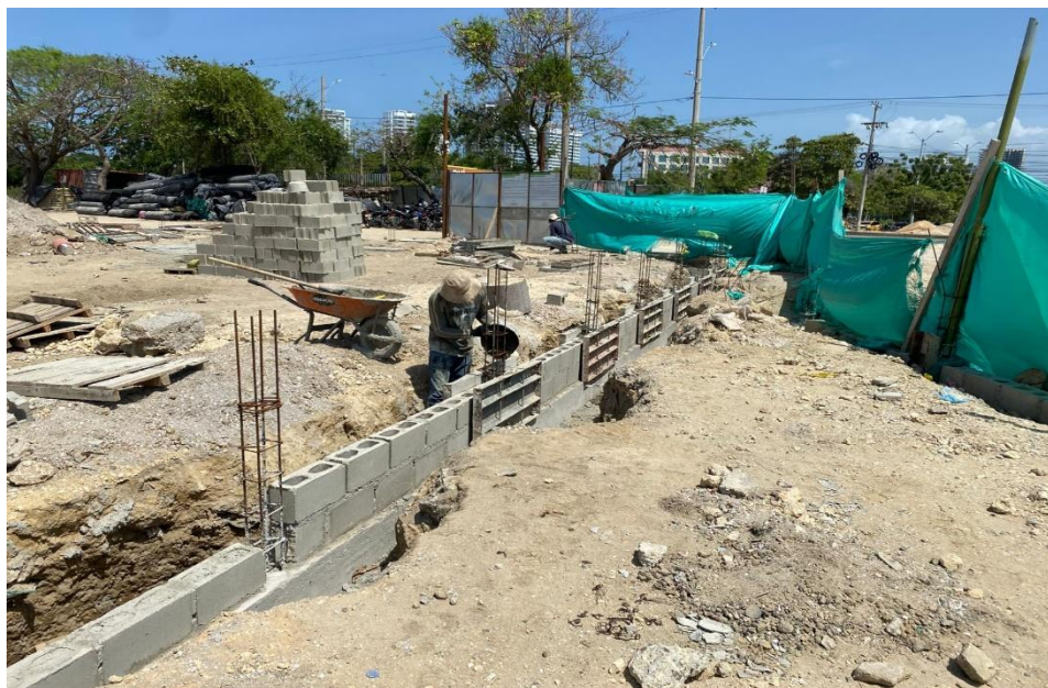
Ilustración 22. Levante en Block No 6 cerramiento cancha de futbol
