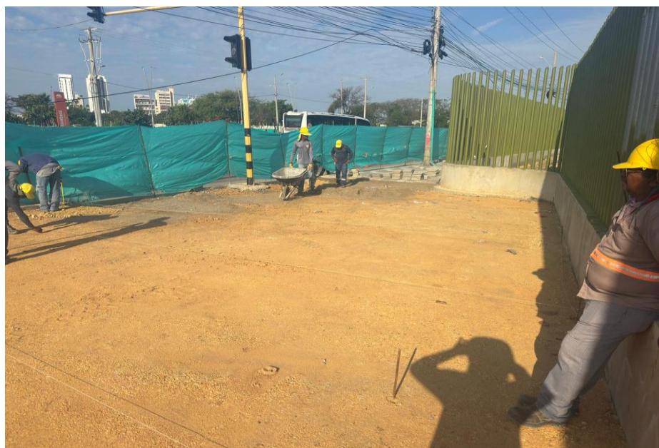
Ilustración 36. Relleno y compactación material seleccionado para conformación de terreno para loseta zona de entrada principal
