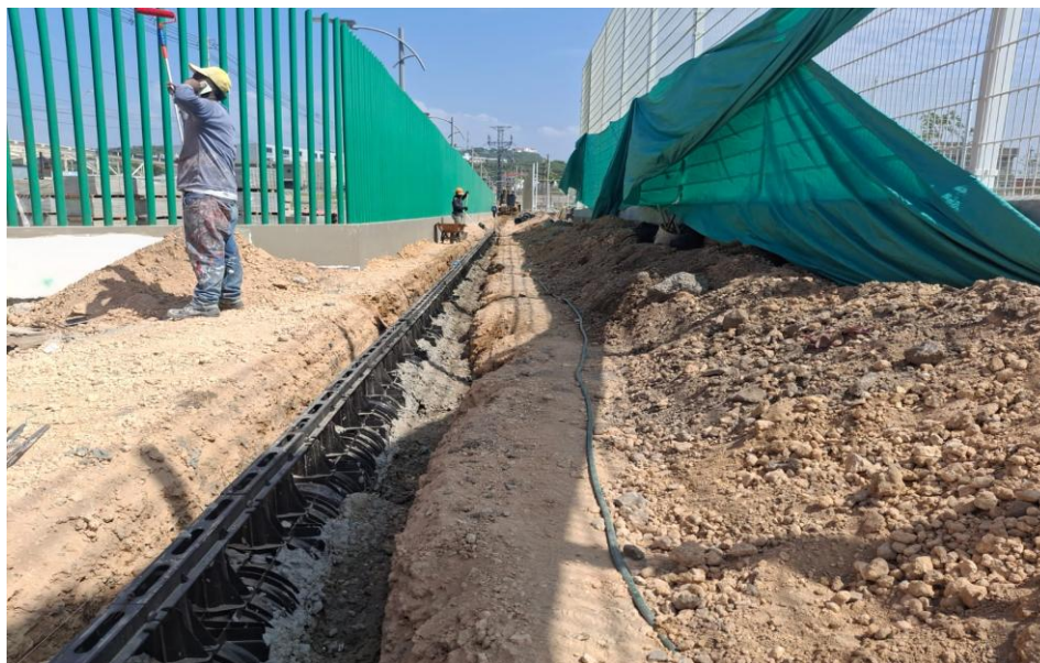
Ilustración 50. Instalación sistema de drenaje aguas lluvias(canaleta)
