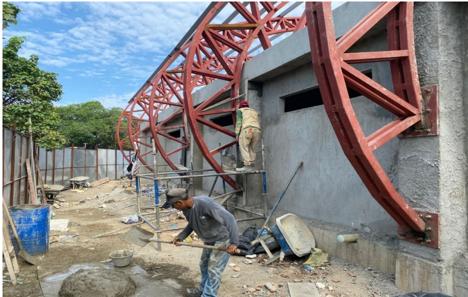
Ilustración 29. Instalación cerchas metálicas para cubierta graderías de softbol
