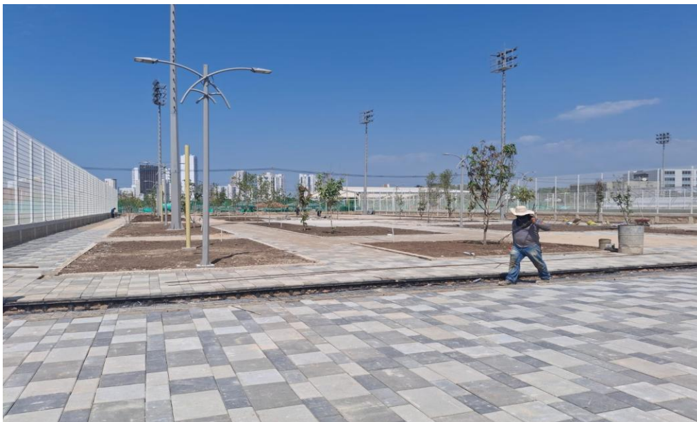
Ilustración 58. Instalación losetas zona central
