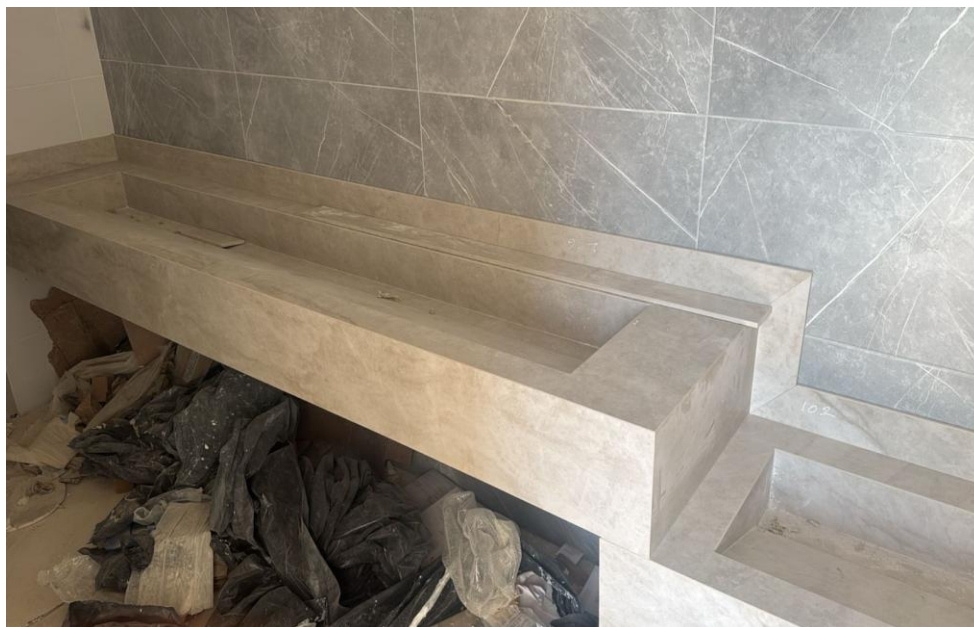
Ilustración 54. Instalación de enchape y mesón baños y camerinos cancha futbol 11
