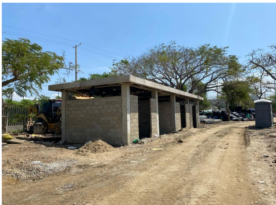
Ilustración 26. Levante en block No 4 cuartos técnicos
