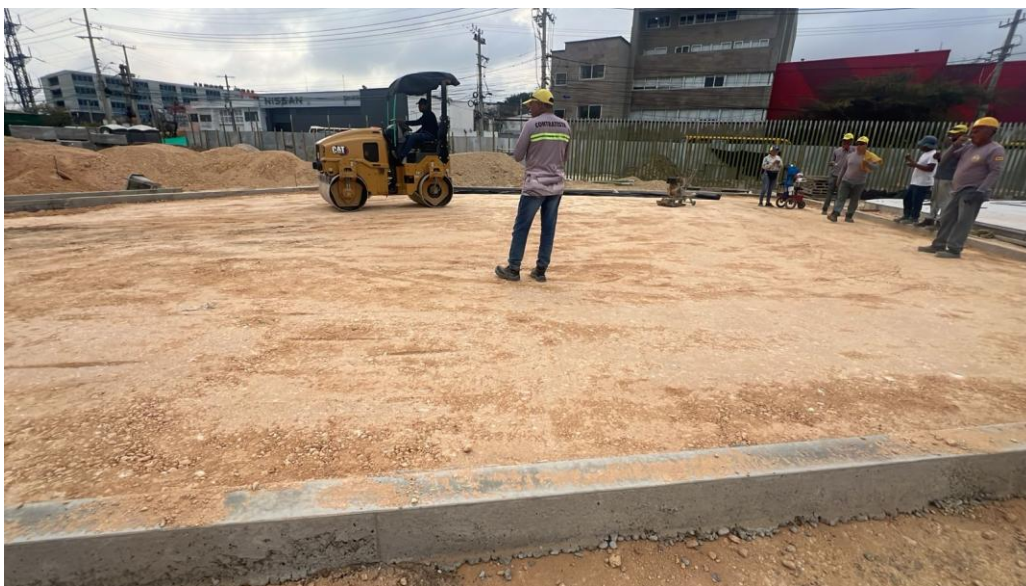
Ilustración 37. Relleno y compactación material seleccionado para acondicionamiento zona de niños
