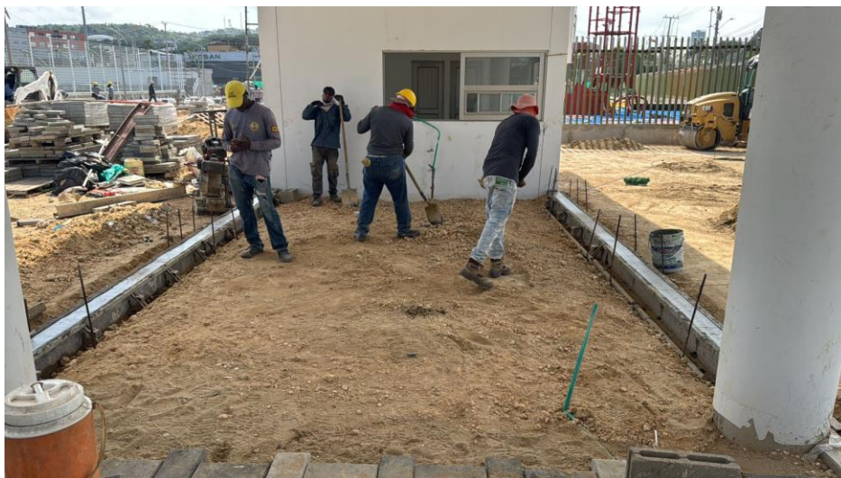
Ilustración 27. Relleno y compactación material seleccionado acceso principal para instalación losetas
