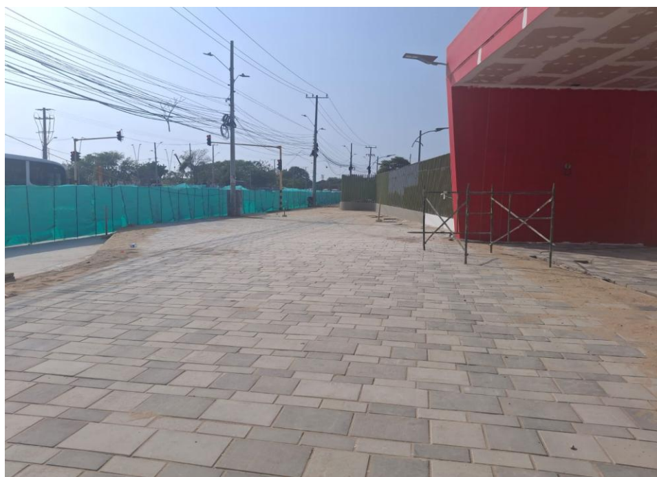
Ilustración 48. Instalación losetas plazoleta acceso principal
