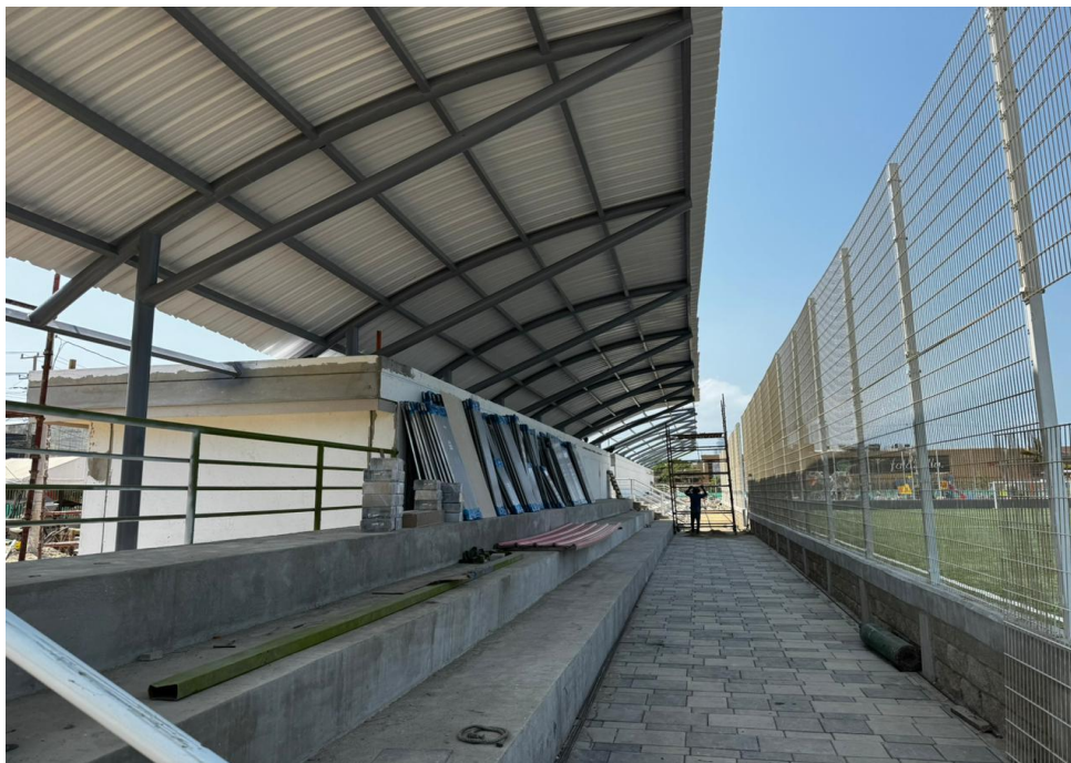
Ilustración 51. Cubierta graderías cancha futbol 9
