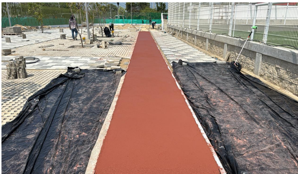
Ilustración 33. Fundida concreto rojo 3000 psi Senderos
