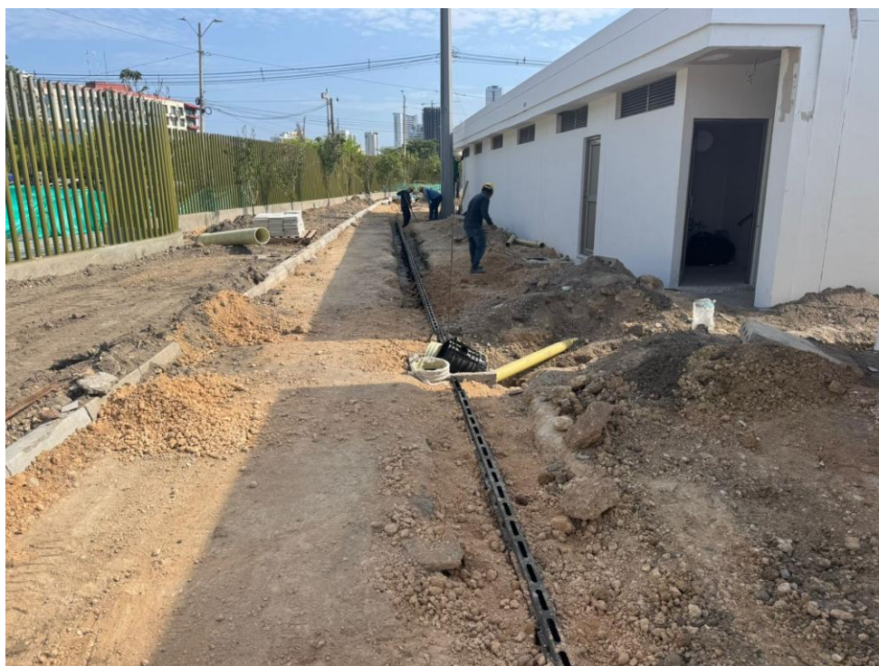
Ilustración 36. Instalación sistema de drenaje aguas lluvias(canaleta)
