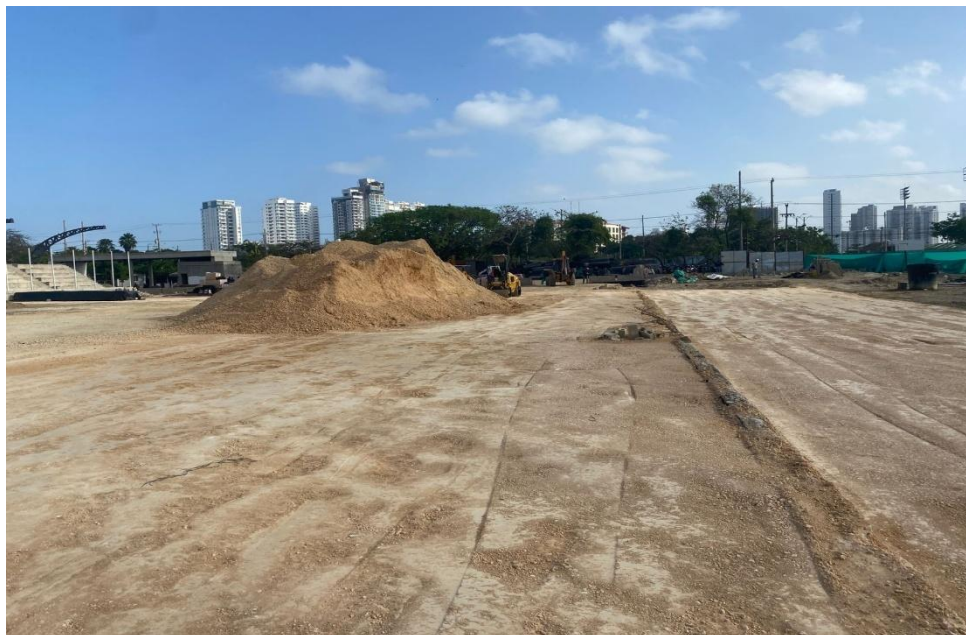
Ilustración 13. Relleno y compactación material seleccionado cancha futbol
