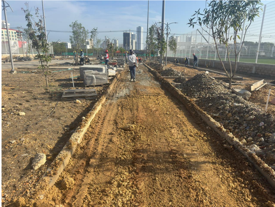
Ilustración 29. Relleno y compactación material seleccionado para instalación de losetas y fundida sendero
