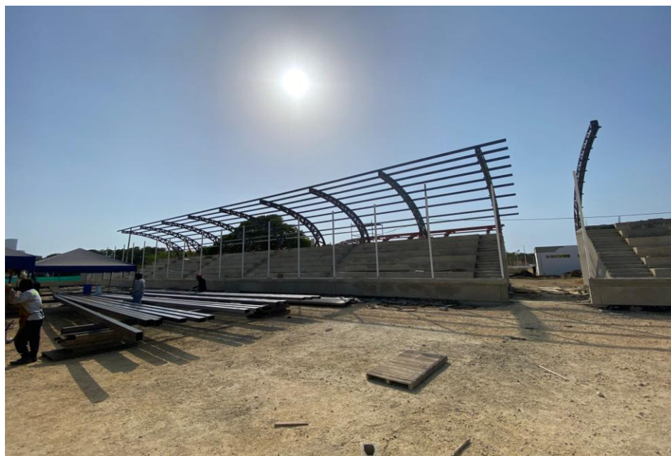
Ilustración 21. Instalación cerchas metálicas para cubierta graderías de futbol
