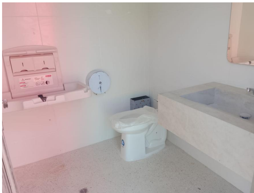
Ilustración 40. Instalación de pisos, enchape, divisiones, cielo raso, aparatos sanitarios y pintura baño familiar cancha futbol 11
