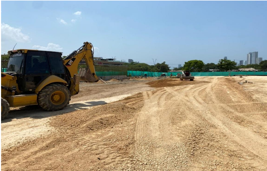
Ilustración 11. Relleno y compactación material seleccionado cancha de futbol
