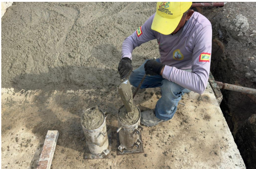
Ilustración 54. Toma de muestras concreto 4000 psi para muro de contención ligas mayores
