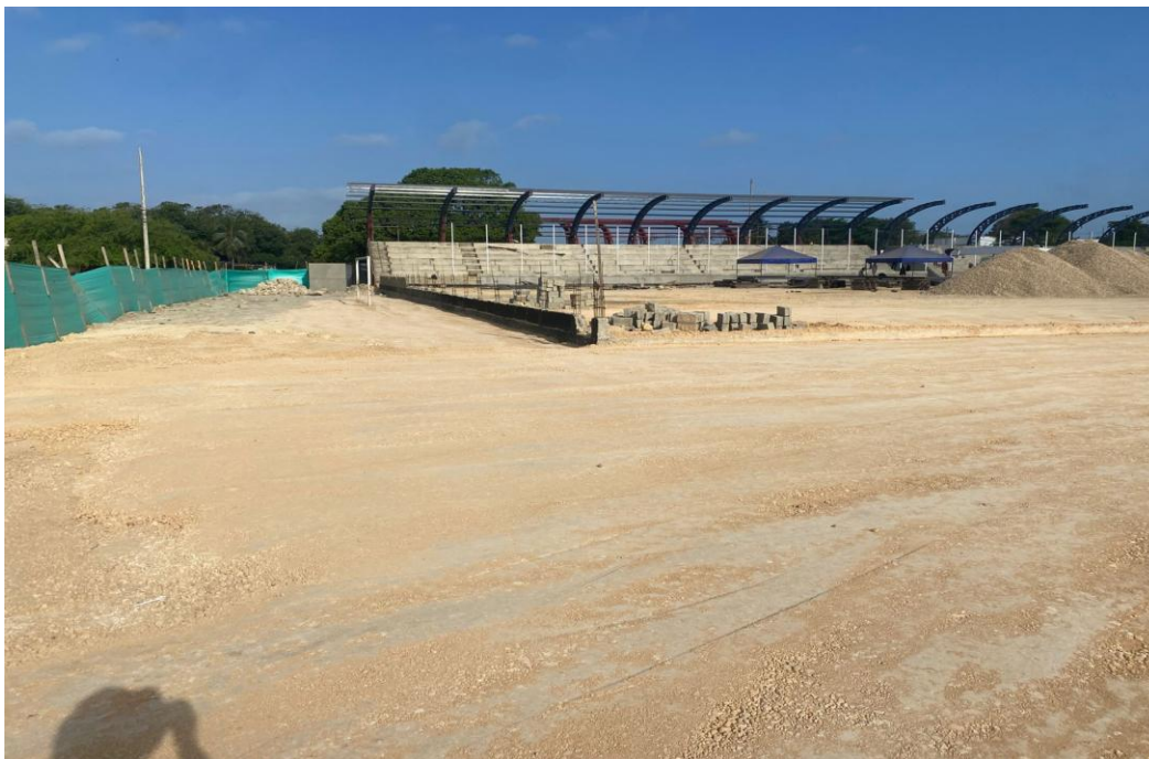
Ilustración 12. Relleno y compactación material seleccionado cancha futbol
