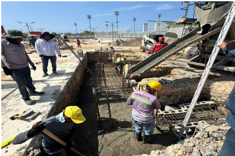
Ilustración 31. Fundida concreto 4000 psi vigas cafeterías
