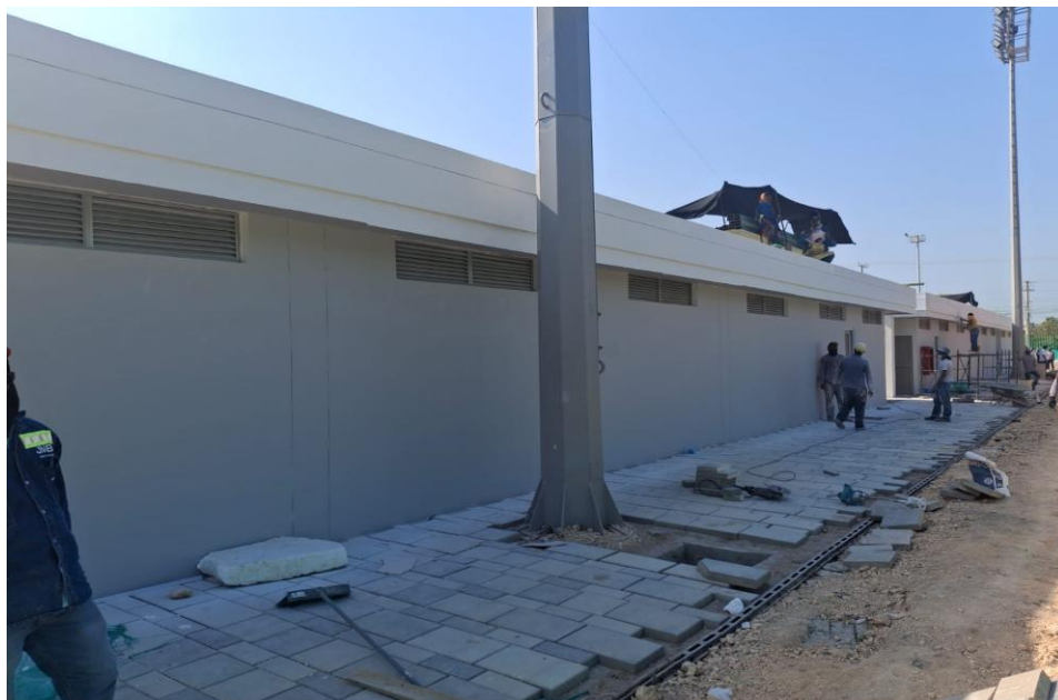
Ilustración 44. Pintura exterior baños y camerinos
