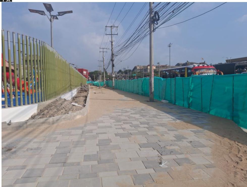
Ilustración 47. Instalación losetas andén frente estación transcaribe
