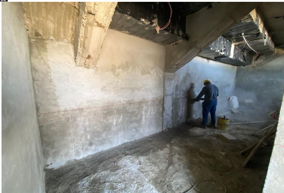
Ilustración 17. Pañete baños graderías de futbol
