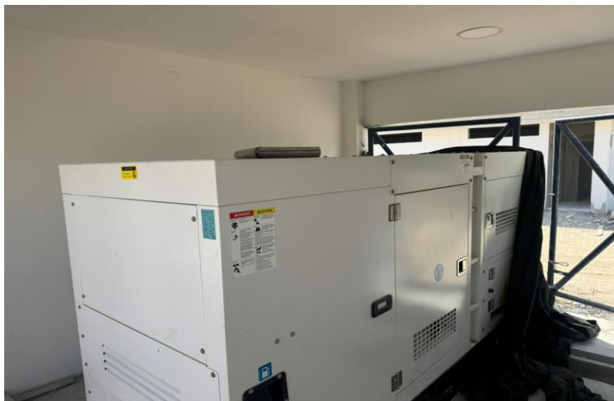
Ilustración 45. Instalación planta eléctrica
