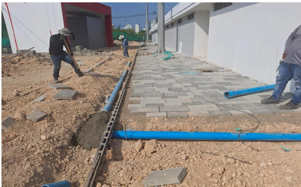
Ilustración 34. Instalación tubería C-900 sistema contra incendios
