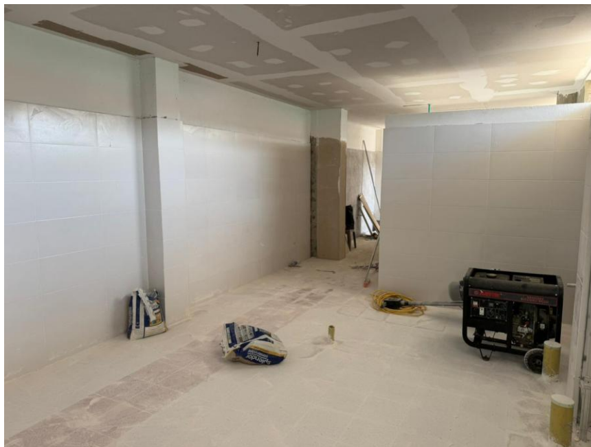
Ilustración 39. Instalación de pisos, enchape, cielo raso y pintura baños y camerinos cancha futbol 9
