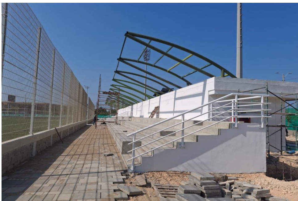
Ilustración 52. Cubierta graderías cancha futbol 11
