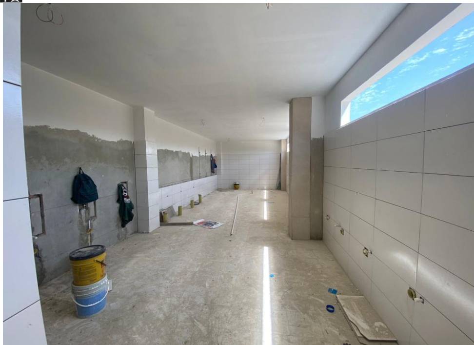
Ilustración 25. Instalación de pisos, enchape y cielo raso dugout
