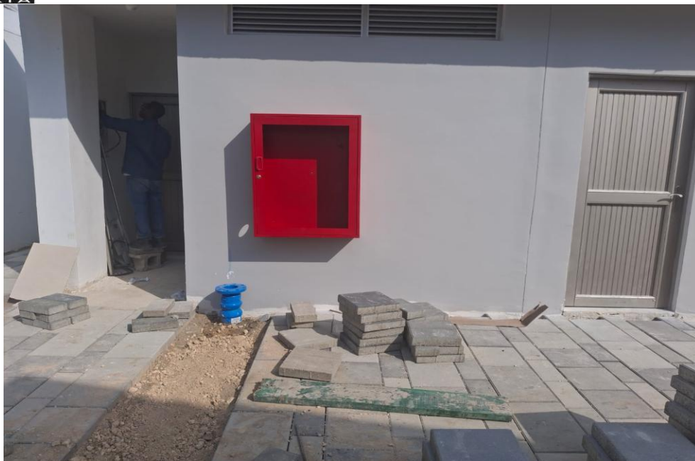
Ilustración 35. Instalación de gabinetes contraincendios
