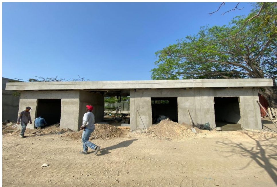
Ilustración 14. Levante en block No 4 y pañete cuarto técnico
