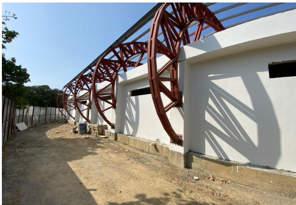
Ilustración 18. Instalación cerchas metálicas para cubierta graderías de softbol
