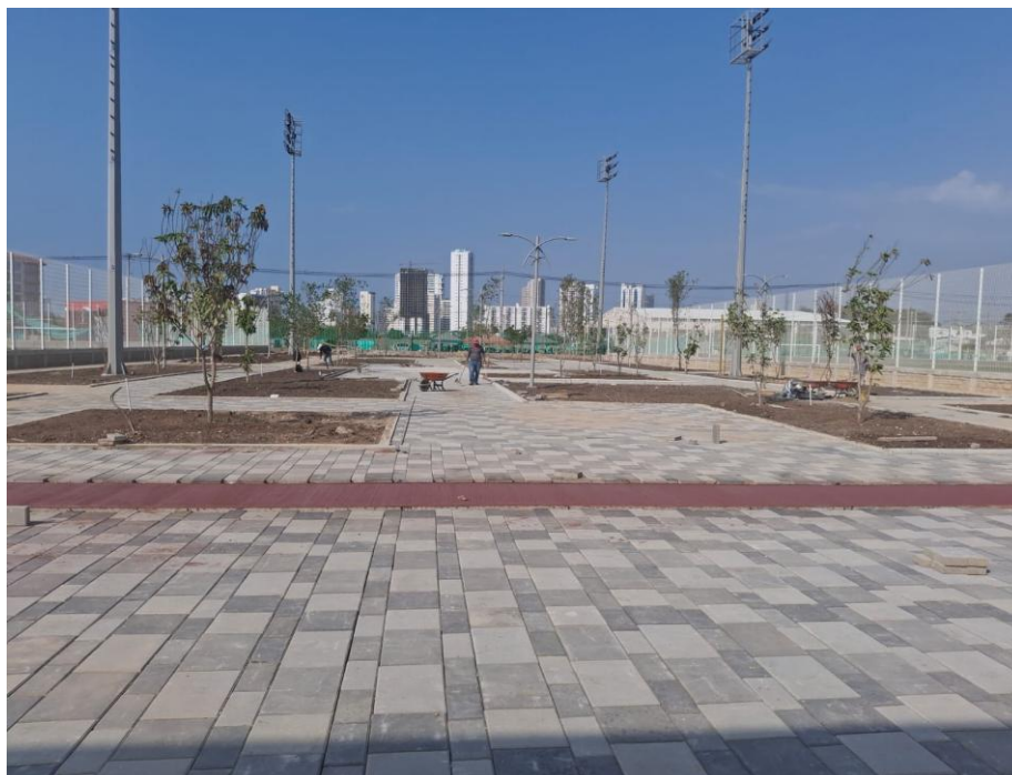
Ilustración 46. Instalación losetas zona central
