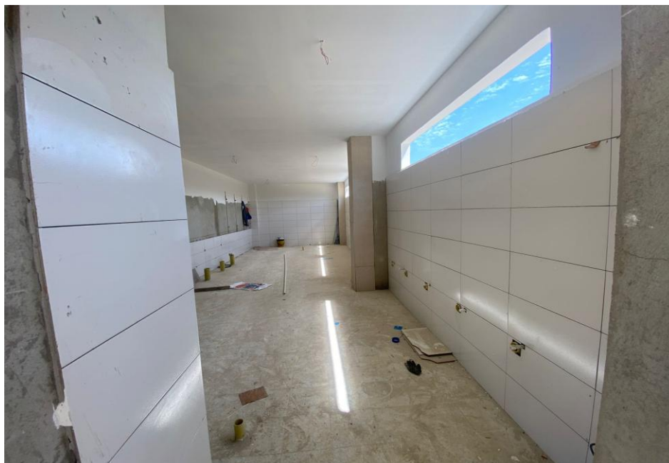
Ilustración 24. Instalación de pisos, enchape y cielo raso dugout
