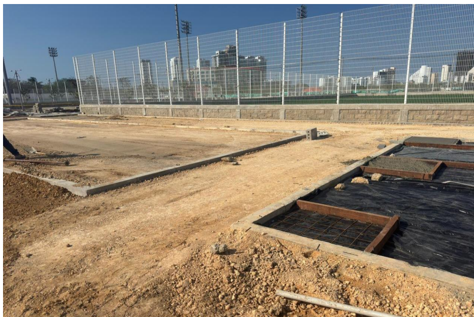
Ilustración 28. Relleno y compactación material seleccionado para conformación de terreno para loseta y gramoquin
