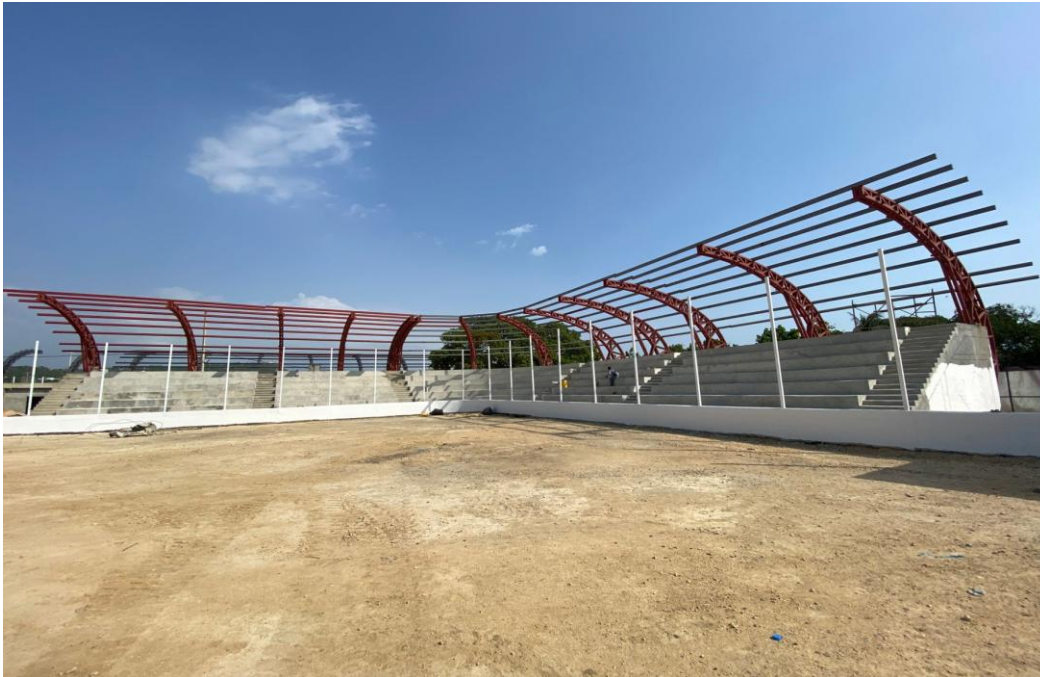
Ilustración 19. Instalación cerchas y correas metálicas para cubierta graderías de softbol
