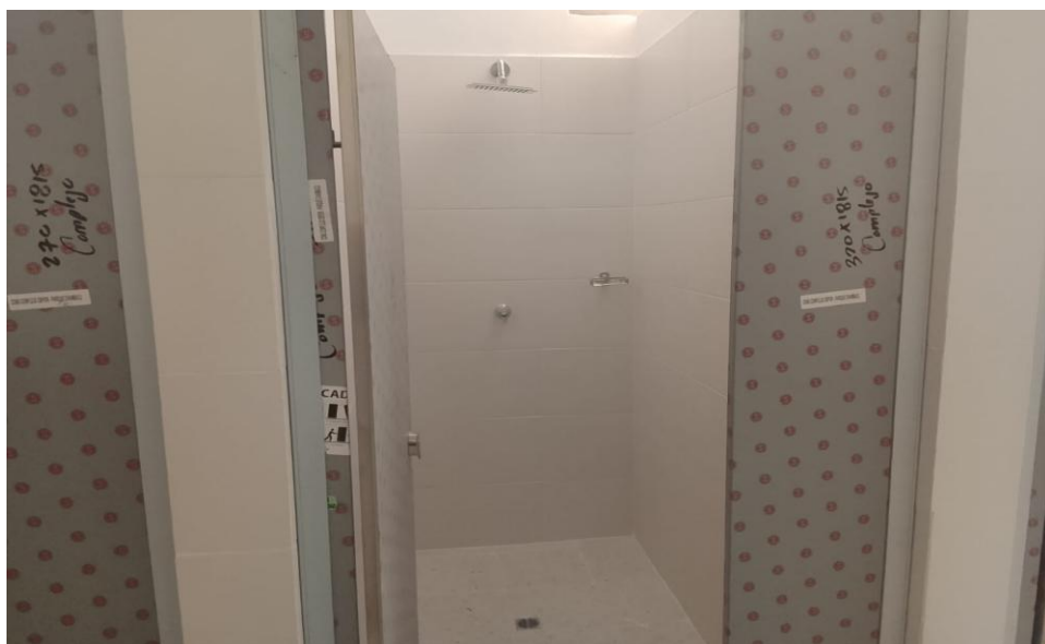
Ilustración 42. Instalación de enchape, piso, cielo raso, división y pintura duchas camerinos cancha futbol 11
