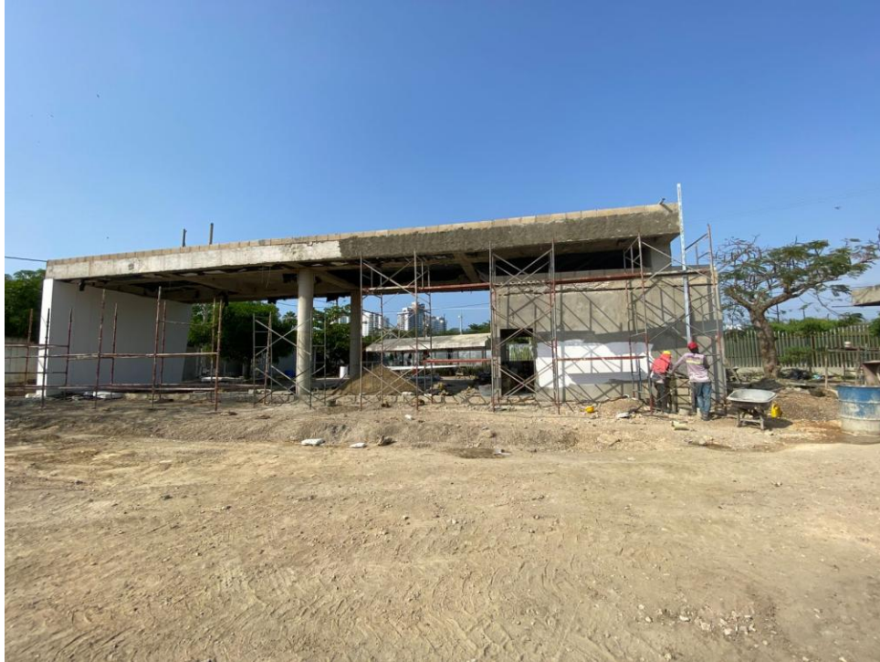
Ilustración 15. Pañete acceso principal
