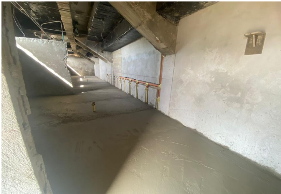
Ilustración 16. Pañete y plantilla baños graderías de softbol
