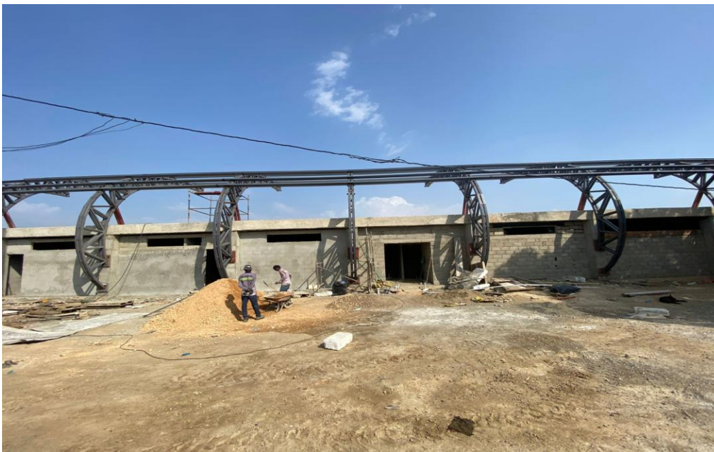
Ilustración 20. Instalación cerchas metálicas para cubierta graderías de fútbol
