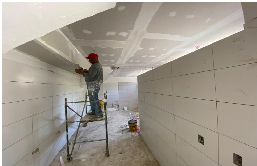
Ilustración 26. Instalación de pisos, enchape y cielo raso baños y camerinos cancha softbol
