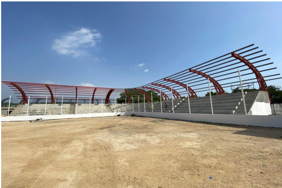
Ilustración 10. Relleno y compactación material seleccionado cancha de softbol.
