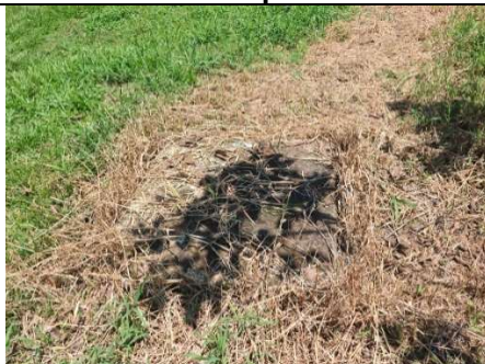
Imagen No. 01. Estado actual de cajas de inspección.
