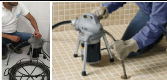
Imagen No. 05. Proceso de limpieza de red de tuberías sanitarias con roto-sonda eléctrica.
