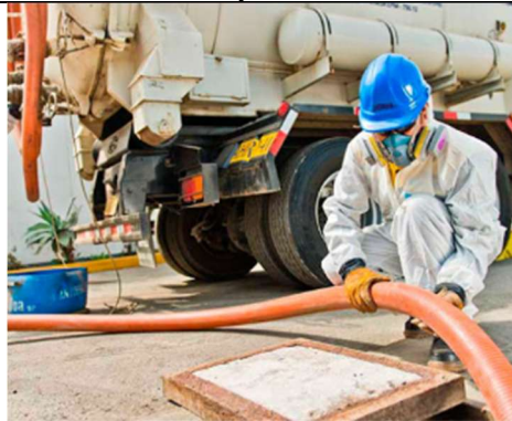
Imagen No. 07. Procedimiento de succión y limpieza de estructura de aguas residuales con camión Vactor.
