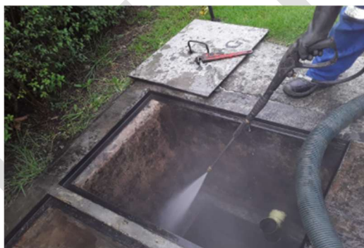
Imagen No. 02. Actividad de limpieza y lavado de cajas de inspección.
