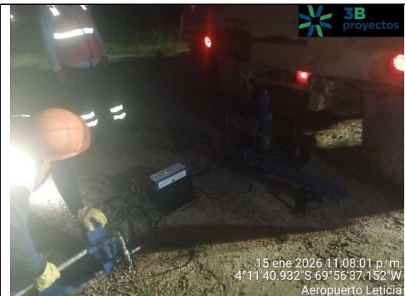
Fotografía No. 8 OBRAS COMPLEMENTARIAS – CONSTRUCCION DE BOX CULVERT
