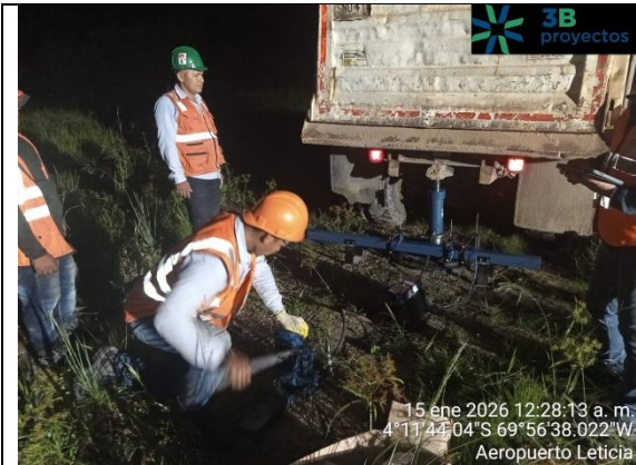
Fotografía No. 1 CONSTRUCCION CALLE DE RODAJE.
