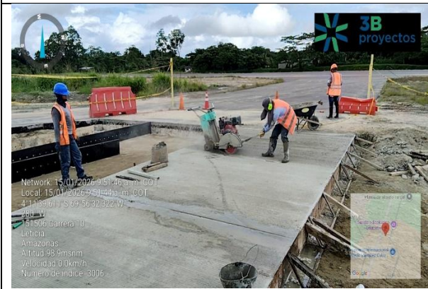
Fotografía No. 5 CONFORMACION DE FRANJA DE SEGURIDAD.
