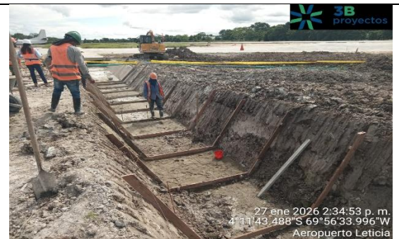
Fotografía No. 22 CONFORMACION DE FRANJA DE SEGUARIDAD.
