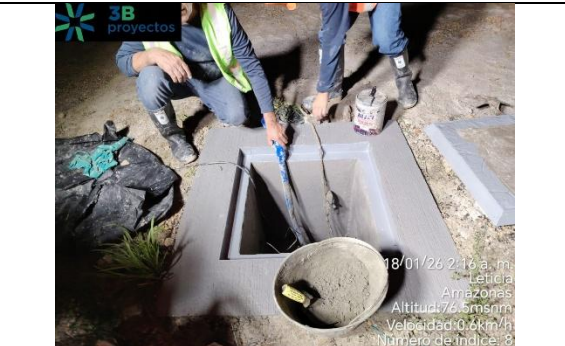
Fotografía No. 20 CANALIZACIONES Y CABLEADO DE AYUDAS VISUALES
