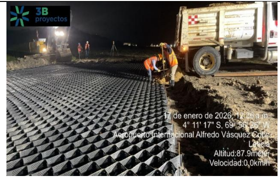
Fotografía No. 16 CONFORMACION DE FRANJA DE SEGUARIDAD.
