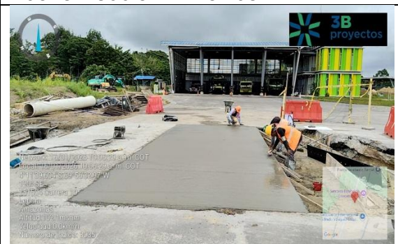
Fotografía No. 10 OBRAS COMPLEMENTARIAS – CONSTRUCCION DE BOX CULVERT
