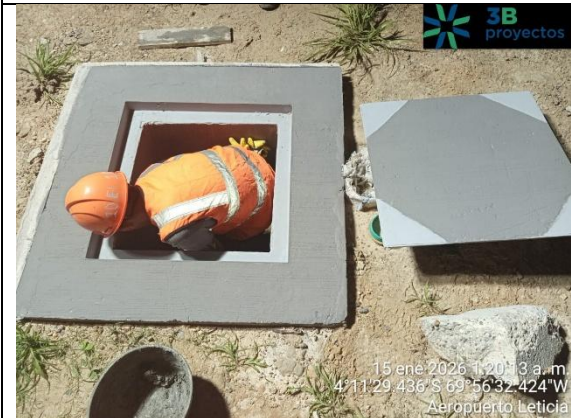
Fotografía No. 3 CONSTRUCCION CALLE DE RODAJE.
