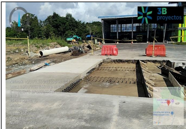
Fotografía No. 7 CONFORMACION DE FRANJA DE SEGURIDAD.
