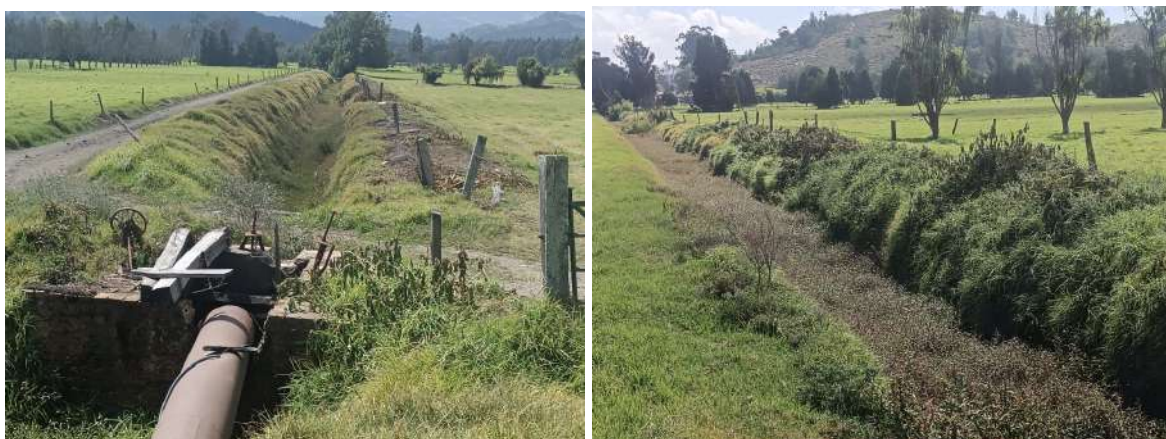
Fotografías 1 y 2. Estado actual del canal aguas arriba de la vía. Fuente propia.
