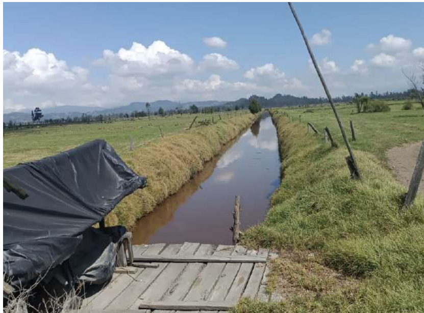
Fotografía 3. Estado actual del canal aguas abajo de la vía. Fuente propia.
